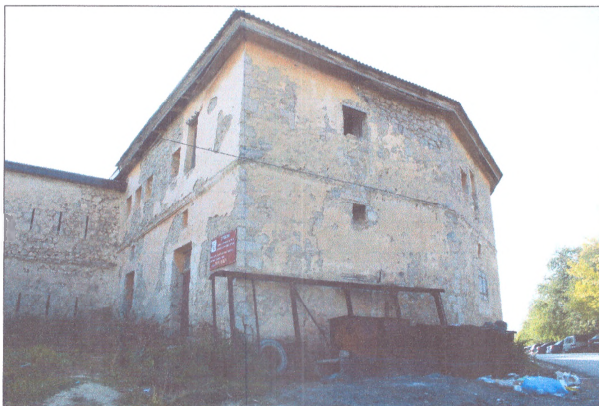
Фото 6. Северо-западный корпус крепости
