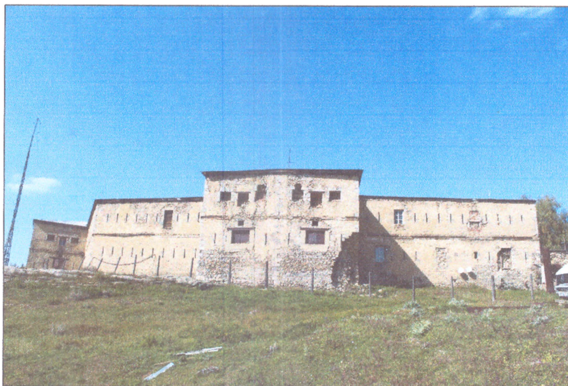
Фото 2. Юго-западный корпус крепости
