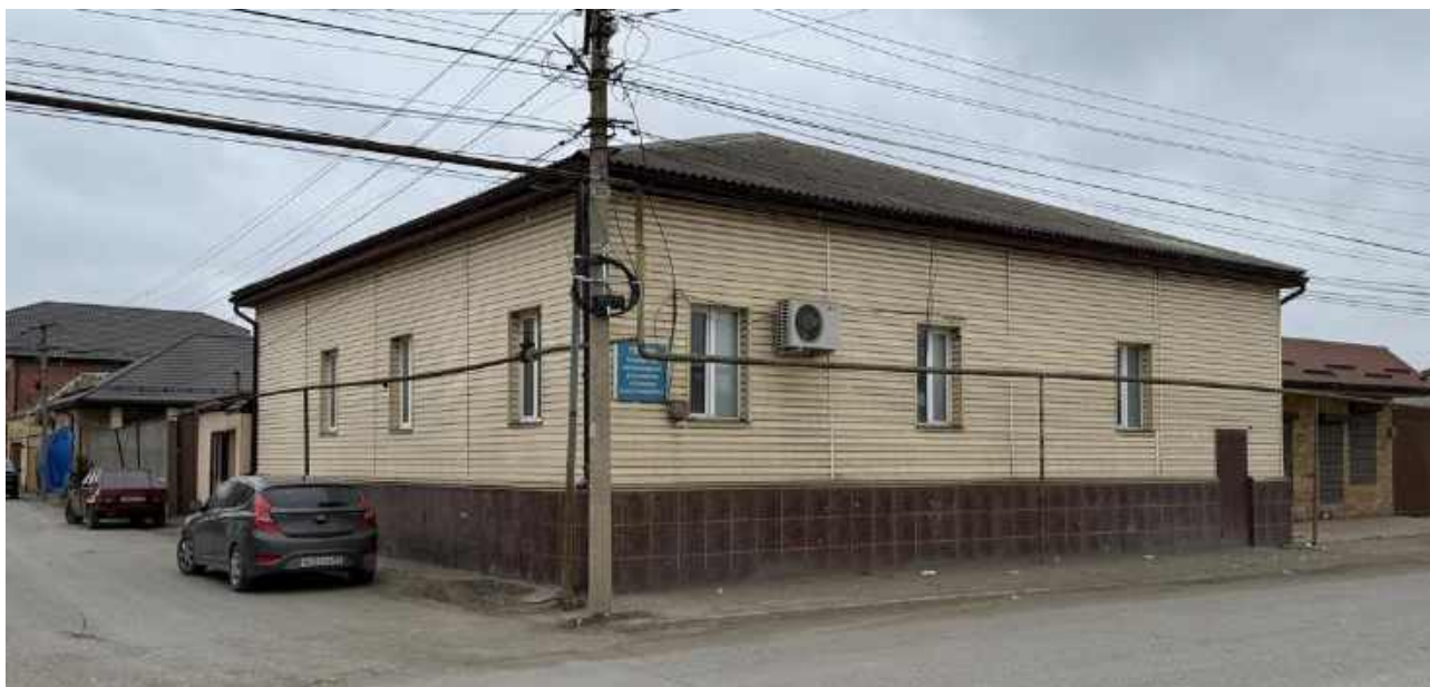
Фото 18. Вид на Объект с перекрестка ул. Багратиона и ул. Нижегородская.
