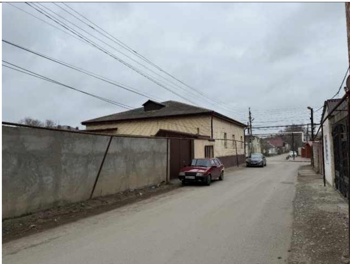
Вид на Объект с северного направления с ул. Нижегородской. Фрагментарная видимость.
