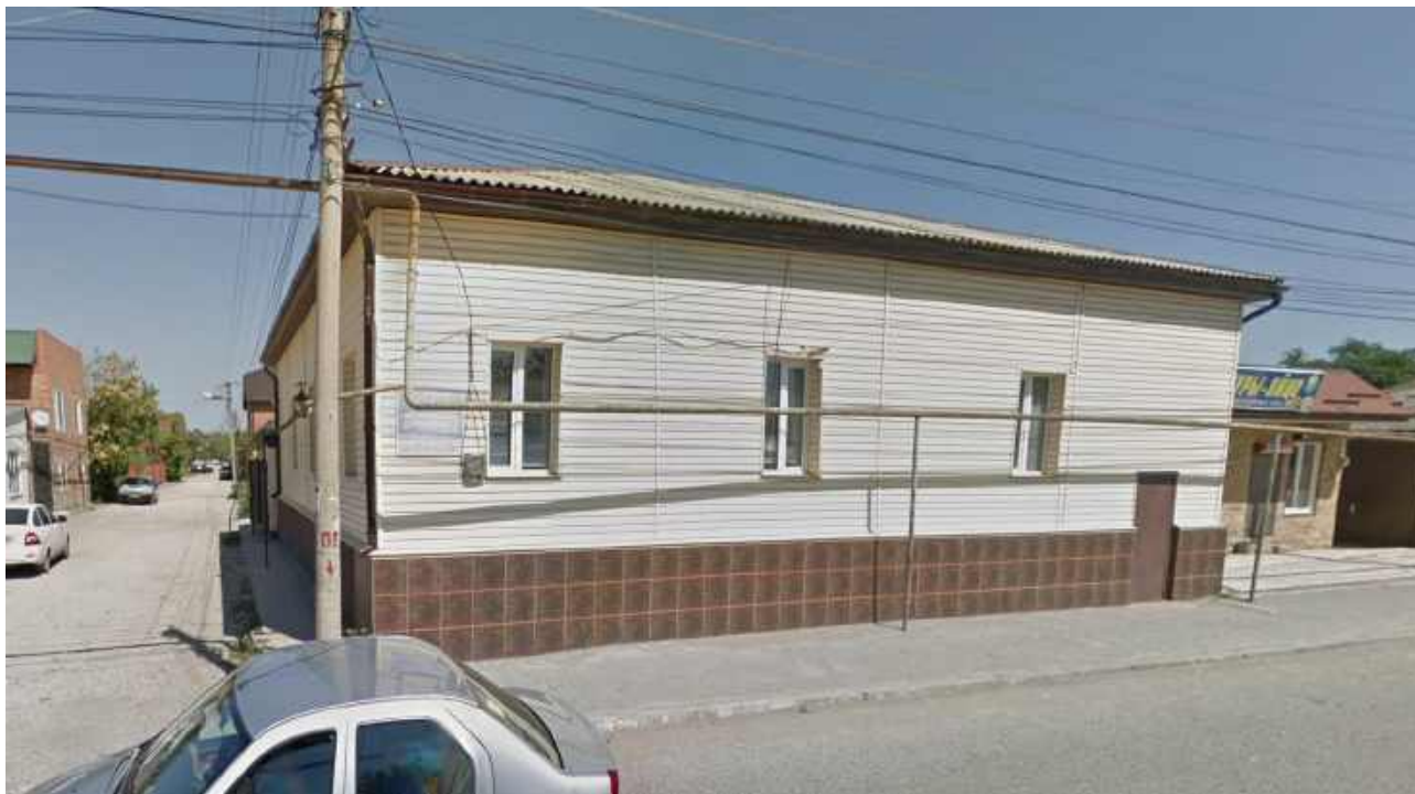
Фото 2. Фото Объекта на август 2019 года.
