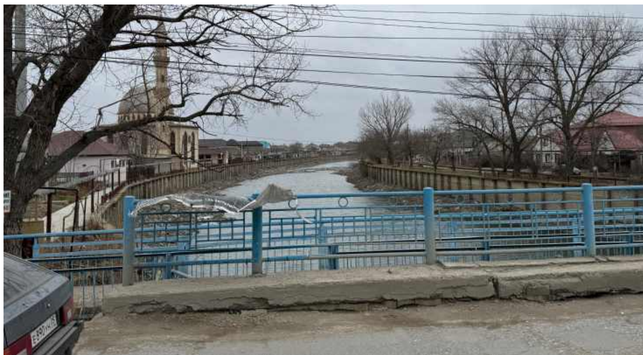
Фото 3. Русло р. Старый Терек, вид с моста по ул. Багратиона.
