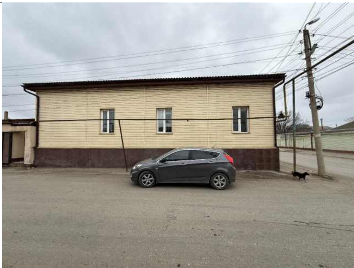
Вид на Объект с северо-западного направления с нечетной стороны ул. Нижегородской.
