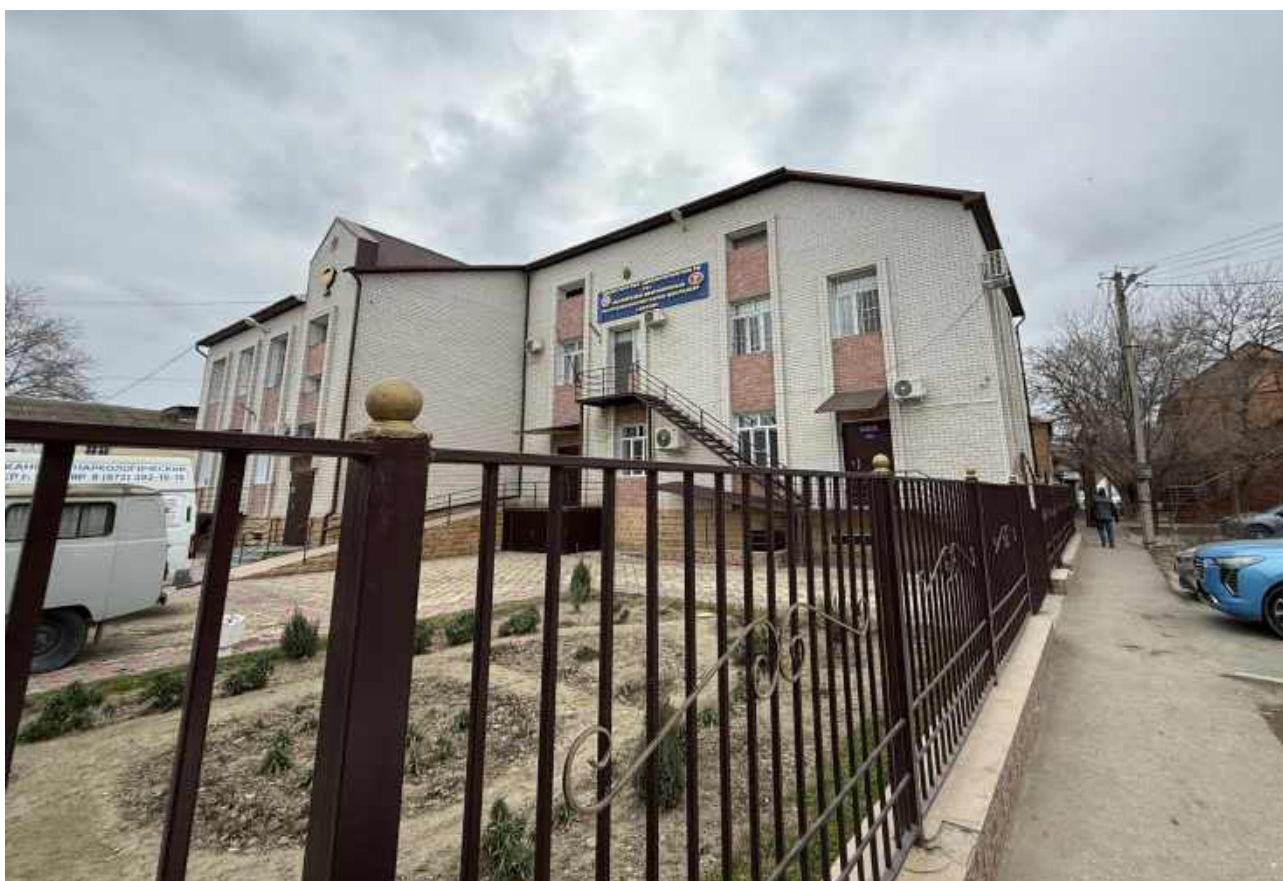
Фото 6. Местоположение утраченного объекта культурного наследия «Здание наркологического диспансера», кон. XIX в. (Республика Дагестан, г. Кизляр, Пушкина, 3).
