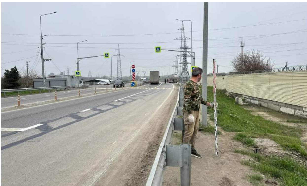
Рис.17. «Капитальный ремонт мостов через канал Чир-ЮртГЭС на км 752+850 автомобильной дороги Р-217 «Кавказ» автомобильная дорога М-4 «Дон» - Владикавказ - Грозный - Махачкала - граница с Азербайджанской Республикой, Республика Дагестан» в Кизилюртовском районе, Республика Дагестан. Рельеф местности и характер растительности участка обследования. Точка фотофиксации 9, вид с 3.
