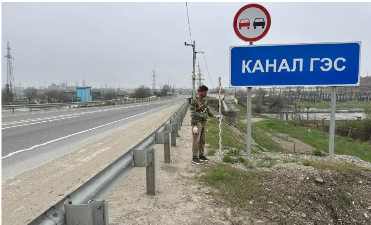
Рис.16. «Капитальный ремонт мостов через канал Чир-ЮртГЭС на км 752+850 автомобильной дороги Р-217 «Кавказ» автомобильная дорога М-4 «Дон» - Владикавказ - Грозный - Махачкала - граница с Азербайджанской Республикой, Республика Дагестан» в Кизилюртовском районе, Республика Дагестан. Рельеф местности и характер растительности участка обследования. Точка фотофиксации 8, вид с З.
