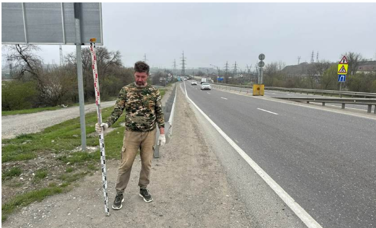
Рис.13. «Капитальный ремонт мостов через канал Чир-ЮртГЭС на км 752+850 автомобильной дороги Р-217 «Кавказ» автомобильная дорога М-4 «Дон» - Владикавказ - Грозный - Махачкала - граница с Азербайджанской Республикой, Республика Дагестан» в Кизилюртовском районе, Республика Дагестан. Рельеф местности и характер растительности участка обследования. Точка фотофиксации 5, вид с СЗ.
