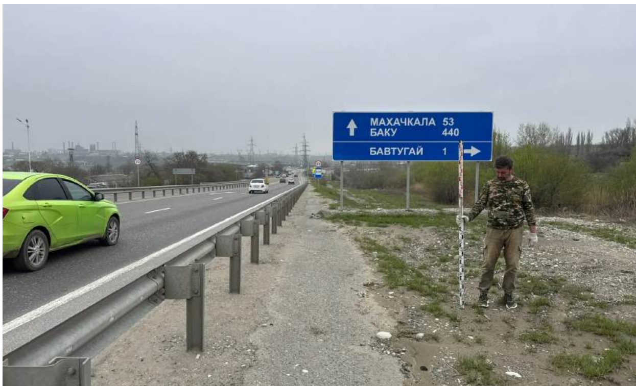
Рис.15. «Капитальный ремонт мостов через канал Чир-ЮртГЭС на км 752+850 автомобильной дороги Р-217 «Кавказ» автомобильная дорога М-4 «Дон» - Владикавказ - Грозный - Махачкала - граница с Азербайджанской Республикой, Республика Дагестан» в Кизилюртовском районе, Республика Дагестан. Рельеф местности и характер растительности участка обследования. Точка фотофиксации 7, вид с СЗ.
