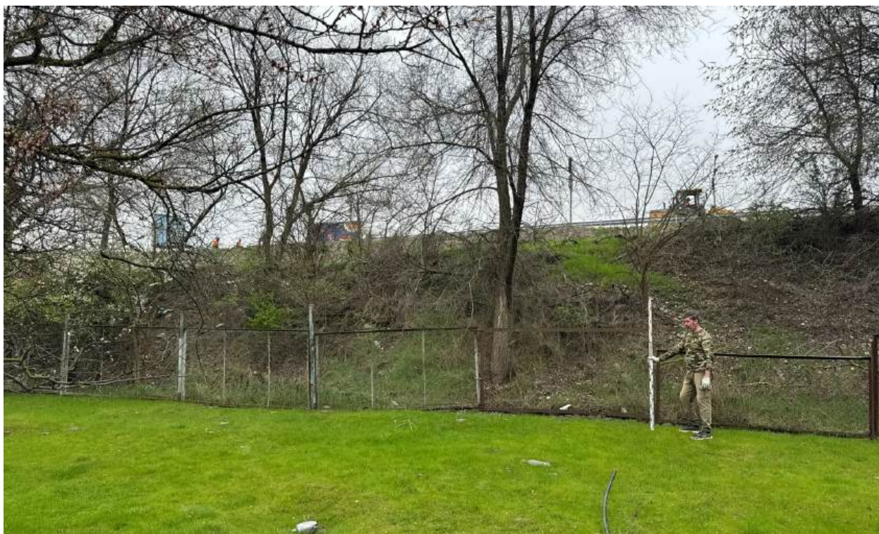
Рис.12. «Капитальный ремонт мостов через канал Чир-ЮртГЭС на км 752+850 автомобильной дороги Р-217 «Кавказ» автомобильная дорога М-4 «Дон» - Владикавказ - Грозный - Махачкала - граница с Азербайджанской Республикой, Республика Дагестан» в Кизилюртовском районе, Республика Дагестан. Рельеф местности и характер растительности участка обследования. Точка фотофиксации 4, вид с С.
