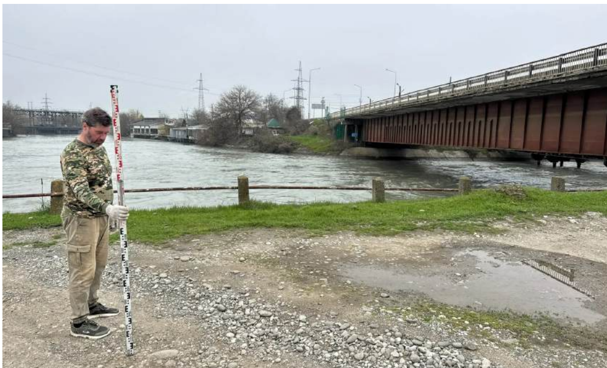
Рис.11. «Капитальный ремонт мостов через канал Чир-ЮртГЭС на км 752+850 автомобильной дороги Р-217 «Кавказ» автомобильная дорога М-4 «Дон» - Владикавказ - Грозный - Махачкала - граница с Азербайджанской Республикой, Республика Дагестан» в Кизилюртовском районе, Республика Дагестан. Рельеф местности и характер растительности участка обследования. Точка фотофиксации 3, вид с СЗ.
