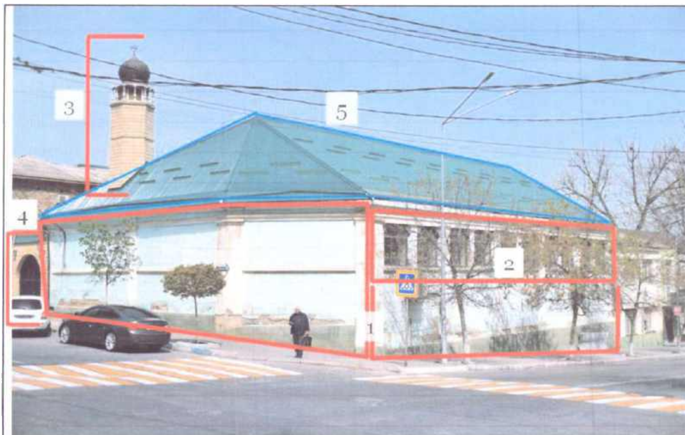
Общий вид с южной стороны.
