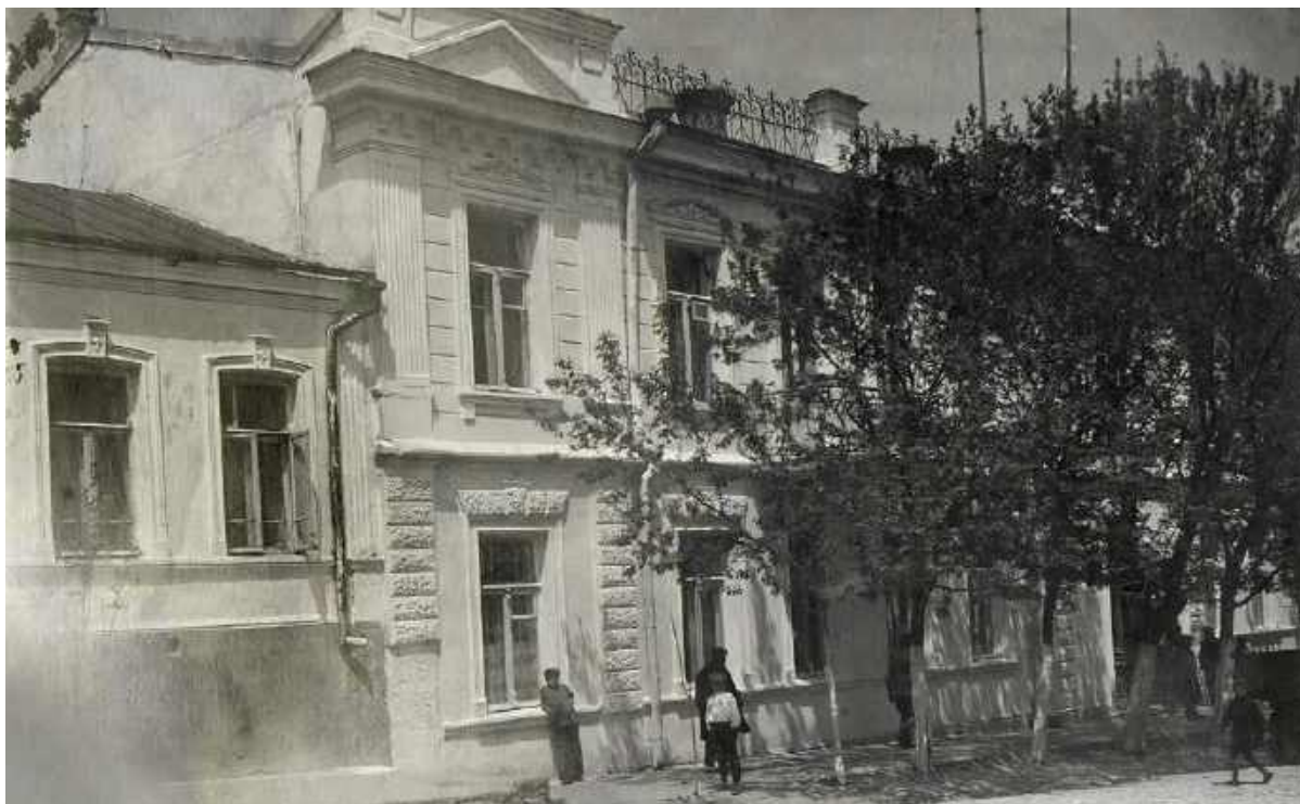
Илл. № 3. Здание Совета народных комиссаров Дагестанской автономной республики 1926 – 1936, Россия, Дагестан, Махачкала Бывший дом Крайнева В. П. Ул. Горького (бывш. Бассейная ул.), 10. Источник: Государственный исторический музей (ГИМ): 47310168, 89430/5250, Ф 14684. Адрес точки съемки: Ул. Горького. Направление съемки: Север
