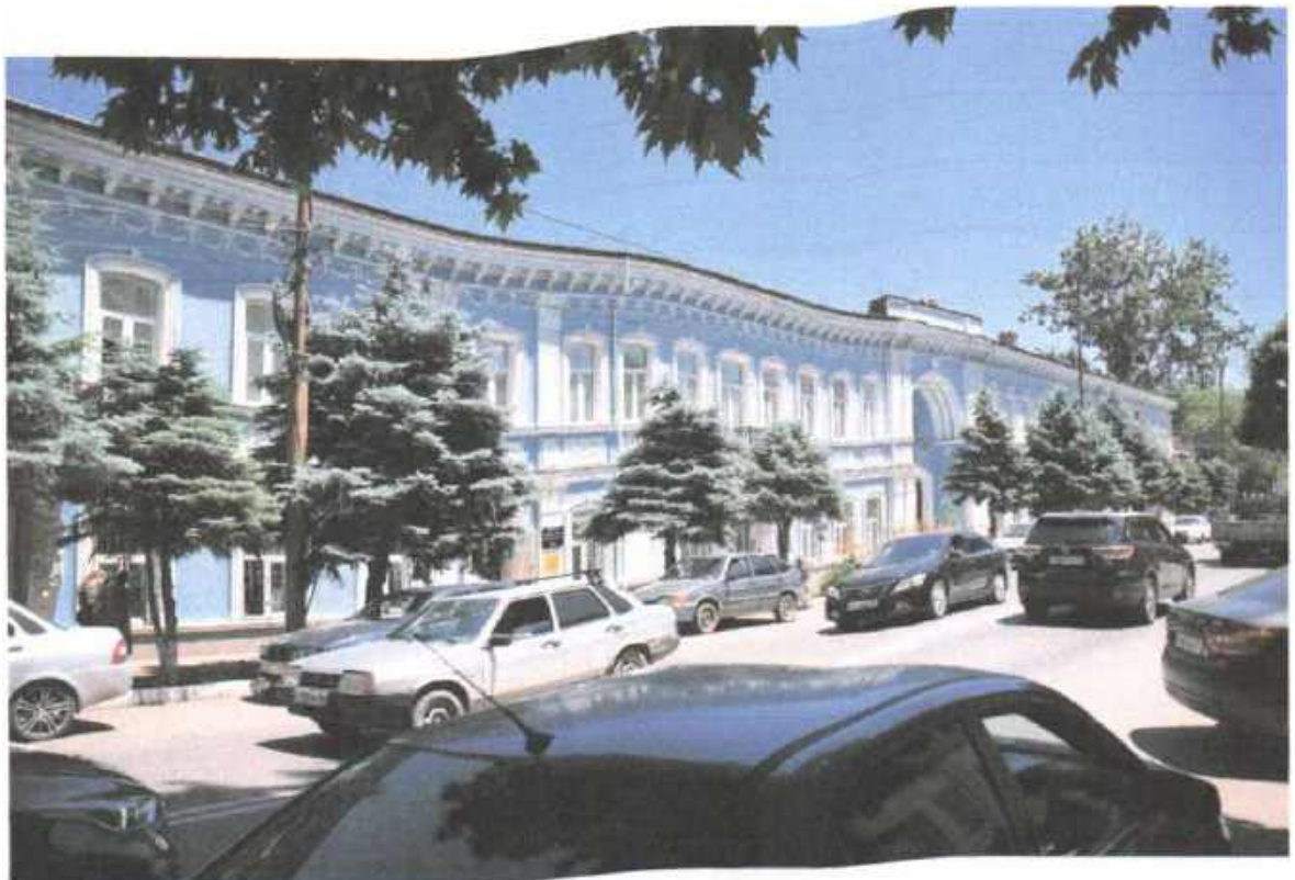
Т.ф.1. Общий вид на главный фасад здания
