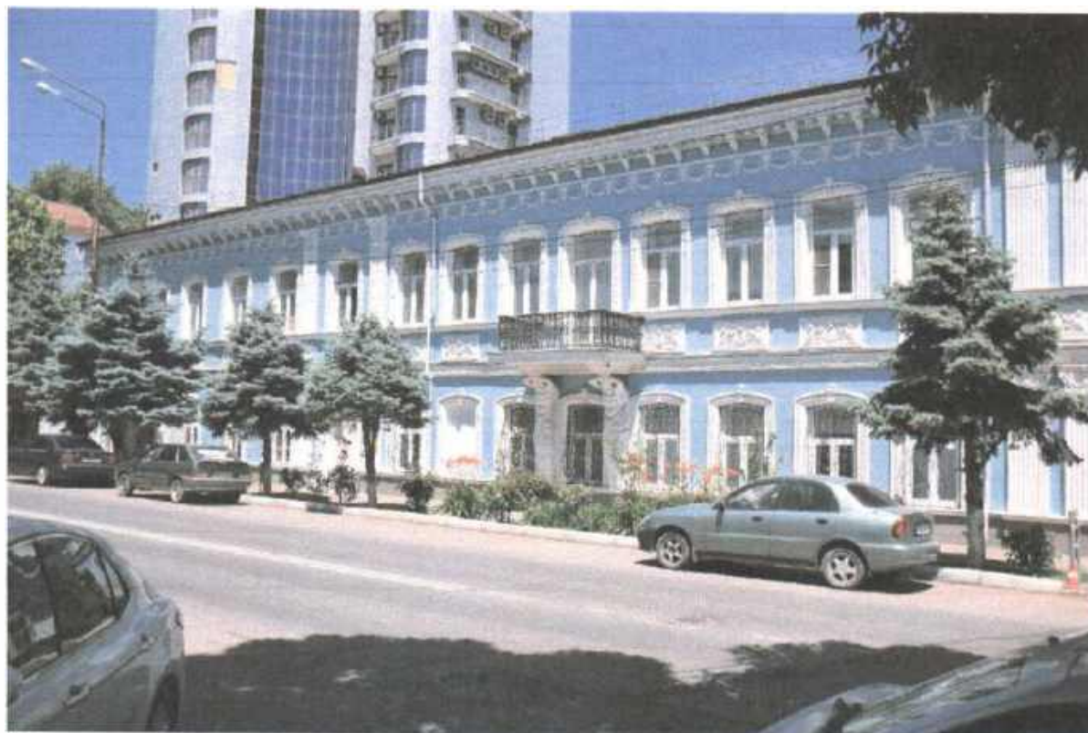
Т.ф.6. Вид на главный фасад.
