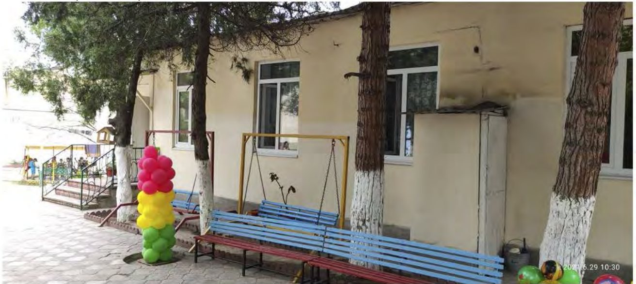
Илл. 39. Вид фасада строения детского сада.
