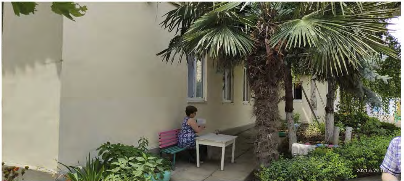
Илл. 37. Вид фасада строения детского сада.
