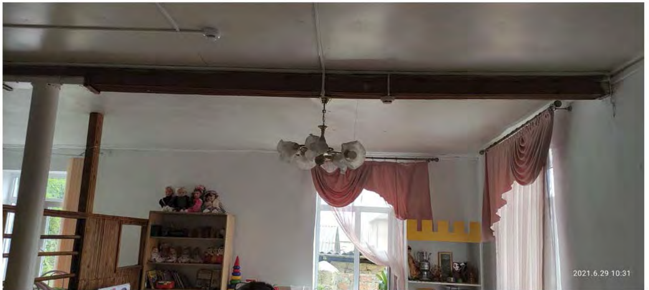
Илл.40. Вид внутри помещения.
