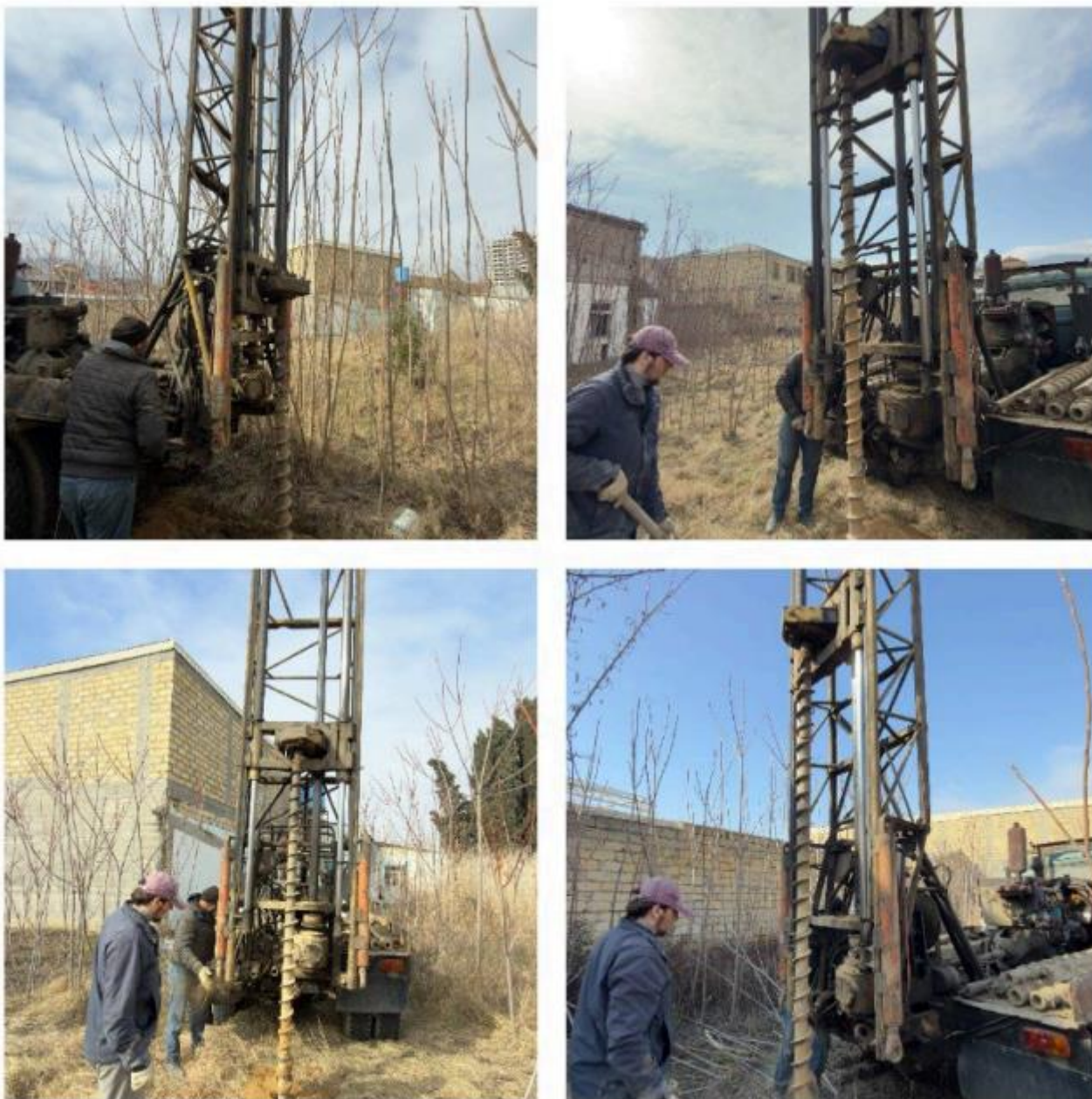
Фоторегистрация буровых работ на участке строительства
