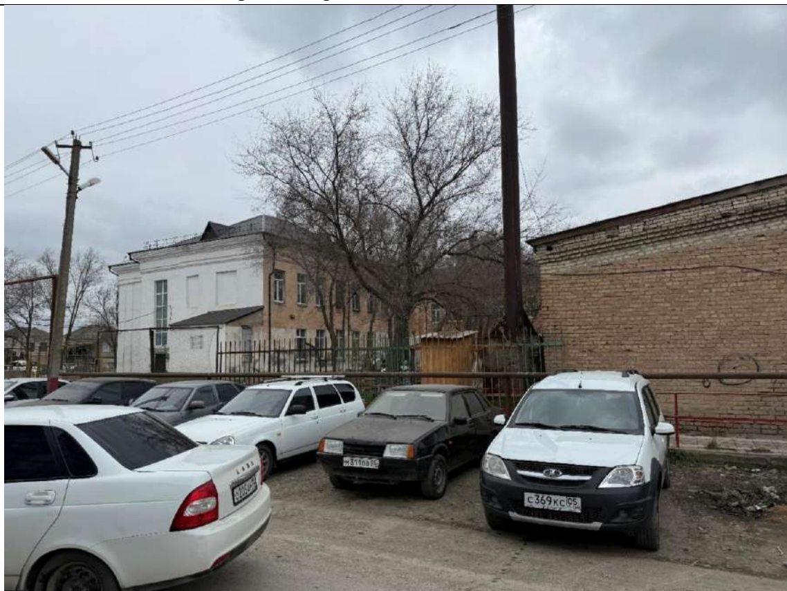
Вид на Объект с северного направления с четной стороны ул. Амирагова. Фрагментарная, сезонная видимость.
