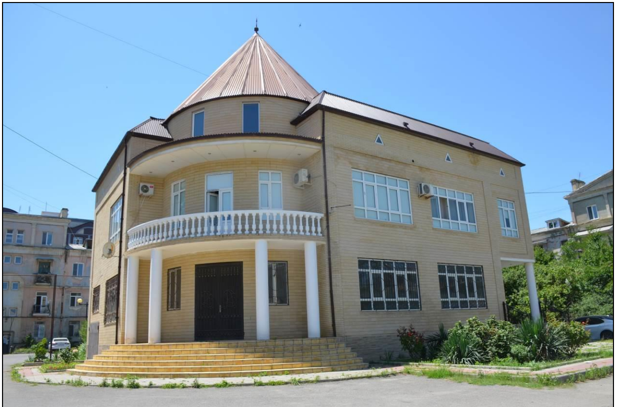
Окружение исследуемого объекта культурного наследия Т.ф. 0.1. Вид на застройку и градостроительную ситуацию внутриквартальной территории, вид с юго-востока.
