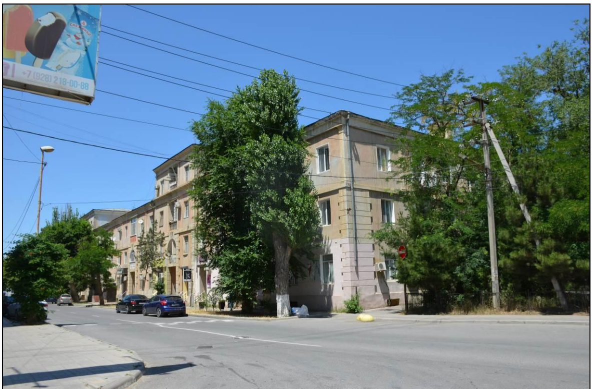
Объект культурного наследия регионального значения «Дом, где жил инженер А. Аливердиев», 1988 год (Республика Дагестан, г. Каспийск, ул. Советская, 17) Т.ф. 1.8. Вид на Объект исследования с ул. Советской, с юга.
