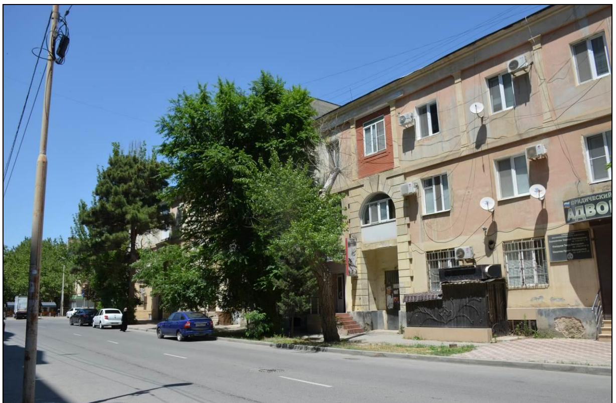
Объект культурного наследия регионального значения «Дом, где жил инженер А. Аливердиев», 1988 год (Республика Дагестан, г. Каспийск, ул. Советская, 17) Т.ф. 1.11. Вид на Объект исследования с ул. Советской, с юга.
