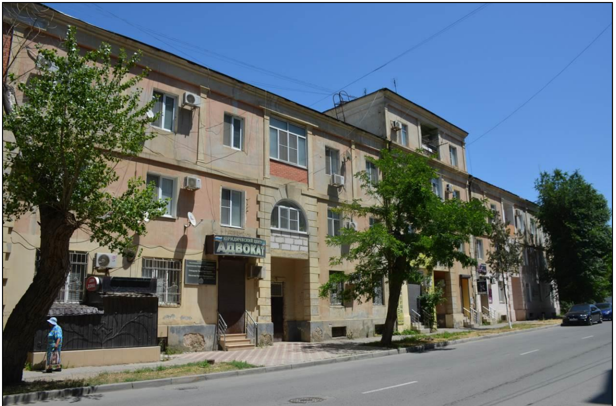
Объект культурного наследия регионального значения «Дом, где жил инженер А. Аливердиев», 1988 год (Республика Дагестан, г. Каспийск, ул. Советская, 17) Т.ф. 1.12. Вид на Объект исследования с ул. Советской, с северо-запада.
