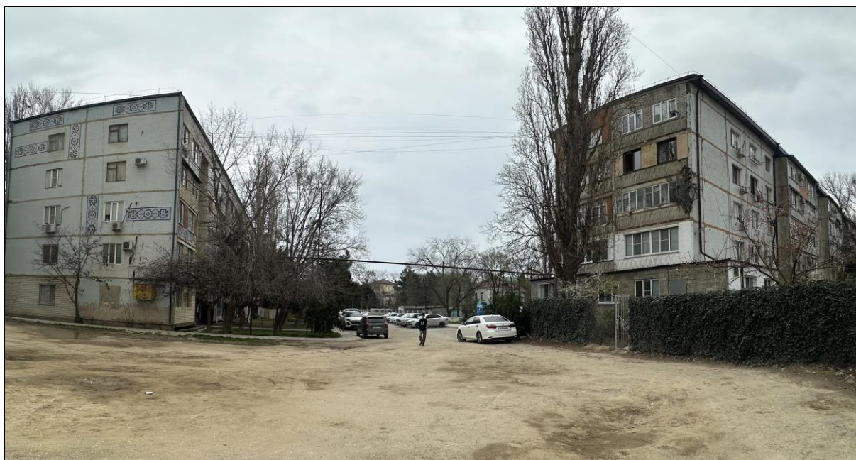
Окружение исследуемого объекта культурного наследия Т.ф. 0.60. Вид на застройку и градостроительную ситуацию южной части исследуемой территории, с юга.
