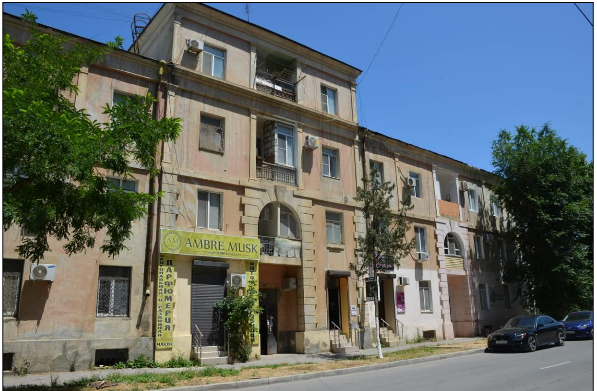
Объект культурного наследия регионального значения «Дом, где жил инженер А. Аливердиев», 1988 год (Республика Дагестан, г. Каспийск, ул. Советская, 17) Т.ф. 1.10. Вид на Объект исследования с ул. Советской, с северо-запада.
