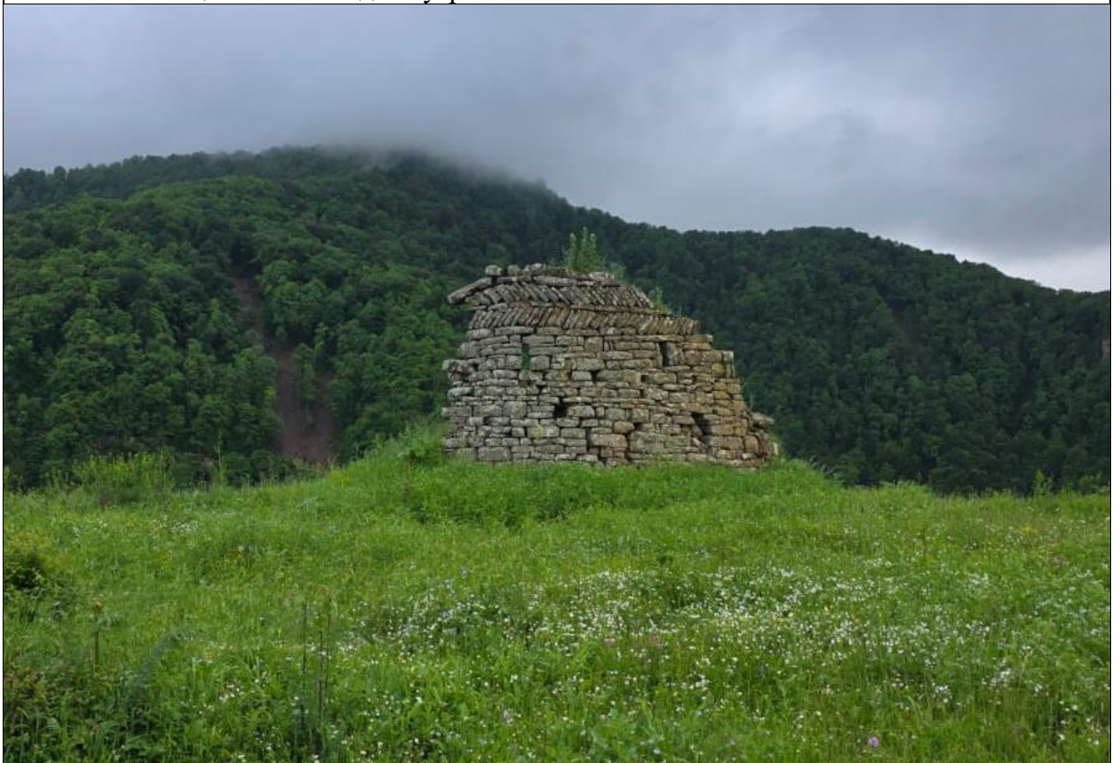
Фото 6. Вид башни с севера
