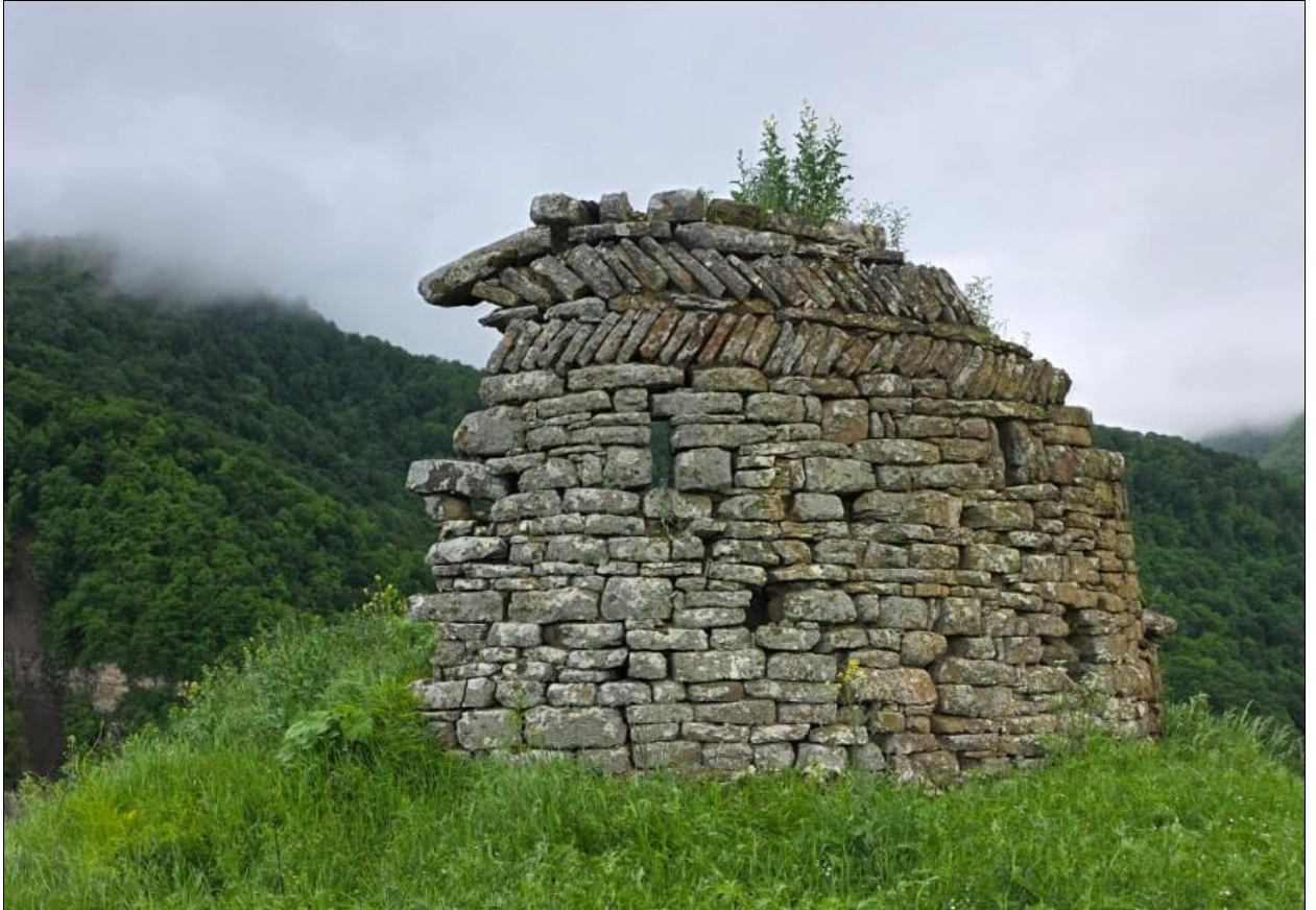
Фото 3. Вид башни с севера
