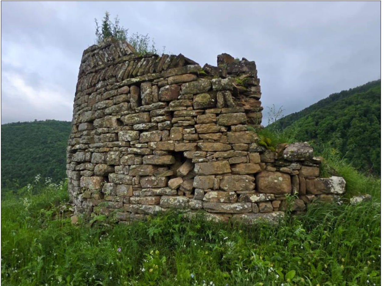
Фото 1. Вид башни с востока
