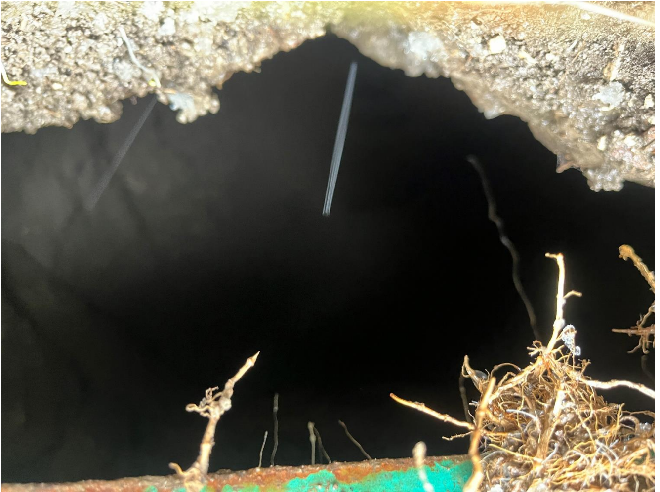
Рис. 4. Фото от 28.03.2026 г. Один из колодцев подземного водопровода вблизи Шамхальского кладбища.
