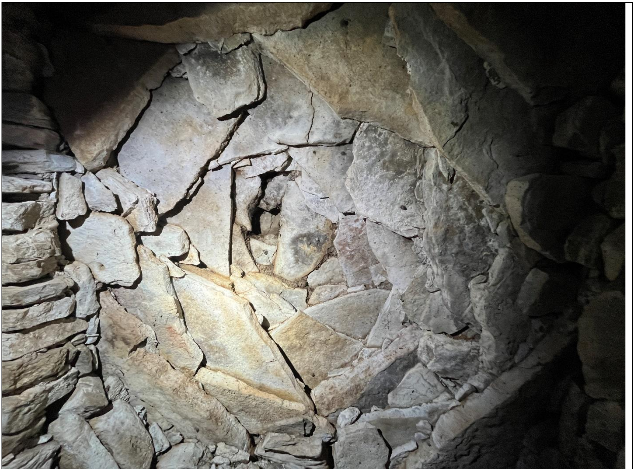
Фото 11. Ложный свод, опирающийся на подпружные арки
