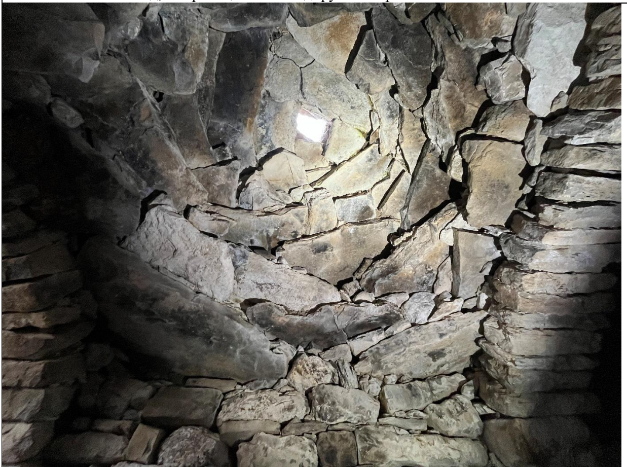
Фото 14. Ложный свод, опирающийся на подпружные арки
