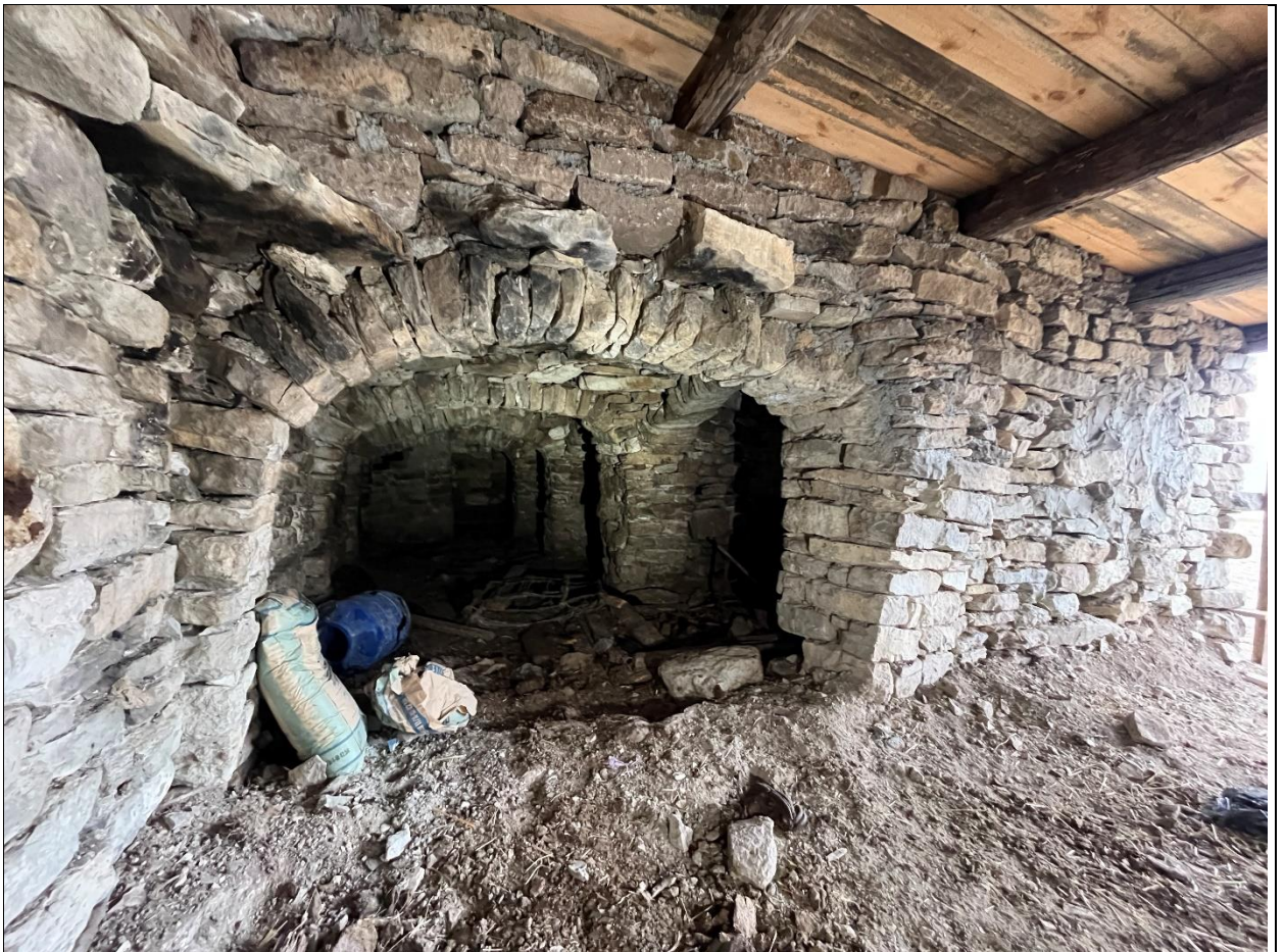
Фото 5. Арочный вход в сводчатые помещения постройки
