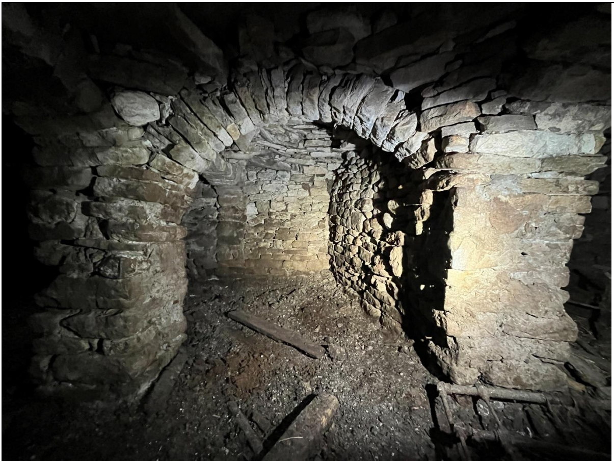
Фото 7. Подпружная большая арка в центральной западной части сводчатого помещения. Вид с севера
