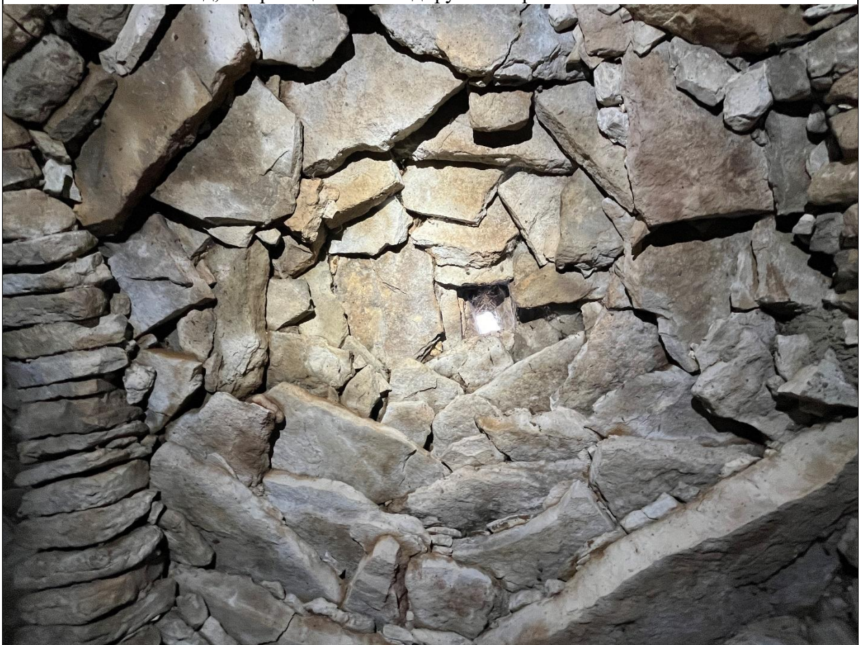
Фото 12. Ложный свод, опирающийся на подпружные арки
