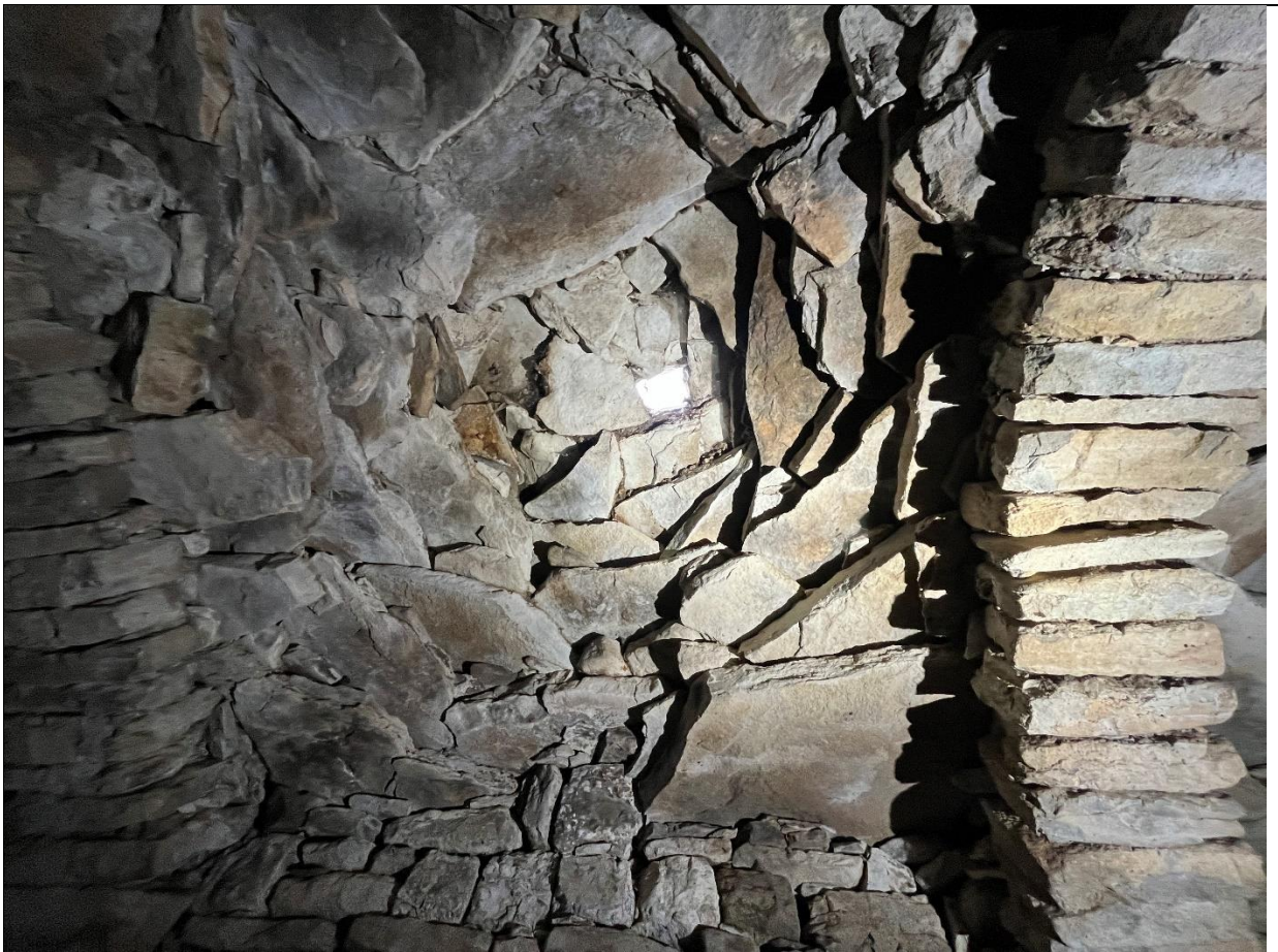
Фото 13. Ложный свод, опирающийся на подпружные арки
