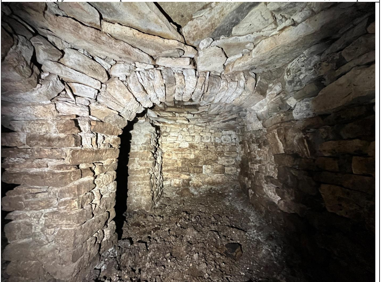
Фото 10. Подпружная малая арка в восточной части сводчатого помещения. Вид с юга
