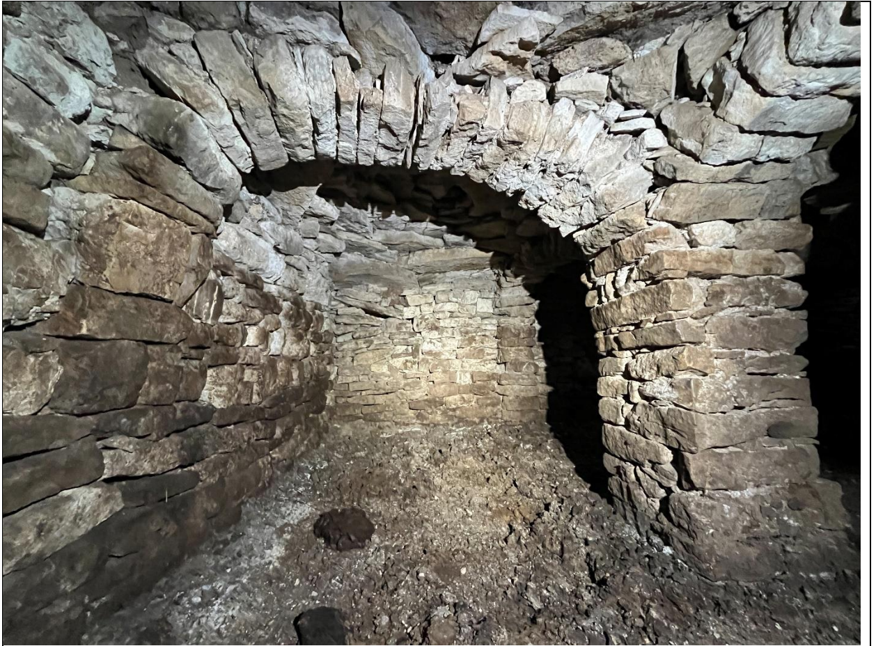
Фото 9. Подпружная малая арка в восточной части сводчатого помещения. Вид с севера
