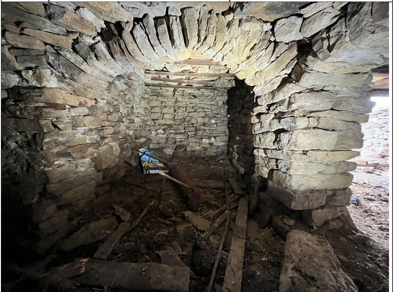
Фото 6. Подпружная малая арка в западной части сводчатого помещения. Вид с севера
