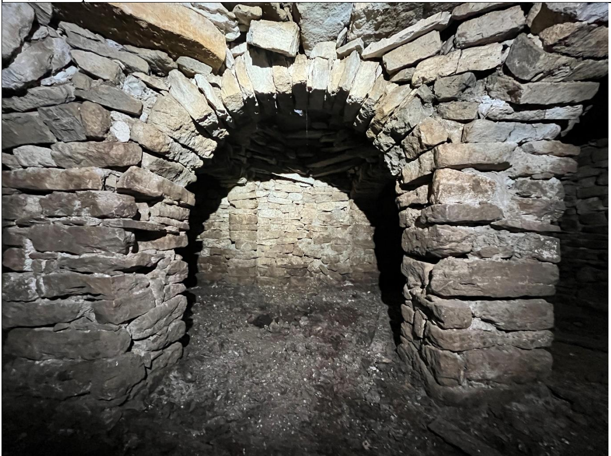
Фото 8. Подпружная большая арка в центральной восточной части сводчатого помещения. Вид с севера
