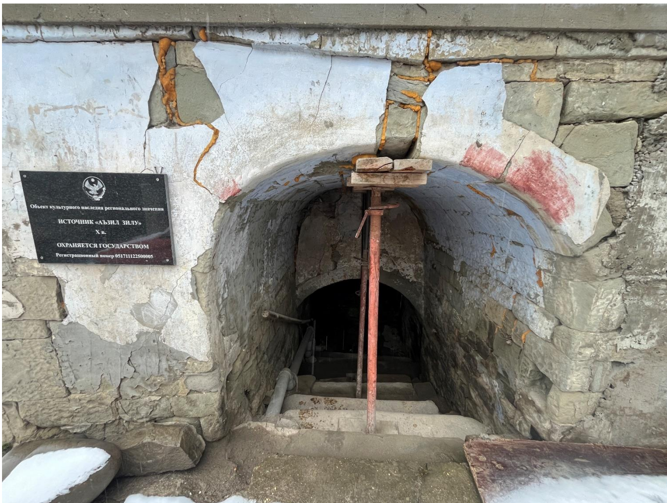
Рис. 4. Фото от 28.03.2026 г. Вид с севера исследуемого объекта.
