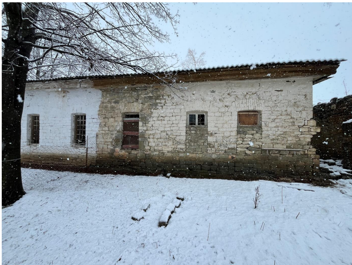
Фото 46. 28.03.2026 г. Корпус 5. Северный фасад.
