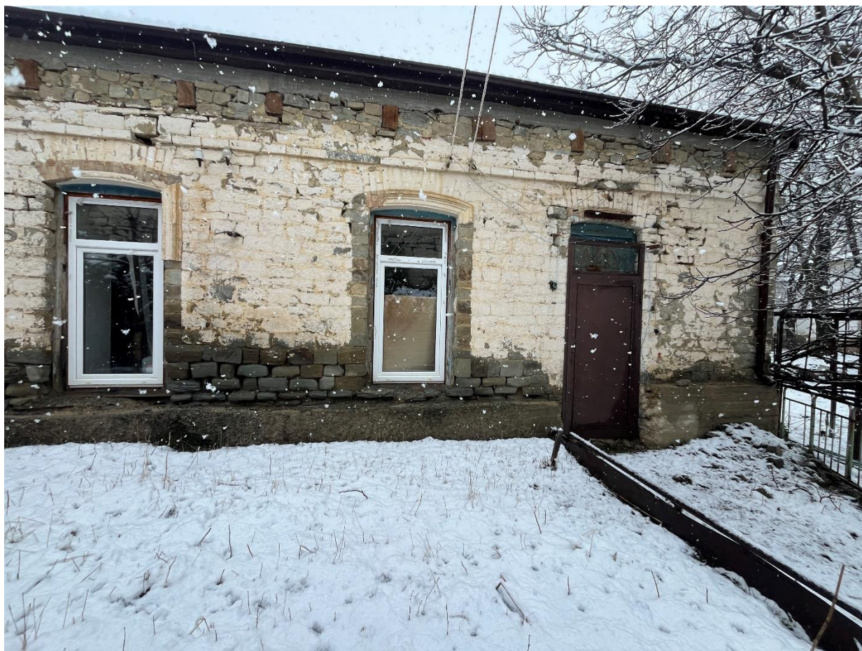
Фото 26. 28.03.2026 г. Вид с запада на восточный блок корпуса 2.
