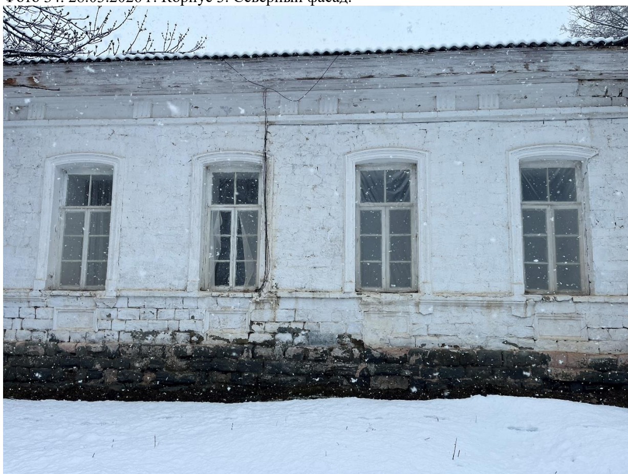
Фото 35. 28.03.2026 г. Корпус 3. Северный фасад.
