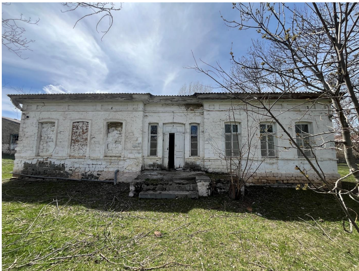
Фото 30. 16.04.2026 г. Корпус 3. Вид с востока.
