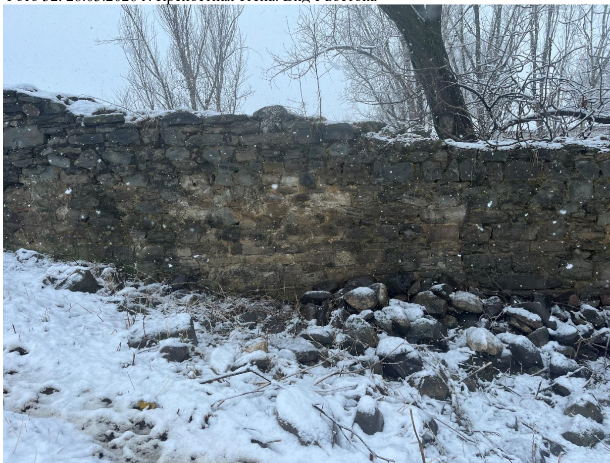
Фото 53. 28.03.2026 г. Фрагмент крепостной стены в восточной части крепости
