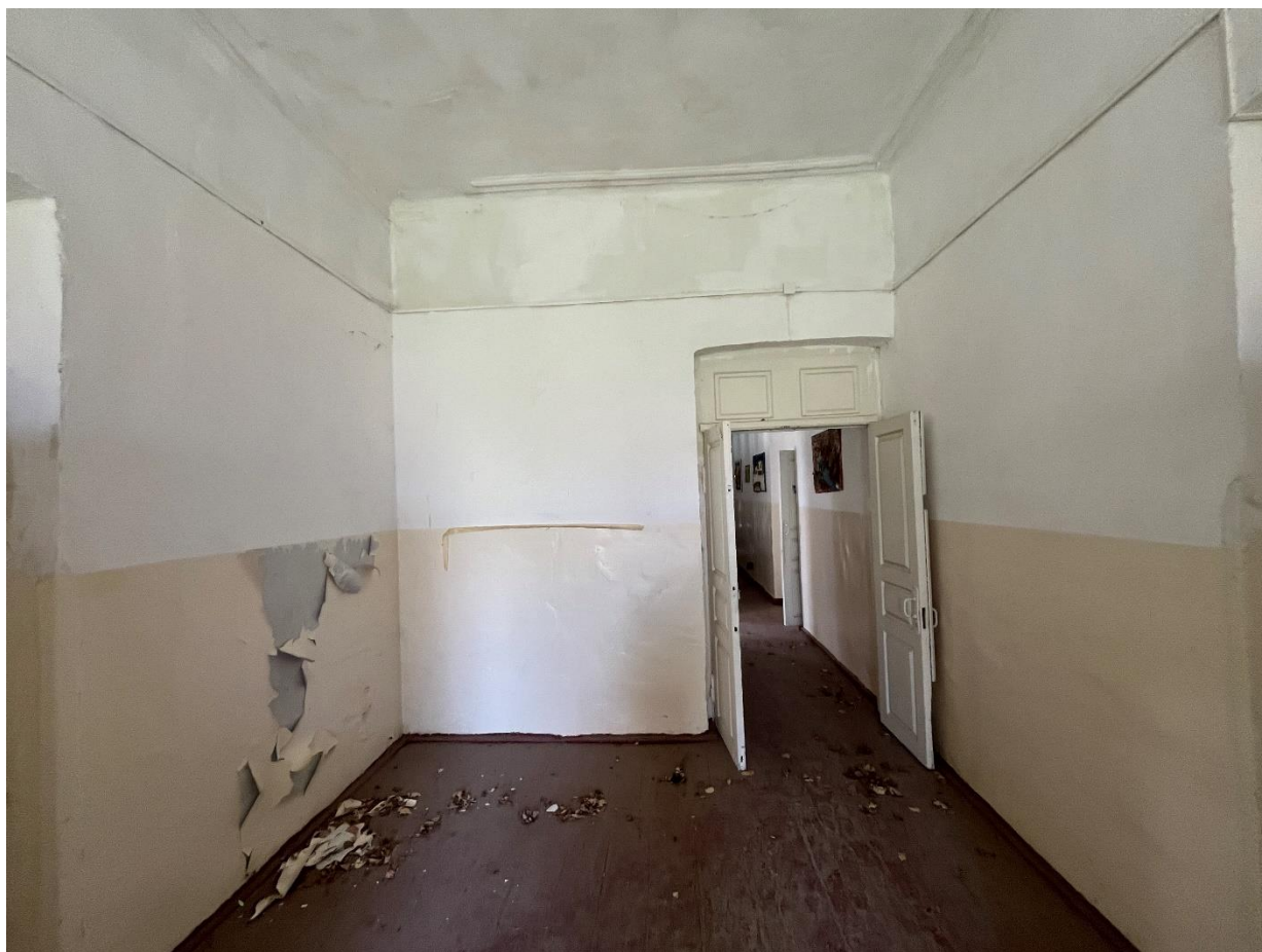
Фото 40. 16.04.2026 г. Корпус 3. Интерьер
