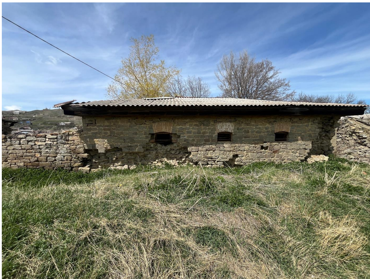
Фото 48. 16.04.2026 г. Корпус 5. Южный фасад.
