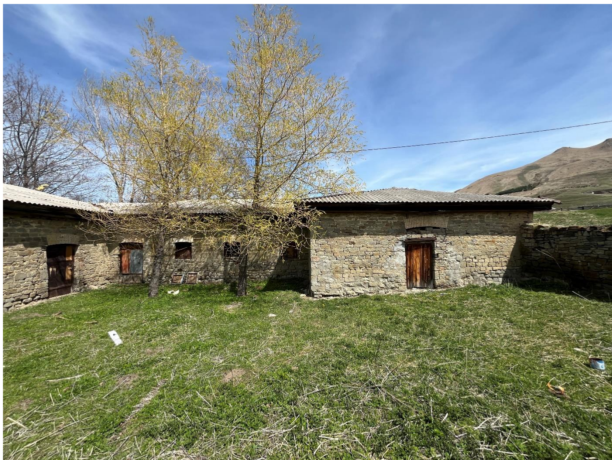
Фото 44. 16.04.2026 г. Корпус 5. Западный фасад.
