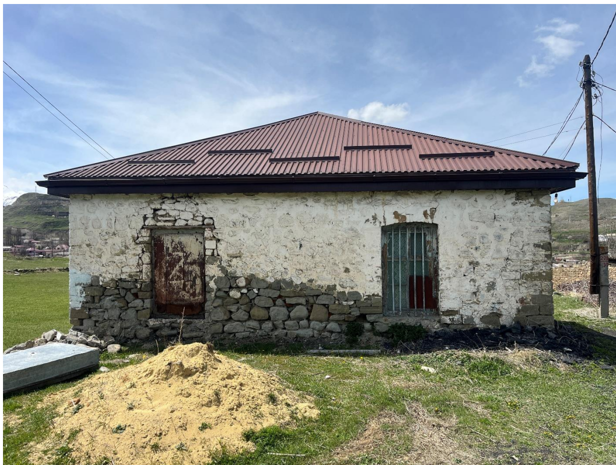
Фото 50. 16.04.2026 г. Корпус 6. Восточный фасад.
