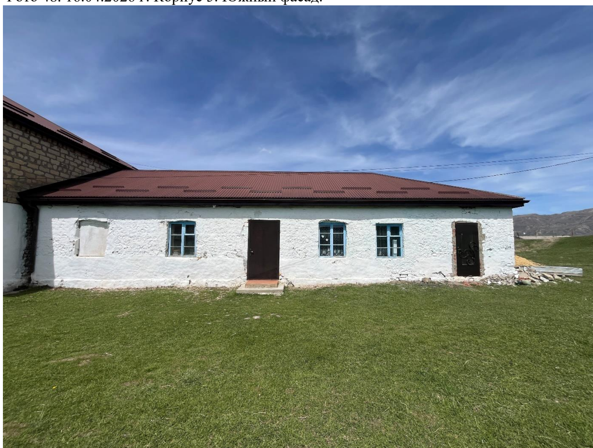
Фото 49. 16.04.2026 г. Корпус 6. Южный фасад.
