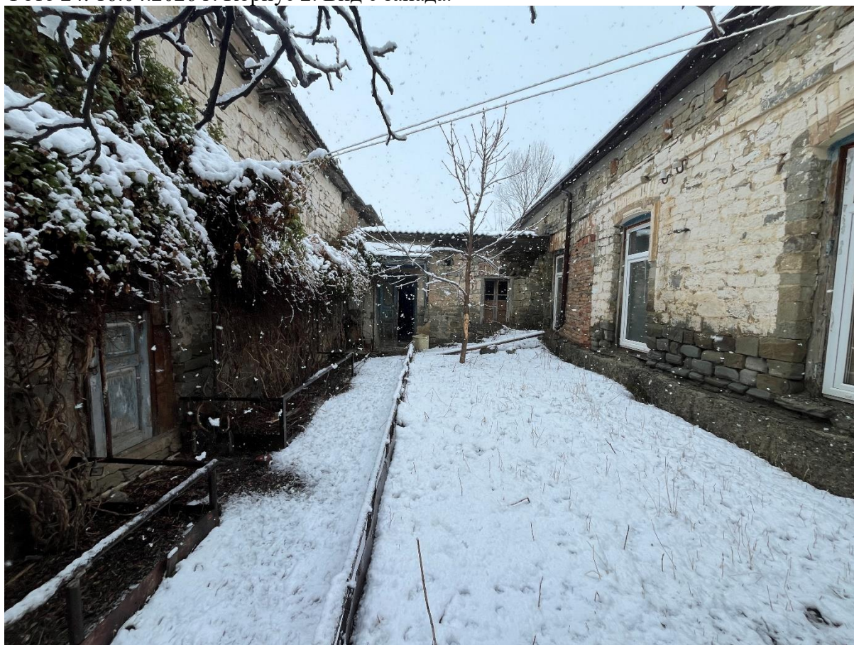
Фото 25. 28.03.2026 г. Корпус 2. Вид с юга на коридор, соединяющий два блока корпуса.
