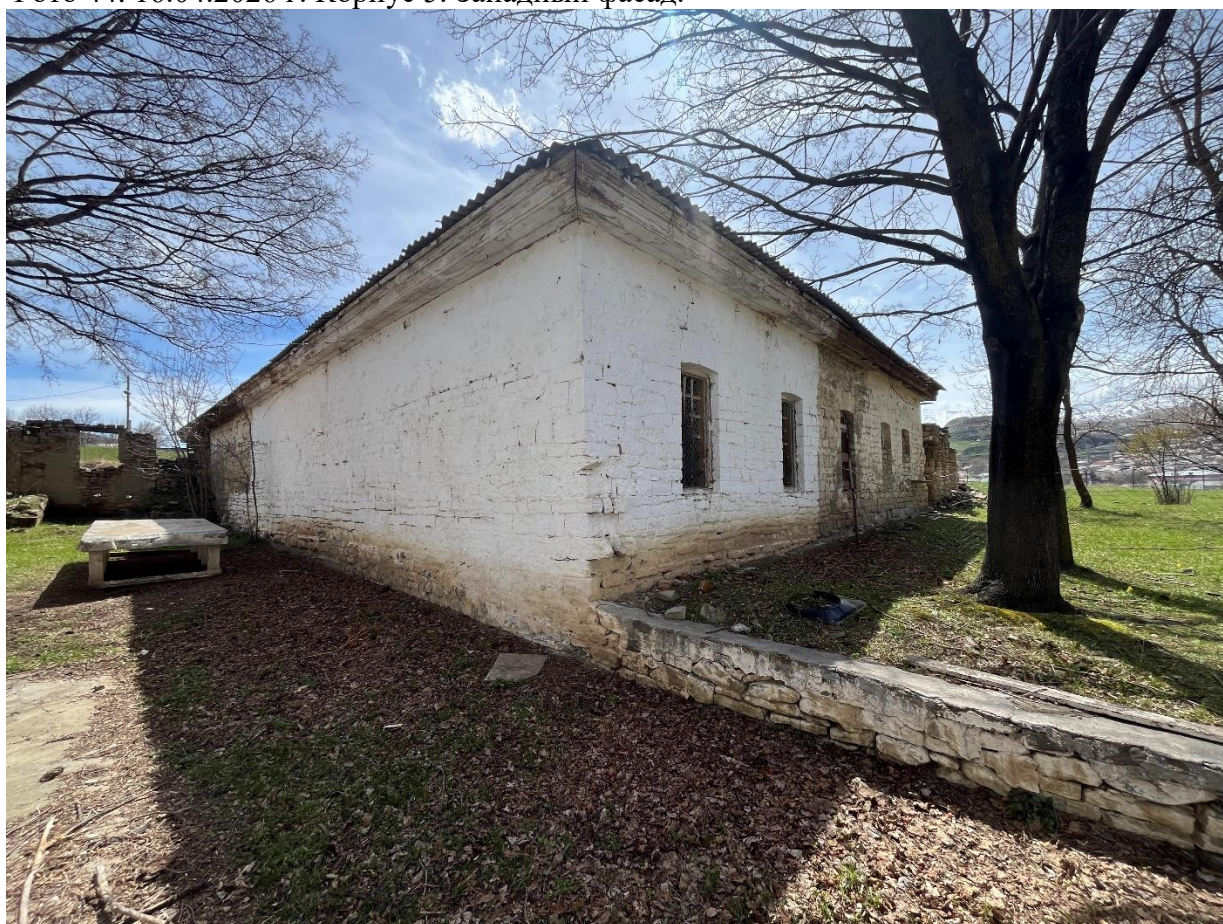
Фото 45. 16.04.2026 г. Корпус 5. Северо-западный угол
