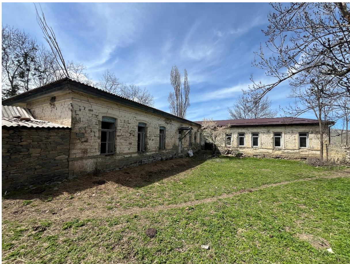
Фото 16. 16.04.2026 г. Корпус 1. Вид с юго-востока.
