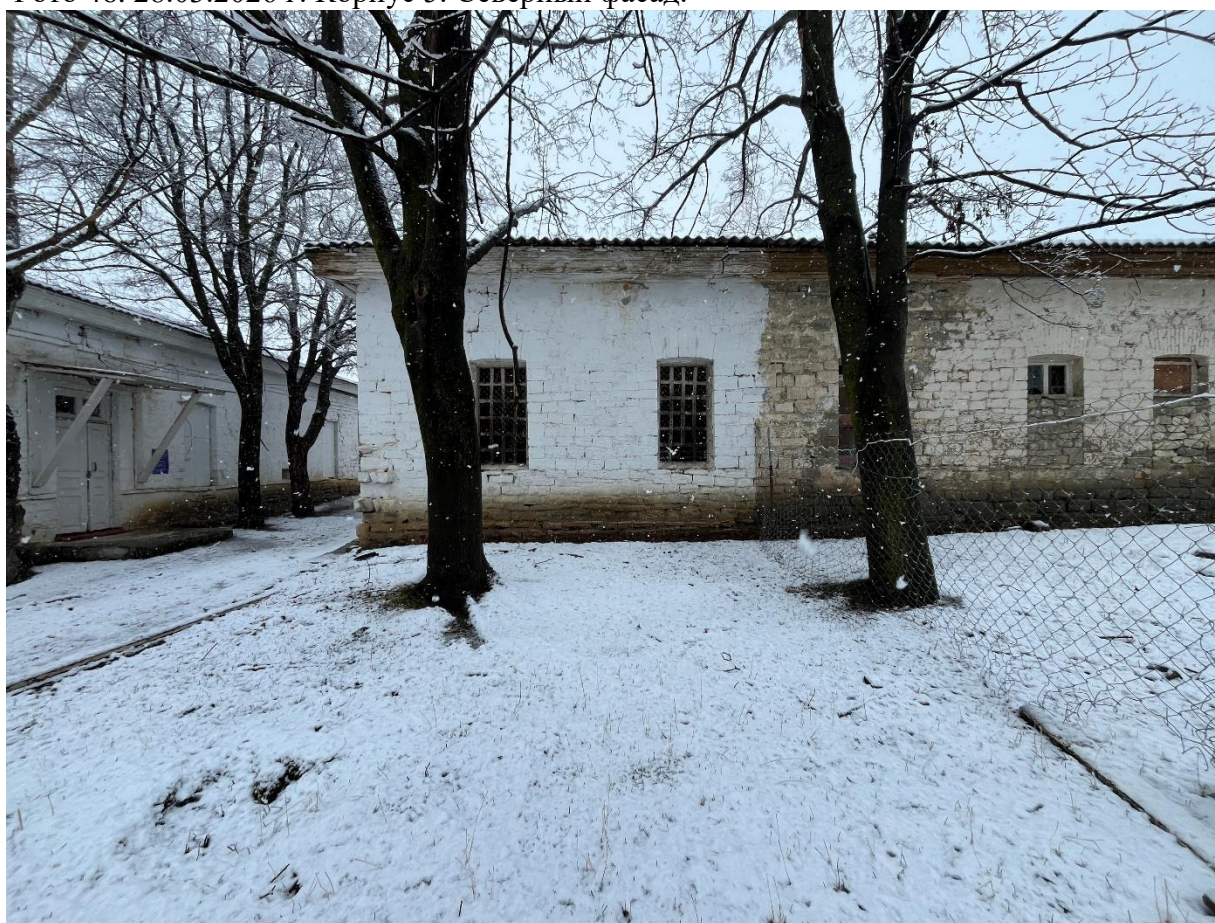
Фото 47. 28.03.2026 г. Корпус 5. Северный фасад.
