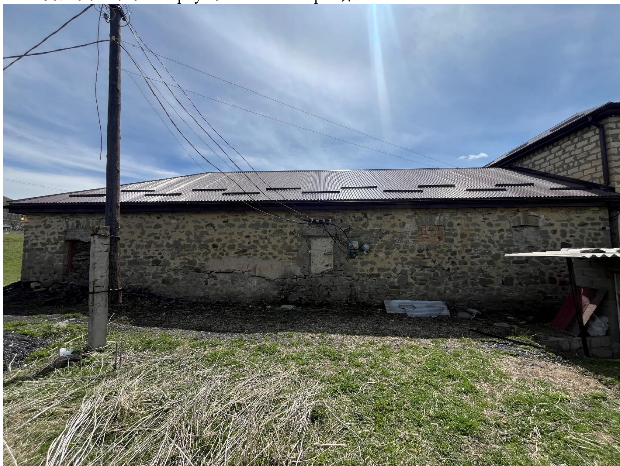
Фото 51. 16.04.2026 г. Корпус 6. Северный фасад.
