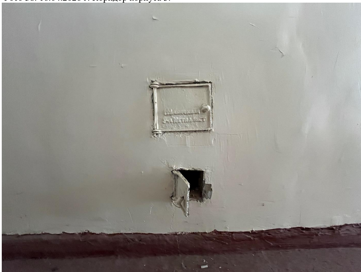
Фото 39. 16.04.2026 г. Встроенная в стену печь корпуса 3.
