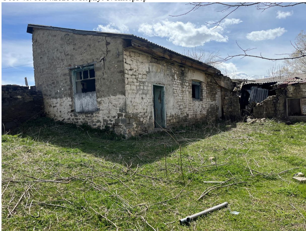
Фото 41. 16.04.2026 г. Корпус 4. Вид с северо-востока.
