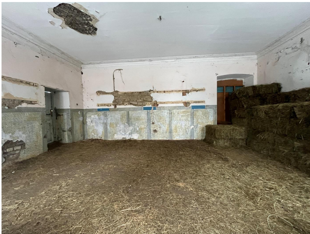
Фото 22. 28.03.2026 г. Корпус 1. Интерьер.
