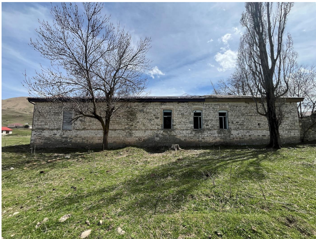
Фото 18. 16.04.2026 г. Корпус 1. Вид с севера.
