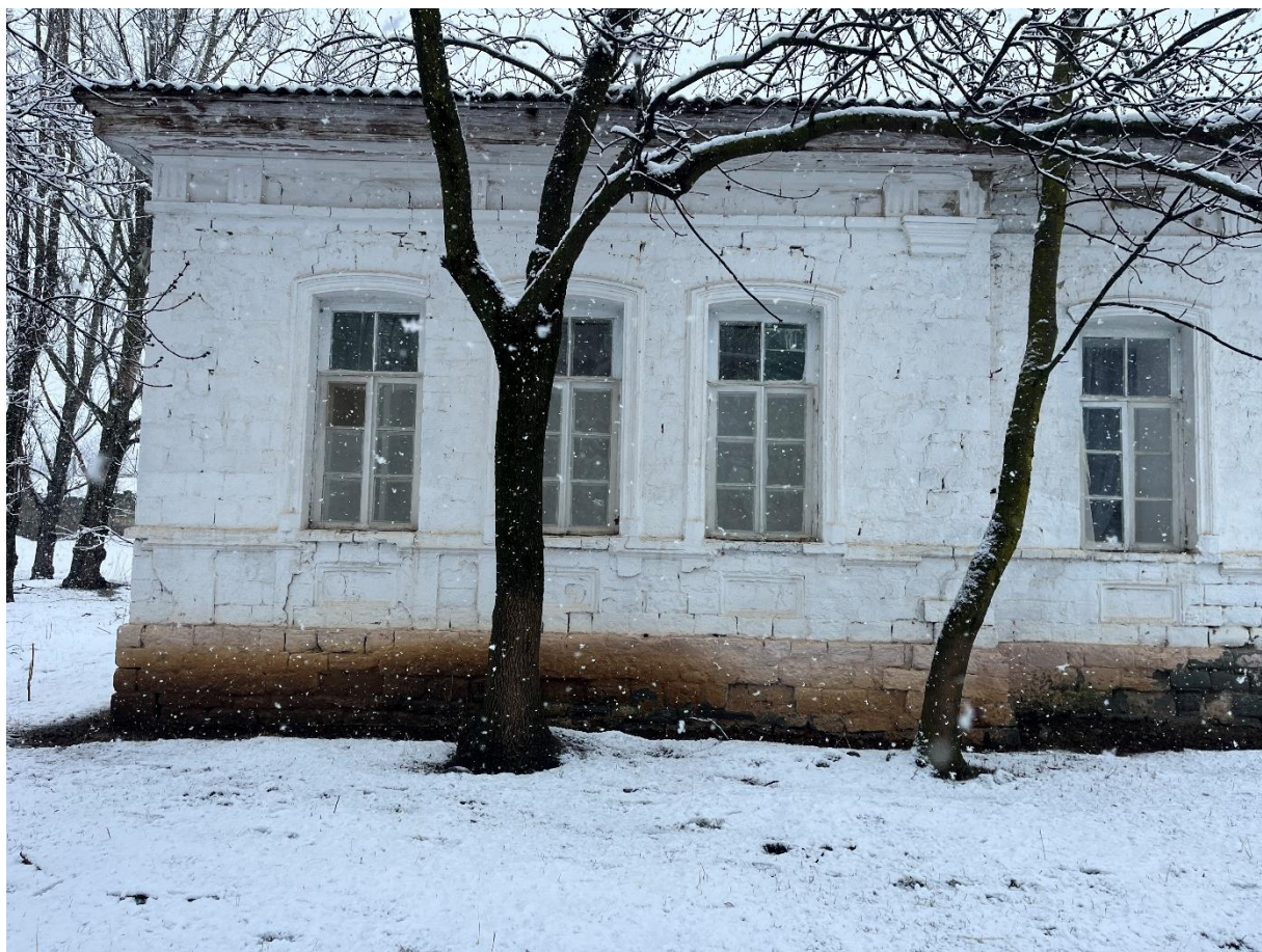
Фото 36. 28.03.2026 г. Корпус 3. Северный фасад.
