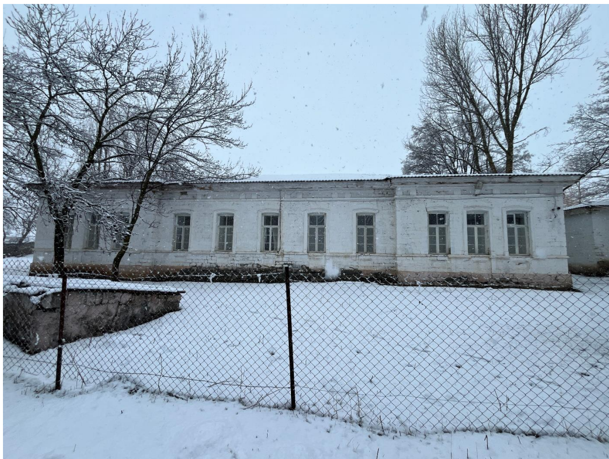
Фото 32. 28.03.2026 г. Корпус 3. Северный фасад.
