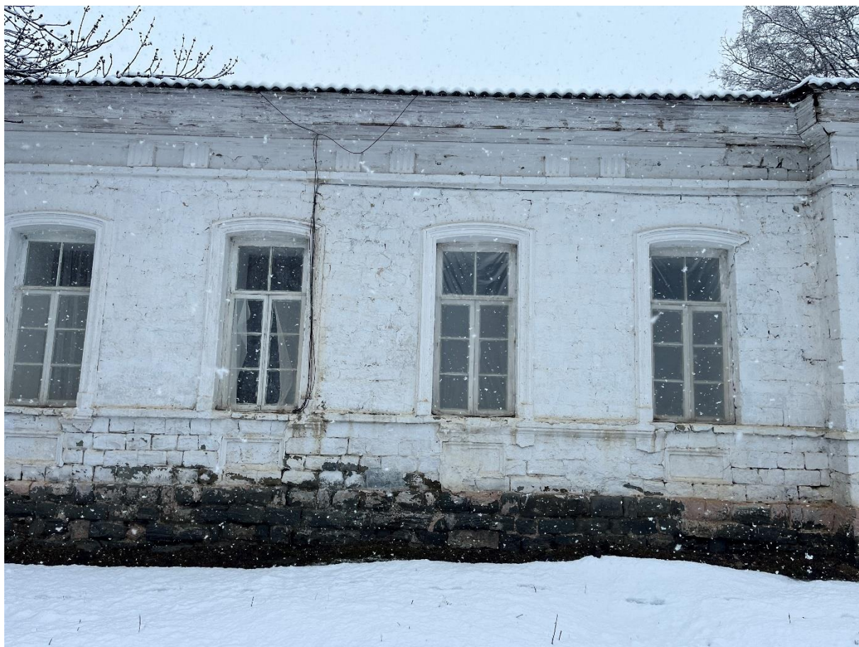
Фото 34. 28.03.2026 г. Корпус 3. Северный фасад.
