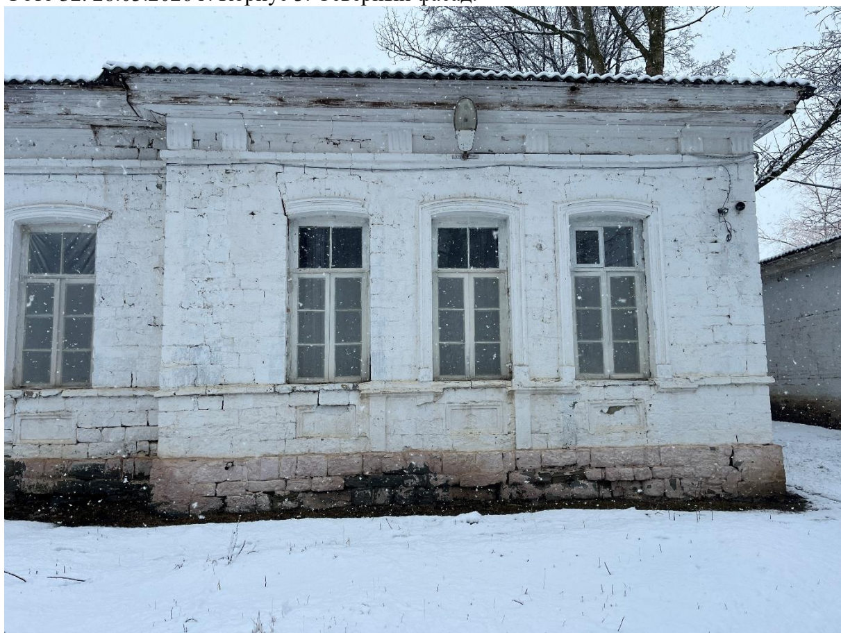
Фото 33. 28.03.2026 г. Корпус 3. Северный фасад.
