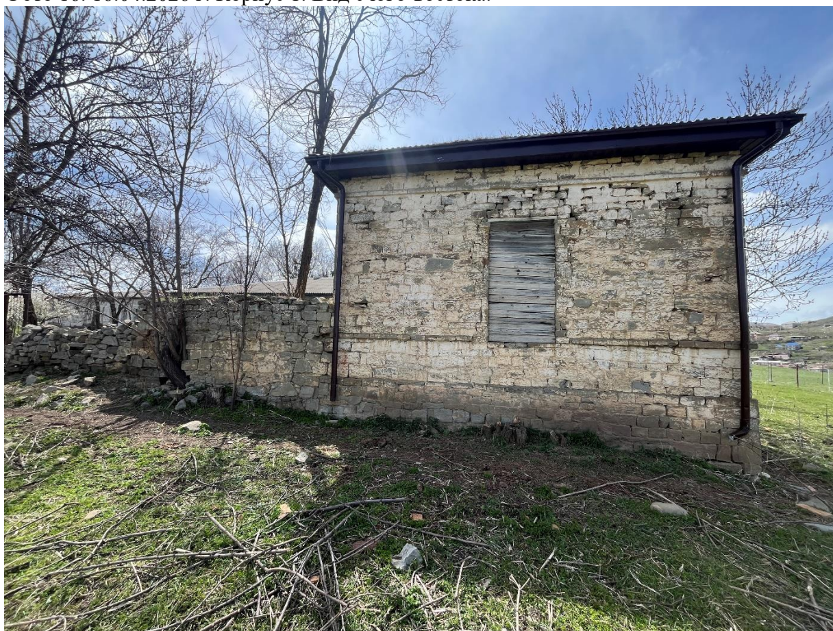
Фото 17. 16.04.2026 г. Корпус 1 и часть стены крепости. Вид с северо-востока.
