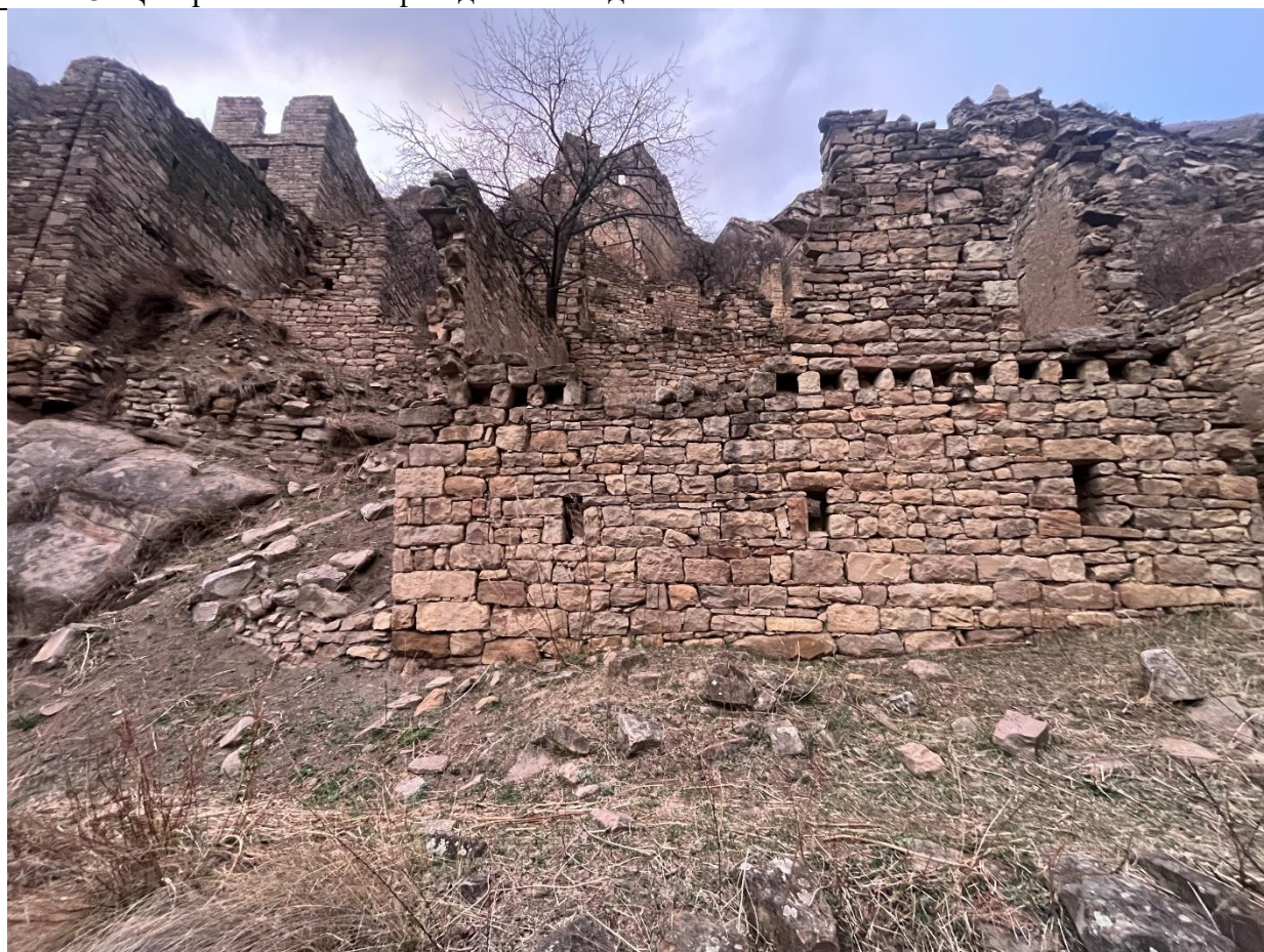
Фото 4. Центральная и западная часть фасада жилого дома
