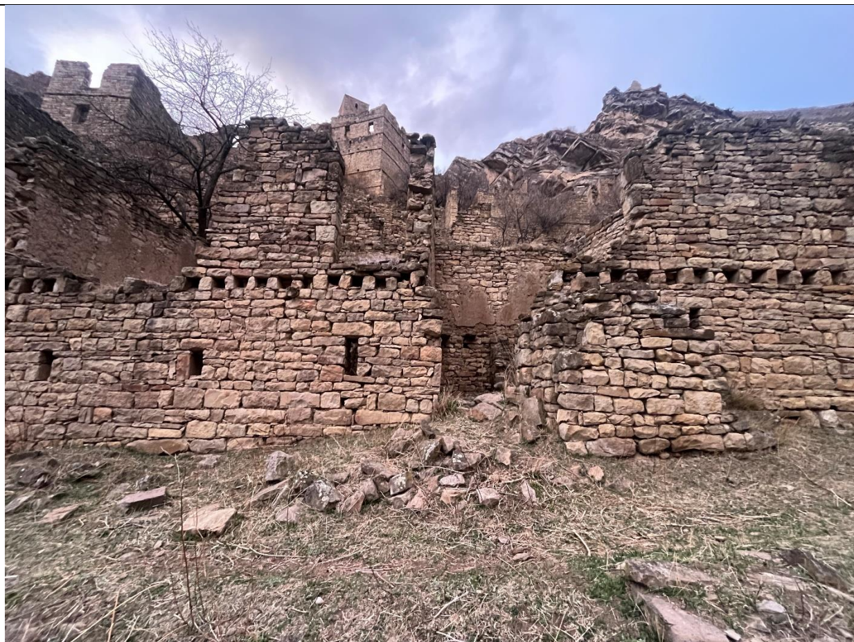
Фото 3. Центральная часть фасада жилого дома
