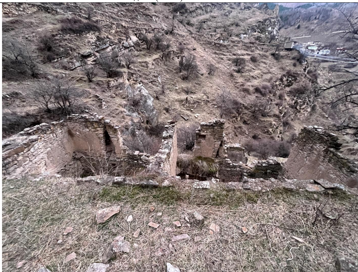
Фото 6. Вид на жилой дом с севера
