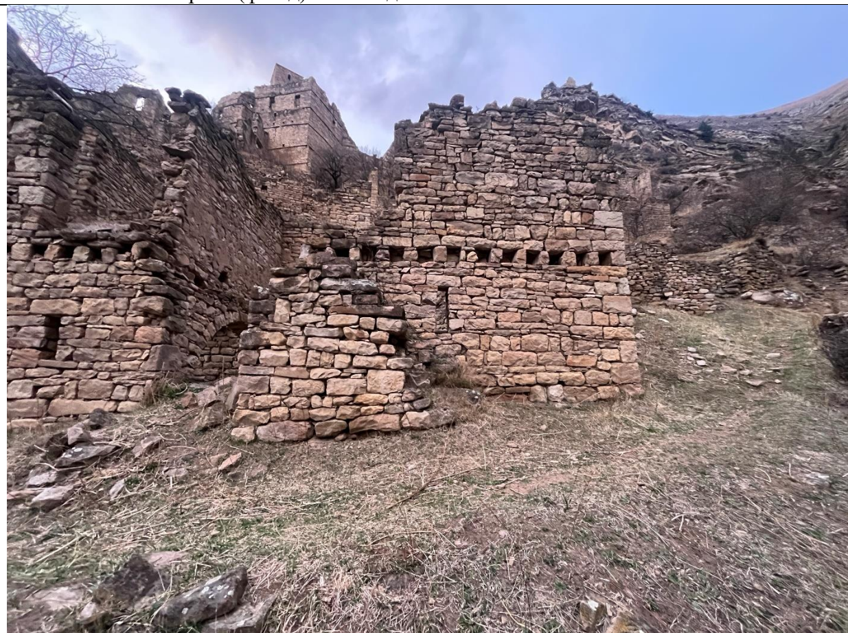
Фото 2. Центральная и восточная часть фасада жилого дома
