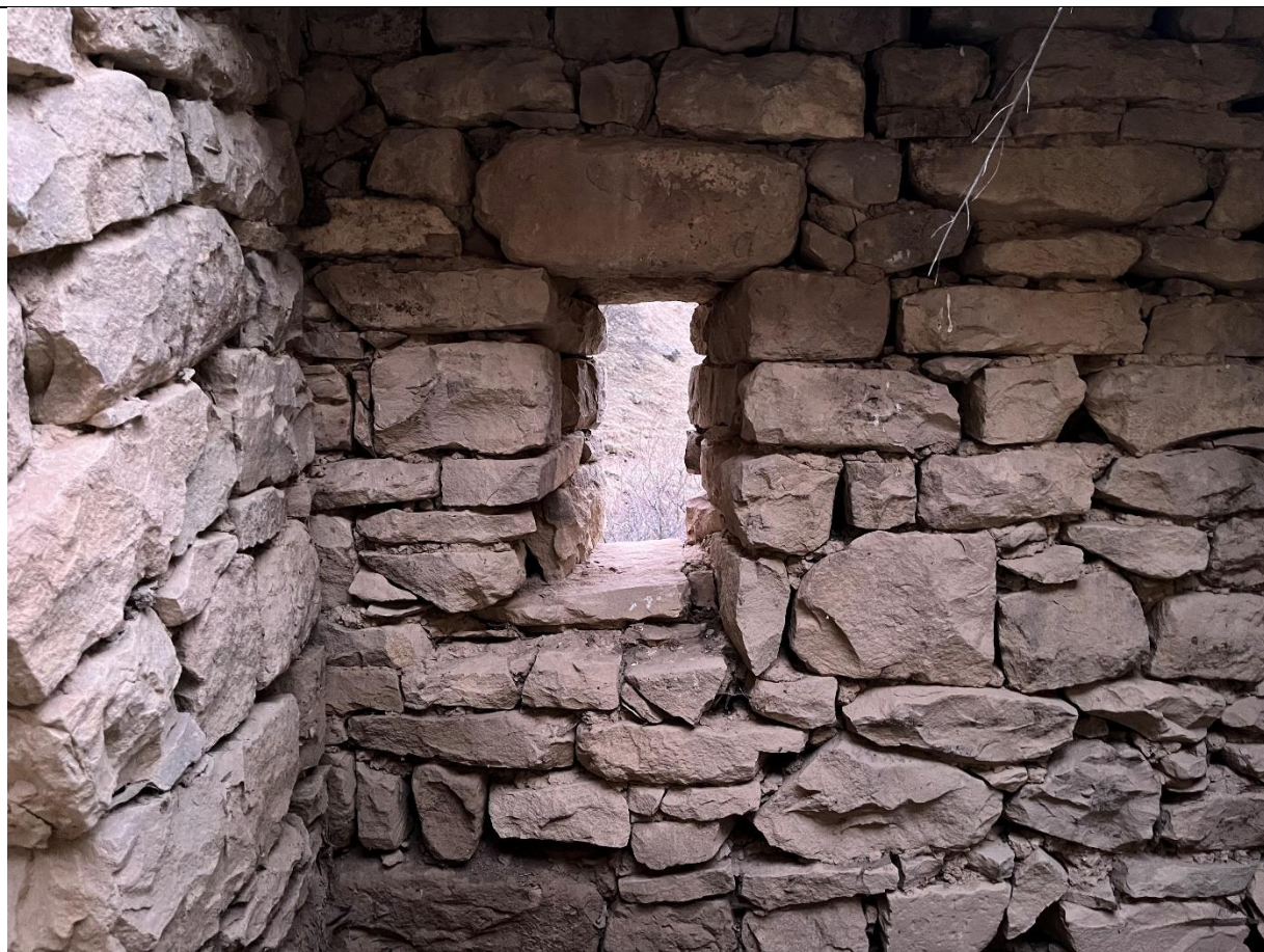
Фото 11. Оконный проем на первом этаже западной части жилого дома
