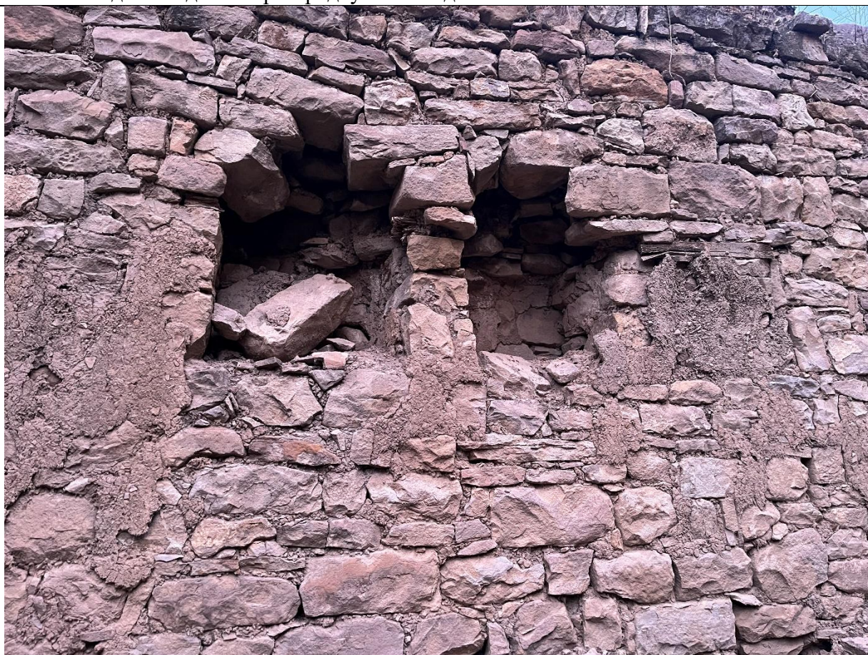
Фото 10. Ниши на втором этаже в западной части дома
