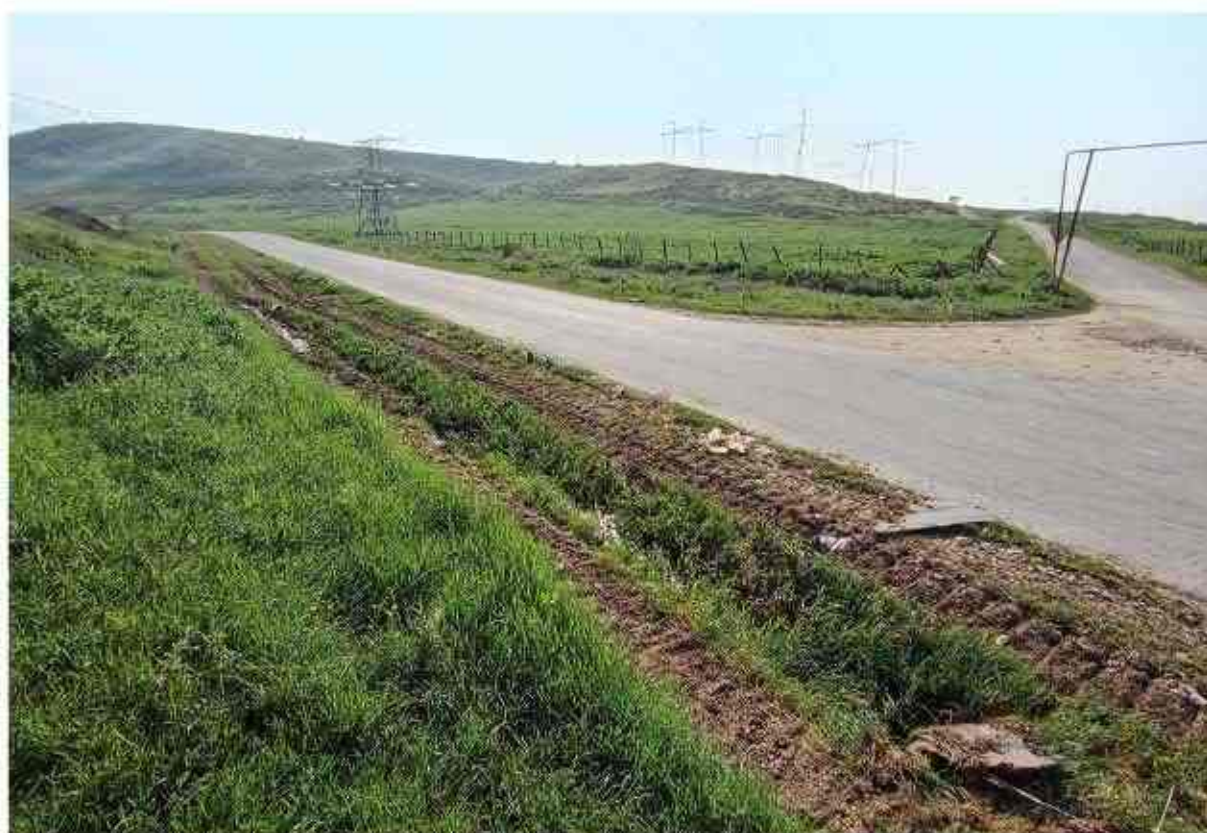
Рис. 8. ВОАН «Ансамбль памятников «Зидьян-Казмаляр». Общий вид с северо-востока, до начала работ.
