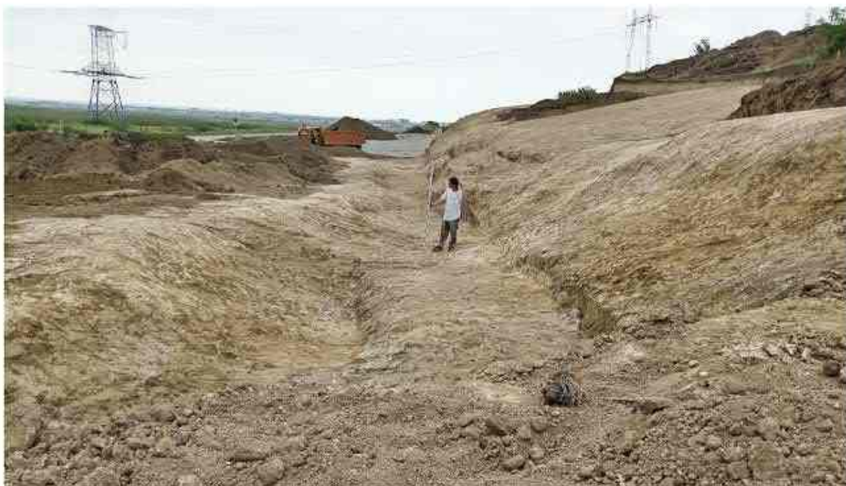
Рис. 47. ВОАН «Ансамбль памятников «Зидьян-казмаляр». Раскоп 1. Участок 1-13. Общий вид на ров после завершения работ. Вид с ЮЮЗ.
