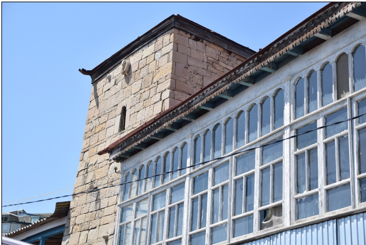
Фото 1. Общий вид здания, вид на главный фасад.
