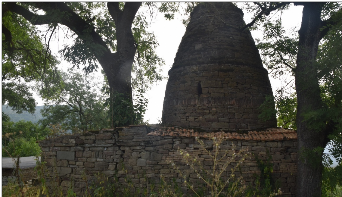
Фото 1. Общий вид мавзолея, вид с западной стороны.
