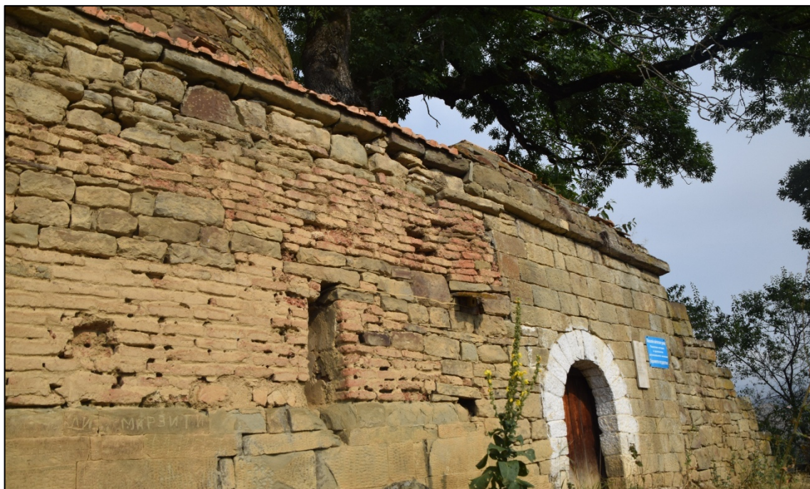
Фото 13. Общий вид мавзолея. Восточный фасад сооружения. Главный вход. (Фото предоставлены Агентством по охране объектов культурного наследия Республики Дагестан. Дата снимка 27.08.2025 г.)
