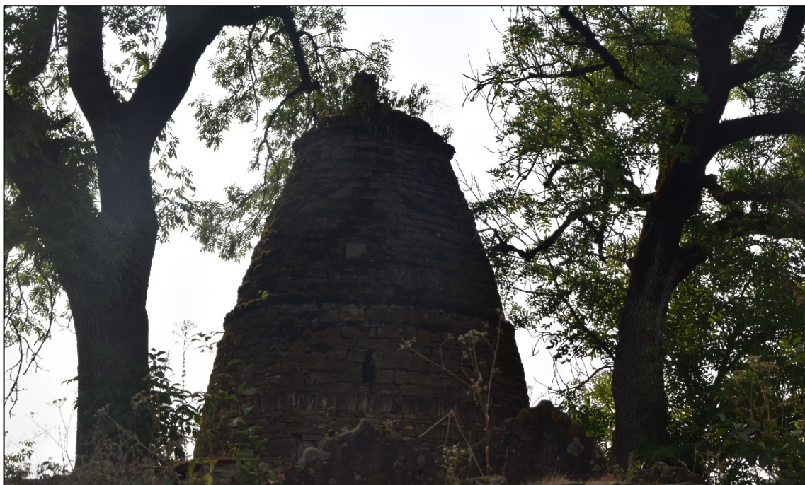
Фото 25. Общий вид на купол мавзолея. Северная сторона.
