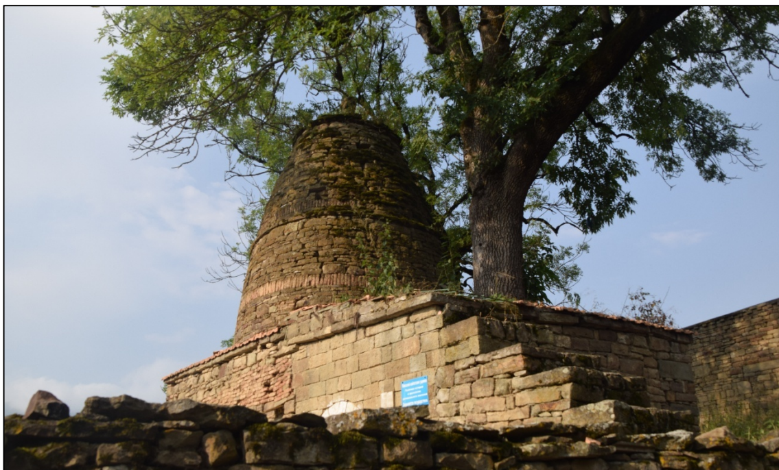
Фото 21. Общий вид мавзолея. Вид на сооружения с северо-востока. (Фото предоставлены Агентством по охране объектов культурного наследия Республики Дагестан. Дата снимка 27.08.2025 г.)
