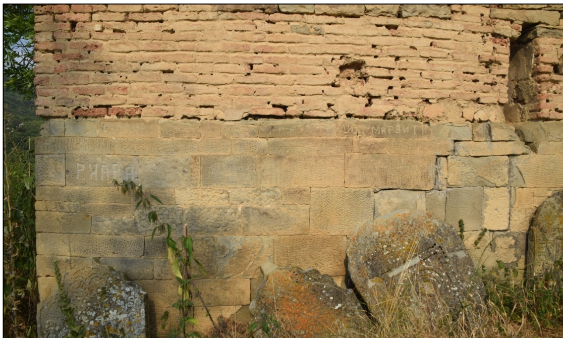
Фото 15. Общий вид мавзолея. Цокольная стена восточного фасада. (Фото предоставлены Агентством по охране объектов культурного наследия Республики Дагестан. Дата снимка 27.08.2025 г.)
