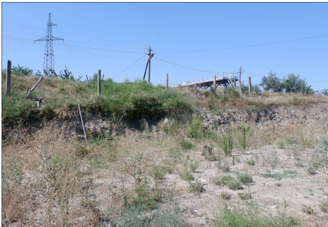
Илл. 43. Зачистка 1 до начала работ. Общий вид. Вид с юга.
