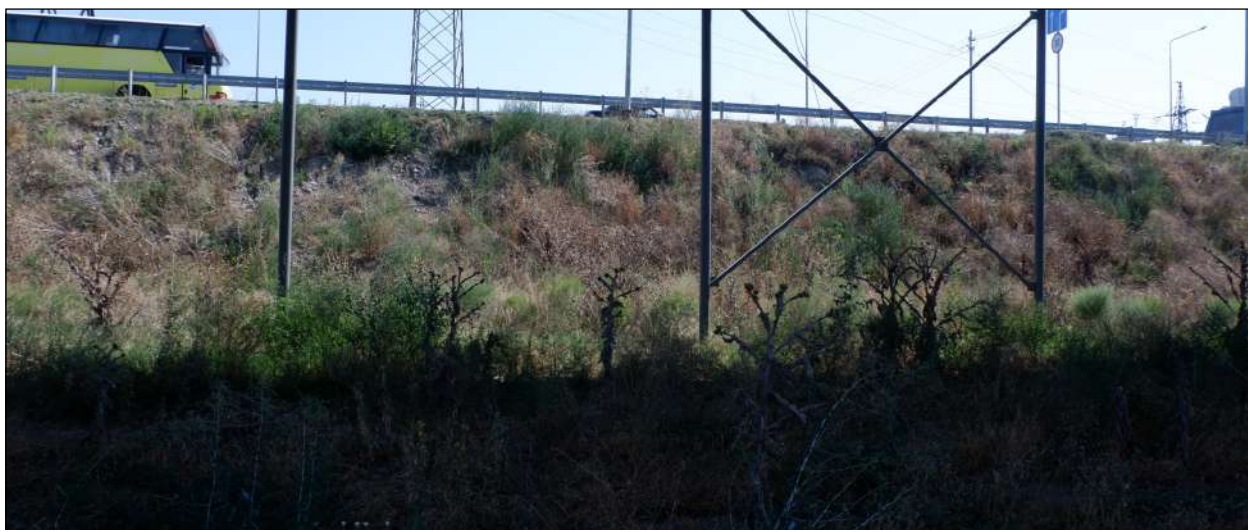
Илл. 12. Общий вид землеотвода. Точка фотофиксации 2. Вид с севера.
