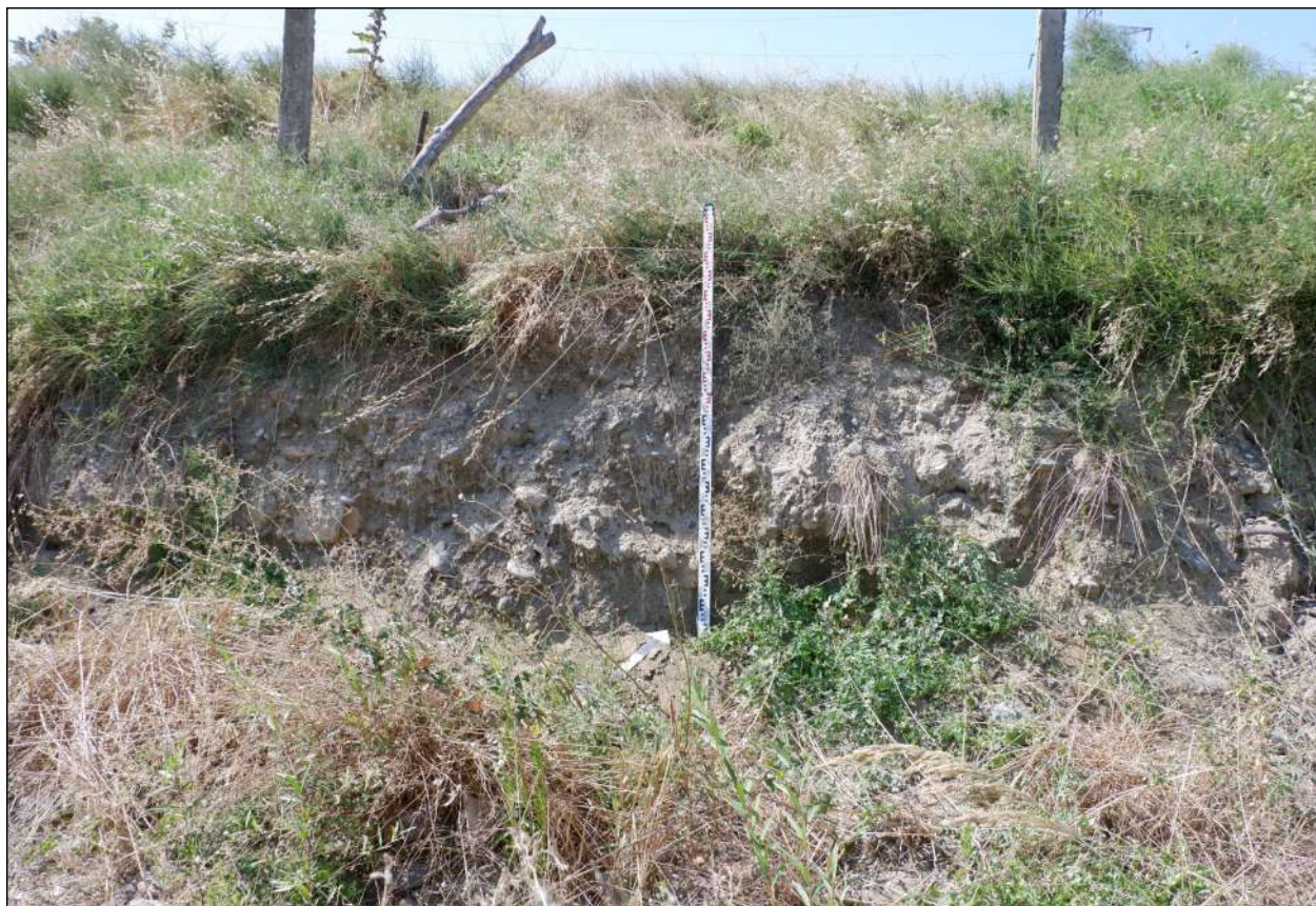
Илл. 42. Зачистка 1 до начала работ. Вид с юго-востока.
