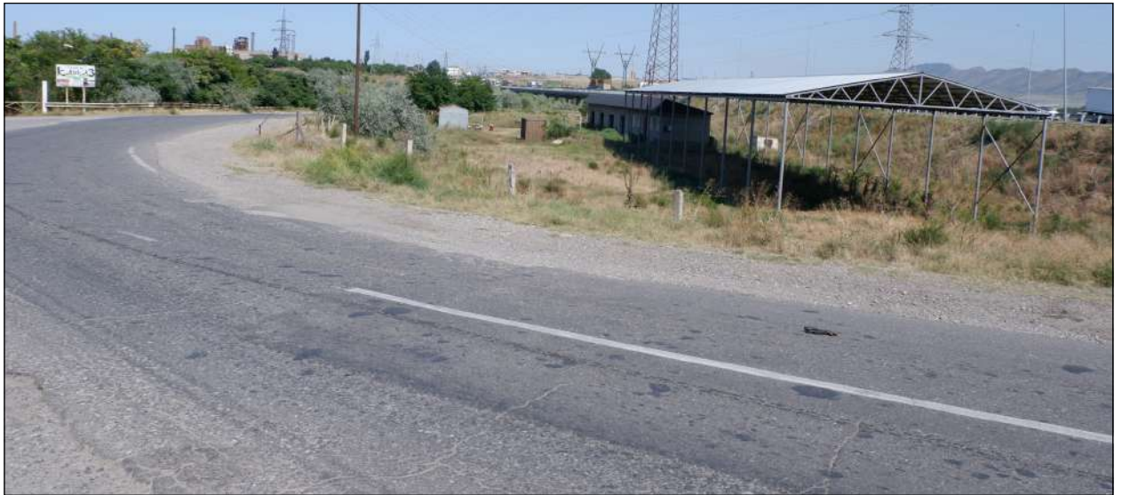
Илл. 8. Общий вид землеотвода. Точка фотофиксации 1. Вид с запада.
