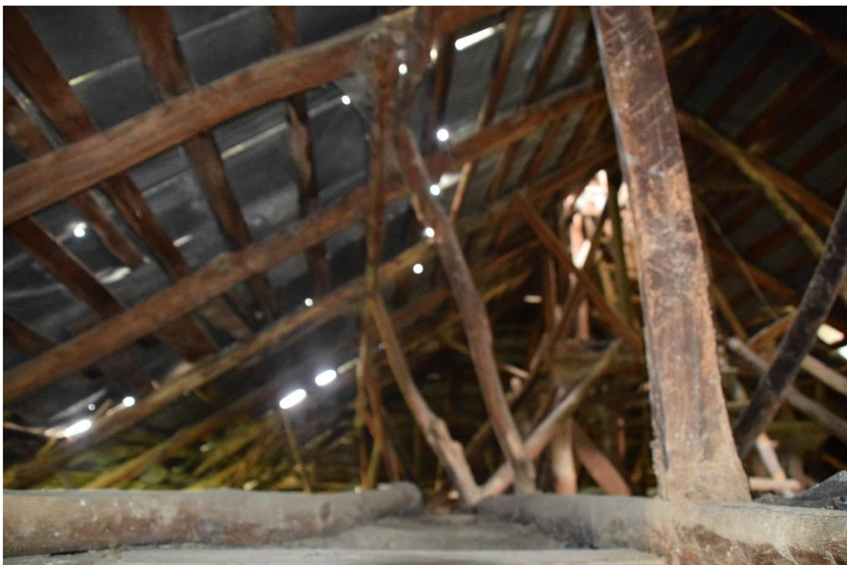
**Фото 24.** Стропильная система кровли мечети, видно, что минарет выстроен на деревянных балках
