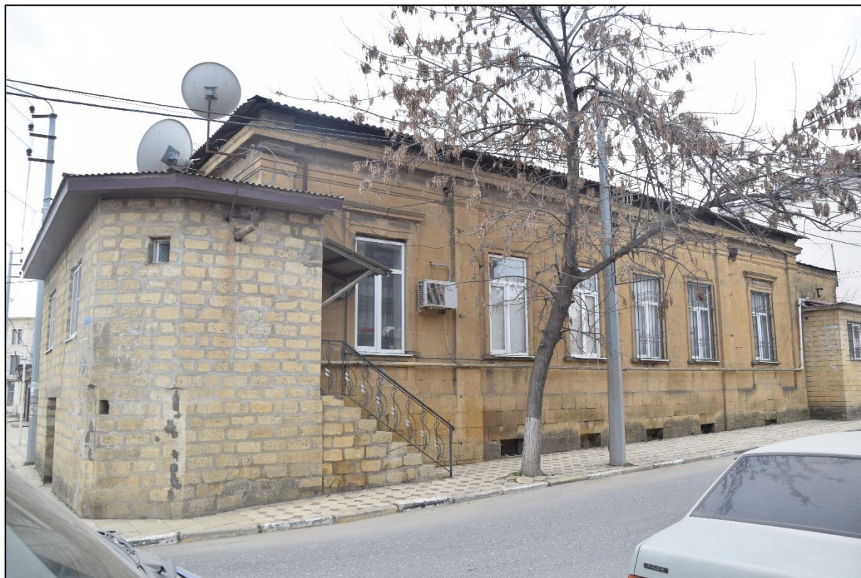
Фото 1. Общий вид здания с пересечения улиц Пашабекова и С. Стальского.
