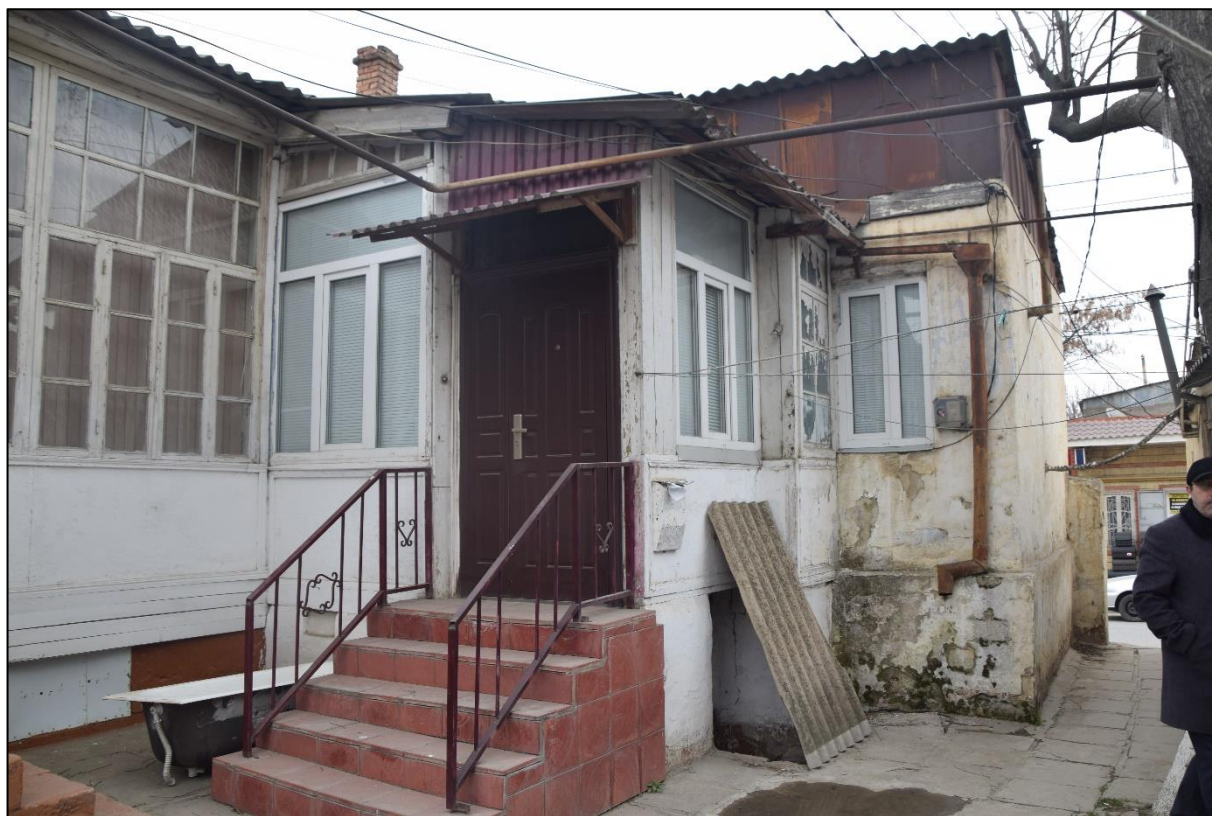
Фото 9. Поздние тамбурные пристройки к зданию со стороны двора.
