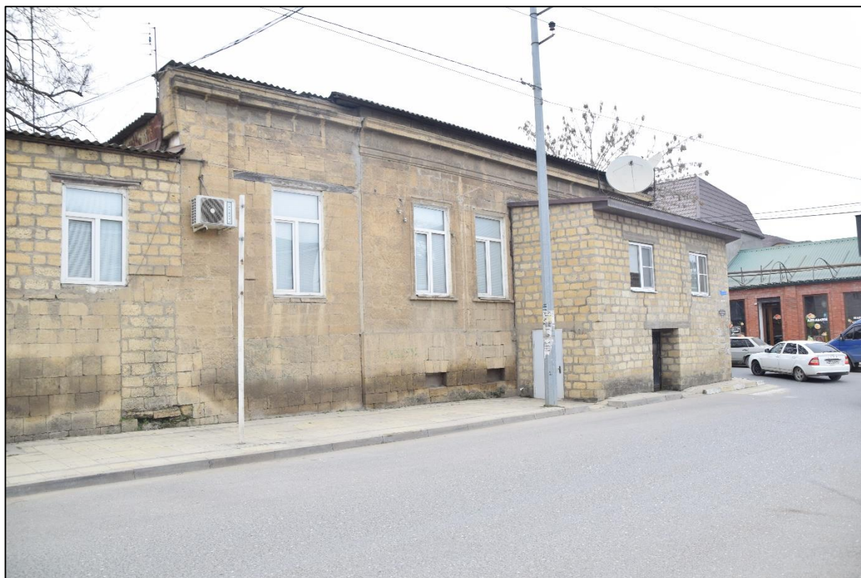
Фото 3. Боковой фасад здания по ул. С. Стальского, общий вид сохранившихся оконных проемов.
