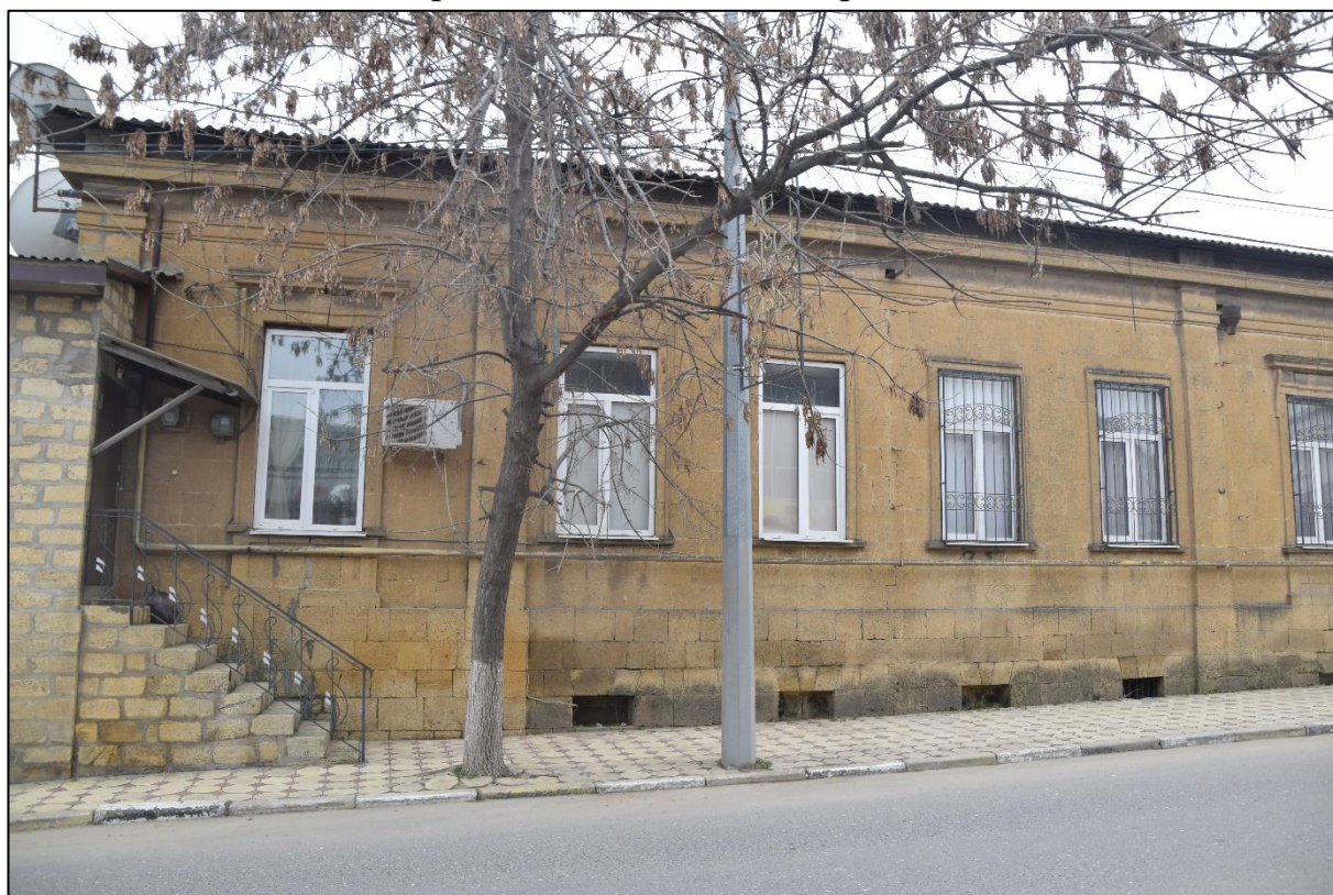
Фото 4. Главный фасад по улице Пашабекова, архитектурно-художественное оформление фасада и оконных проемов.
