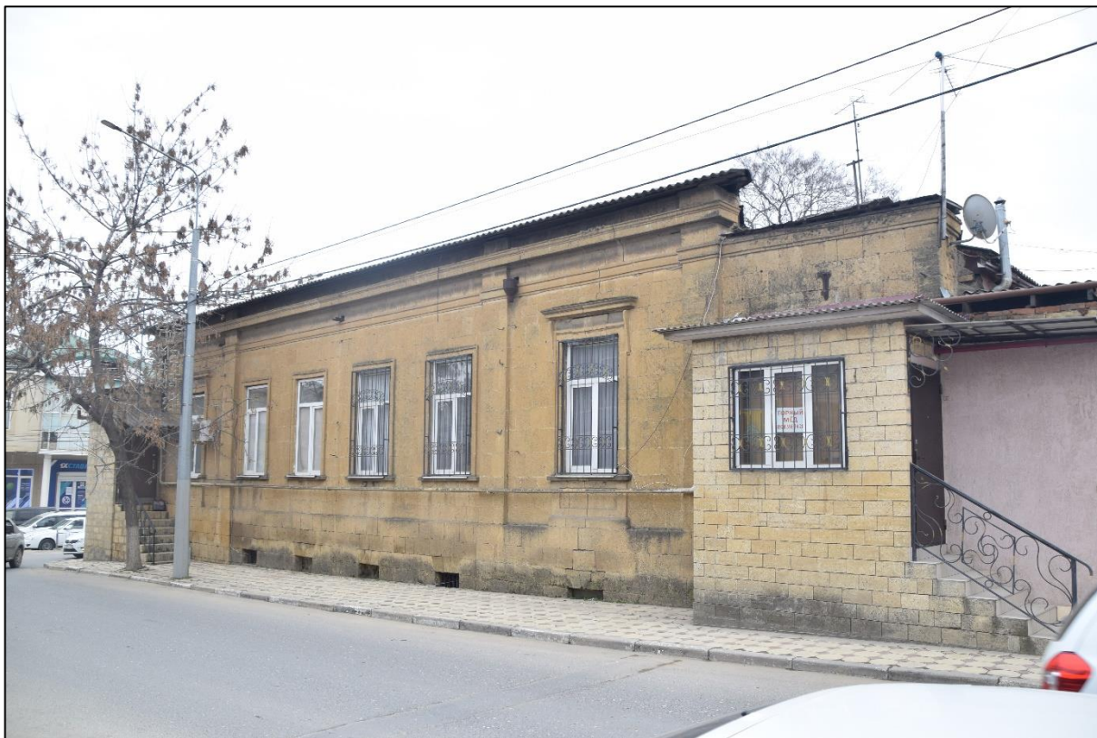
Фото 7. Общий вид на главный фасад с ул. Пашабекова, пристройка на месте главного входа в здание.
