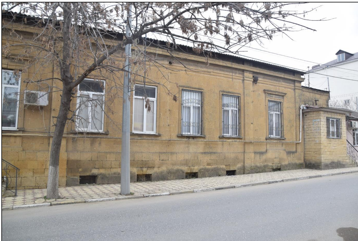
Фото 5. Фасад по улице Пашабекова, архитектурно-художественное оформление фасада и оконных проемов, парапет здания.
