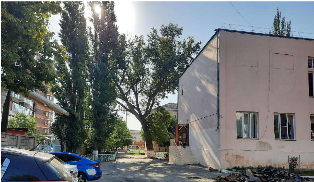
Т.ф. 9 Республика Дагестан, г. Махачкала, ул. 26 Ярагского, д. 78. «Здание средней школы №5, где размещался эвакуогоспиталь 4651». Общий вид северо-восточного фасада. Вид со стороны дворовой территории школы (с севера). Фото: Ильясов И.М., сентябрь 2021 г.
