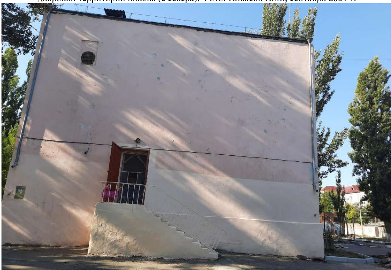
Т.ф. 10 Республика Дагестан, г. Махачкала, ул. 26 Ярагского, д. 78. «Здание средней школы №5, где размещался эвакуогоспиталь 4651». Фрагмент северо-восточного фасада. Фото: Ильясов И.М., сентябрь 2021 г.
