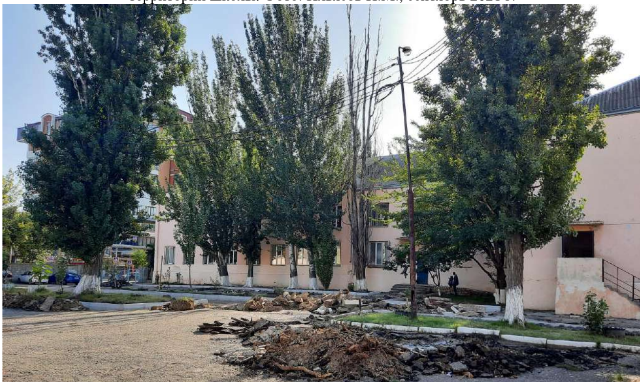
Т.ф. 8 Республика Дагестан, г. Махачкала, ул. 26 Ярагского, д. 78. «Здание средней школы №5, где размещался эвакуогоспиталь 4651». Общий вид северного фасада. Вид со стороны дворовой территории школы (с северо-запада). Фото: Ильясов И.М., сентябрь 2021 г.
