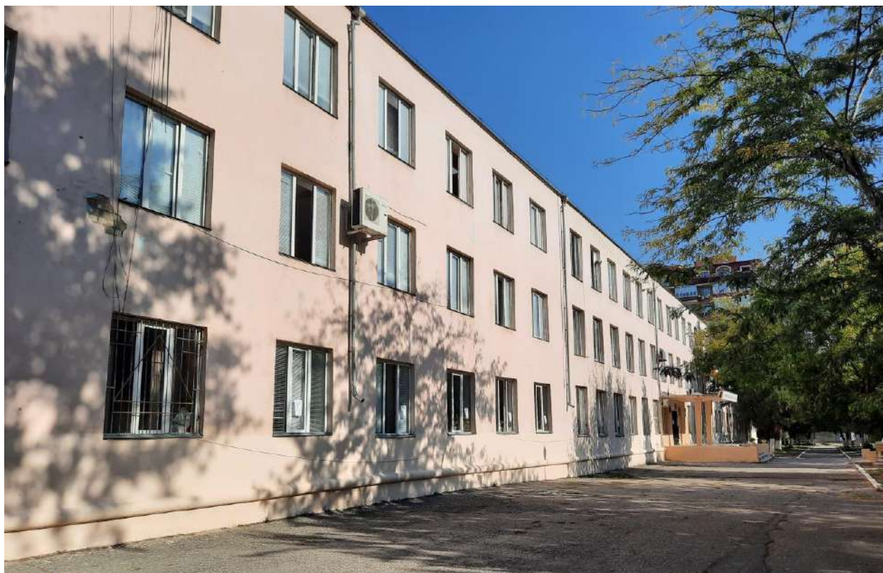
Т.ф. 2. Республика Дагестан, г. Махачкала, ул. 26 Ярагского, д. 78. «Здание средней школы №5, где размещался эвакуогоспиталь 4651». Общий вид юго-восточного фасада с улицы Ярагского. Фото: Ильясов И.М., сентябрь 2021 г.
