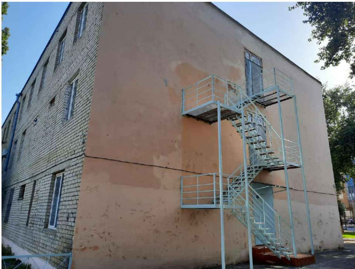
Т.ф. 3. Республика Дагестан, г. Махачкала, ул. 26 Ярагского, д. 78. «Здание средней школы №5, где размещался эвакуогоспиталь 4651». Фрагмент юго-западного фасада. Вид со стороны дворовой территории школы. Фото: Ильясов И.М., сентябрь 2021 г.
