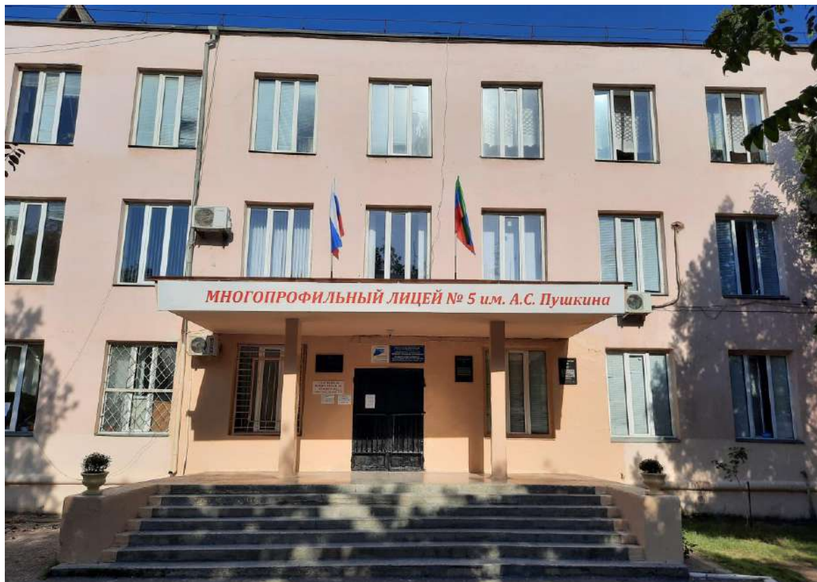
Т.ф. 1. Республика Дагестан, г. Махачкала, ул. 26 Ярагского, д. 78. «Здание средней школы №5, где размещался эвакуогоспиталь 4651». Юго-восточный фасад. Вид с территории школы. Фото: Ильясов И.М., сентябрь 2021 г.
