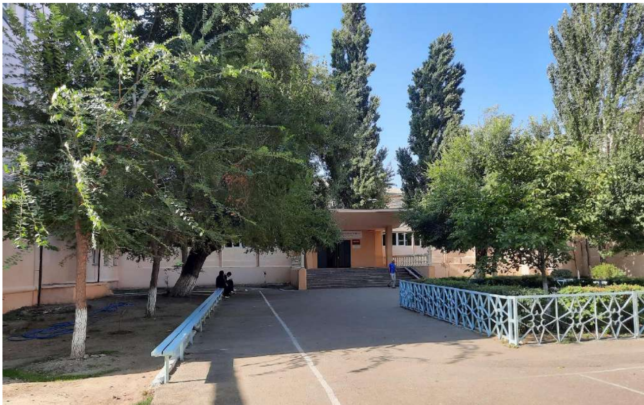
Т.ф. 11 Республика Дагестан, г. Махачкала, ул. 26 Ярагского, д. 78. «Здание средней школы №5, где размещался эвакуогоспиталь 4651». Фрагмент северо-восточного фасада. Вид с восточной стороны. Фото: Ильясов И.М., сентябрь 2021 г.
