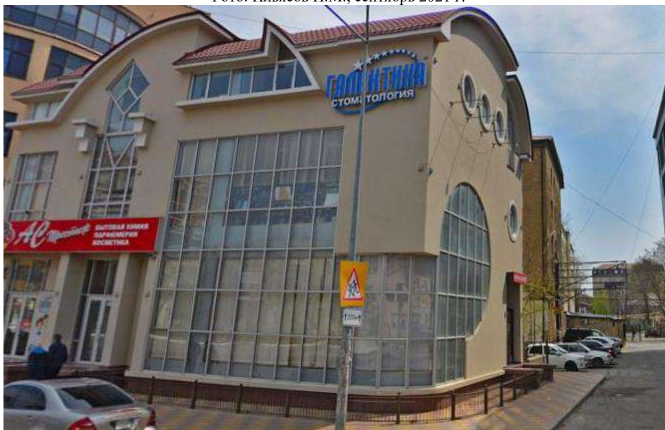
Т.ф. 22. Республика Дагестан, г. Махачкала, ул. Ярагского, 59Е. Общий вид в сторону дворовой территории. Фото: Ильясов И.М., сентябрь 2021 г.
