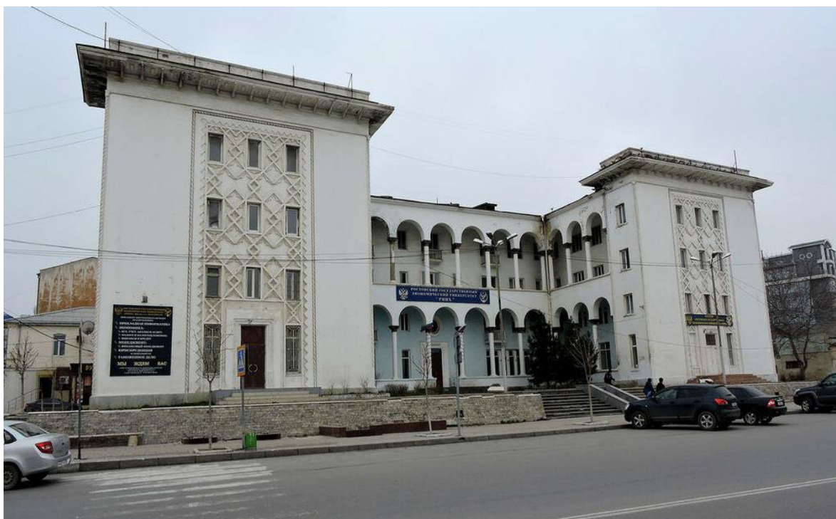
Фото 1. Общий вид Объекта.
