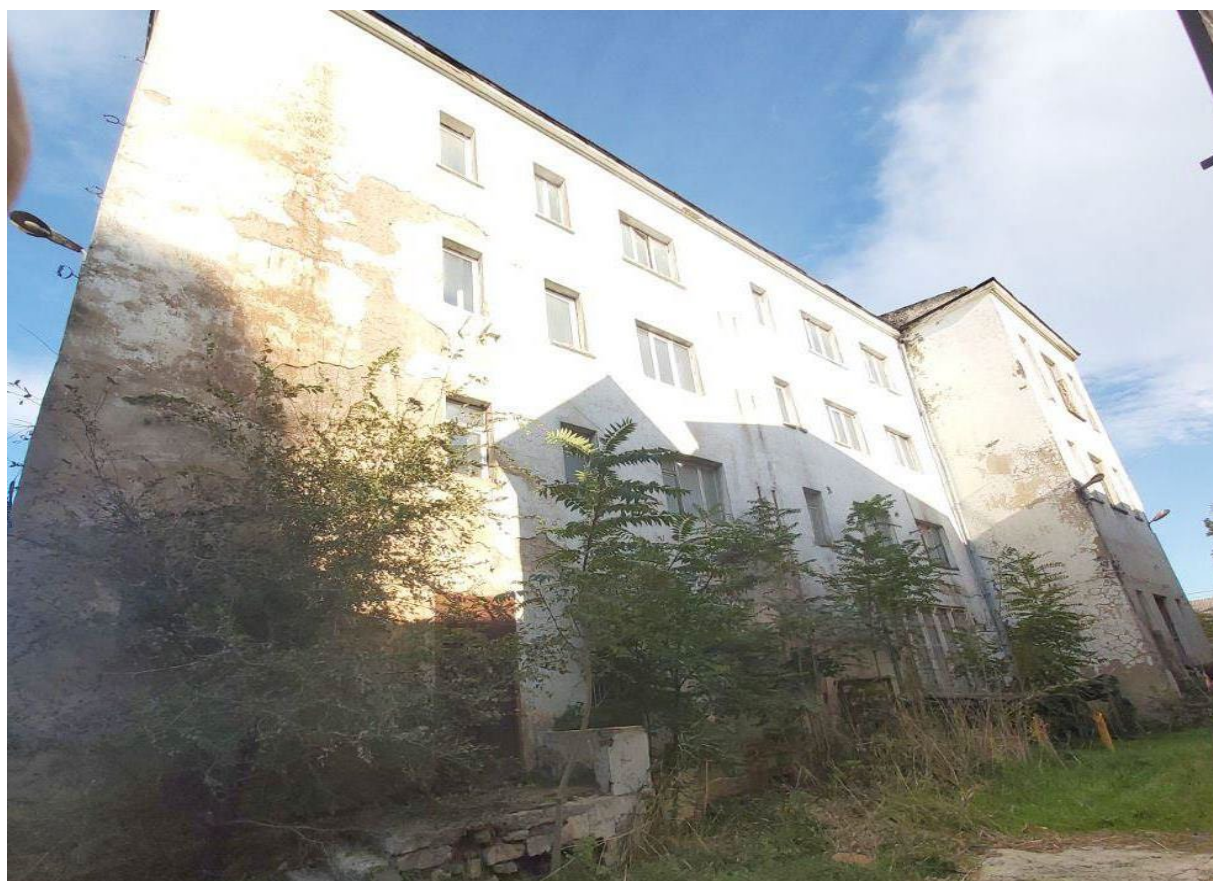
Фото 4. Фрагмент дворового фасада здания.
