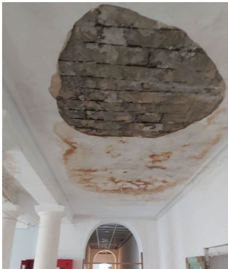
Фото 5. Интерьеры Объекта. Помещение на четвертом этаже.
