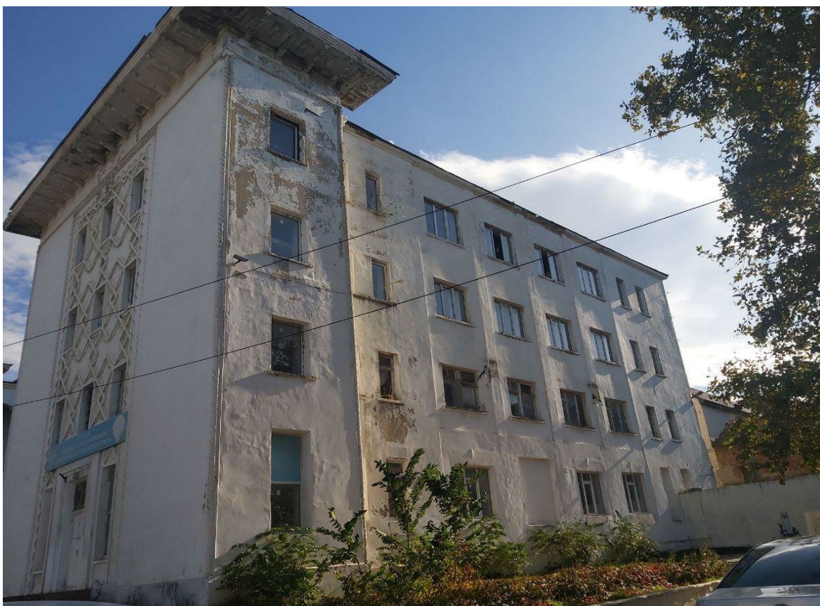
Фото 2. Общий вид Объекта со стороны северо-западного фасада.
