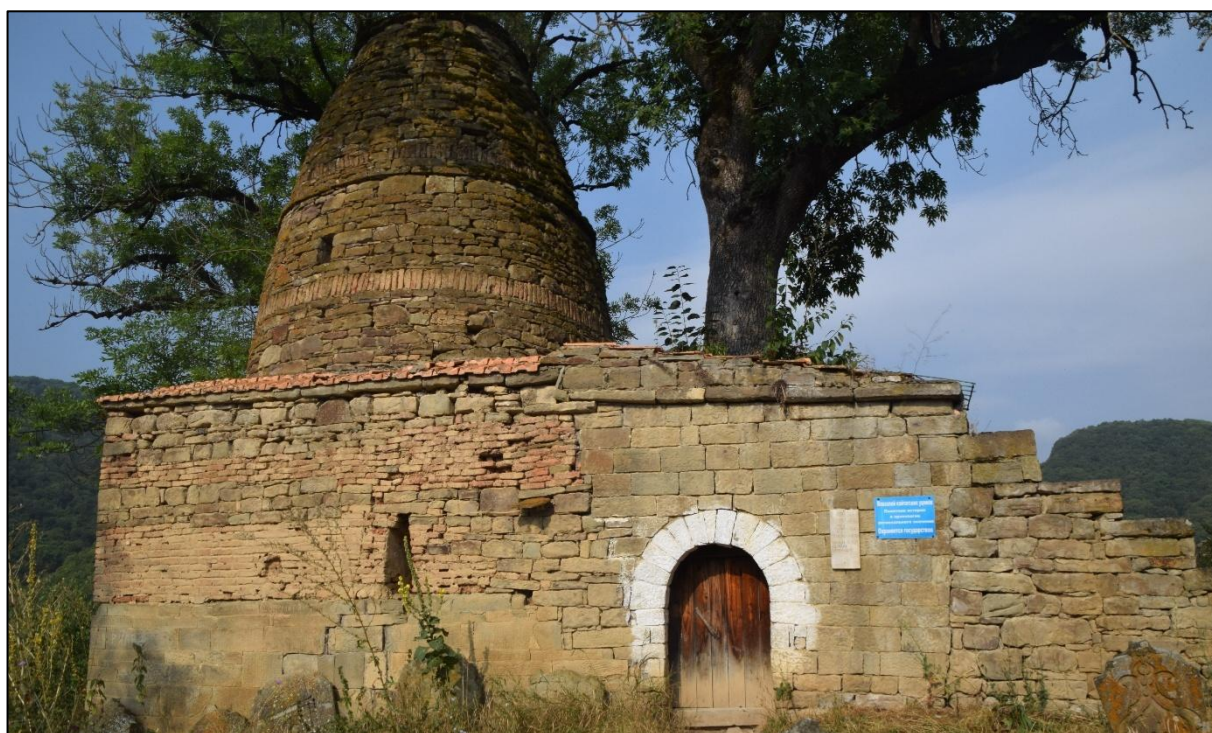
Фото 16. Общий вид мавзолея. Главный фасад. (Фото предоставлены Агентством по охране объектов культурного наследия Республики Дагестан. Дата снимка 27.08.2025 г.)
