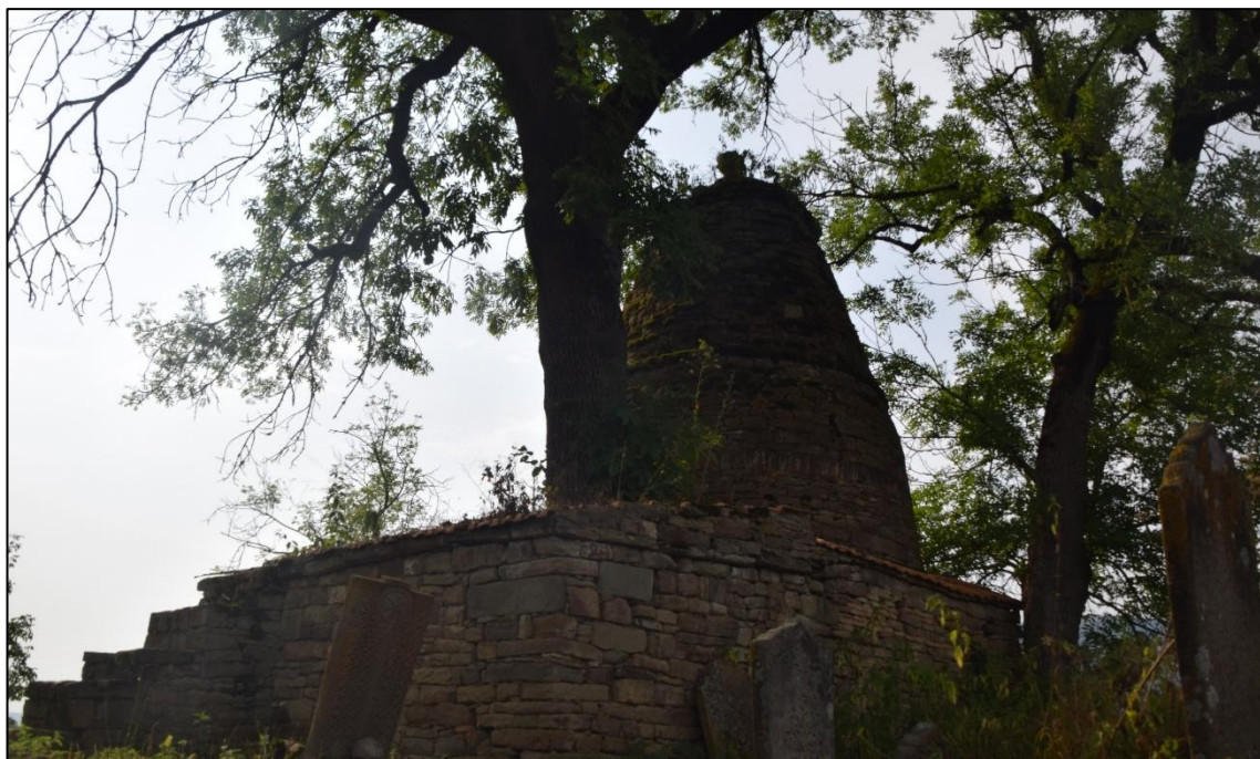
Фото 23. Общий вид мавзолея. Вид на купол с северо-запада. (Фото предоставлены Агентством по охране объектов культурного наследия Республики Дагестан. Дата снимка 27.08.2025 г.)
