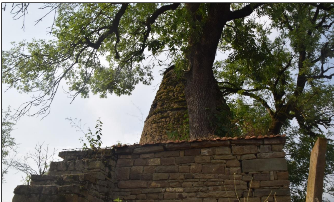
Фото 22. Общий вид мавзолея. Вид на купол с северной стороны. (Фото предоставлены Агентством по охране объектов культурного наследия Республики Дагестан. Дата снимка 27.08.2025 г.)
