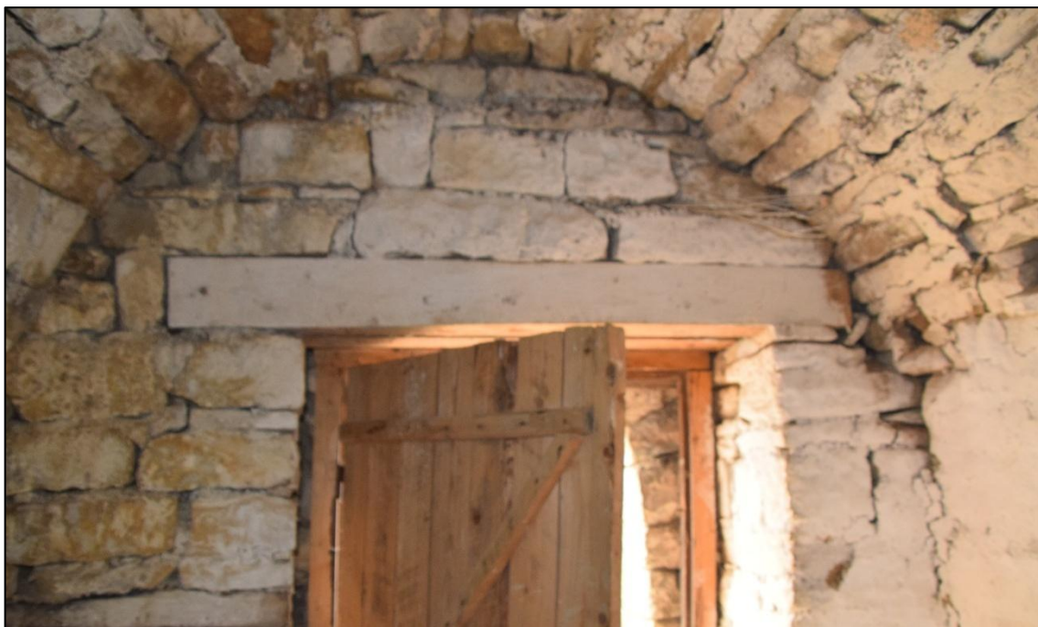
Фото 5. Интерьеры объекта. Помещение тамбура. Входная дверь. (Фото предоставлены Агентством по охране объектов культурного наследия Республики Дагестан. Дата снимка 27.08.2025 г.)
