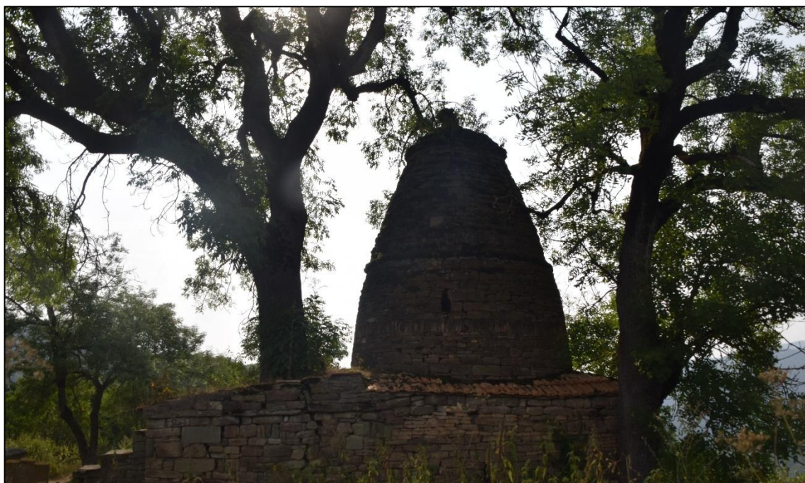
Фото 24. Общий вид мавзолея. Вид на объект с северо-запада. (Фото предоставлены Агентством по охране объектов культурного наследия Республики Дагестан. Дата снимка 27.08.2025 г.)
