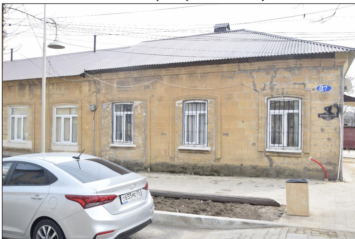
Фото 4. Фасад по улице Канделаки, архитектурно-художественное оформление фасада и оконных проемов, третий проем от угла – историческая заложенная дверь (главный вход).
