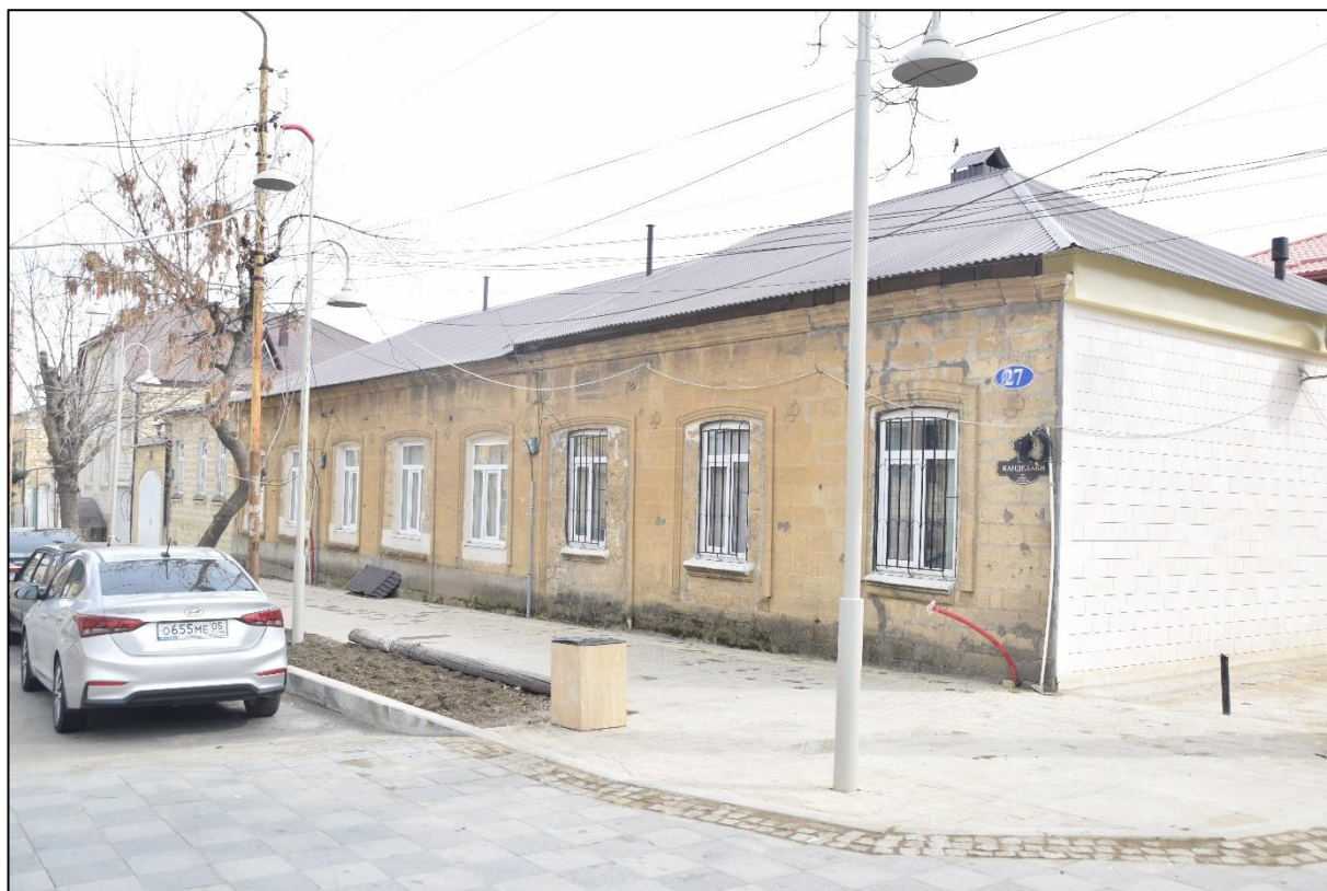
Фото 3. Общий вид на северный фасад здания по ул. Канделаки.
