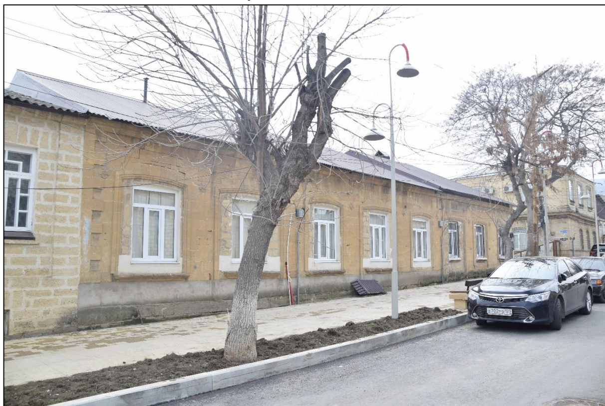
Фото 10. Общий вид северного фасада здания по ул. Канделаки.
