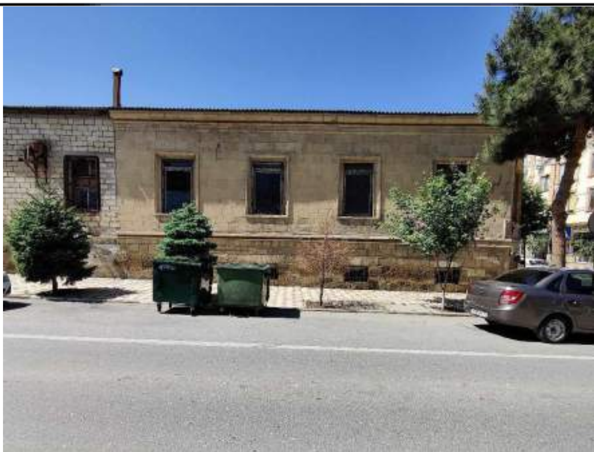
Точка фотофиксации № 8.5 Вид с ул. Пашабекова, тафінкцiрованное наличие визуальное восприятие анализируемого объекта
