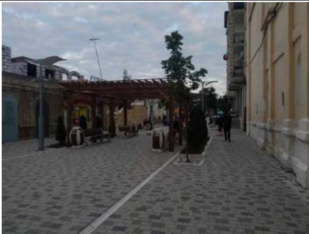
Точка фотофиксации №15 Фрагментарная видимость объекта с переулка Мирзы Казем-Бека с объектами благоустройства, находящимися в зоне визуального восприятия ОКН
