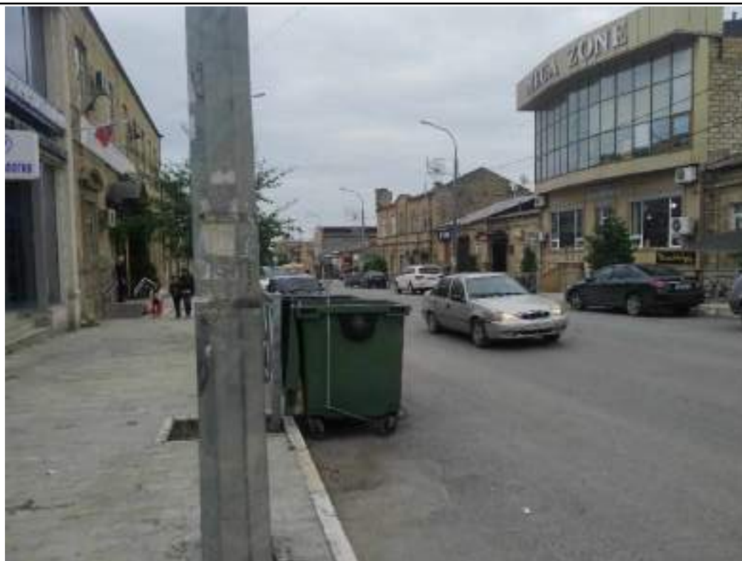
Точка фотофиксации № 7.2 Вид объекта в перспективе ул. Курбанова с дальних точек визуального восприятия
