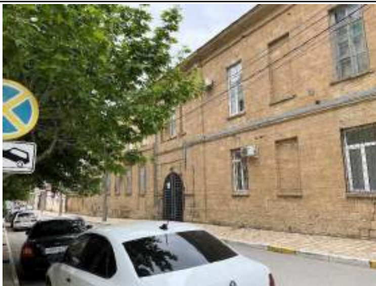
Точка фотофиксации 4.9 Вид объекта с ул. Пашабекова
