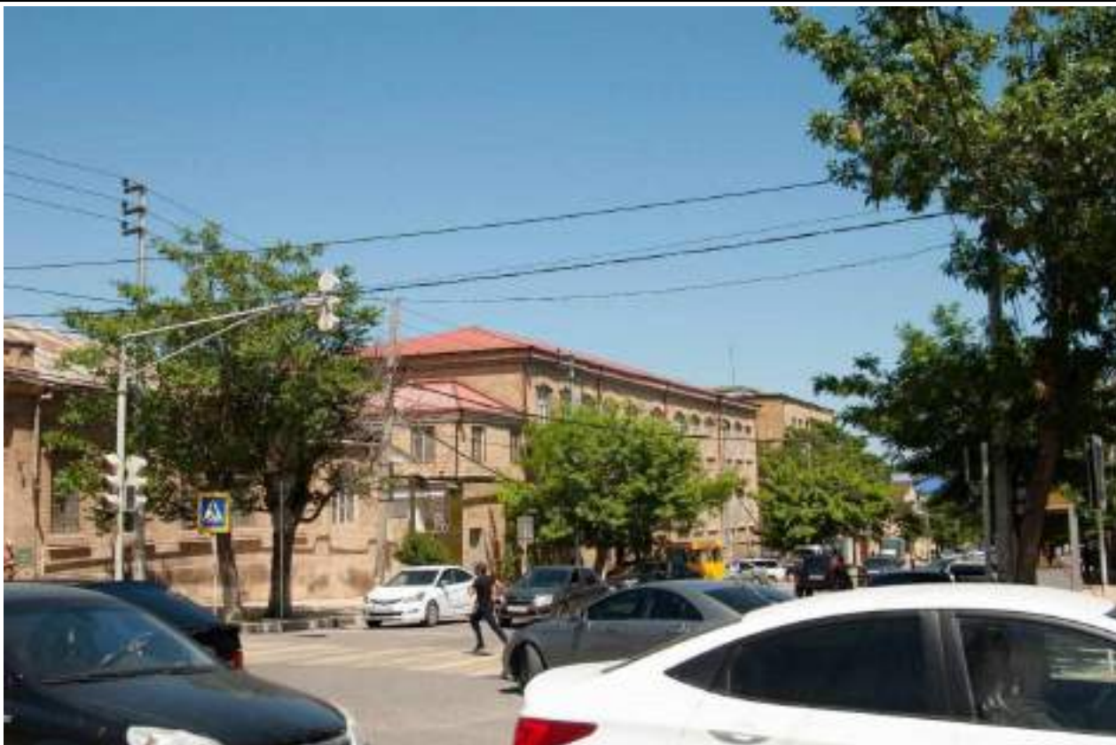
Точка фотофиксации 1.14 Вид объекта на пересечении ул. Сальмана и ул. Пушкина
