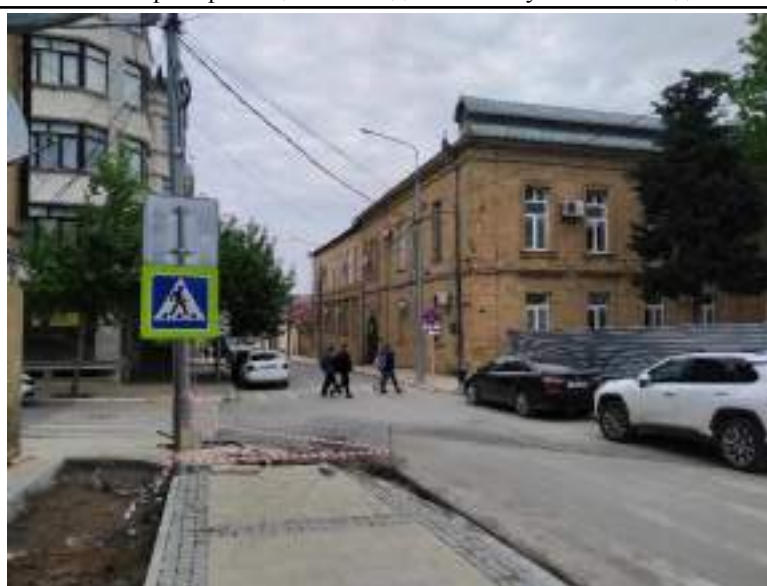
Точка фотофиксации 4.6 Вид объекта с ул. пл. Свободы
