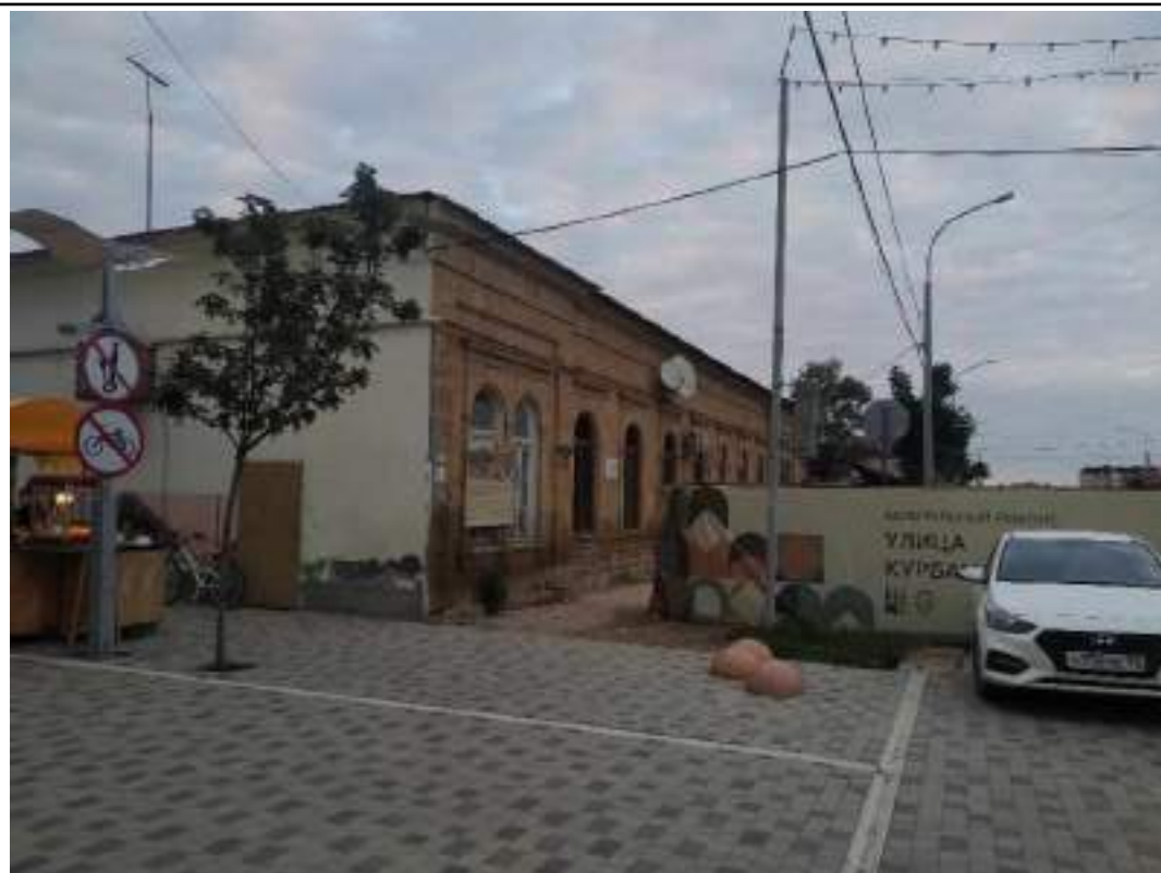
Точка фотофиксации №17 Вид объекта на пересечении ул. Мирзы Казем-Бека и ул. Курбанова
