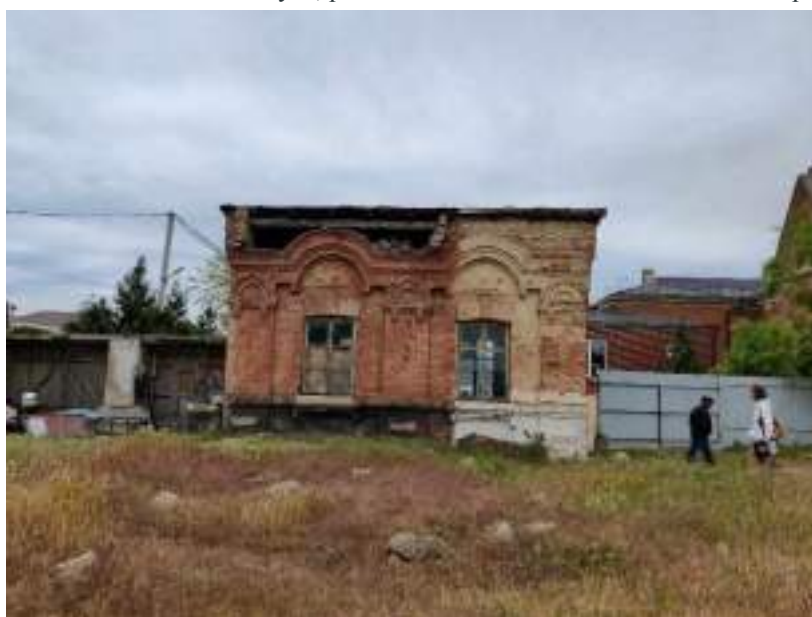
Точка фотофиксации №2.2 Вид объекта
