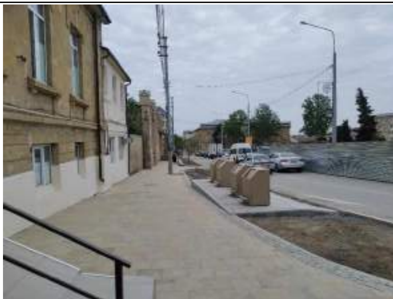
Точка фотофиксации 4.3 Вид объекта с ул. пл. Свободы
