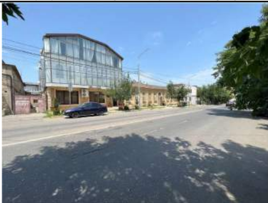
Точка фотофиксации №18 Визуальное восприятие объекта в перспективе ул. Пушкина
