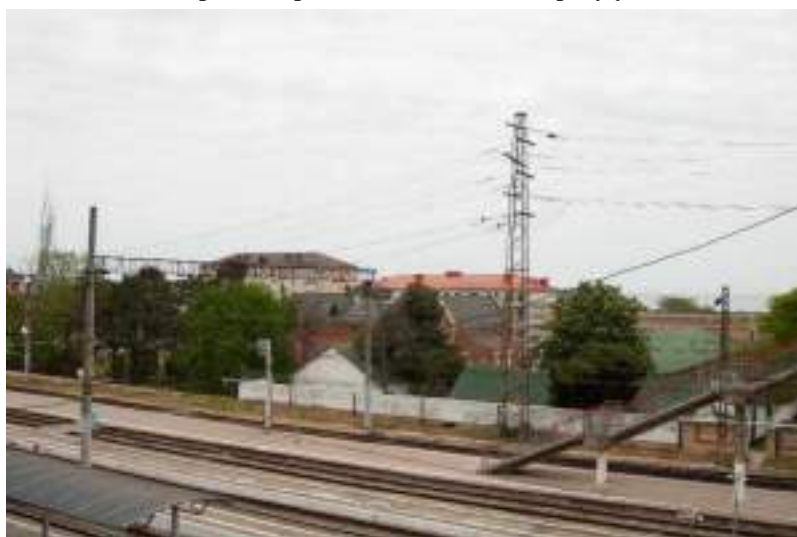
Точка фотофиксации №2.1 Вид с виадука, расположенного возле здания железнодорожного вокзала
