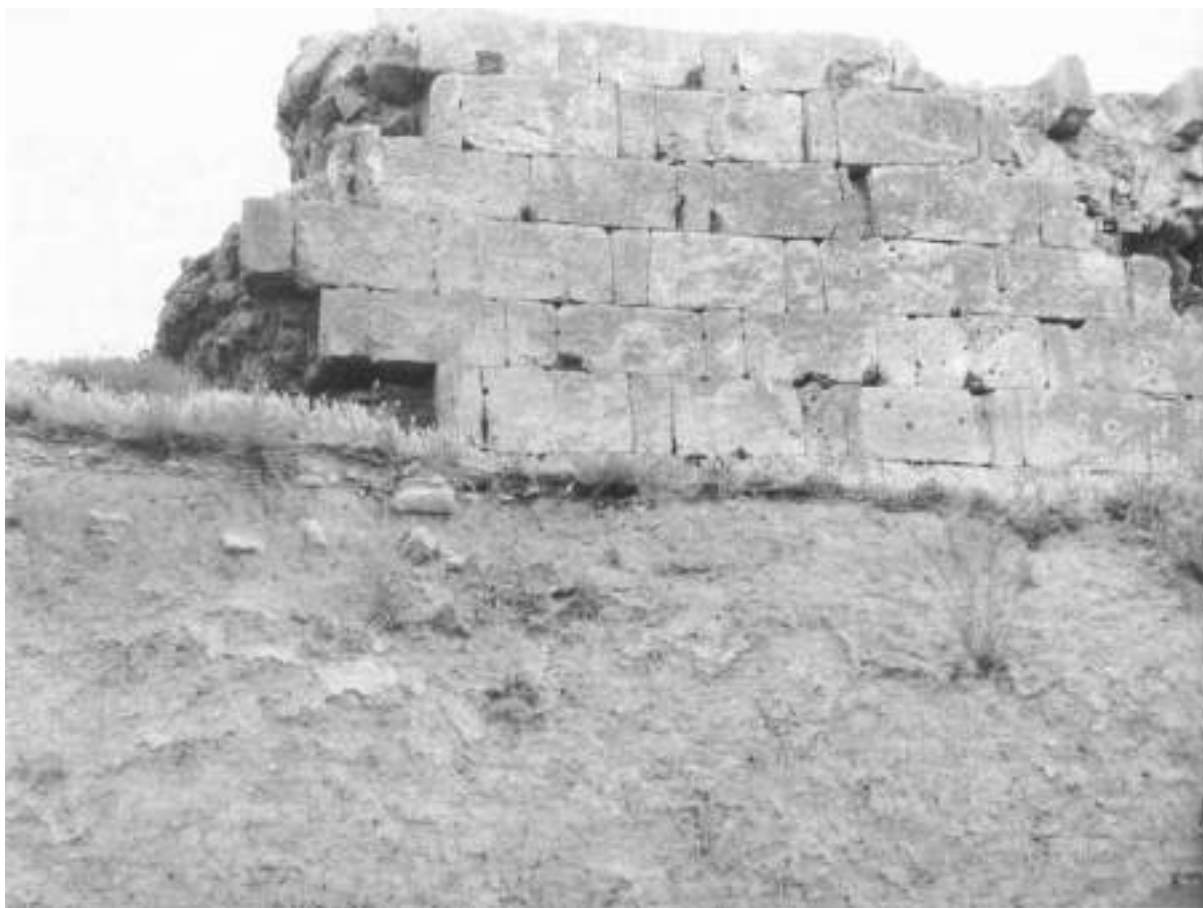
Илл. 4. Сырцовая стена примыкающая с юга к северной городской стене, вблизи башни 41. Фото 1957 г.
