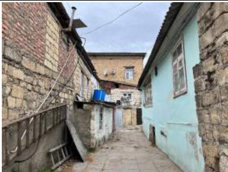
Точка фотофиксации 4.17 Вид объекта с ул Курбанова
