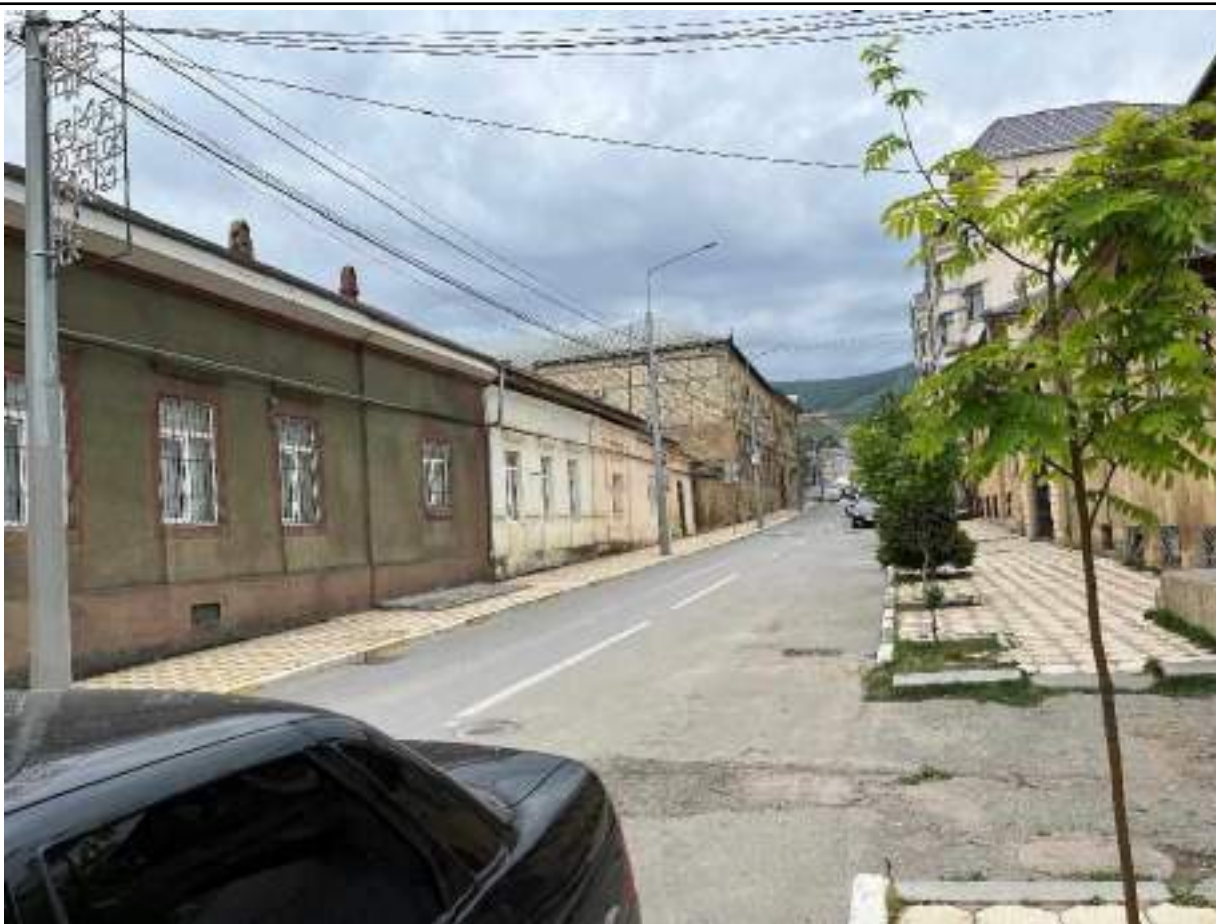
Точка фотофиксации 4.12 Вид объекта в перспективе ул. Пашабекова
