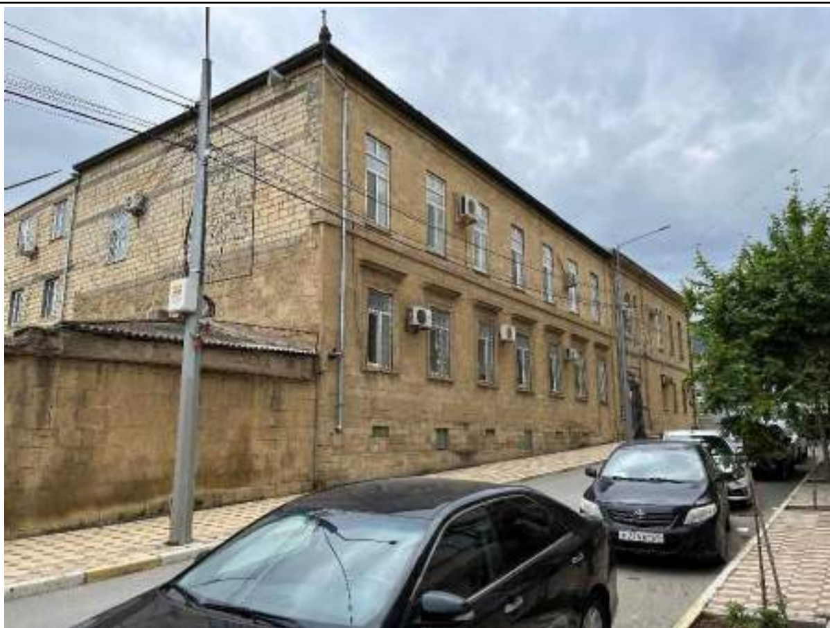
Точка фотофиксации 4.11 Вид объекта с ул. Пашабекова
