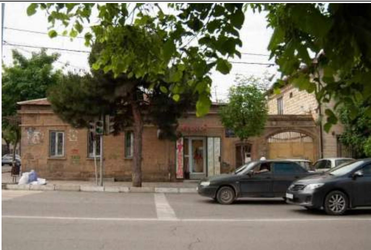
Точка фотофиксации № 1 Вид объекта с ул. Пушкина
