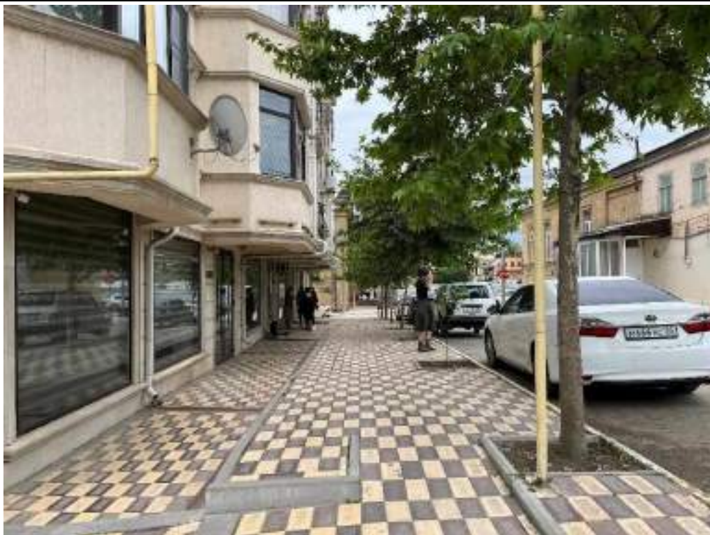
Точка фотофиксации 4.22 Вид объекта с проезда, примыкающего к ул. Пашабекова
