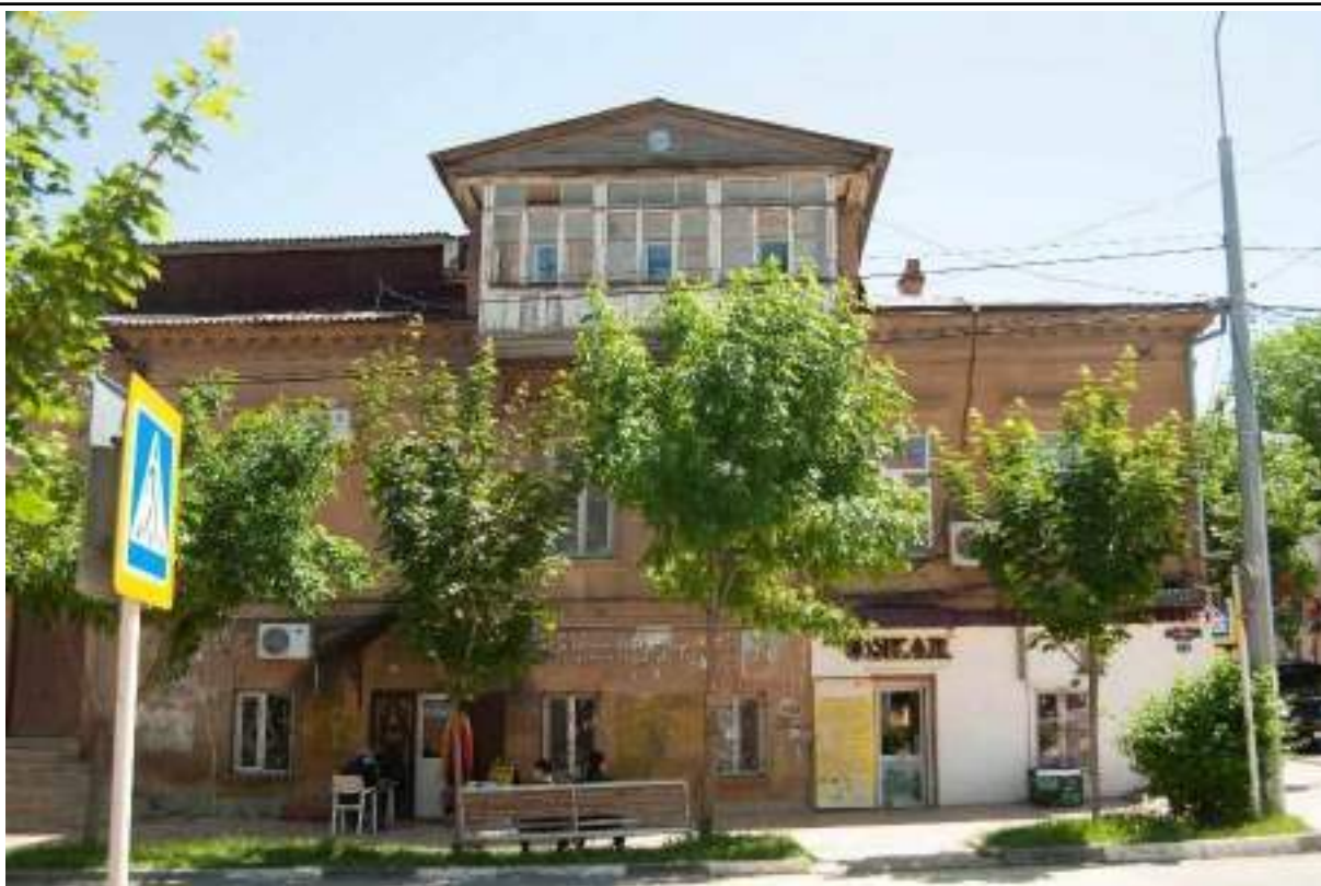
Точка фотофиксации № 1.5 Вид с ул. Ленина, зафиксированное наилучшее визуальное восприятие анализируемого объекта
