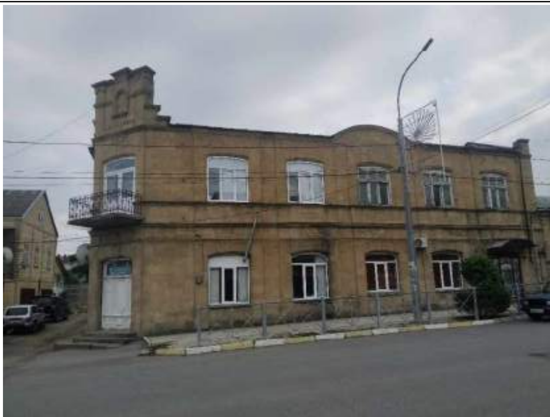
Точка фотофиксации № 7.4 Вид объекта с ул. Курбанова
