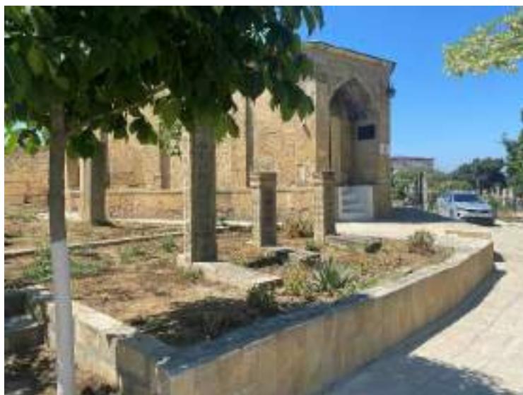
Точка фотофиксации №18 Вид на Мавзолей Дербентских ханов с наилучшей точки зрительного восприятия с близкого расстояния
