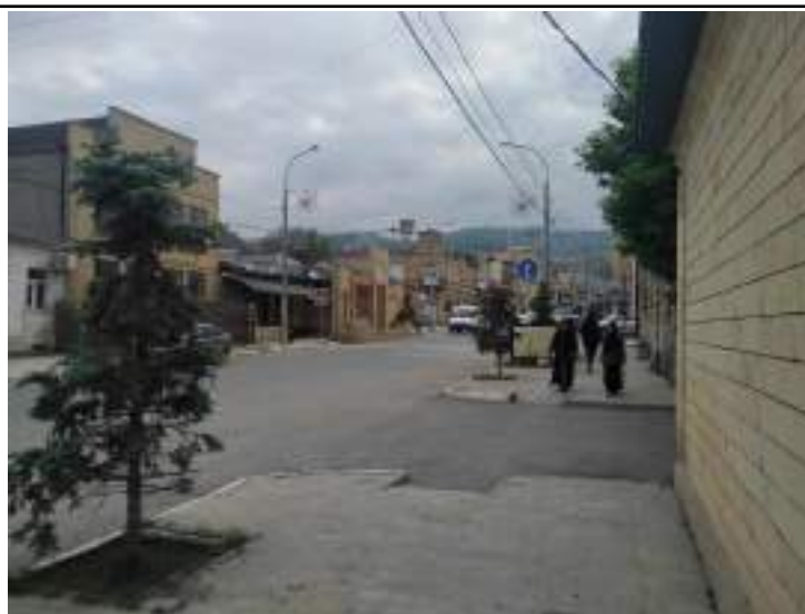
Точка фотофиксации № 7.10 Вид объекта с ул. Курбанова
