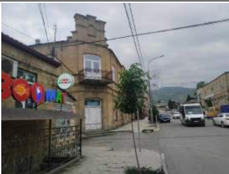
Точка фотофиксации № 7.6 Вид объекта с ул. Курбанова
