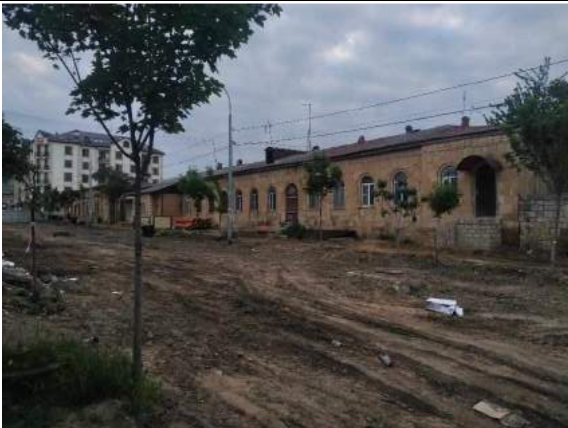
Точка фотофиксации №8 Вид восточного корпуса объекта с ул. Курбанова
