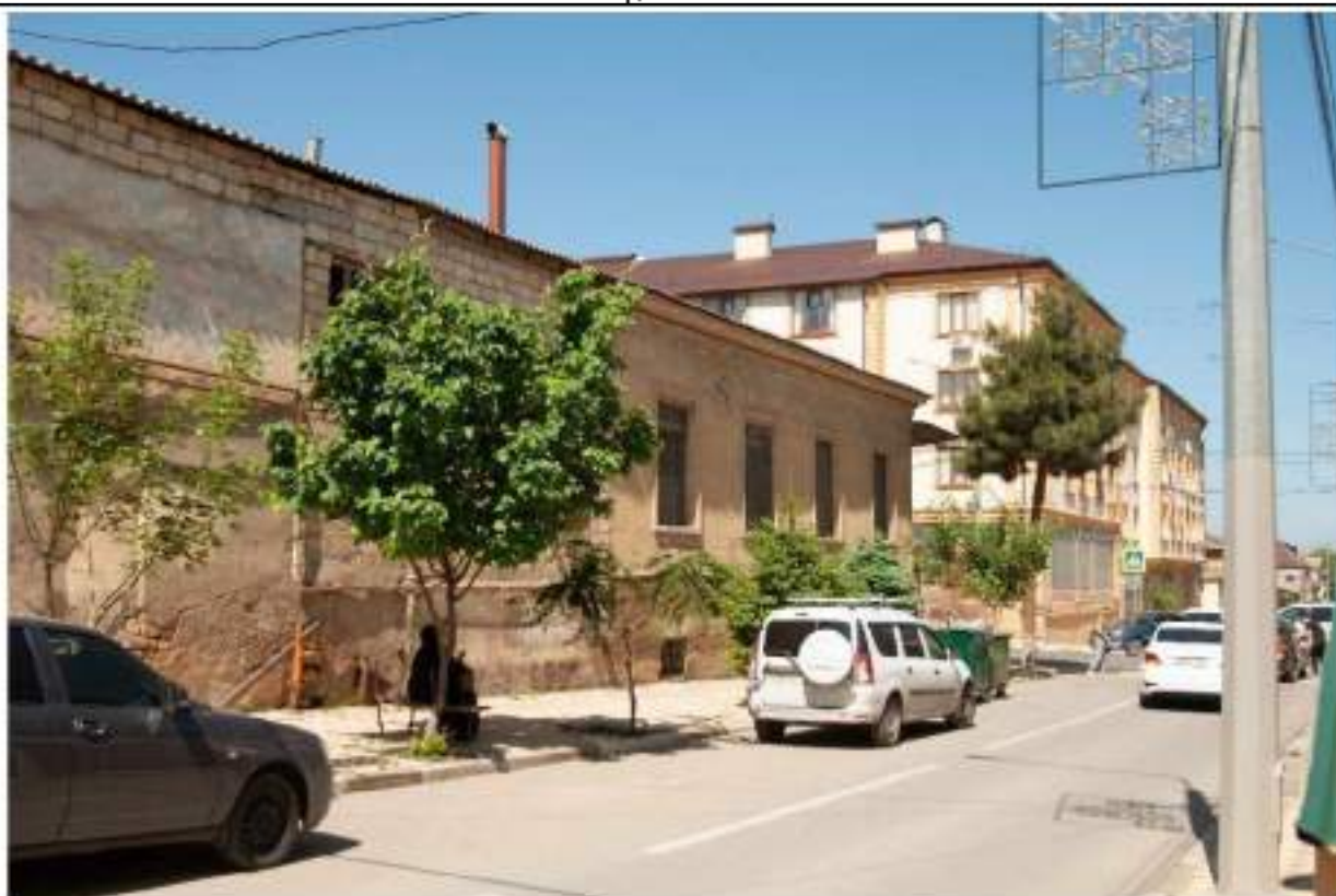
Точка фотофиксации № 8.6 Вид объекта с ул. Пашабекова
