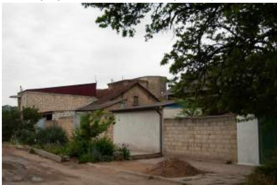
Точка фотофиксации №15 Вид объектов в перспективе ул. Вокзальной
