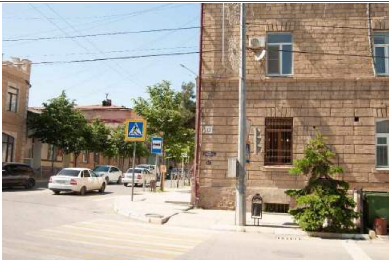
Точка фотофиксации № 8.11 Вид объекта на пересечении ул. Гагарина и ул. Курбанова
