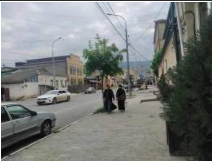
Точка фотофиксации № 7.11 Вид объекта с ул. Курбанова
