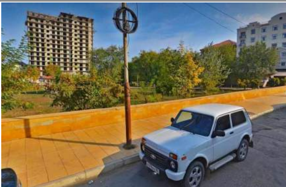
Точка фотофиксации №14 Вид объекта с ул. переулок Карла Маркса через парк Революционной славы, возможна сезонная видимость объекта, в связи с расположением объектов озеленения в зоне визуального восприятия объекта (по состоянию на 2018 г.)
