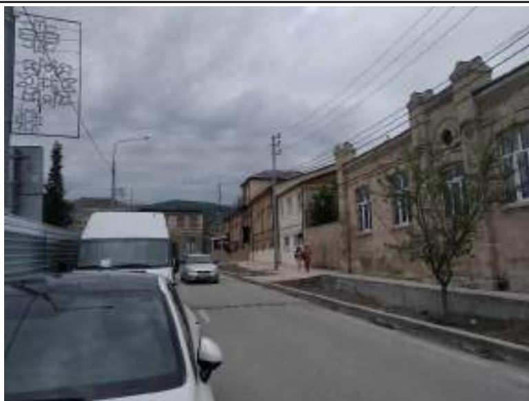
Точка фотофиксации 2.3 Визуальное восприятие объекта с ул. пл. Свободы
