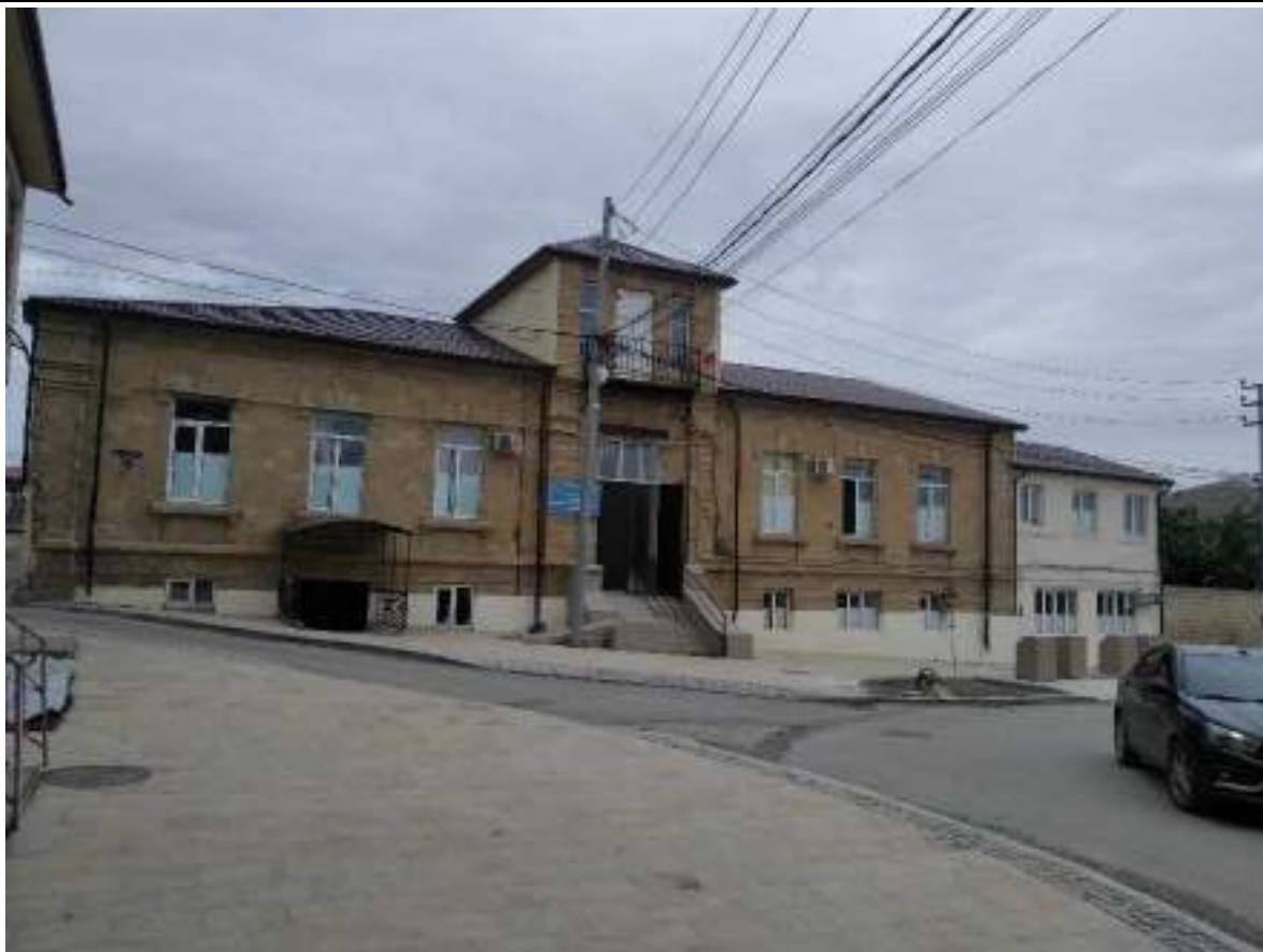
Точка фотофиксации 3.4 Вид объекта с ул. пл. Свободы
