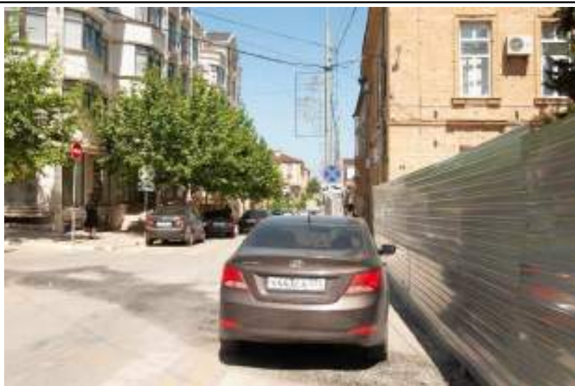
Точка фотофиксации № 8.8 Вид с ул. Пашабекова
