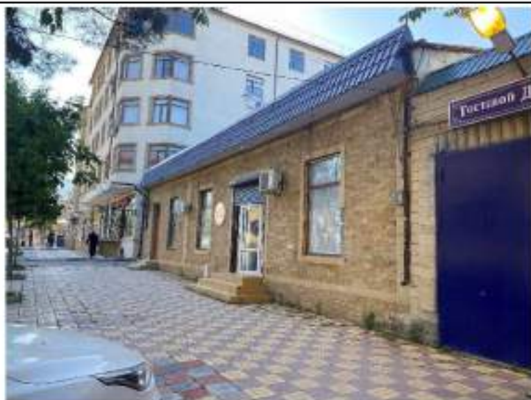
Точка фотофиксации № 8 Видовое раскрытие на объект с близкими точкам зрительного восприятия, в поле визуального восприятия объекта располагается диссимирующий объект капитального строительства
