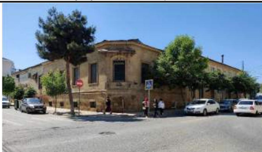
Точка фотофиксации № 8.4 Вид объекта на пересечении ул. Пашбекова и ул. Гагарина
