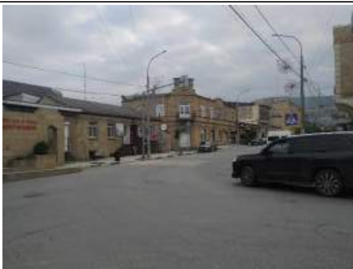
Точка фотофиксации № 7.8 Вид объекта на пересечении ул. Гагарина и ул. Курбанова
