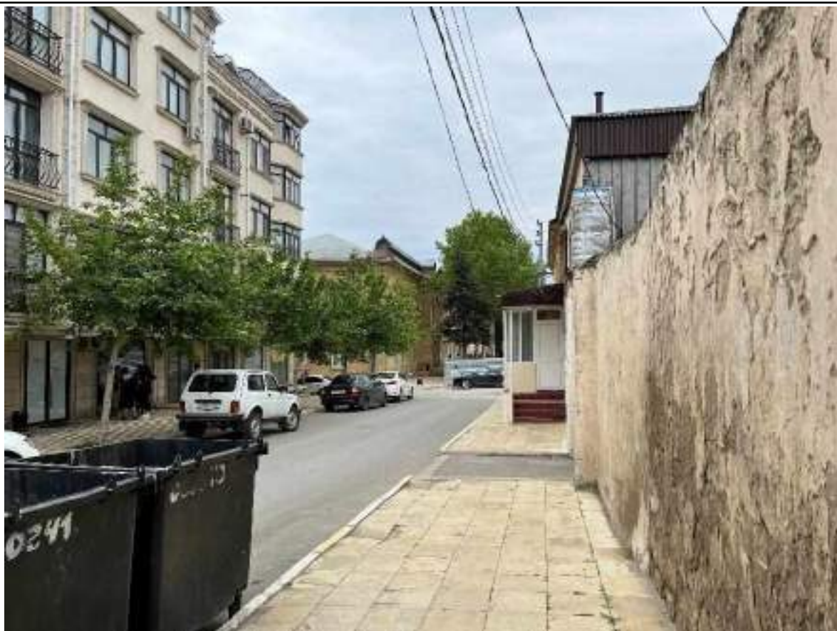
Точка фотофиксации 4.21 Вид объекта с проезда, примыкающего к ул. Пашабекова
