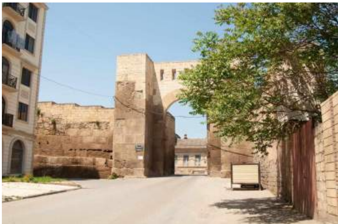
Точка фотофиксации №8 Вид объекта с проезда, соединяющего ул. Ленина и ул. Пугина
