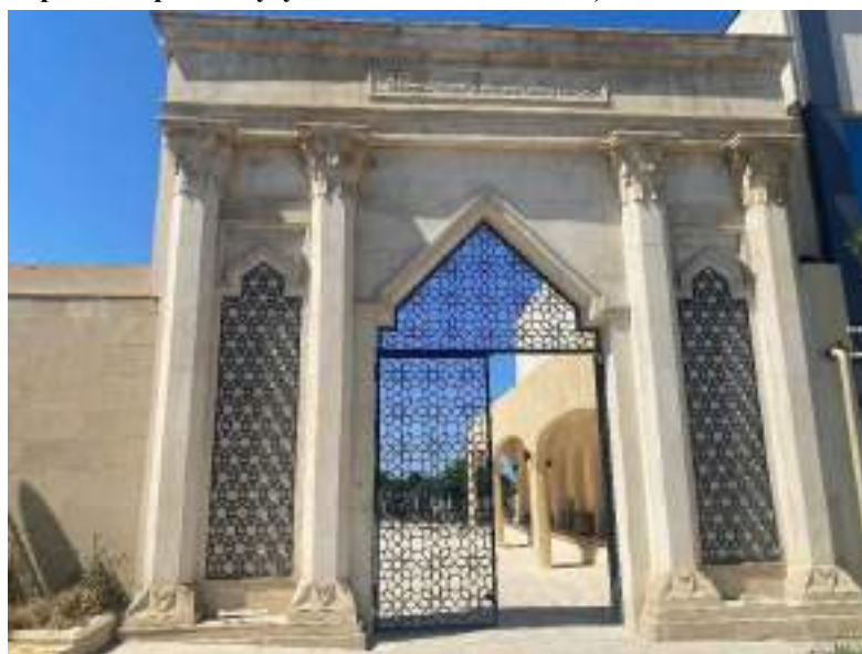
Точка фотофиксации №1 Вид на кладбище со стороны входной группы
