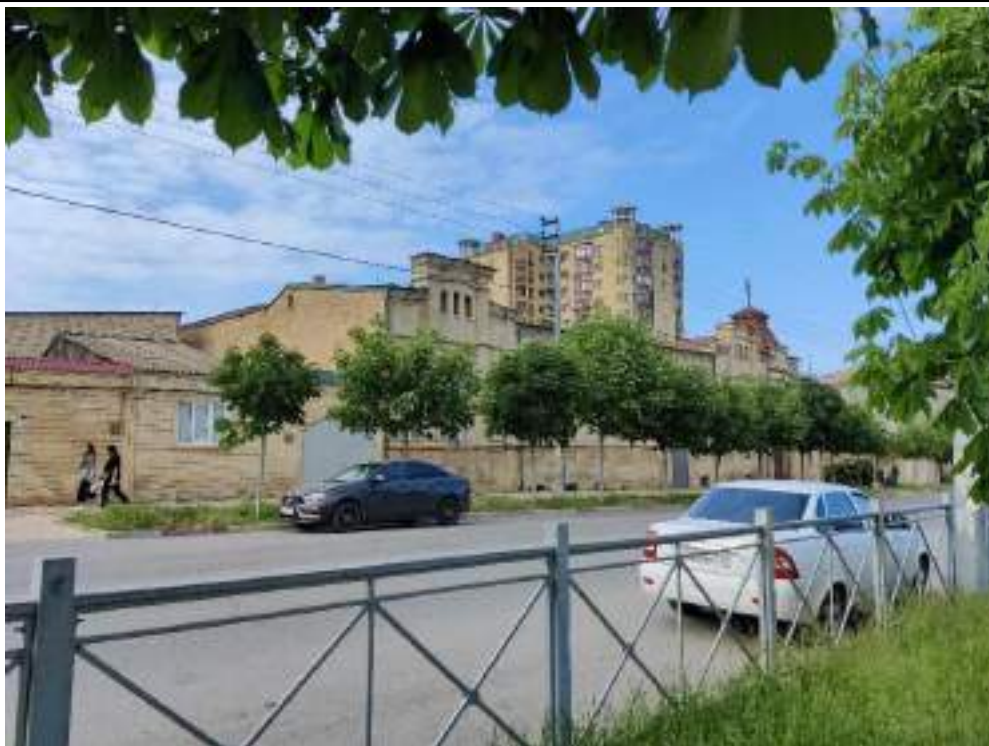
Точка фотофиксации № 3 Вид с ул. Буйнакского, возможно визуальное восприятие анализируемого объекта в перспективе улицы при движении вдоль нее, в зоне визуального восприятия памятника расположен диссонирующий современный объект капитального строительства
