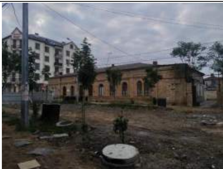
Точка фотофиксации №6 Вид восточного корпуса объекта с ул. Курбанова
