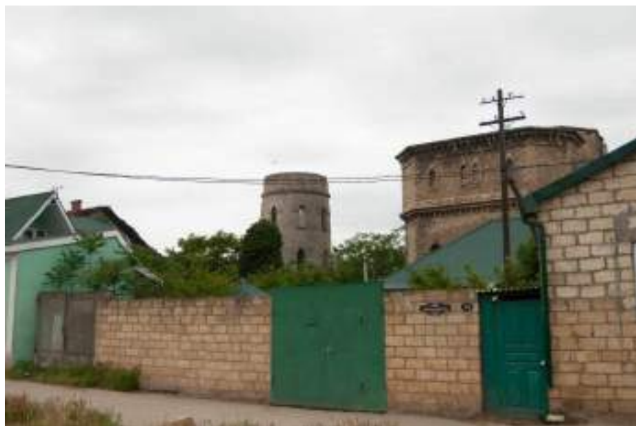
Точка фотофиксации №14 Вид объектов в перспективе ул. Вокзальной
