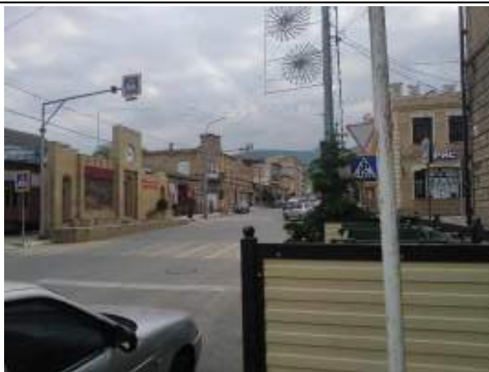
Точка фотофиксации № 7.9 Вид объекта с ул. Курбанова
