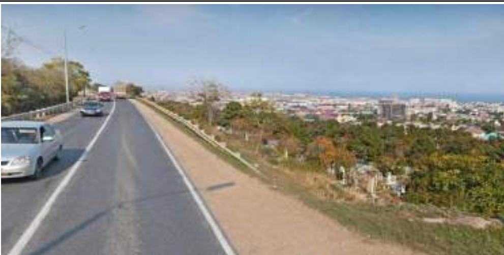
Точка фотофиксации № 22 Фрагментарная видимость объекта с автомагистралю федерального значения «Кавказ» (Р-217, в прошлом М-26)
