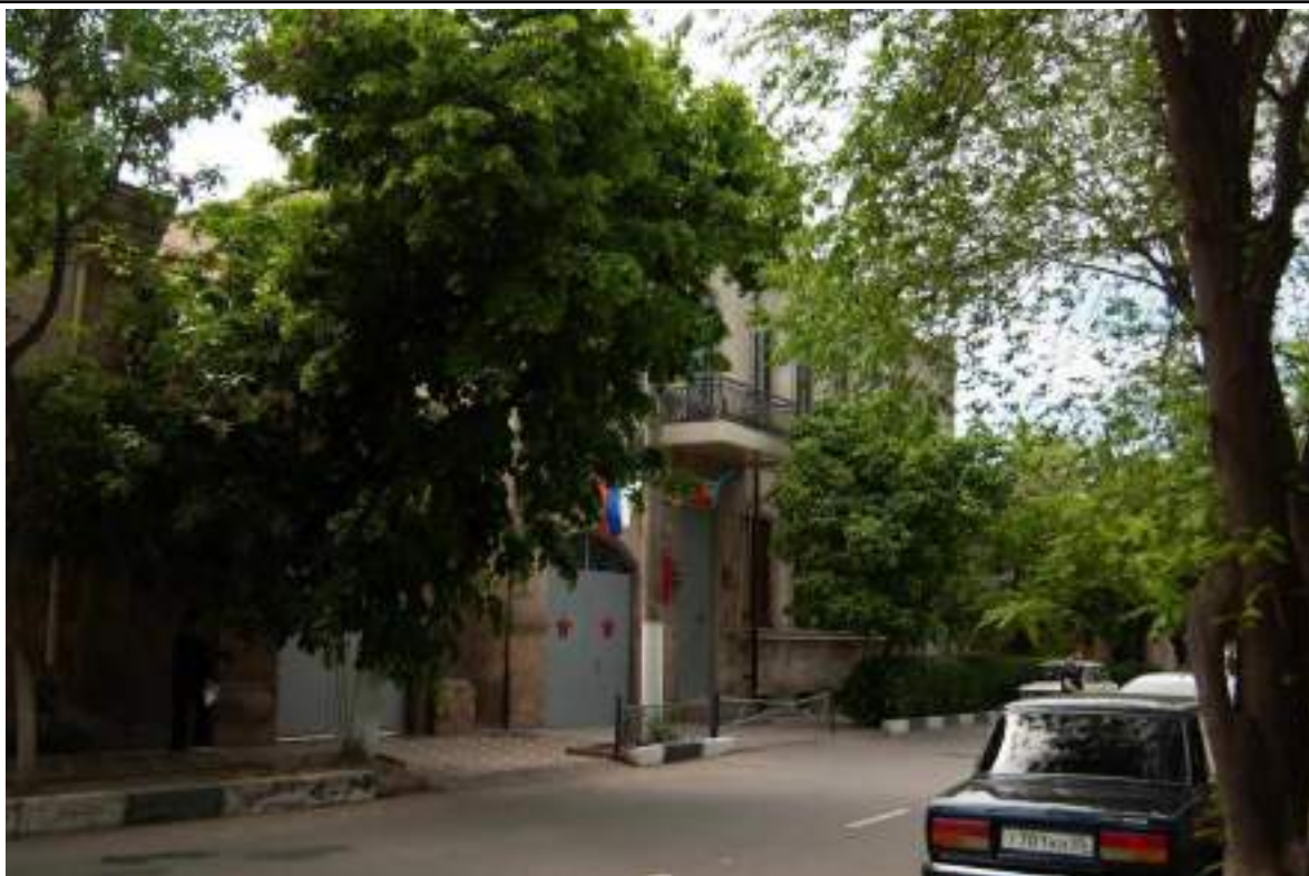
Точка фотофиксации №1 В Вид объекта в перспективе пер. Красноармейский
