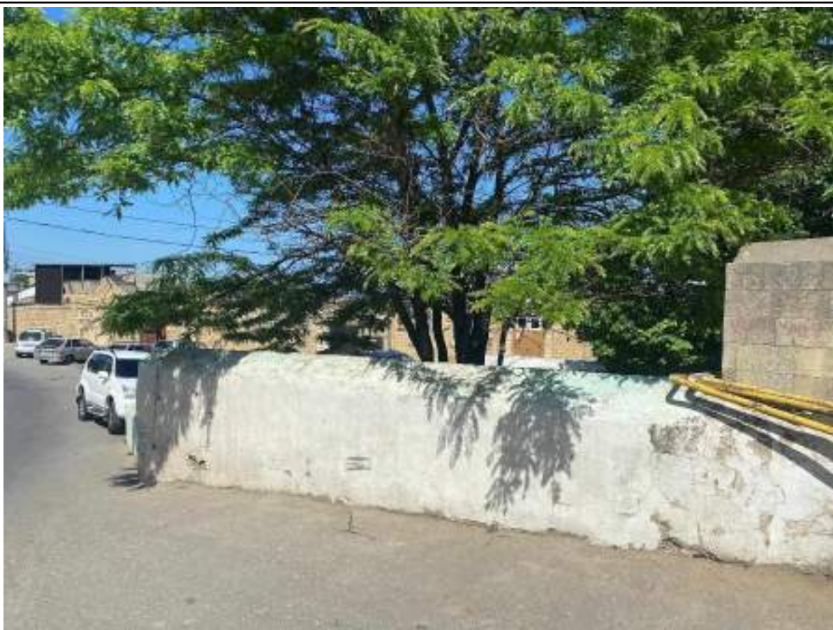
Точка фотофиксации № 2 Вид с ул. Агасиева
