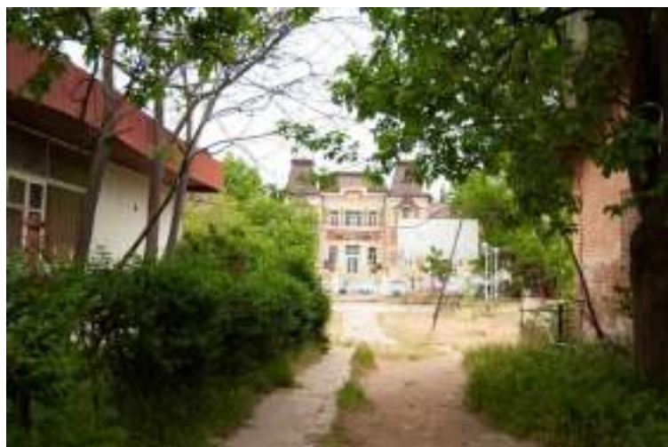
Точка фотофиксации №10 Вид на объект из сквера, возможна фрагментарная видимость объекта
