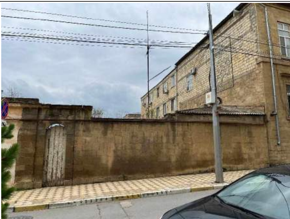
Точка фотофиксации 4.10 Вид объекта с ул. Пашабекова
