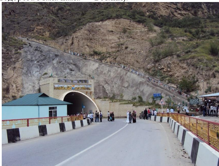
Фото 1. Тоннель под горой Ахульго.
