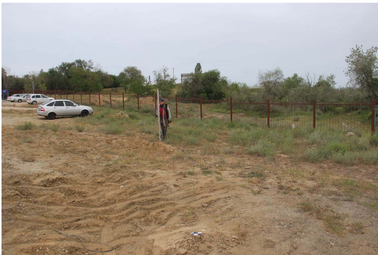
Рис. 3. Республика Дагестан. Объект «Проектирование и строительство напорной нитки D 1400 мм от ГКНС-6 г. Махачкалы до канализационных очистных сооружений г. Каспийска протяжённостью 16,0 км и производительностью 300 тыс. куб. м. в сутки». Точка фиксации №1 (WGS-84) N 42.86723°; E 47.67640°. Территория очистных сооружений. Вид с запада.
