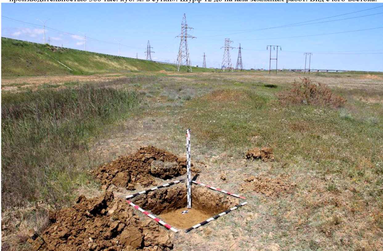
Рис. 121. Республика Дагестан. Объект «Проектирование и строительство напорной нитки D 1400 мм от ГКНС-6 г. Махачкалы до канализационных очистных сооружений г. Каспийска протяжённостью 16,0 км и производительностью 300 тыс. куб. м. в сутки». Объект «Реконструкция и увеличение общей производительности НГС-6 до 240 куб. м в сутки (г. Махачкала)». Шурф 12 после окончания земляных работ. Вид с юго-востока.
