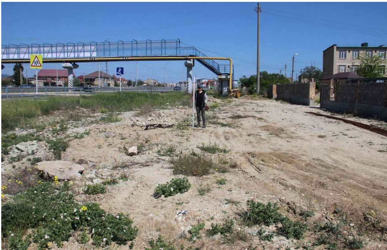
Рис. 26. Республика Дагестан. Объект «Проектирование и строительство напорной нитки D 1400 мм от ГКНС-6 г. Махачкалы до канализационных очистных сооружений г. Каспийска протяжённостью 16,0 км и производительностью 300 тыс. куб. м. в сутки». Трасса обследования. Точка фиксации №13 (WGS-84) N 42. 87025°; E 47. 62483°. 3-я Школьная улица (столовая «Аль Кавсар»). Вид с юго-востока.
