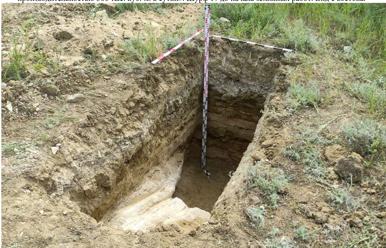
Рис. 148. Республика Дагестан. Объект «Проектирование и строительство напорной нитки D 1400 мм от ГКНС-6 г. Махачкалы до канализационных очистных сооружений г. Каспийска протяжённостью 16,0 км и производительностью 300 тыс. куб. м. в сутки». Шурф 17 после окончания земляных работ. Шурф на уровне материкового песчаника и песка. Вид с севера.
