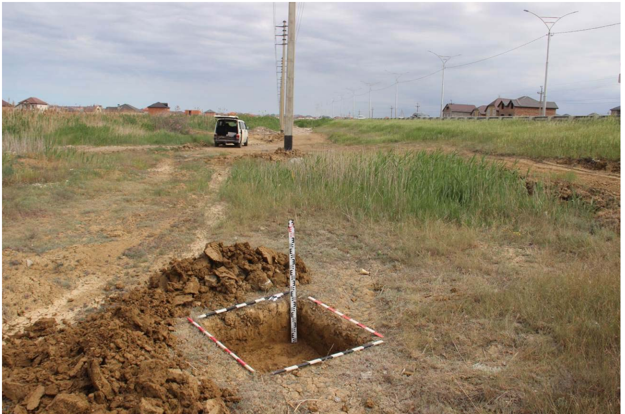
Рис. 141. Республика Дагестан. Объект «Проектирование и строительство напорной нитки D 1400 мм от ГКНС-6 г. Махачкалы до канализационных очистных сооружений г. Каспийска протяжённостью 16,0 км и производительностью 300 тыс. куб. м. в сутки». Шурф 16 после окончания земляных работ. Вид с северо-запада.
