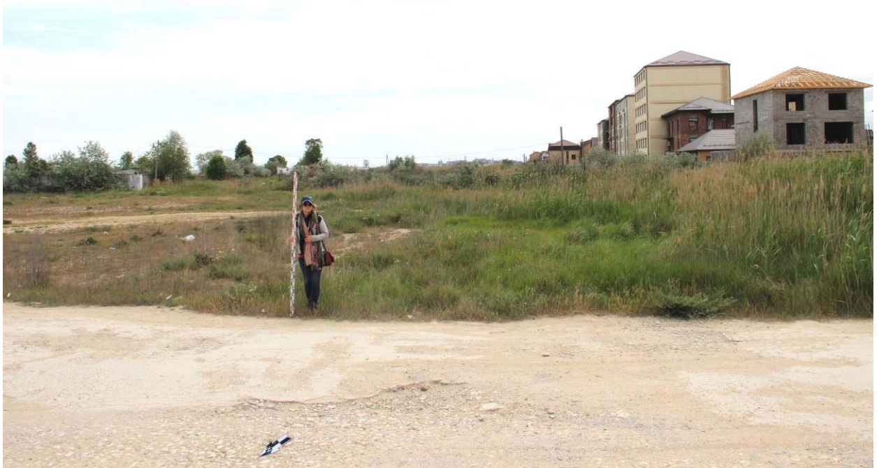
Рис. 58. Республика Дагестан. Объект «Проектирование и строительство напорной нитки D 1400 мм от ГКНС-6 г. Махачкалы до канализационных очистных сооружений г. Каспийска протяжённостью 16,0 км и производительностью 300 тыс. куб. м. в сутки». Трасса обследования. Точка фиксации №30 (WGS-84) N 42.94658°; E 47.57609°. Вид с северо-запада.
