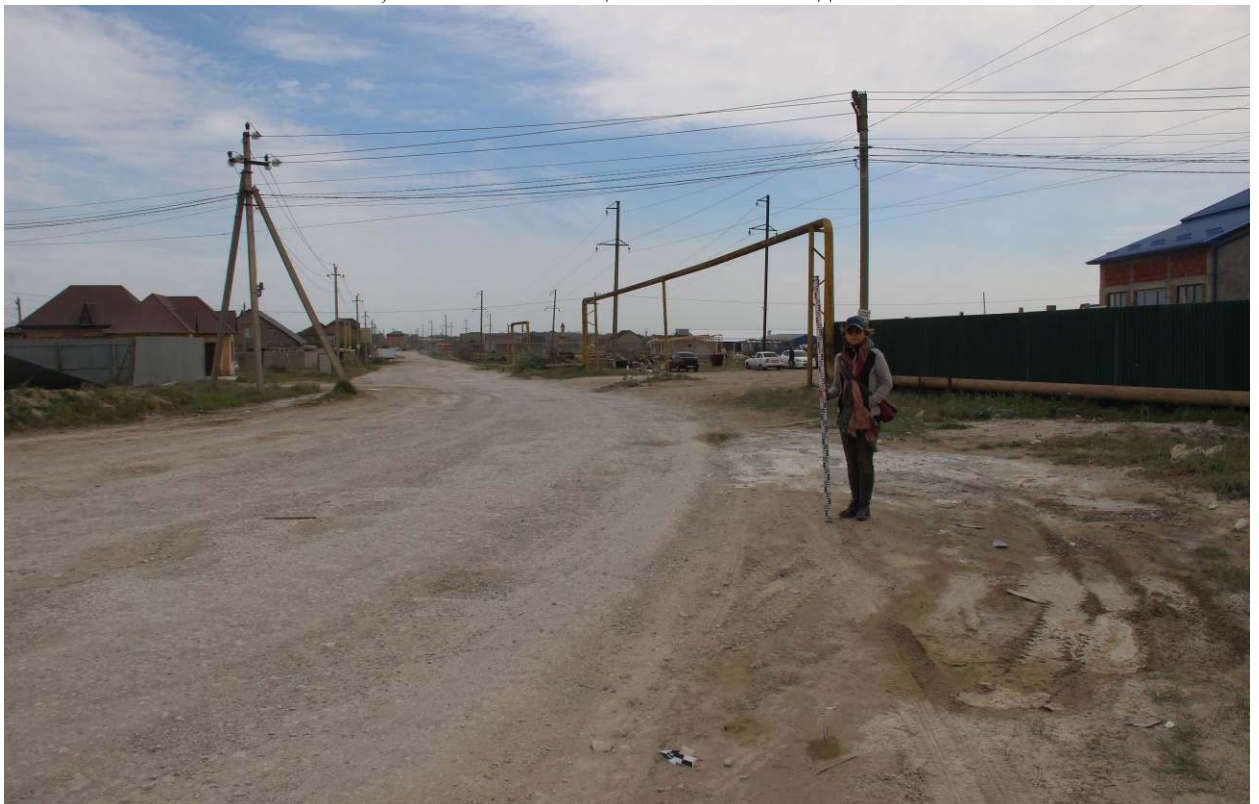
Рис. 13. Республика Дагестан. Объект «Проектирование и строительство напорной нитки D 1400 мм от ГКНС-6 г. Махачкалы до канализационных очистных сооружений г. Каспийска протяжённостью 16,0 км и производительностью 300 тыс. куб. м. в сутки». Трасса обследования. Точка фиксации №6 (WGS-84) N 42. 85747°; E 47. 64956°. Улица Маячная 133. Вид с запада.
