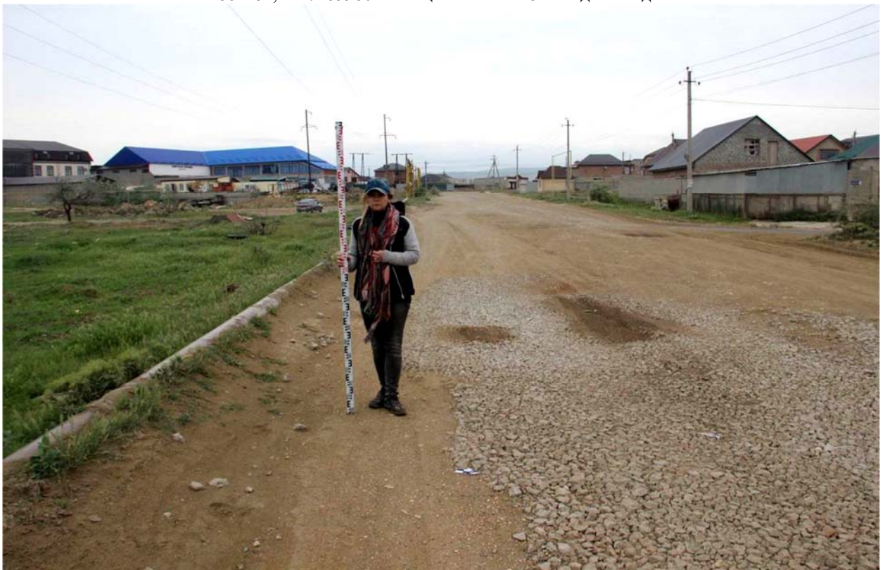
Рис. 11. Республика Дагестан. Объект «Проектирование и строительство напорной нитки D 1400 мм от ГКНС-6 г. Махачкалы до канализационных очистных сооружений г. Каспийска протяжённостью 16,0 км и производительностью 300 тыс. куб. м. в сутки». Трасса обследования. Точка фиксации №5 (WGS-84) N 42. 85836°; E 47. 65186°. Улица Маячная 143. Вид с востока.
