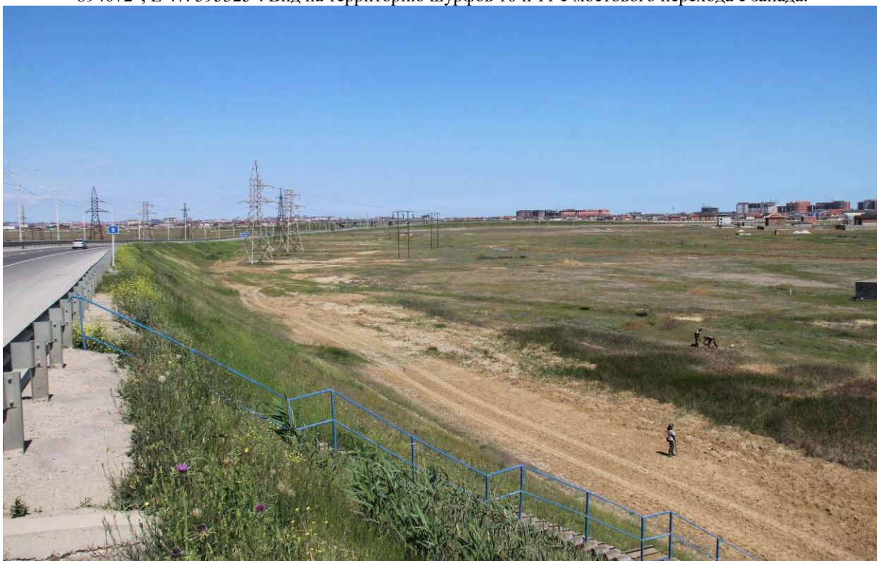
Рис.41. Республика Дагестан. Объект «Проектирование и строительство напорной нитки D 1400 мм от ГКНС-6 г. Махачкалы до канализационных очистных сооружений г. Каспийска протяжённостью 16,0 км и производительностью 300 тыс. куб. м. в сутки». Трасса обследования. Точка фиксации (WGS-84) N 42. 894072°; E 47. 595325°. Вид на территорию шурфов 12 и 14 с мостового перехода с востока.
