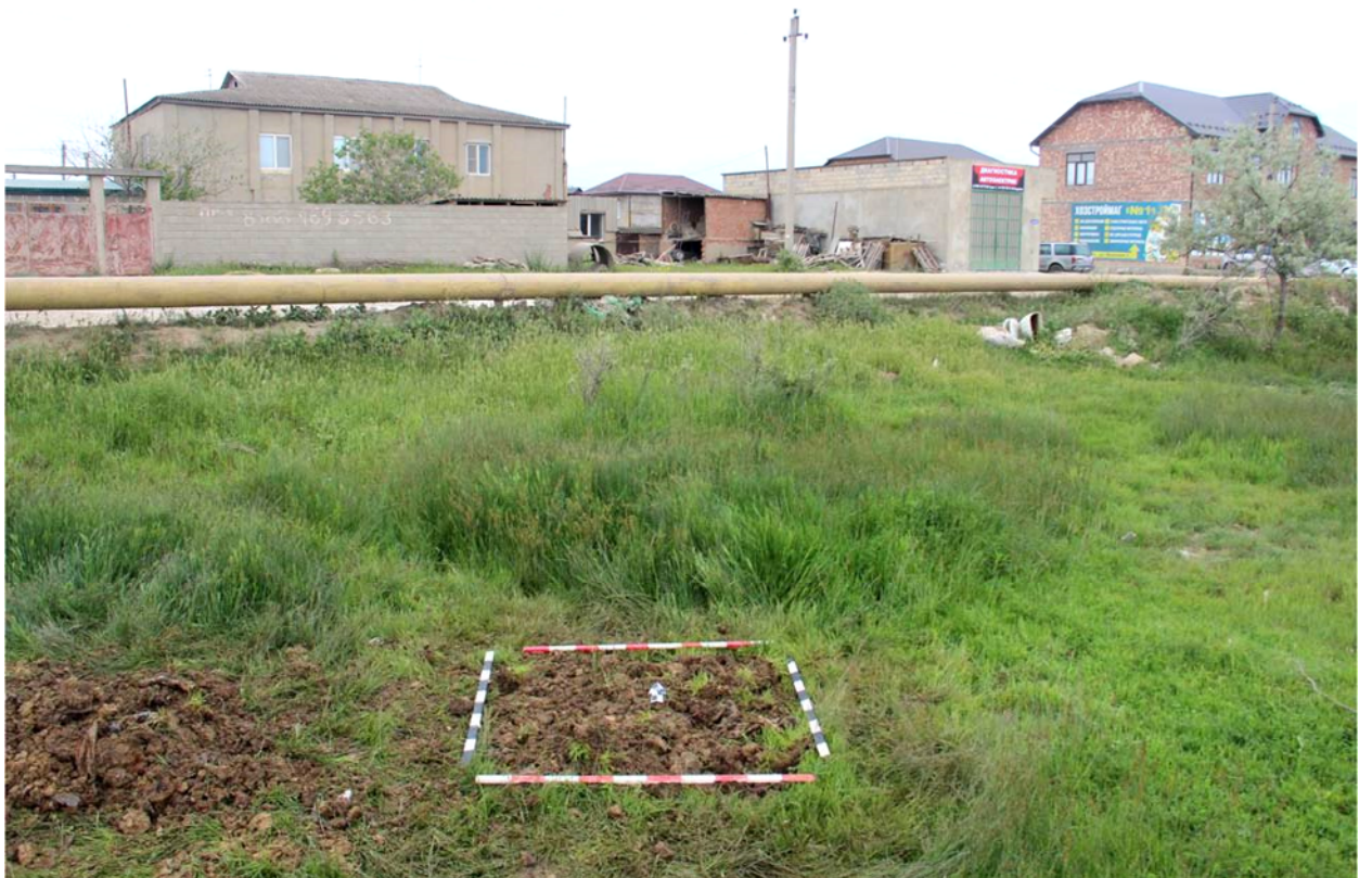
Рис. 85. Республика Дагестан. Объект «Проектирование и строительство напорной нитки D 1400 мм от ГКНС-6 г. Махачкалы до канализационных очистных сооружений г. Каспийска протяжённостью 16,0 км и производительностью 300 тыс. куб. м. в сутки». Шурф 4 после проведения земляных работ. Рекультивация. Вид с юга.
