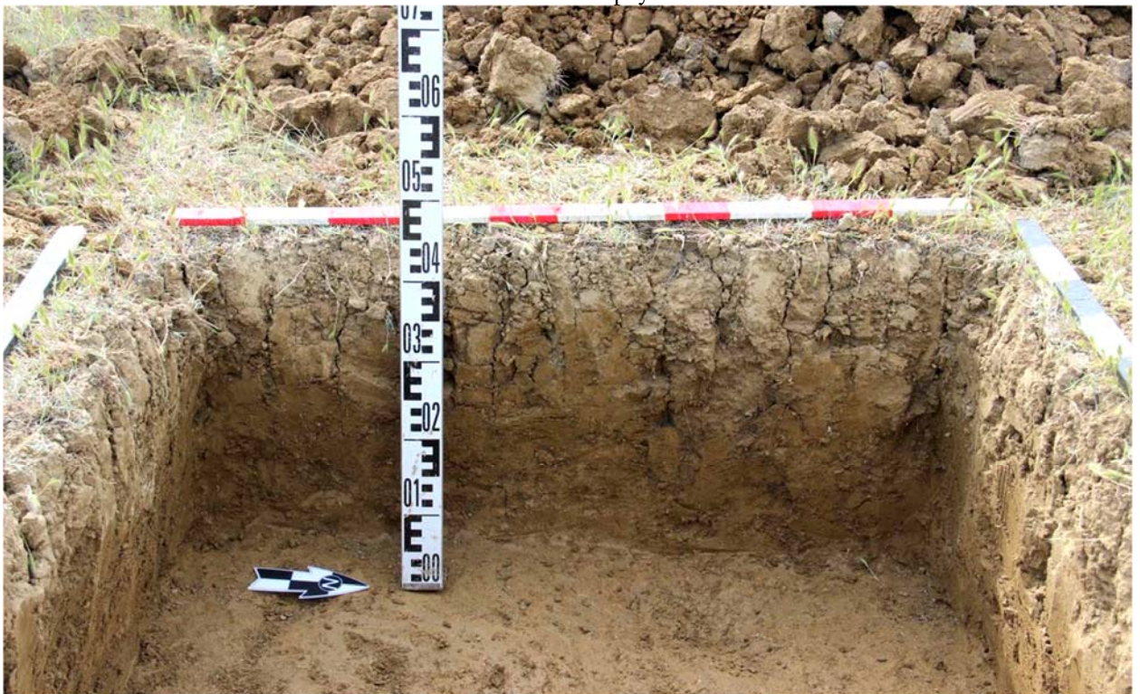
Рис. 113. Республика Дагестан. Объект «Проектирование и строительство напорной нитки D 1400 мм от ГКНС-6 г. Махачкалы до канализационных очистных сооружений г. Каспийска протяжённостью 16,0 км и производительностью 300 тыс. куб. м. в сутки». Зачистка шурфа 10 на уровне материкового туго-пластичного суглинка светло-коричневого оттенка. Стратиграфия профиля западного борта шурфа. Вид с востока.
