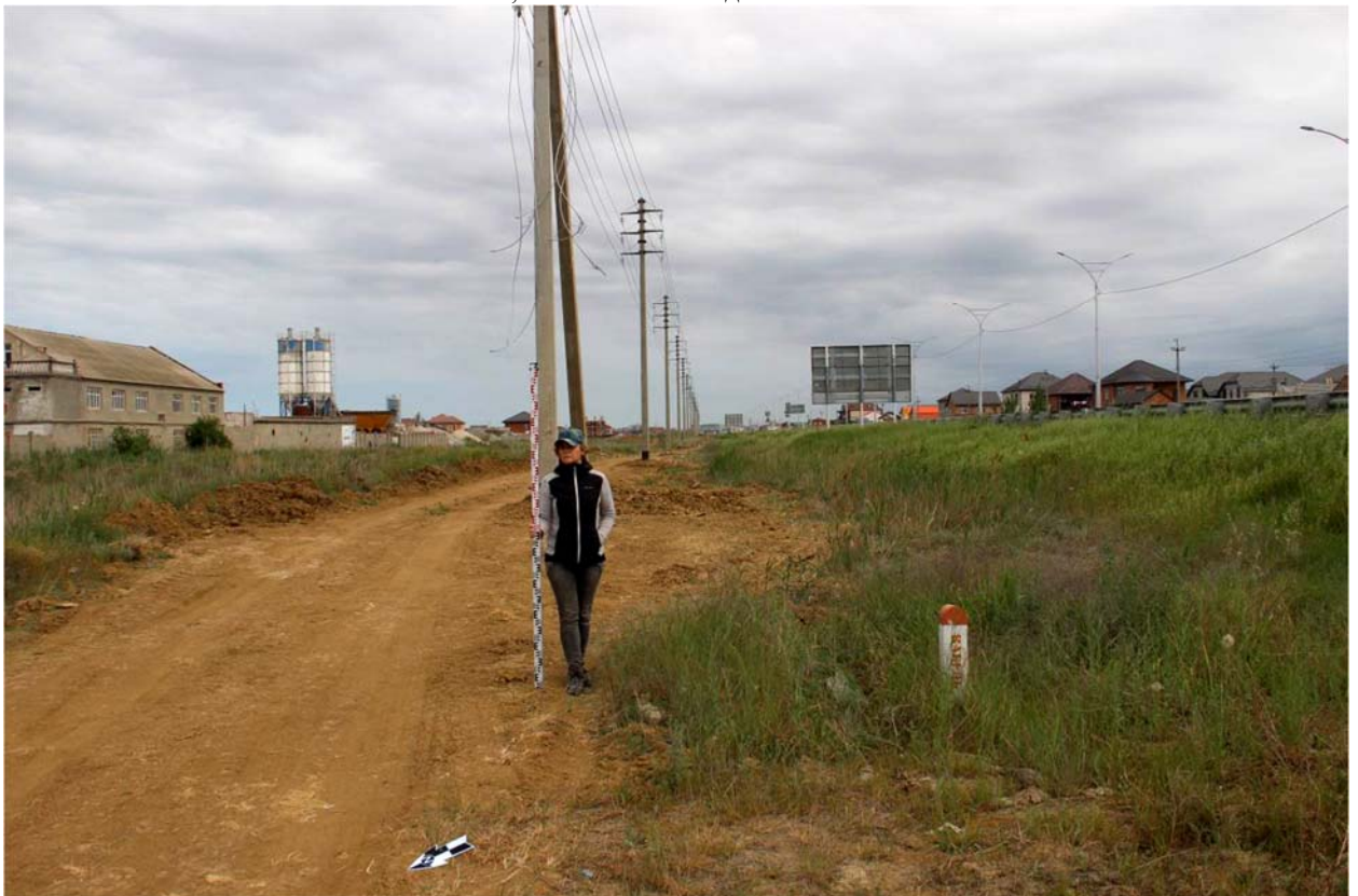
Рис. 47. Республика Дагестан. Объект «Проектирование и строительство напорной нитки D 1400 мм от ГКНС-6 г. Махачкалы до канализационных очистных сооружений г. Каспийска протяжённостью 16,0 км и производительностью 300 тыс. куб. м. в сутки». Трасса обследования. Точка фиксации №24 (WGS-84) N 42. 921165°; E 47. 581994°. Вид с северо-запада.
