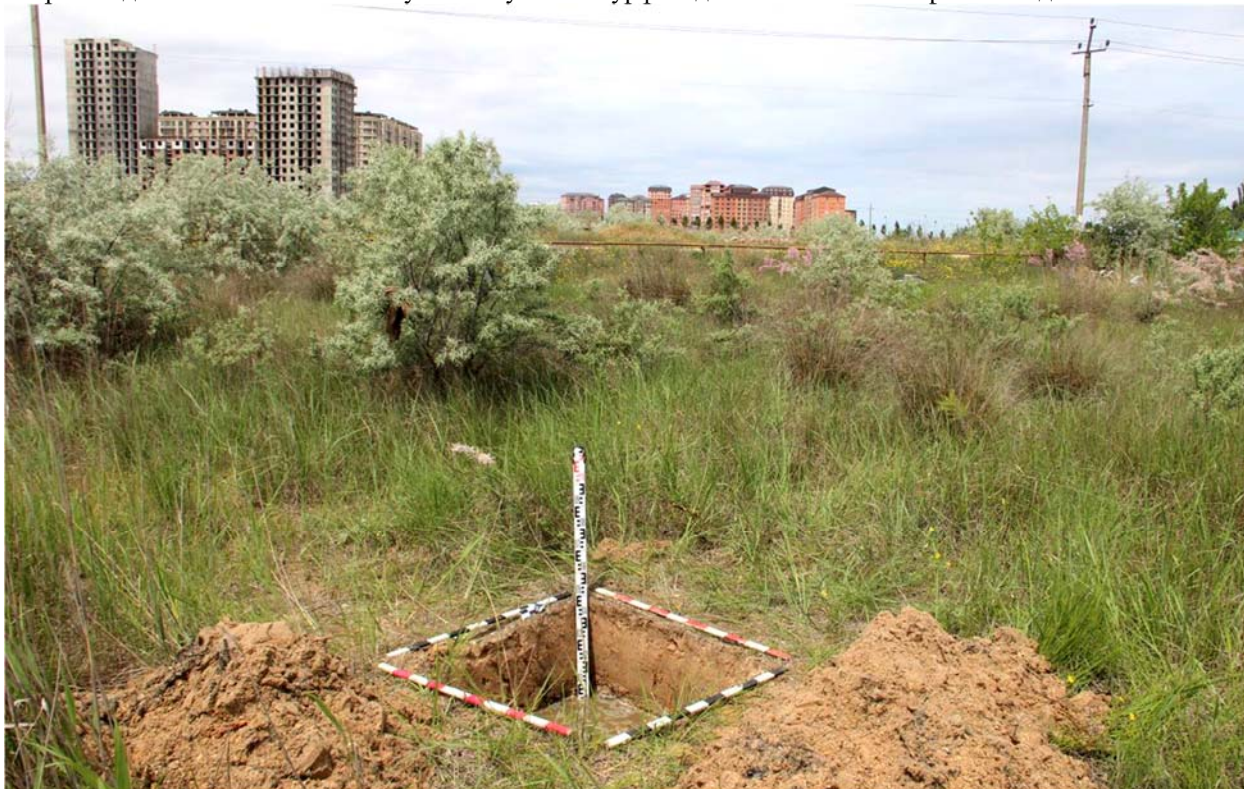
Рис. 162. Республика Дагестан. Объект «Проектирование и строительство напорной нитки D 1400 мм от ГКНС-6 г. Махачкалы до канализационных очистных сооружений г. Каспийска протяжённостью 16,0 км и производительностью 300 тыс. куб. м. в сутки». Шурф 20 после окончания земляных работ. Вид с юго-востока.
