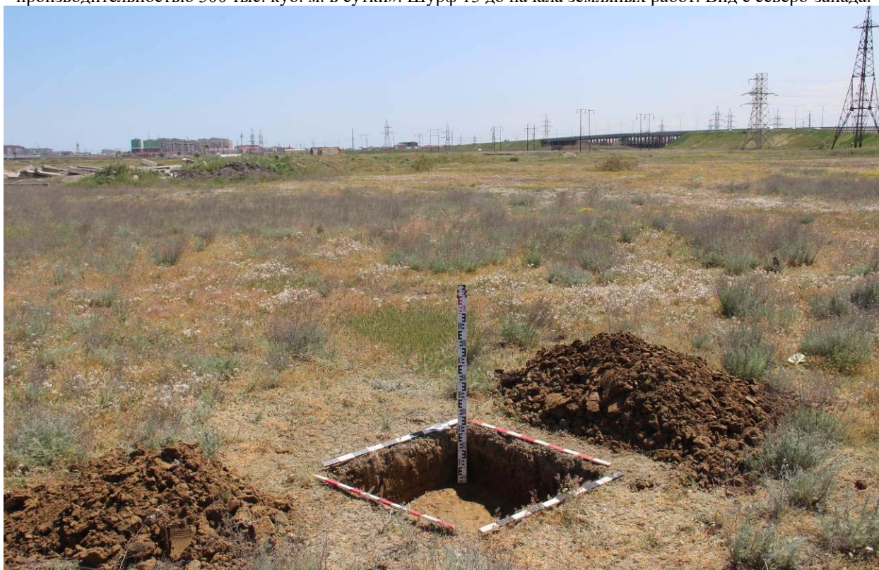
Рис. 126. Республика Дагестан. Объект «Проектирование и строительство напорной нитки D 1400 мм от ГКНС-6 г. Махачкалы до канализационных очистных сооружений г. Каспийска протяжённостью 16,0 км и производительностью 300 тыс. куб. м. в сутки». Шурф 13 после окончания земляных работ. Вид с северо-запада.
