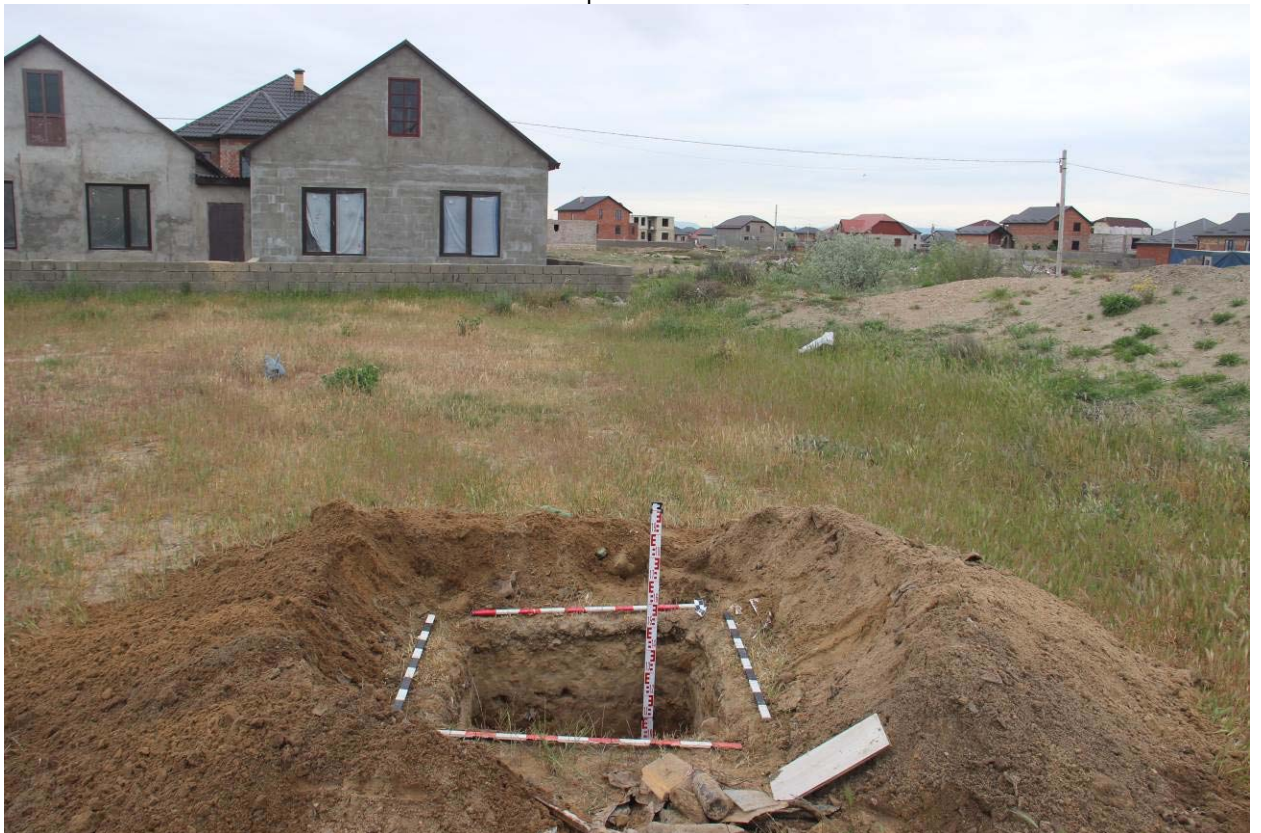
Рис. 71. Республика Дагестан. Объект «Проектирование и строительство напорной нитки D 1400 мм от ГКНС-6 г. Махачкалы до канализационных очистных сооружений г. Каспийска протяжённостью 16,0 км и производительностью 300 тыс. куб. м. в сутки». Шурф 2 после окончания земляных работ. Вид с севера.
