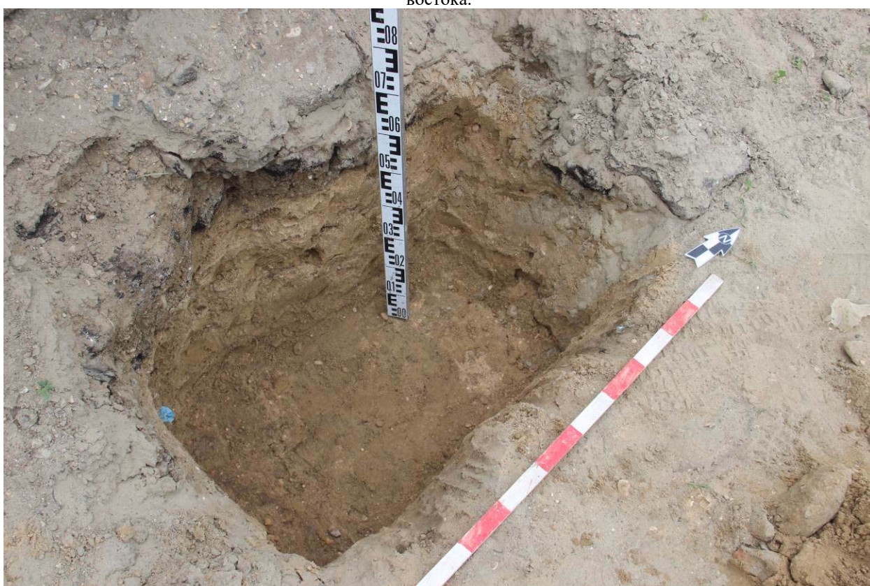
Рис. 67. Республика Дагестан. Объект «Проектирование и строительство напорной нитки D 1400 мм от ГКНС-6 г. Махачкалы до канализационных очистных сооружений г. Каспийска протяжённостью 16,0 км и производительностью 300 тыс. куб. м. в сутки». Зачистка шурфа на уровне материкового суглинка. Стратиграфия профиля западного и северного бортов шурфа. Вид с юго-востока.
