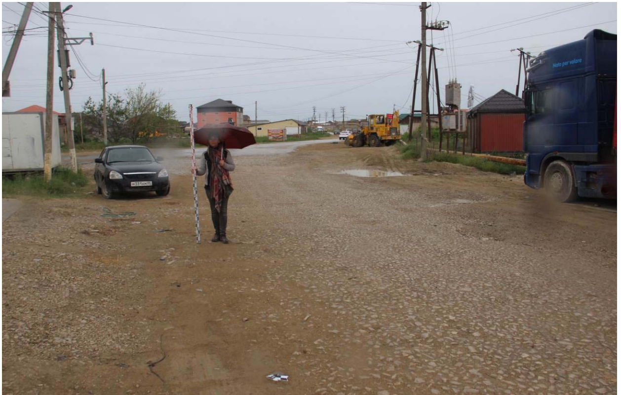
Рис. 10. Республика Дагестан. Объект «Проектирование и строительство напорной нитки D 1400 мм от ГКНС-6 г. Махачкалы до канализационных очистных сооружений г. Каспийска протяжённостью 16,0 км и производительностью 300 тыс. куб. м. в сутки». Трасса обследования. Точка фиксации №4 (WGS-84) N 42. 86215°; E 47. 65960°. Улица Маячная 151. Вид с запада.
