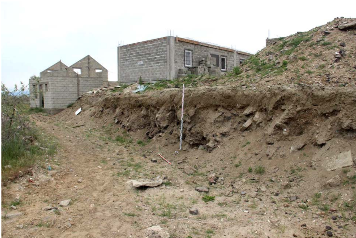
Рис. 64. Республика Дагестан. Объект «Проектирование и строительство напорной нитки D 1400 мм от ГКНС-6 г. Махачкалы до канализационных очистных сооружений г. Каспийска протяжённостью 16,0 км и производительностью 300 тыс. куб. м. в сутки». Шурф 1 (Зачистка) до начала земляных работ. Вид с северо-востока.
