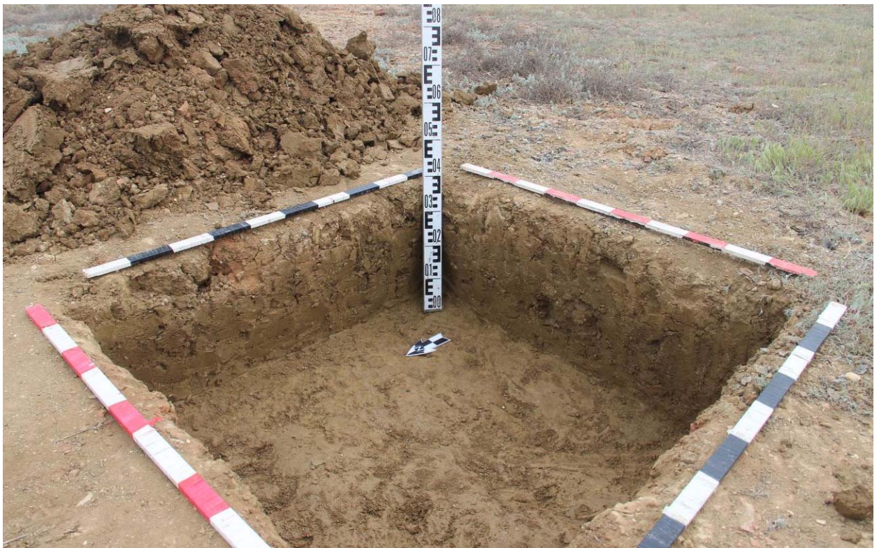
Рис. 118. Республика Дагестан. Объект «Проектирование и строительство напорной нитки D 1400 мм от ГКНС-6 г. Махачкалы до канализационных очистных сооружений г. Каспийска протяжённостью 16,0 км и производительностью 300 тыс. куб. м. в сутки». Зачистка шурфа 11 на уровне материкового тугопластичного суглинка светло-коричневого оттенка. Стратиграфия профиля южного и восточного бортов шурфа. Вид с северо-запада.
