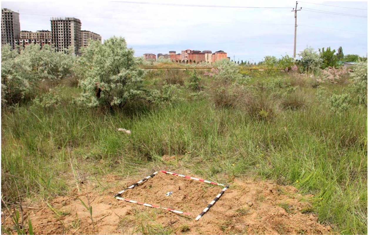
Рис. 165. Республика Дагестан. Объект «Проектирование и строительство напорной нитки D 1400 мм от ГКНС-6 г. Махачкалы до канализационных очистных сооружений г. Каспийска протяжённостью 16,0 км и производительностью 300 тыс. куб. м. в сутки». Шурф 20 после проведения земляных работ. Рекультивация. Вид с юго-востока.
