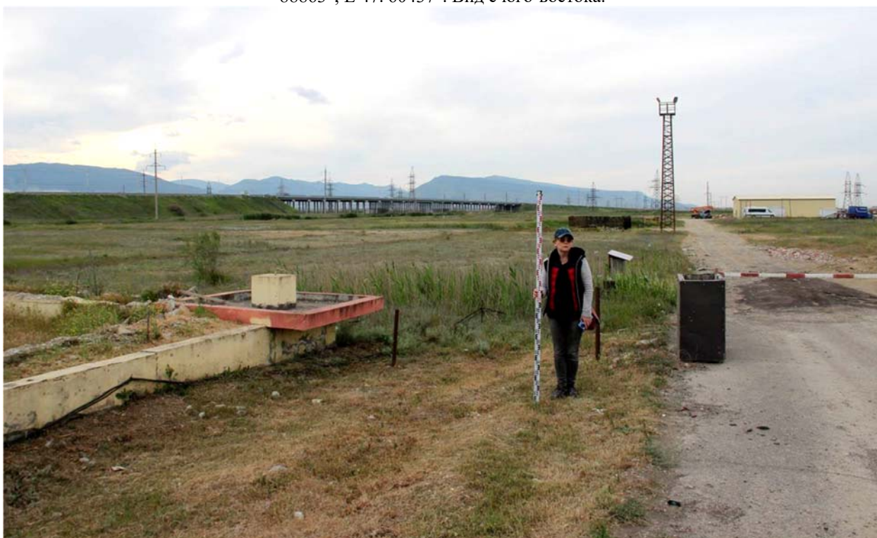
Рис. 37. Республика Дагестан. Объект «Проектирование и строительство напорной нитки D 1400 мм от ГКНС-6 г. Махачкалы до канализационных очистных сооружений г. Каспийска протяжённостью 16,0 км и производительностью 300 тыс. куб. м. в сутки». Трасса обследования. Точка фиксации №19 (WGS-84) N 42. 89104°; E 47. 60299°. Вид на мостовой переход и плавни под ним с востока.
