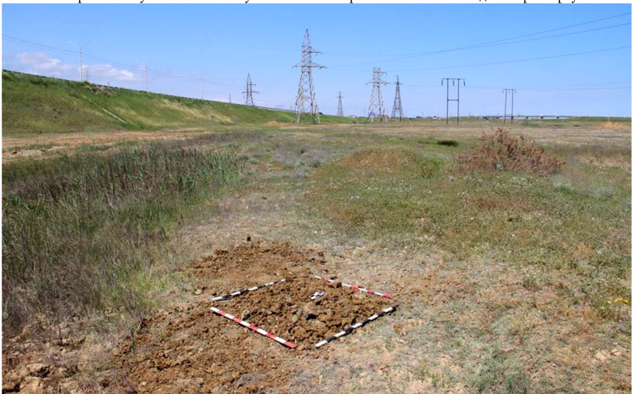
Рис. 123. Республика Дагестан. Объект «Проектирование и строительство напорной нитки D 1400 мм от ГКНС-6 г. Махачкалы до канализационных очистных сооружений г. Каспийска протяжённостью 16,0 км и производительностью 300 тыс. куб. м. в сутки». Шурф 12 после проведения земляных работ. Рекультивация. Вид с юго-востока.
