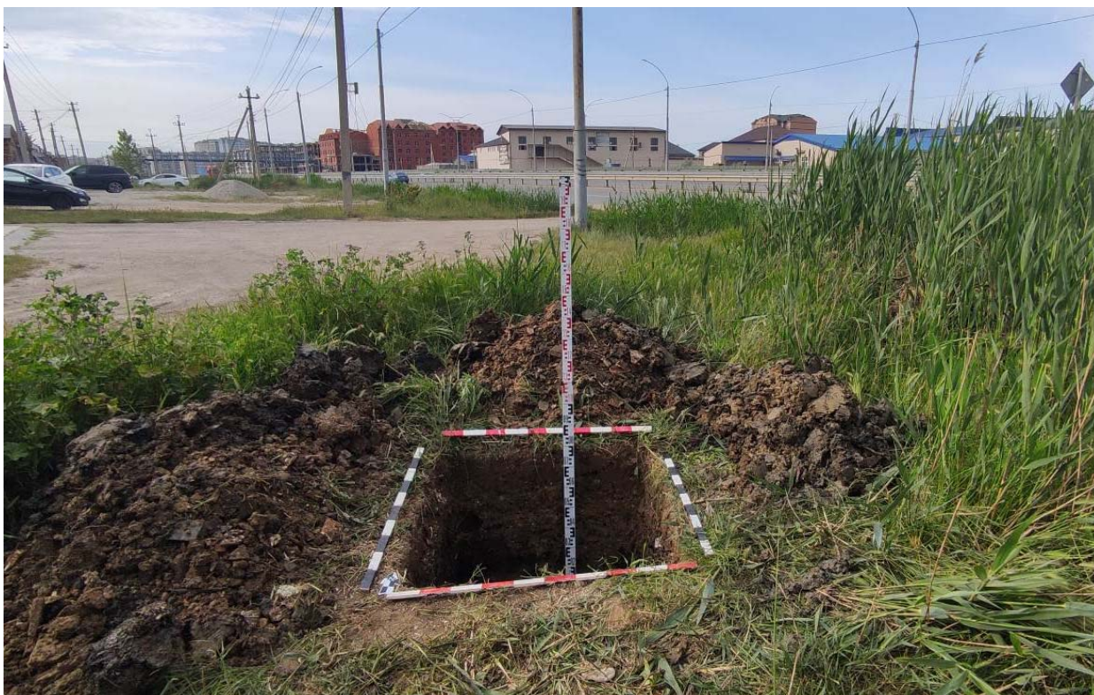
Рис. 105. Республика Дагестан. Объект «Проектирование и строительство напорной нитки D 1400 мм от ГКНС-6 г. Махачкалы до канализационных очистных сооружений г. Каспийска протяжённостью 16,0 км и производительностью 300 тыс. куб. м. в сутки». Шурф 9 после окончания земляных работ. Вид с юга.
