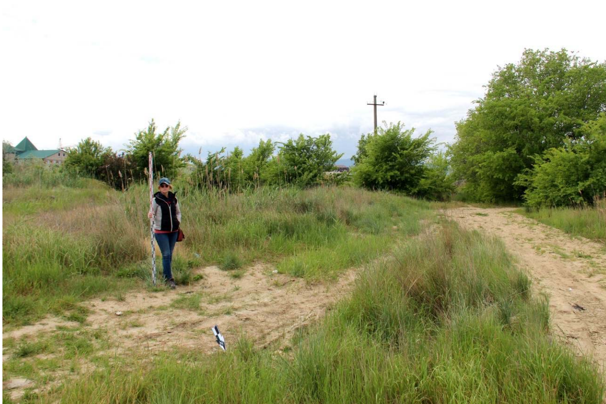
Рис. 62. Республика Дагестан. Объект «Проектирование и строительство напорной нитки D 1400 мм от ГКНС-6 г. Махачкалы до канализационных очистных сооружений г. Каспийска протяжённостью 16,0 км и производительностью 300 тыс. куб. м. в сутки». Трасса обследования. Точка фиксации №32 (WGS-84) N 42.950730°; E 47.573480°. Вид с севера.
