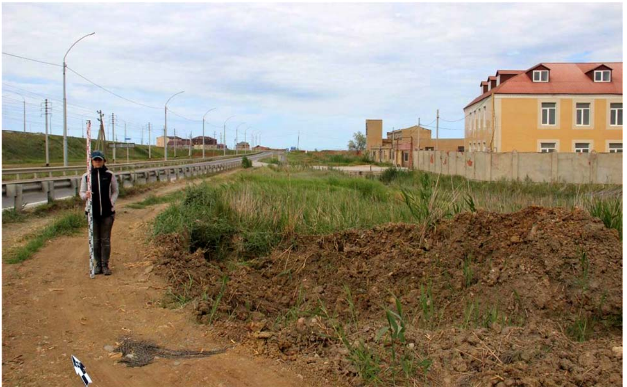
Рис. 48. Республика Дагестан. Объект «Проектирование и строительство напорной нитки D 1400 мм от ГКНС-6 г. Махачкалы до канализационных очистных сооружений г. Каспийска протяжённостью 16,0 км и производительностью 300 тыс. куб. м. в сутки». Трасса обследования. Точка фиксации №24 (WGS-84) N 42. 921165°; E 47. 581994°. Вид с юго-запада.
