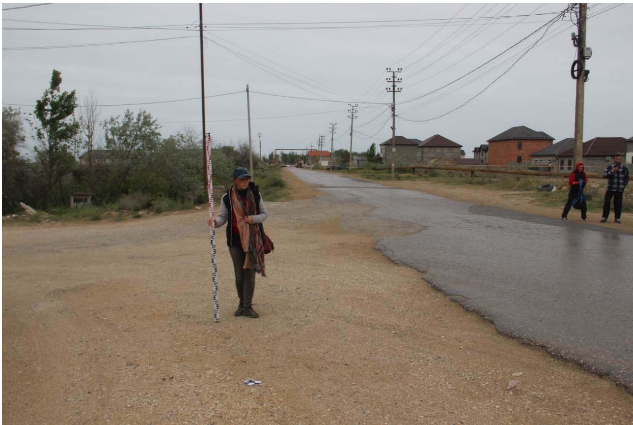
Рис. 6. Республика Дагестан. Объект «Проектирование и строительство напорной нитки D 1400 мм от ГКНС-6 г. Махачкалы до канализационных очистных сооружений г. Каспийска протяжённостью 16,0 км и производительностью 300 тыс. куб. м. в сутки». Трасса обследования. Точка фиксации №2 (WGS-84) N 42.86510°; E 47.67935°. Улица Маячная 67 (1-я Карьерная линия). Вид с запада.
