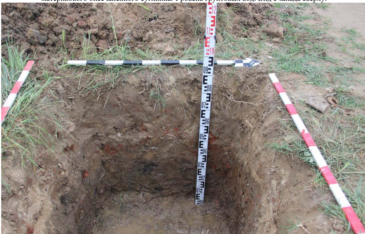
Рис. 79. Республика Дагестан. Объект «Проектирование и строительство напорной нитки D 1400 мм от ГКНС-6 г. Махачкалы до канализационных очистных сооружений г. Каспийска протяжённостью 16,0 км и производительностью 300 тыс. куб. м. в сутки». Зачистка шурфа 3 на уровне материкового опесчаненного суглинка. Стратиграфия профиля восточного борта шурфа. Вид с запада.
