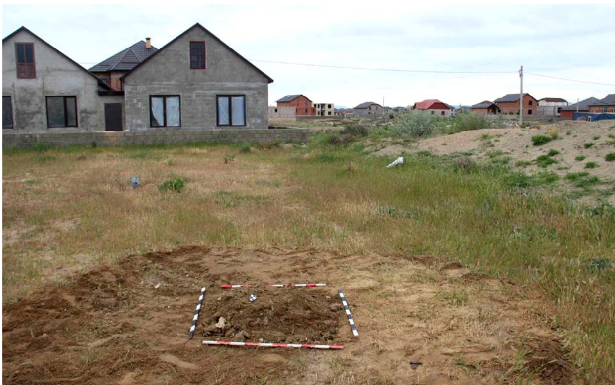
Рис. 74. Республика Дагестан. Объект «Проектирование и строительство напорной нитки D 1400 мм от ГКНС-6 г. Махачкалы до канализационных очистных сооружений г. Каспийска протяжённостью 16,0 км и производительностью 300 тыс. куб. м. в сутки». Шурф 2 после проведения земляных работ. Рекультивация. Вид с северо-востока.
