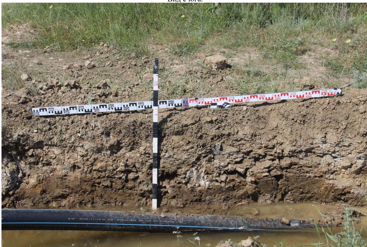
Рис. 102. Республика Дагестан. Объект «Проектирование и строительство напорной нитки D 1400 мм от ГКНС-6 г. Махачкалы до канализационных очистных сооружений г. Каспийска протяжённостью 16,0 км и производительностью 300 тыс. куб. м. в сутки». Шурф-зачистка 8 до начала земляных работ. Вид с востока.
