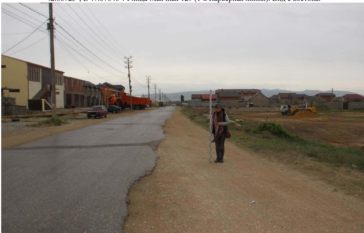
Рис. 5. Республика Дагестан. Объект «Проектирование и строительство напорной нитки D 1400 мм от ГКНС-6 г. Махачкалы до канализационных очистных сооружений г. Каспийска протяжённостью 16,0 км и производительностью 300 тыс. куб. м. в сутки». Трасса обследования. Точка фиксации №2 (WGS-84) N 42.86510°; E 47.67935°. Улица Маячная 67 (1-я Карьерная линия). Вид с востока.
