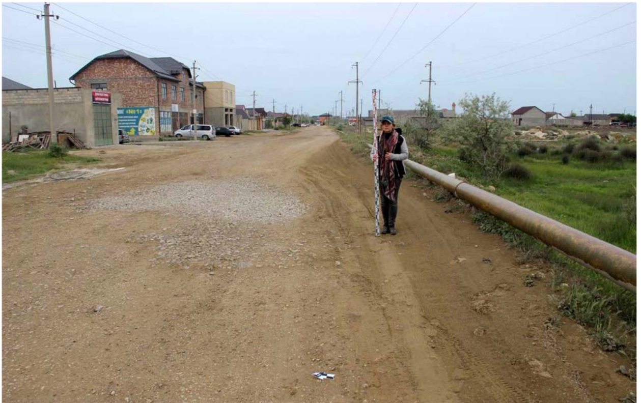
Рис. 12. Республика Дагестан. Объект «Проектирование и строительство напорной нитки D 1400 мм от ГКНС-6 г. Махачкалы до канализационных очистных сооружений г. Каспийска протяжённостью 16,0 км и производительностью 300 тыс. куб. м. в сутки». Трасса обследования. Точка фиксации №5 (WGS-84) N 42. 85836°; E 47. 65186°. Улица Маячная 143. Вид с востока.
