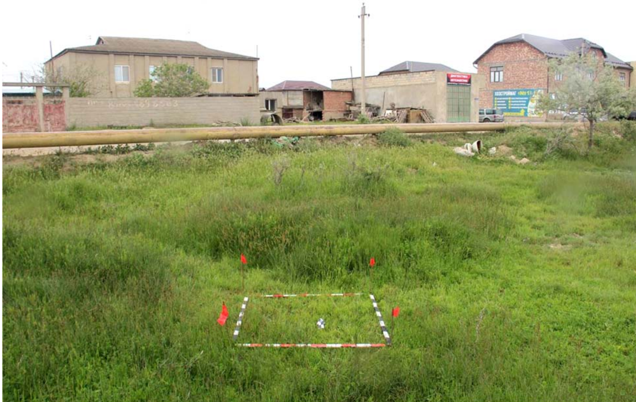
Рис. 81. Республика Дагестан. Объект «Проектирование и строительство напорной нитки D 1400 мм от ГКНС-6 г. Махачкалы до канализационных очистных сооружений г. Каспийска протяжённостью 16,0 км и производительностью 300 тыс. куб. м. в сутки». Шурф 4 до начала земляных работ. Вид с юга.
