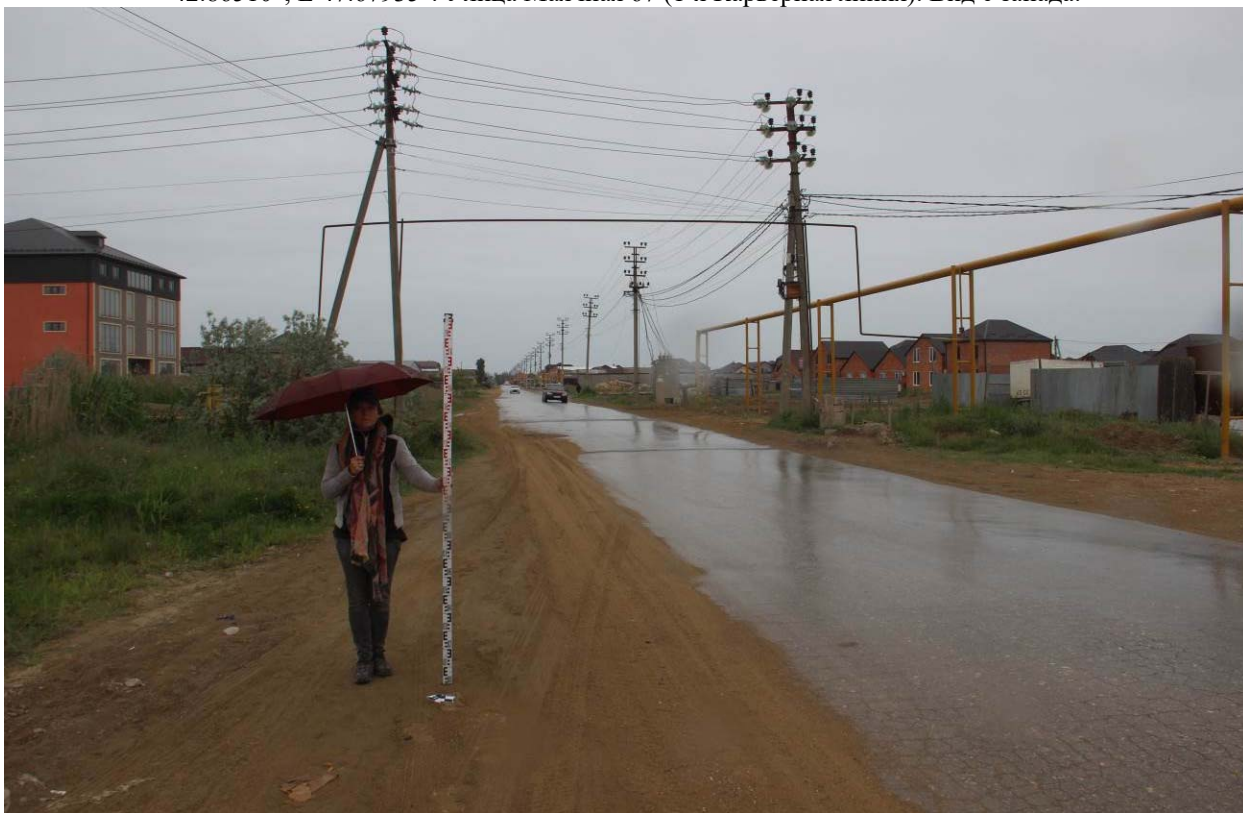
Рис. 7. Республика Дагестан. Объект «Проектирование и строительство напорной нитки D 1400 мм от ГКНС-6 г. Махачкалы до канализационных очистных сооружений г. Каспийска протяжённостью 16,0 км и производительностью 300 тыс. куб. м. в сутки». Трасса обследования. Точка фиксации №3 (WGS-84) N 42.862740°; E 47.661620°. Улица Маячная 151Б (1-я Карьерная линия). Вид с запада.
