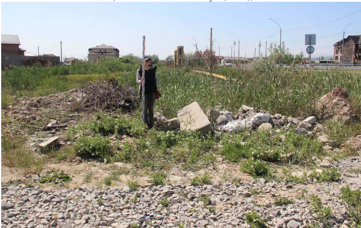
Рис. 25. Республика Дагестан. Объект «Проектирование и строительство напорной нитки D 1400 мм от ГКНС-6 г. Махачкалы до канализационных очистных сооружений г. Каспийска протяжённостью 16,0 км и производительностью 300 тыс. куб. м. в сутки». Трасса обследования. Точка фиксации №13 (WGS-84) N 42. 87025°; E 47. 62483°. 3-я Школьная улица (столовая «Аль Кавсар»). Вид с северо-запада.
