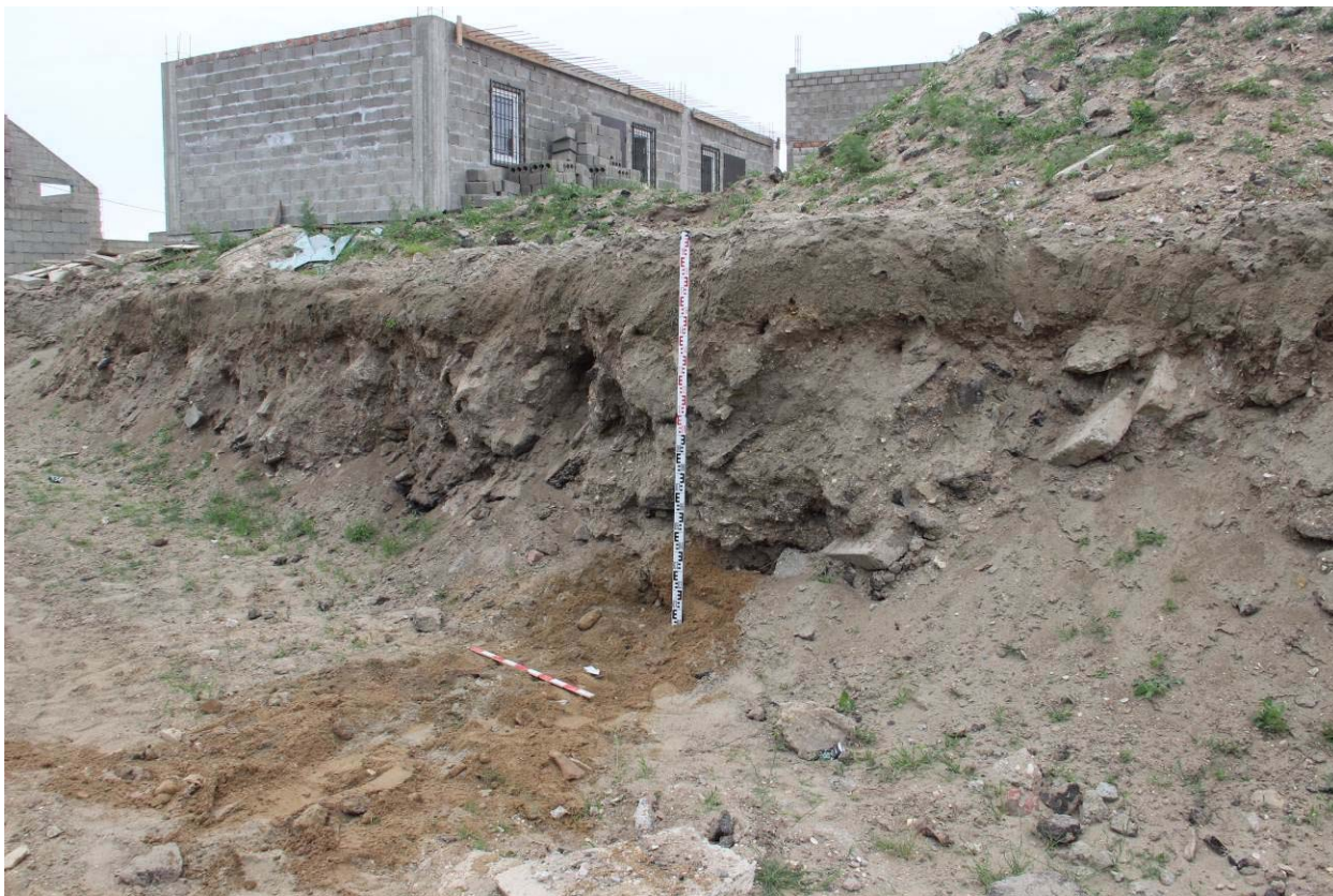
Рис. 68. Республика Дагестан. Объект «Проектирование и строительство напорной нитки D 1400 мм от ГКНС-6 г. Махачкалы до канализационных очистных сооружений г. Каспийска протяжённостью 16,0 км и производительностью 300 тыс. куб. м. в сутки». Шурф после проведения земляных работ. Рекультивация. Вид с северо-востока.
