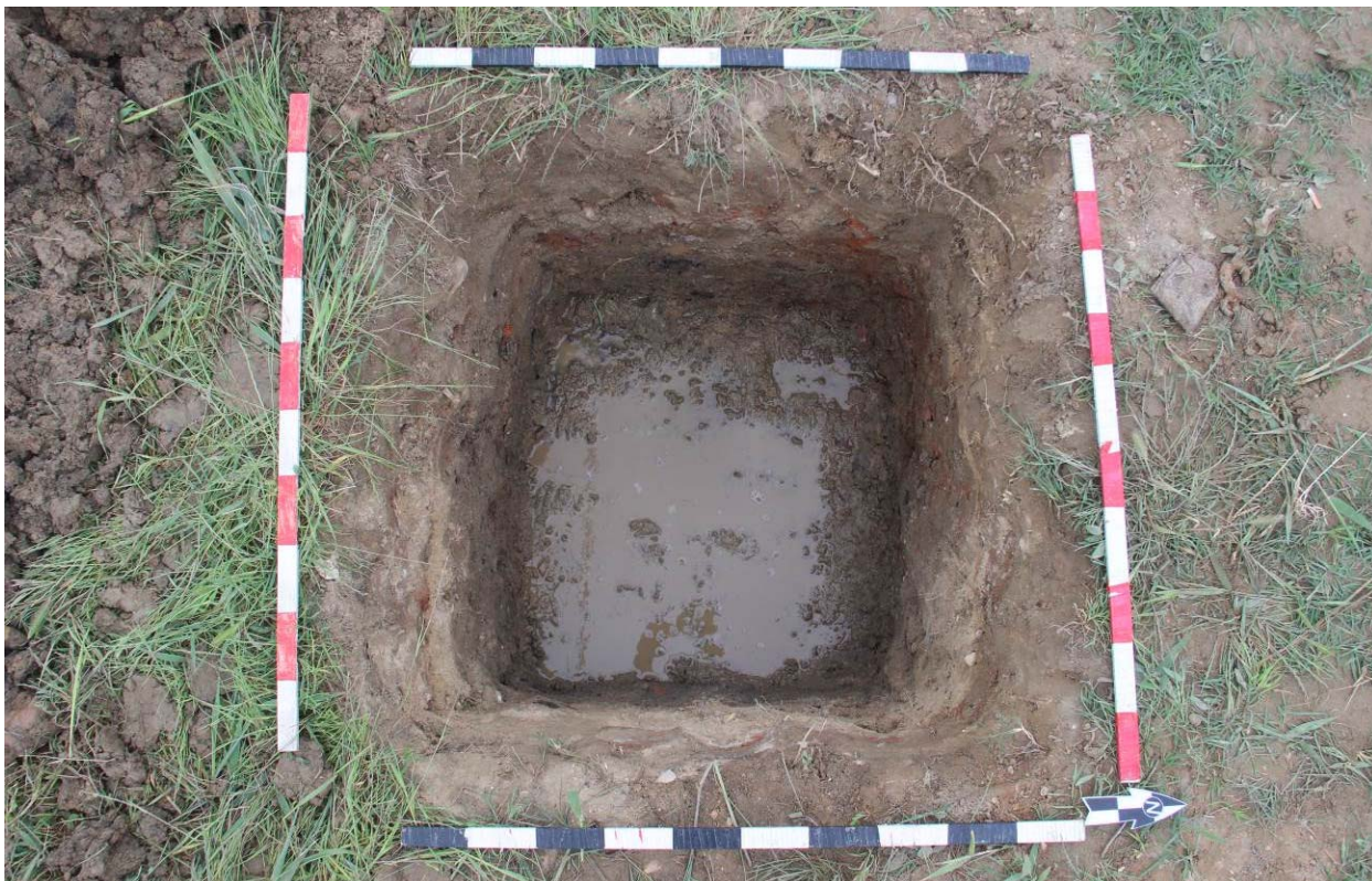
Рис. 78. Республика Дагестан. Объект «Проектирование и строительство напорной нитки D 1400 мм от ГКНС-6 г. Махачкалы до канализационных очистных сооружений г. Каспийска протяжённостью 16,0 км и производительностью 300 тыс. куб. м. в сутки». Шурф 3 после окончания земляных работ. Шурф на уровне материкового опесчаненного суглинка. Уровень грунтовых вод. Вид с запада сверху.
