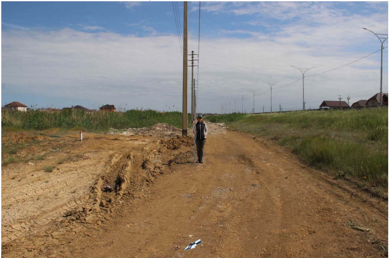
Рис. 45. Республика Дагестан. Объект «Проектирование и строительство напорной нитки D 1400 мм от ГКНС-6 г. Махачкалы до канализационных очистных сооружений г. Каспийска протяжённостью 16,0 км и производительностью 300 тыс. куб. м. в сутки». Трасса обследования. Точка фиксации №23 (WGS-84) N 42. 91382°; E 47. 58910°. Вид с северо-запада.
