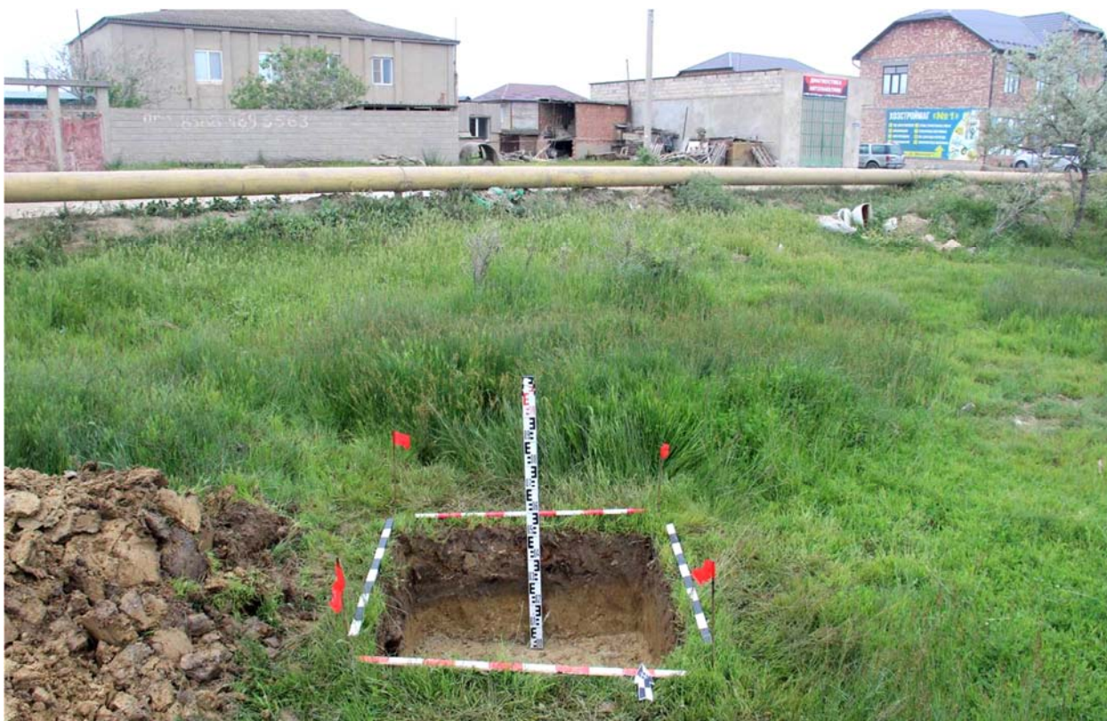
Рис. 82. Республика Дагестан. Объект «Проектирование и строительство напорной нитки D 1400 мм от ГКНС-6 г. Махачкалы до канализационных очистных сооружений г. Каспийска протяжённостью 16,0 км и производительностью 300 тыс. куб. м. в сутки». Шурф 4 после окончания земляных работ. Вид с юга.
