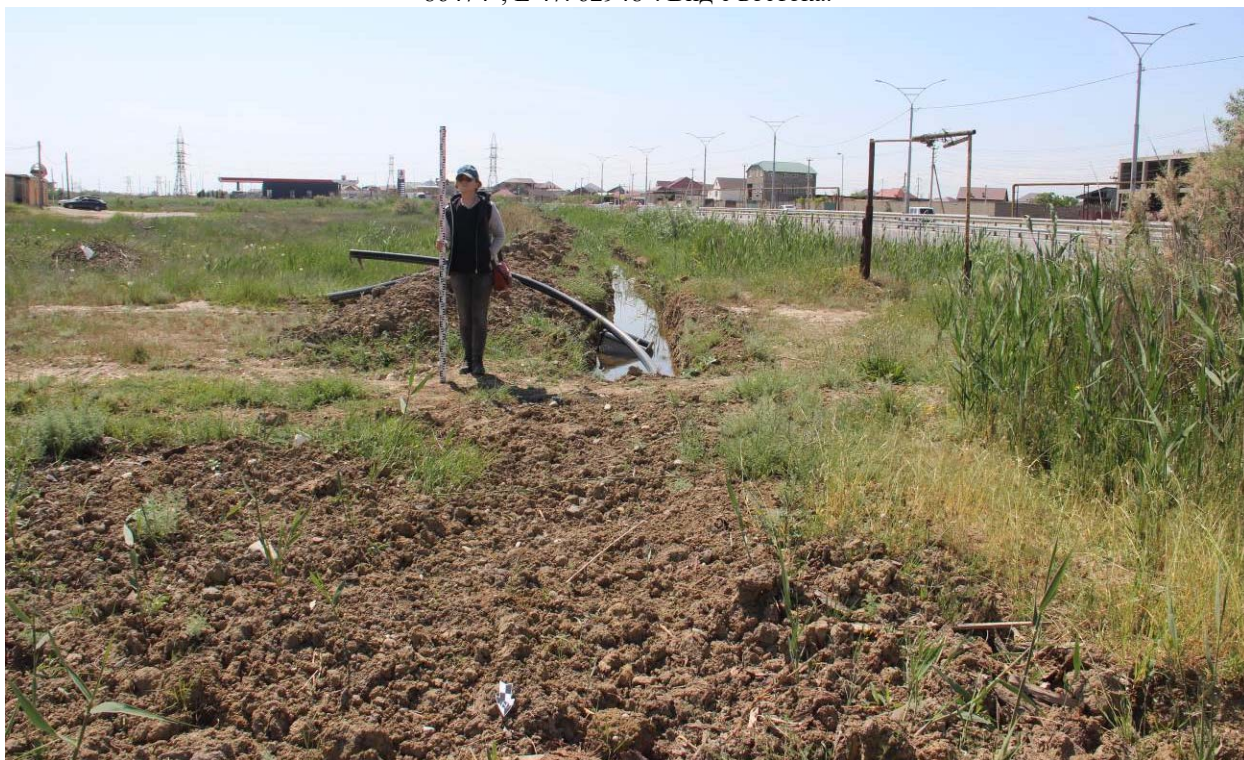
Рис. 23. Республика Дагестан. Объект «Проектирование и строительство напорной нитки D 1400 мм от ГКНС-6 г. Махачкалы до канализационных очистных сооружений г. Каспийска протяжённостью 16,0 км и производительностью 300 тыс. куб. м. в сутки». Трасса обследования. Точка фиксации №11 (WGS-84) N 42. 86704°; E 47. 62612°. 5-я Школьная улица 7. Вид с севера.
