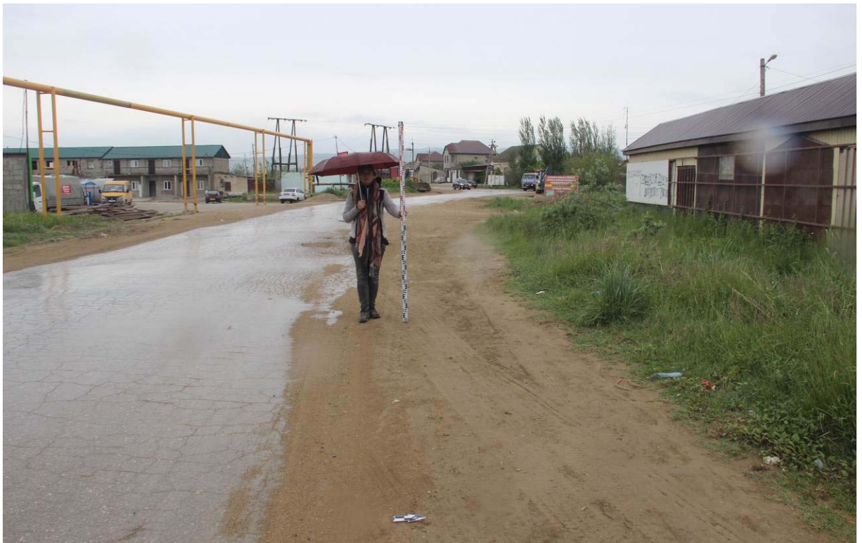
Рис. 8. Республика Дагестан. Объект «Проектирование и строительство напорной нитки D 1400 мм от ГКНС-6 г. Махачкалы до канализационных очистных сооружений г. Каспийска протяжённостью 16,0 км и производительностью 300 тыс. куб. м. в сутки». Трасса обследования. Точка фиксации №3 (WGS-84) N 42. 862740°; E 47. 661620°. Улица Маячная 151Б (1-я Карьерная линия). Вид с востока.
