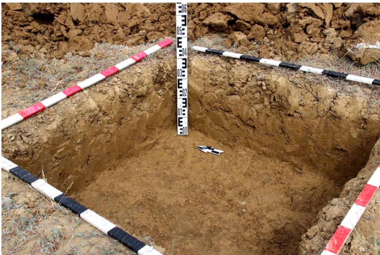
Рис. 143. Республика Дагестан. Объект «Проектирование и строительство напорной нитки D 1400 мм от ГКНС-6 г. Махачкалы до канализационных очистных сооружений г. Каспийска протяжённостью 16,0 км и производительностью 300 тыс. куб. м. в сутки». Зачистка шурфа 16 на уровне материкового тугопластичного суглинка светло-коричневого оттенка. Стратиграфия профиля южного борта шурфа. Вид с юго-запада.
