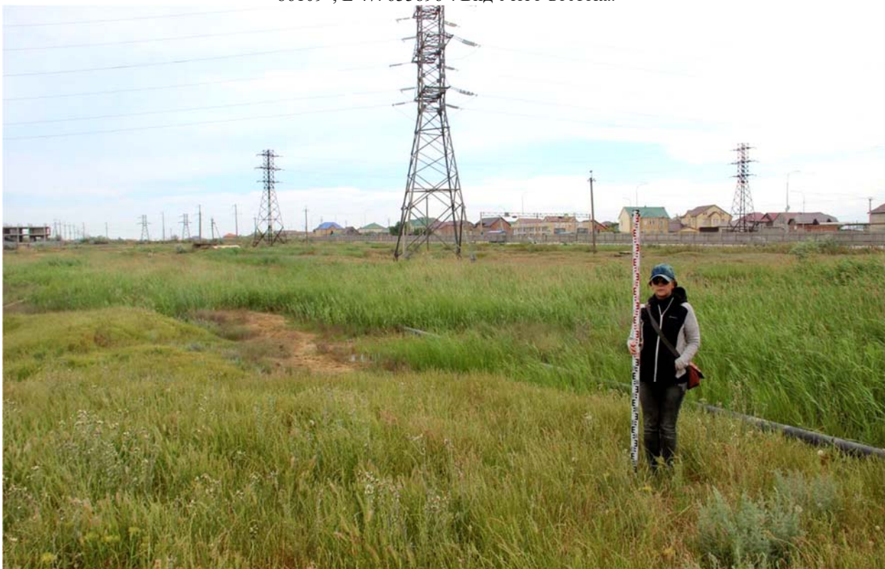
Рис. 21. Республика Дагестан. Объект «Проектирование и строительство напорной нитки D 1400 мм от ГКНС-6 г. Махачкалы до канализационных очистных сооружений г. Каспийска протяжённостью 16,0 км и производительностью 300 тыс. куб. м. в сутки». Трасса обследования. Точка фиксации №10 (WGS-84) N 42. 86474°; E 47. 62948°. Вид с северо-запада.
