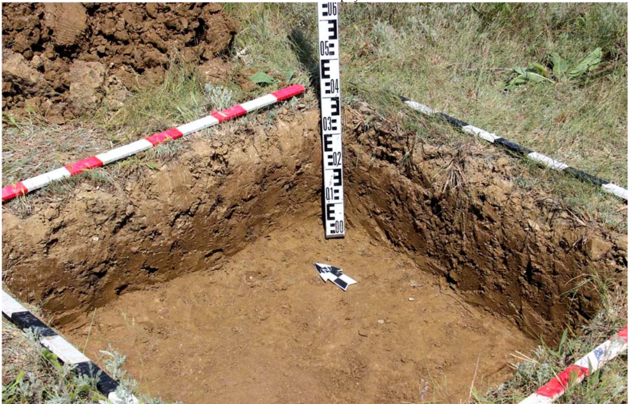
Рис. 138. Республика Дагестан. Объект «Проектирование и строительство напорной нитки D 1400 мм от ГКНС-6 г. Махачкалы до канализационных очистных сооружений г. Каспийска протяжённостью 16,0 км и производительностью 300 тыс. куб. м. в сутки». Зачистка шурфа 15 на уровне материкового туго-пластичного суглинка светло-коричневого оттенка. Стратиграфия профиля северного и восточного бортов шурфа. Вид с юго-запада.
