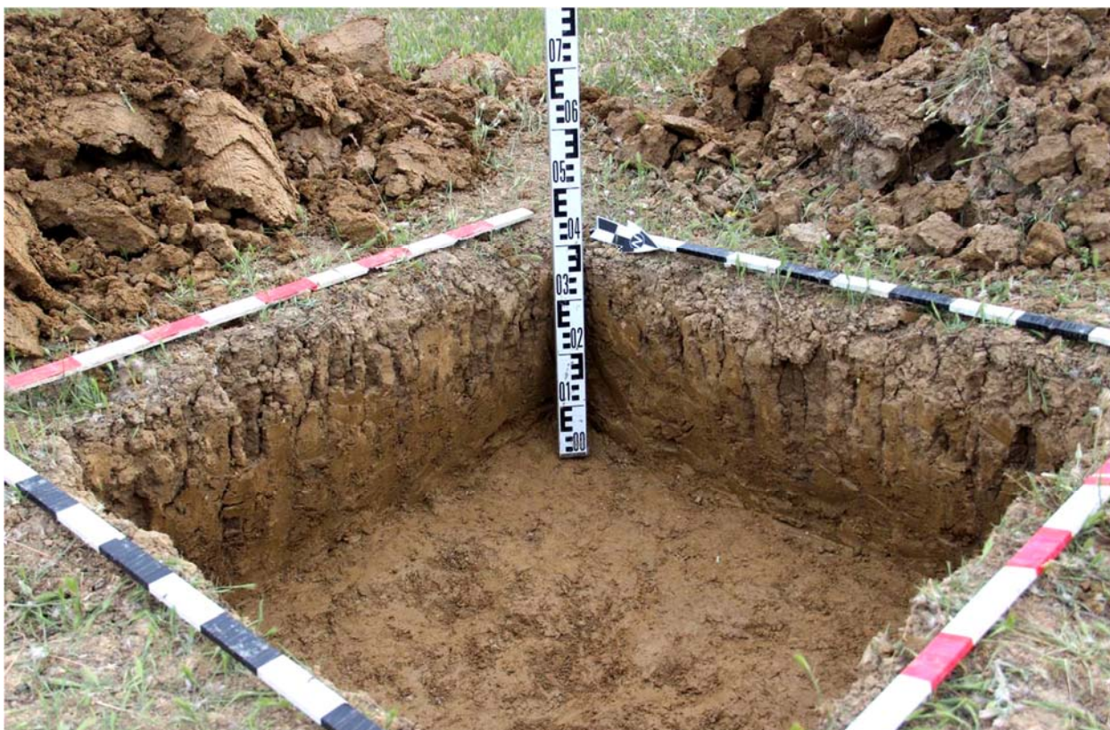
Рис. 133. Республика Дагестан. Объект «Проектирование и строительство напорной нитки D 1400 мм от ГКНС-6 г. Махачкалы до канализационных очистных сооружений г. Каспийска протяжённостью 16,0 км и производительностью 300 тыс. куб. м. в сутки». Зачистка шурфа 14 на уровне материкового тугопластичного суглинка светло-коричневого оттенка. Стратиграфия профиля южного борта шурфа. Вид с севера.
