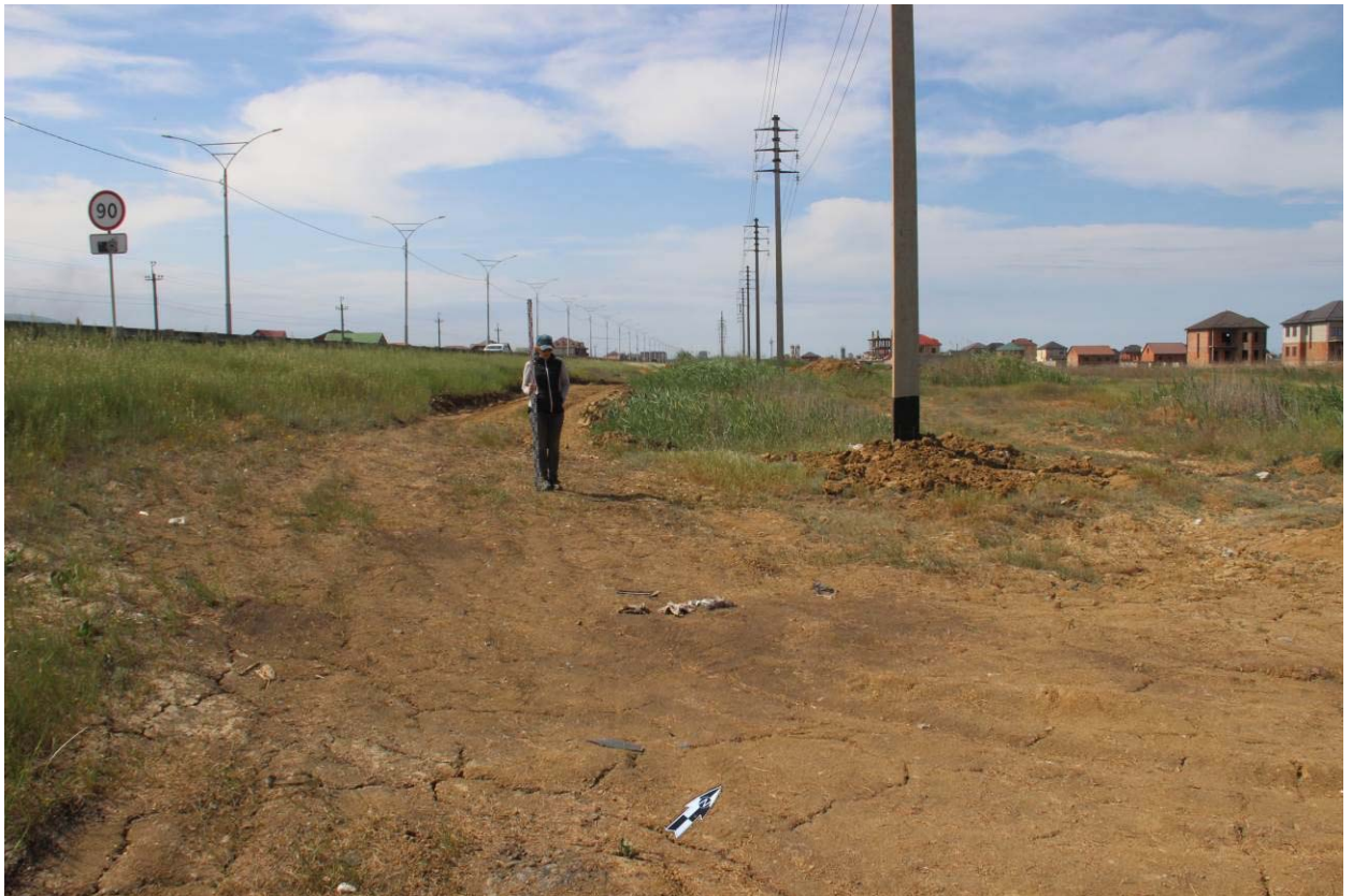
Рис. 46 Республика Дагестан. Объект «Проектирование и строительство напорной нитки D 1400 мм от ГКНС-6 г. Махачкалы до канализационных очистных сооружений г. Каспийска протяжённостью 16,0 км и производительностью 300 тыс. куб. м. в сутки». Трасса обследования. Точка фиксации №23 (WGS-84) N 42. 91382°; E 47. 58910°. Вид с юго-востока.
