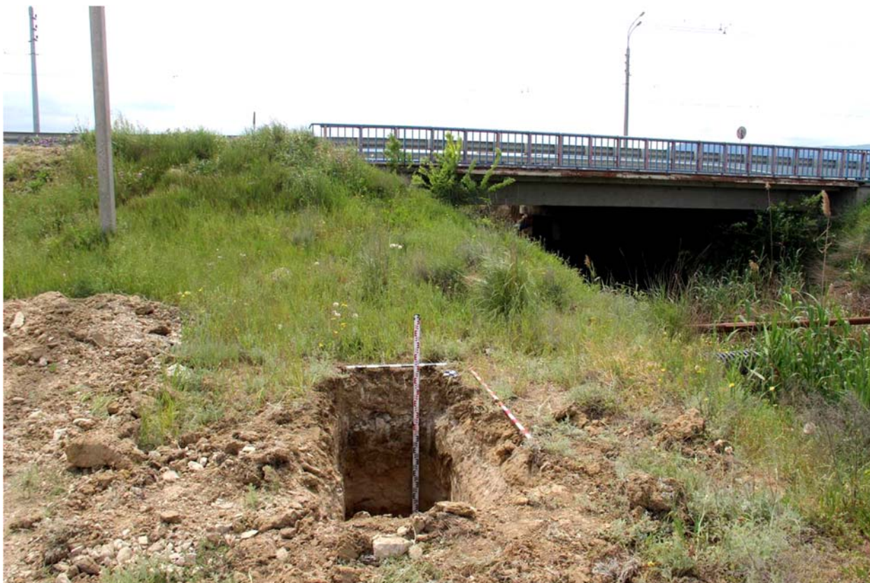
Рис. 147. Республика Дагестан. Объект «Проектирование и строительство напорной нитки D 1400 мм от ГКНС-6 г. Махачкалы до канализационных очистных сооружений г. Каспийска протяжённостью 16,0 км и производительностью 300 тыс. куб. м. в сутки». Шурф 17 до начала земляных работ. Вид с востока.
