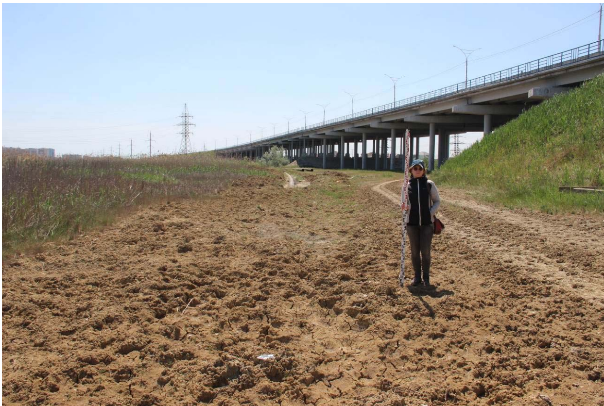
Рис. 38. Республика Дагестан. Объект «Проектирование и строительство напорной нитки D 1400 мм от ГКНС-6 г. Махачкалы до канализационных очистных сооружений г. Каспийска протяжённостью 16,0 км и производительностью 300 тыс. куб. м. в сутки». Трасса обследования. Точка фиксации №20 (WGS-84) N 42. 894135°; E 47. 595701°. Вид на мостовой переход и плавни под ним с запада.
