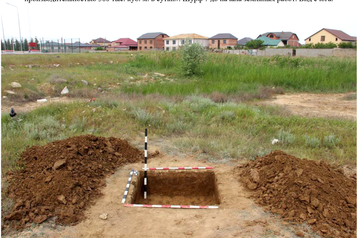
Рис. 98. Республика Дагестан. Объект «Проектирование и строительство напорной нитки D 1400 мм от ГКНС-6 г. Махачкалы до канализационных очистных сооружений г. Каспийска протяжённостью 16,0 км и производительностью 300 тыс. куб. м. в сутки». Шурф 7 после окончания земляных работ. Вид с юга.
