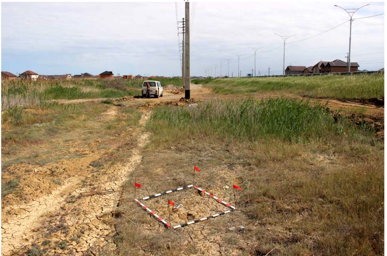
Рис. 140. Республика Дагестан. Объект «Проектирование и строительство напорной нитки D 1400 мм от ГКНС-6 г. Махачкалы до канализационных очистных сооружений г. Каспийска протяжённостью 16,0 км и производительностью 300 тыс. куб. м. в сутки». Шурф 16 до начала земляных работ. Вид с северо-запада.
