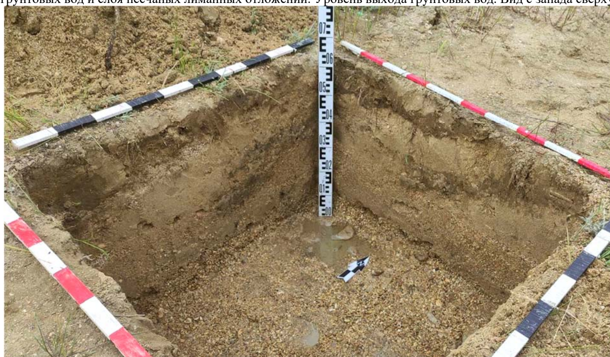
Рис. 154. Республика Дагестан. Объект «Проектирование и строительство напорной нитки D 1400 мм от ГКНС-6 г. Махачкалы до канализационных очистных сооружений г. Каспийска протяжённостью 16,0 км и производительностью 300 тыс. куб. м. в сутки». Зачистка шурфа 18 на уровне песчаных лиманных отложений. Стратиграфия профиля северного и западного бортов шурфа. Вид с юго-востока.
