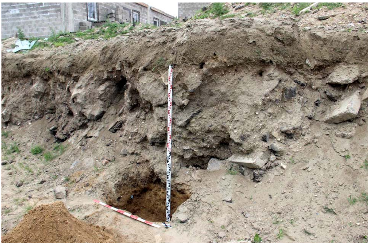
Рис. 66. Республика Дагестан. Объект «Проектирование и строительство напорной нитки D 1400 мм от ГКНС-6 г. Махачкалы до канализационных очистных сооружений г. Каспийска протяжённостью 16,0 км и производительностью 300 тыс. куб. м. в сутки». Шурф 1 после окончания земляных работ. Вид с северо-востока.
