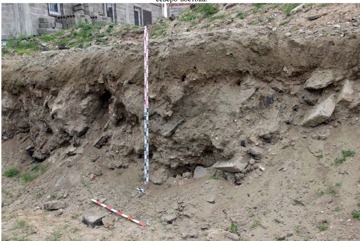
Рис. 65. Республика Дагестан. Объект «Проектирование и строительство напорной нитки D 1400 мм от ГКНС-6 г. Махачкалы до канализационных очистных сооружений г. Каспийска протяжённостью 16,0 км и производительностью 300 тыс. куб. м. в сутки». Шурф 1 до начала земляных работ. Вид с северо-востока.
