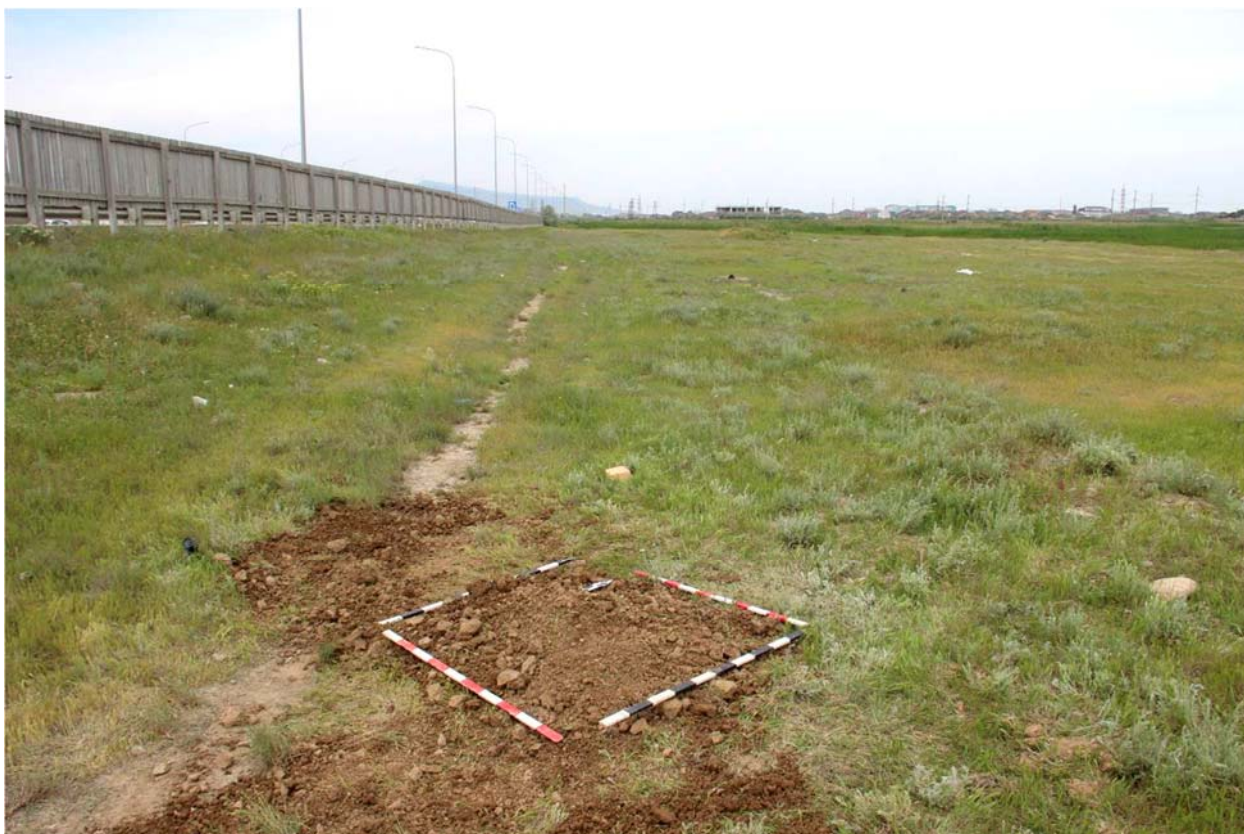
Рис. 91. Республика Дагестан. Объект «Проектирование и строительство напорной нитки D 1400 мм от ГКНС-6 г. Махачкалы до канализационных очистных сооружений г. Каспийска протяжённостью 16,0 км и производительностью 300 тыс. куб. м. в сутки». Шурф 5 после проведения земляных работ. Рекультивация. Вид с юго-востока.
