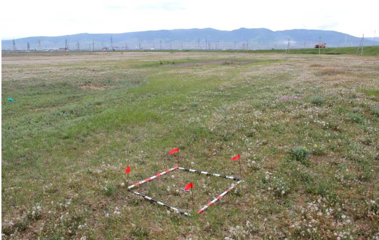
Рис. 130. Республика Дагестан. Объект «Проектирование и строительство напорной нитки D 1400 мм от ГКНС-6 г. Махачкалы до канализационных очистных сооружений г. Каспийска протяжённостью 16,0 км и производительностью 300 тыс. куб. м. в сутки». Шурф 14 до начала земляных работ. Вид с северо-востока.
