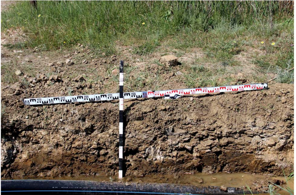
Рис. 103. Республика Дагестан. Объект «Проектирование и строительство напорной нитки D 1400 мм от ГКНС-6 г. Махачкалы до канализационных очистных сооружений г. Каспийска протяжённостью 16,0 км и производительностью 300 тыс. куб. м. в сутки». Шурф 8 после окончания земляных работ. Вид с востока.
