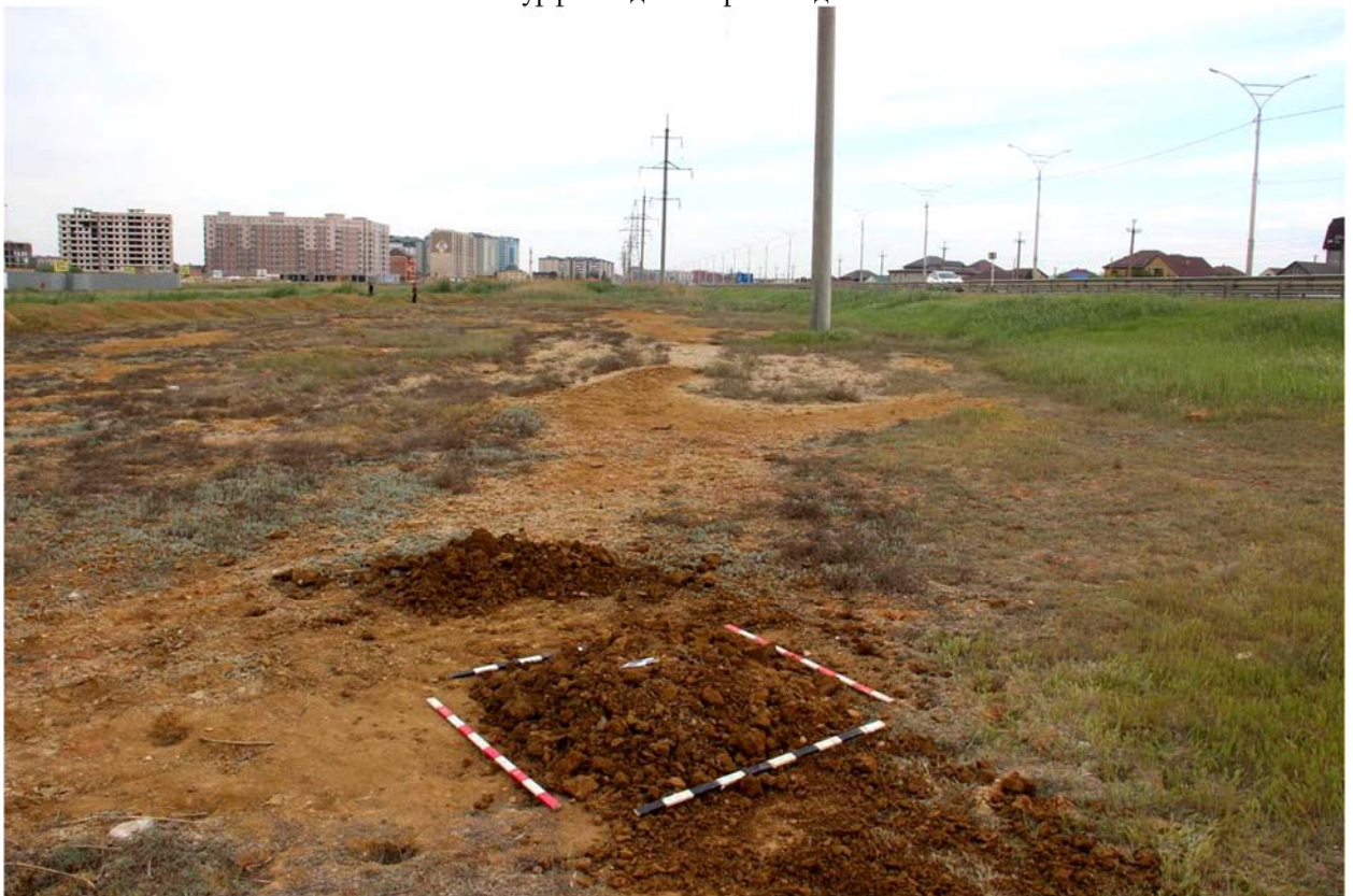
Рис. 119. Республика Дагестан. Объект «Проектирование и строительство напорной нитки D 1400 мм от ГКНС-6 г. Махачкалы до канализационных очистных сооружений г. Каспийска протяжённостью 16,0 км и производительностью 300 тыс. куб. м. в сутки». Шурф 11 после проведения земляных работ. Рекультивация. Вид с северо-запада.
