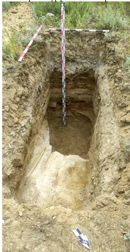
Рис. 150. Республика Дагестан. Объект «Проектирование и строительство напорной нитки D 1400 мм от ГКНС-6 г. Махачкалы до канализационных очистных сооружений г. Каспийска протяжённостью 16,0 км и производительностью 300 тыс. куб. м. в сутки». Шурф 17 после проведения земляных работ. Рекультивация. Вид с севера.
