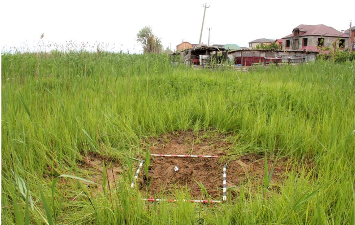
Рис. 160. Республика Дагестан. Объект «Проектирование и строительство напорной нитки D 1400 мм от ГКНС-6 г. Махачкалы до канализационных очистных сооружений г. Каспийска протяжённостью 16,0 км и производительностью 300 тыс. куб. м. в сутки». Шурф 19 после проведения земляных работ. Рекультивация. Вид с севера.
