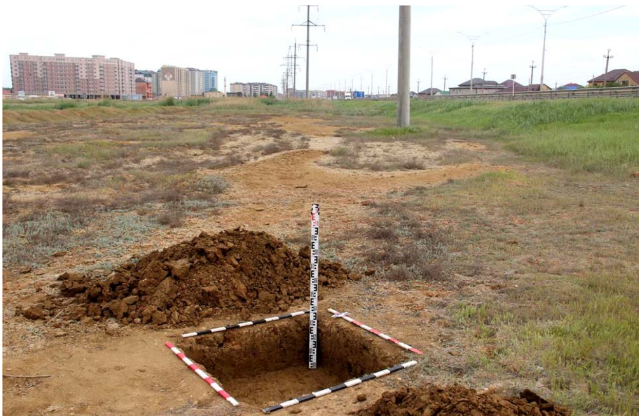
Рис. 116. Республика Дагестан. Объект «Проектирование и строительство напорной нитки D 1400 мм от ГКНС-6 г. Махачкалы до канализационных очистных сооружений г. Каспийска протяжённостью 16,0 км и производительностью 300 тыс. куб. м. в сутки». Шурф 11 после окончания земляных работ. Вид с северо-запада.
