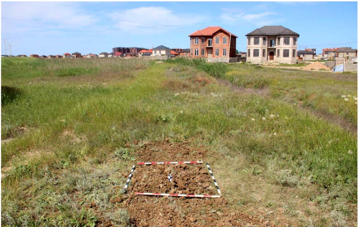
Рис. 139. Республика Дагестан. Объект «Проектирование и строительство напорной нитки D 1400 мм от ГКНС-6 г. Махачкалы до канализационных очистных сооружений г. Каспийска протяжённостью 16,0 км и производительностью 300 тыс. куб. м. в сутки». Шурф 15 после проведения земляных работ. Рекультивация. Вид с юга.
