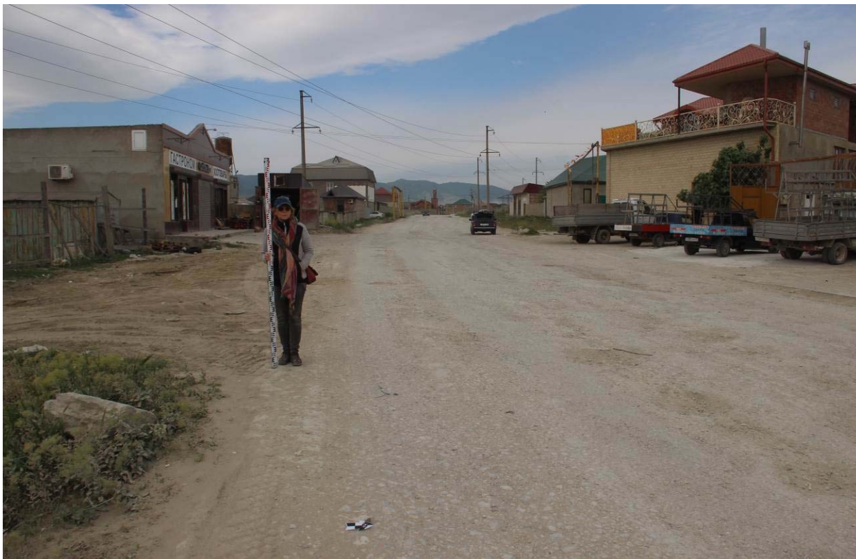
Рис. 14. Республика Дагестан Объект «Проектирование и строительство напорной нитки D 1400 мм от ГКНС-6 г. Махачкалы до канализационных очистных сооружений г. Каспийска протяжённостью 16,0 км и производительностью 300 тыс. куб. м. в сутки». Трасса обследования. Точка фиксации №6 (WGS-84) N 42. 85747°; E 47. 64956°. Улица Маячная 133. Вид с востока.
