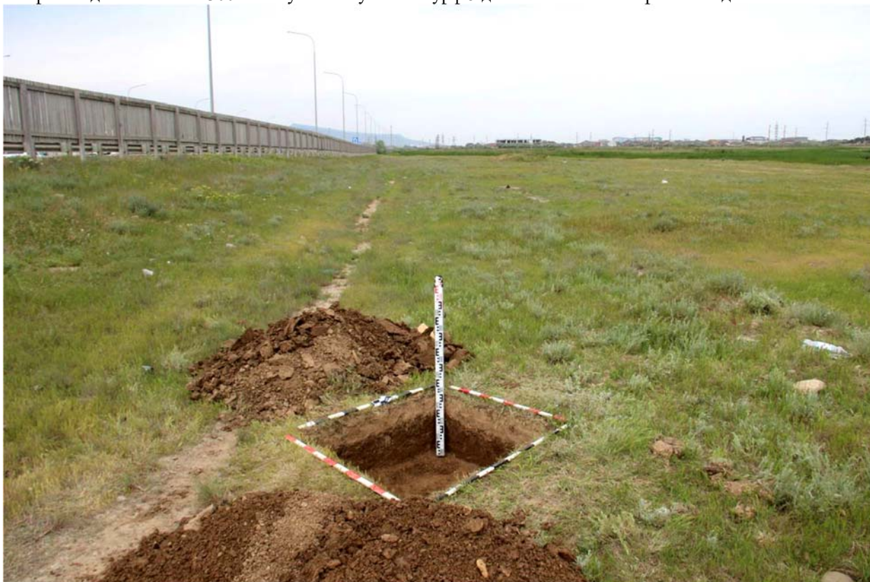
Рис. 88. Республика Дагестан. Объект «Проектирование и строительство напорной нитки D 1400 мм от ГКНС-6 г. Махачкалы до канализационных очистных сооружений г. Каспийска протяжённостью 16,0 км и производительностью 300 тыс. куб. м. в сутки». Шурф 5 после окончания земляных работ. Вид с юго-востока.
