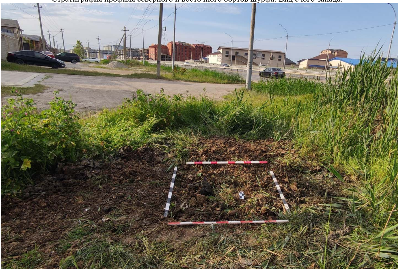
Рис.108. Республика Дагестан. Объект «Проектирование и строительство напорной нитки D 1400 мм от ГКНС-6 г. Махачкалы до канализационных очистных сооружений г. Каспийска протяжённостью 16,0 км и производительностью 300 тыс. куб. м. в сутки». Шурф 9 после проведения земляных работ. Рекультивация. Вид с юга.
