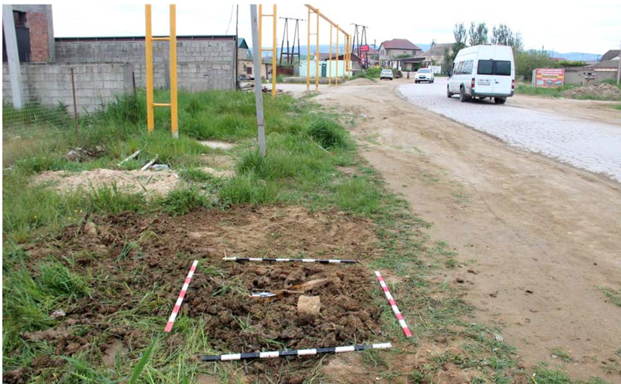
Рис. 80. Республика Дагестан. Объект «Проектирование и строительство напорной нитки D 1400 мм от ГКНС-6 г. Махачкалы до канализационных очистных сооружений г. Каспийска протяжённостью 16,0 км и производительностью 300 тыс. куб. м. в сутки». Шурф 3 после проведения земляных работ. Рекультивация. Вид с востока.
