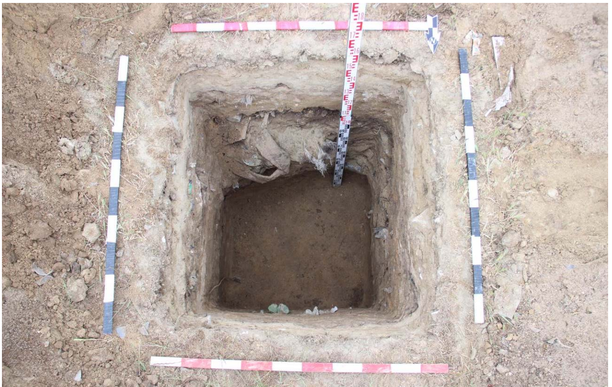
Рис. 72. Республика Дагестан. Объект «Проектирование и строительство напорной нитки D 1400 мм от ГКНС-6 г. Махачкалы до канализационных очистных сооружений г. Каспийска протяжённостью 16,0 км и производительностью 300 тыс. куб. м. в сутки». Шурф 2 после окончания земляных работ. Зачистка шурфа на уровне материкового опесчаненного суглинка. Вид с севера сверху.
