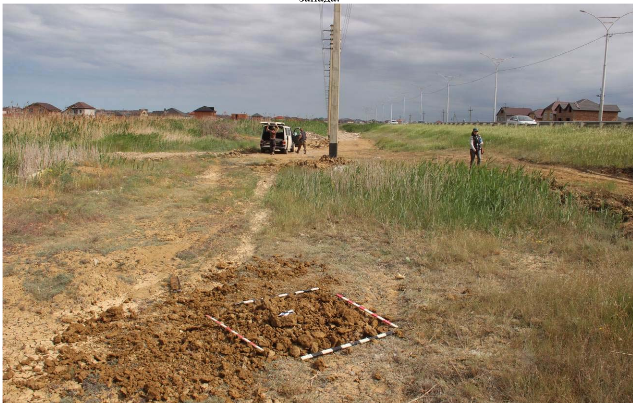
Рис. 144. Республика Дагестан. Объект «Проектирование и строительство напорной нитки D 1400 мм от ГКНС-6 г. Махачкалы до канализационных очистных сооружений г. Каспийска протяжённостью 16,0 км и производительностью 300 тыс. куб. м. в сутки». Шурф 16 после проведения земляных работ. Рекультивация. Вид с северо-запада.
