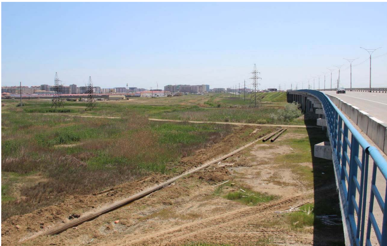
Рис. 40. Республика Дагестан. Объект «Проектирование и строительство напорной нитки D 1400 мм от ГКНС-6 г. Махачкалы до канализационных очистных сооружений г. Каспийска протяжённостью 16,0 км и производительностью 300 тыс. куб. м. в сутки». Трасса обследования. Точка фиксации (WGS-84) N 42. 894072°; E 47. 595325°. Вид на территорию шурфов 10 и 11 с мостового перехода с запада.
