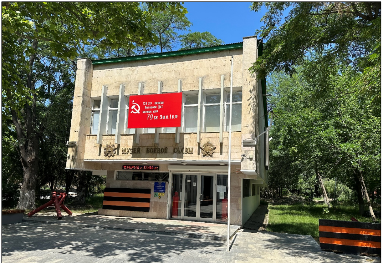
Фото 2. Главный фасад здания, вход в здание.
