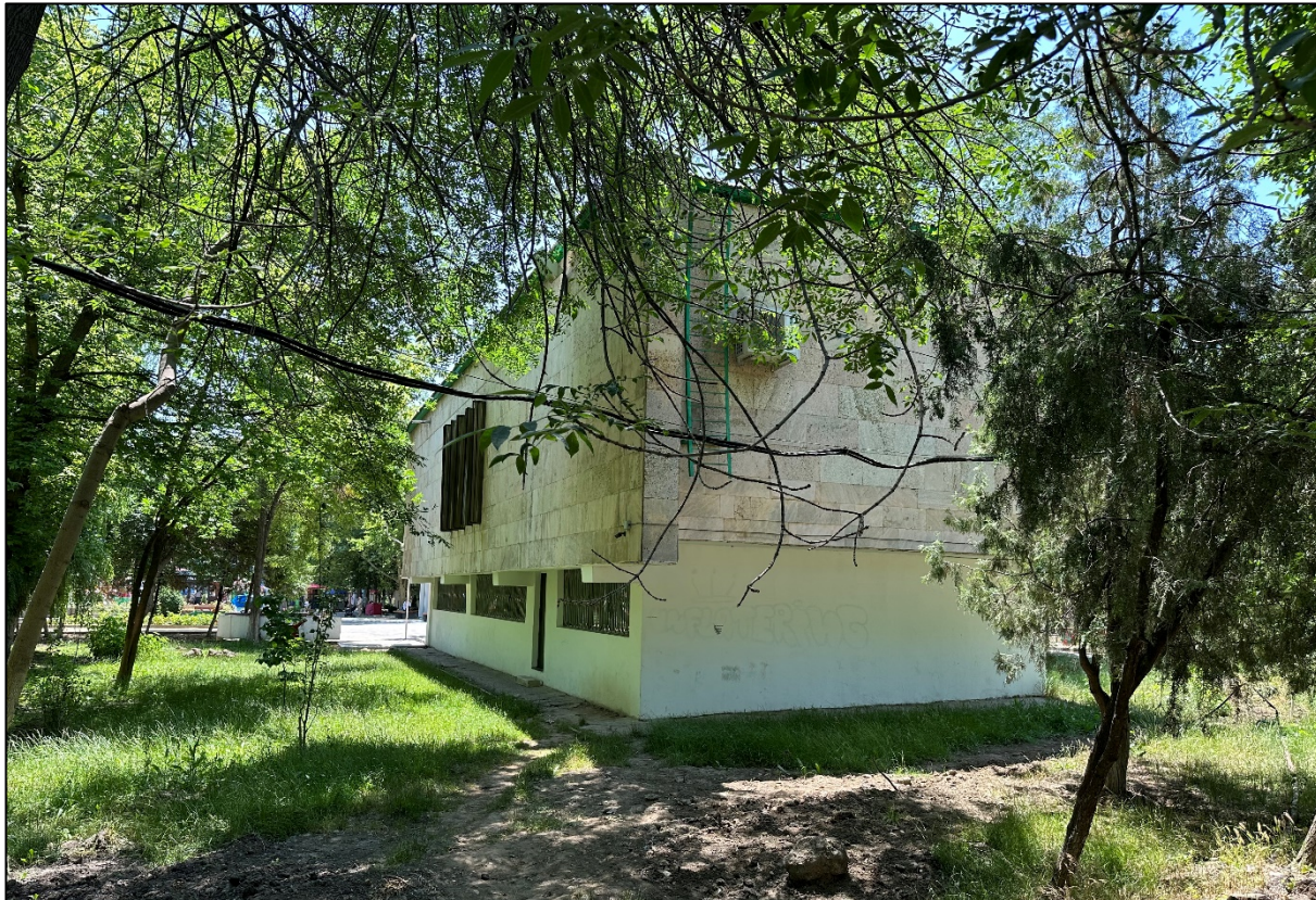
Фото 10. Тыльный фасад здания.
