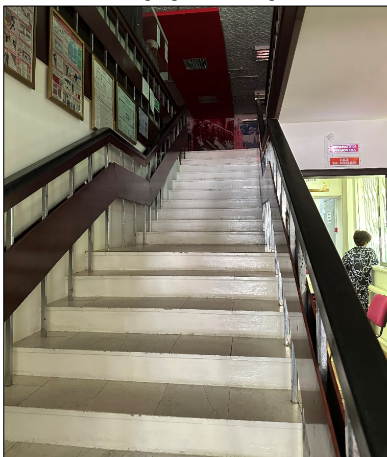
Фото 4. Лестница на второй этаж здания.
