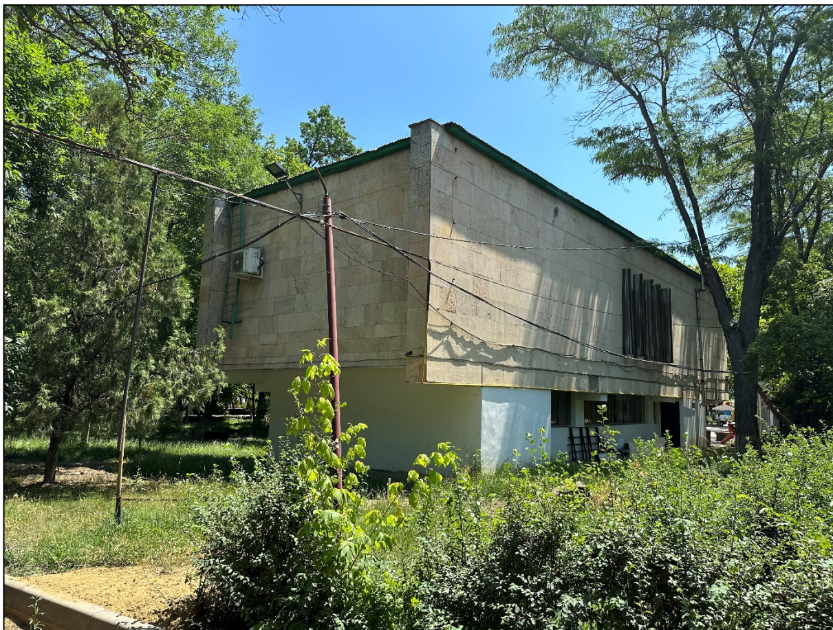
Фото 9. Тыльный фасад здания.
