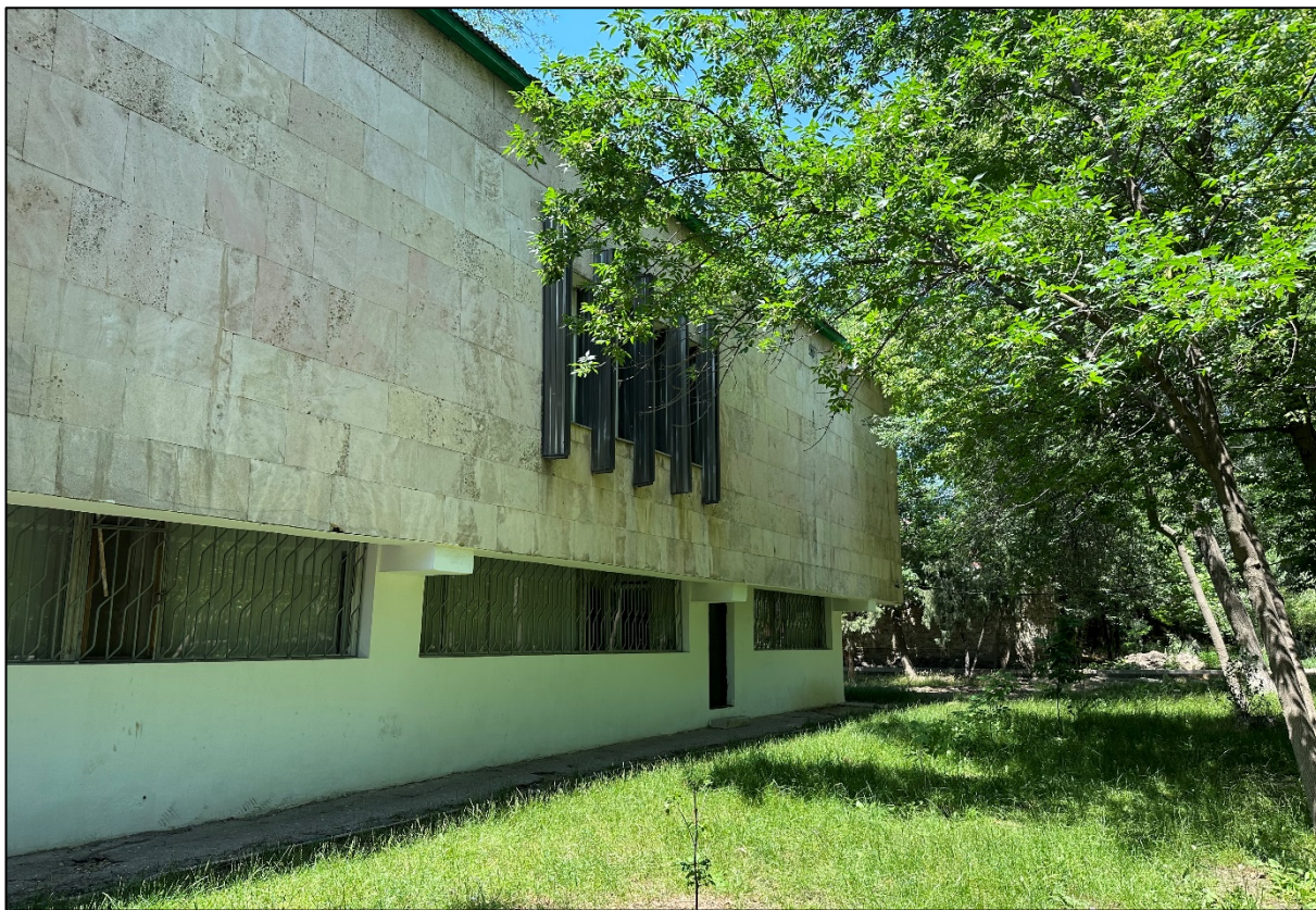
Фото 7. Боковой фасад здания, по правой стороне от главного входа.
