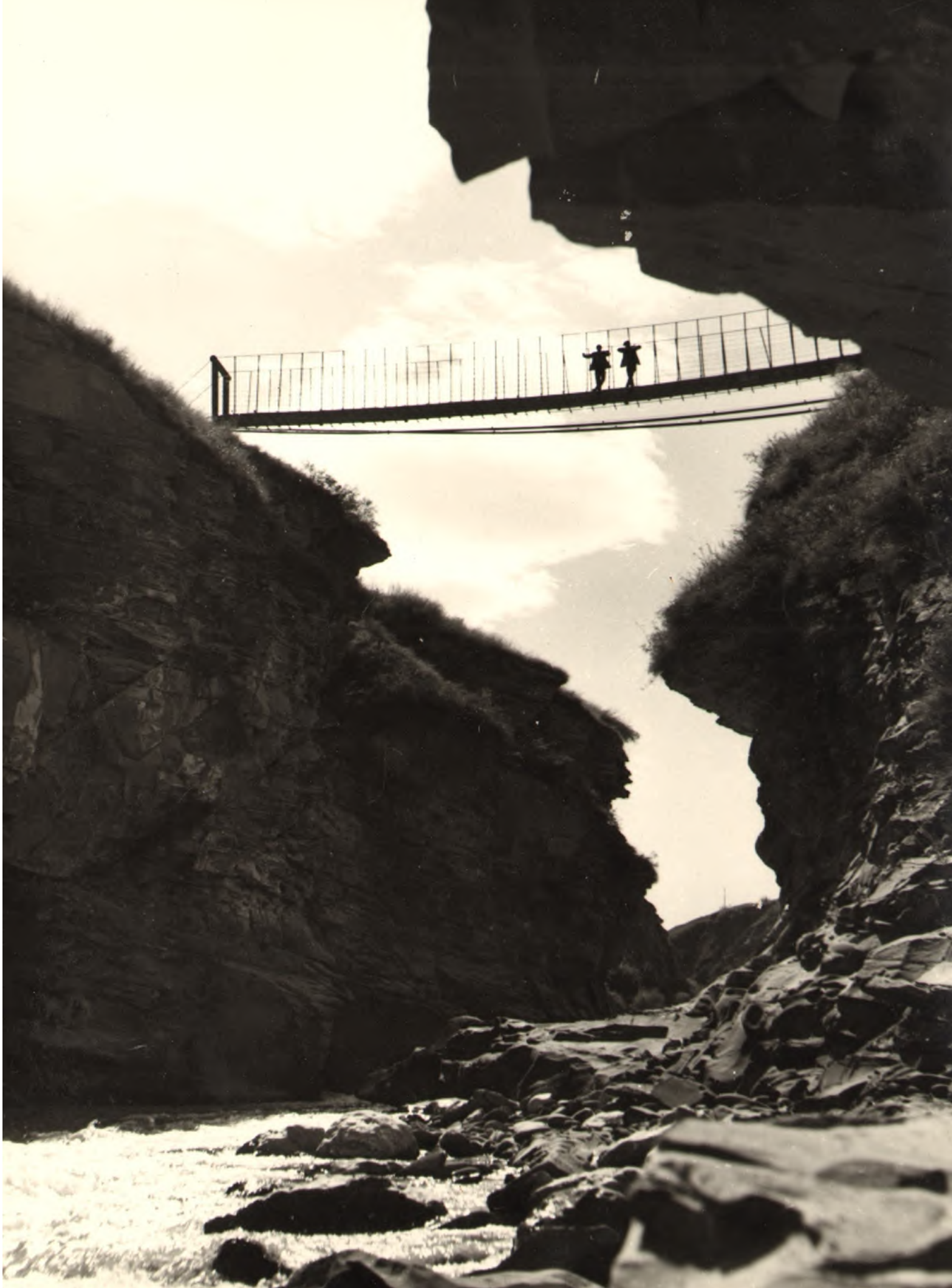
Фотография. Канатный мост через реку Кази-Кумухское Койсу. 1970 год // НМ РД КП-18762/14
