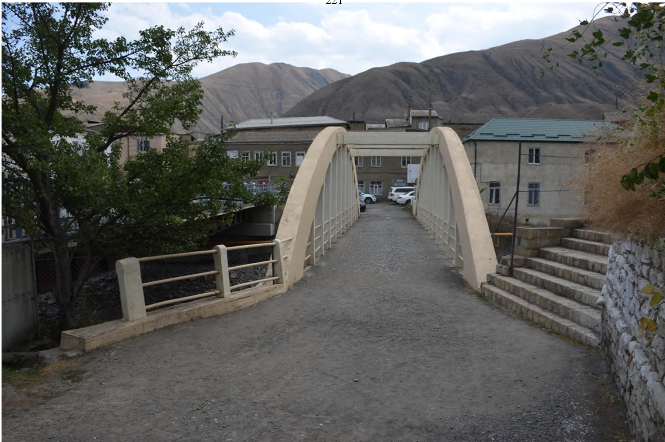
Мост инженеров Джиорса и Дебернардн, расположенный в с. Ахты Ахтынского района Республики Дагестан. Фото Агафоновой И.С. 04.09.2022 года.
