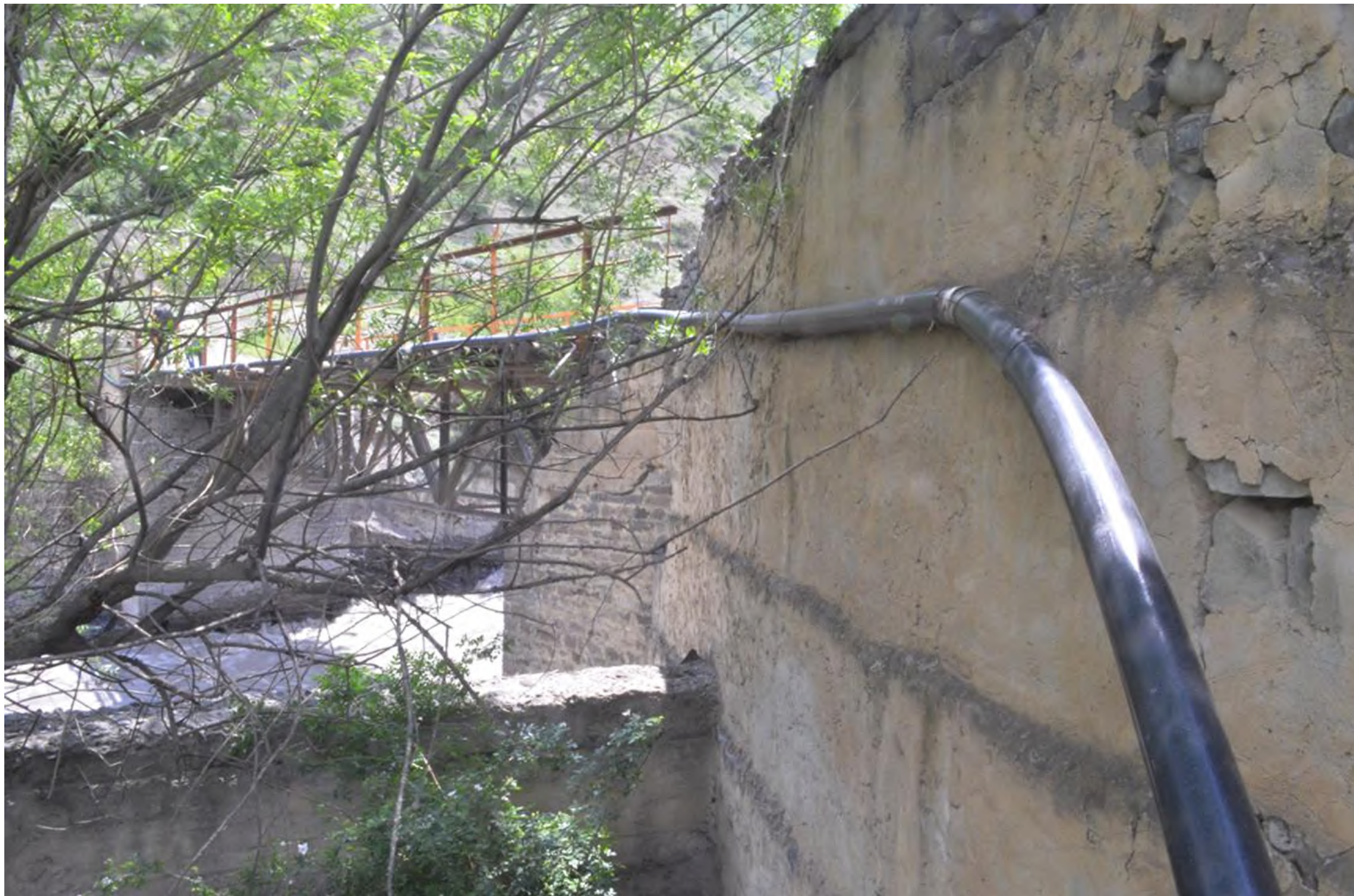
Мост, расположенный по адресу: Республика Дагестан, Ахтынский район, с. Ахты, 2,5 км к западу от села. Фото: 2018 год.
