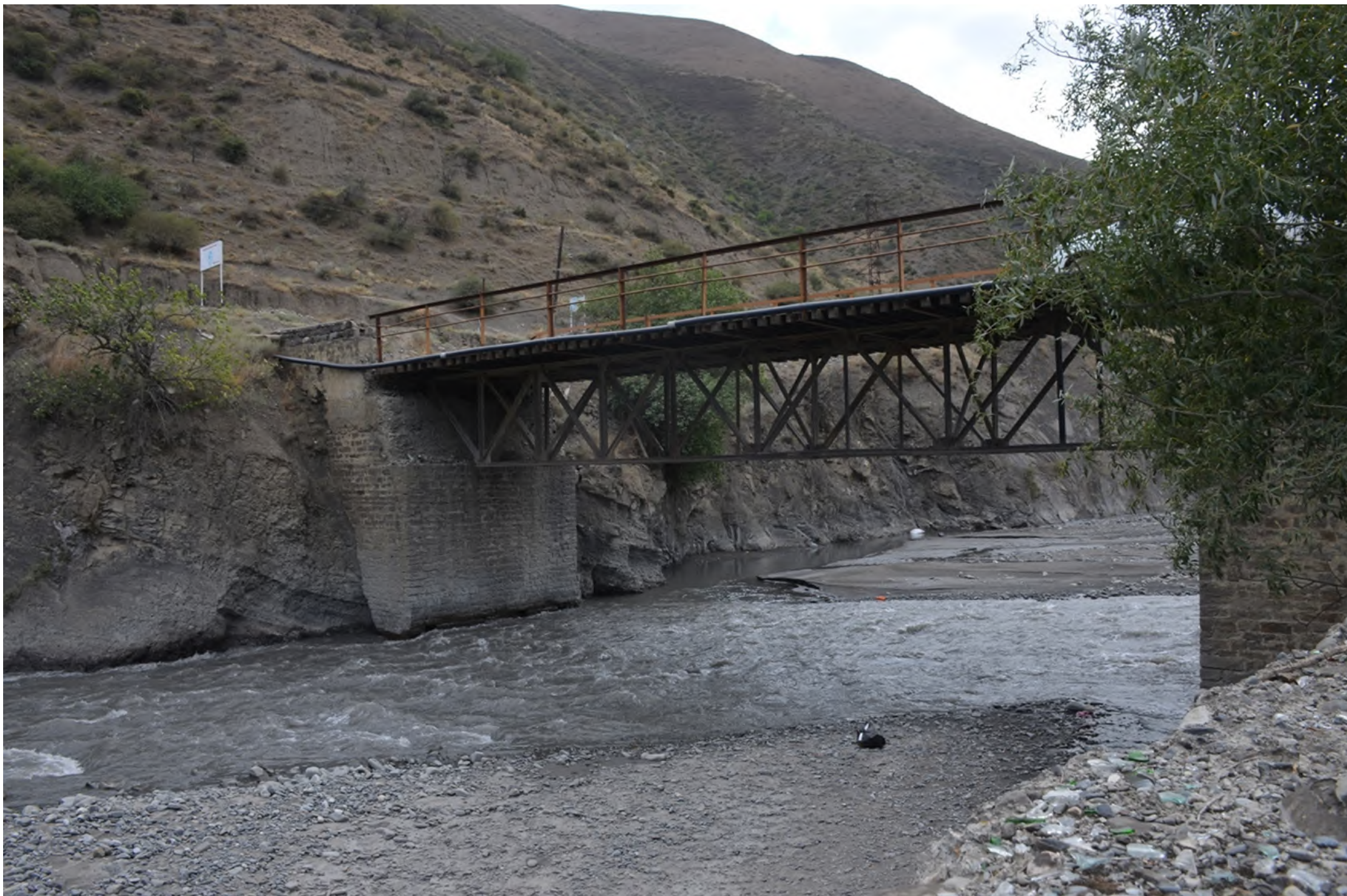
Мост, расположенный по адресу: Республика Дагестан, Ахтынский район, с. Ахты, 2,5 км к западу от села. Фото Агафоновой И.С. 04.09.2022 года.
