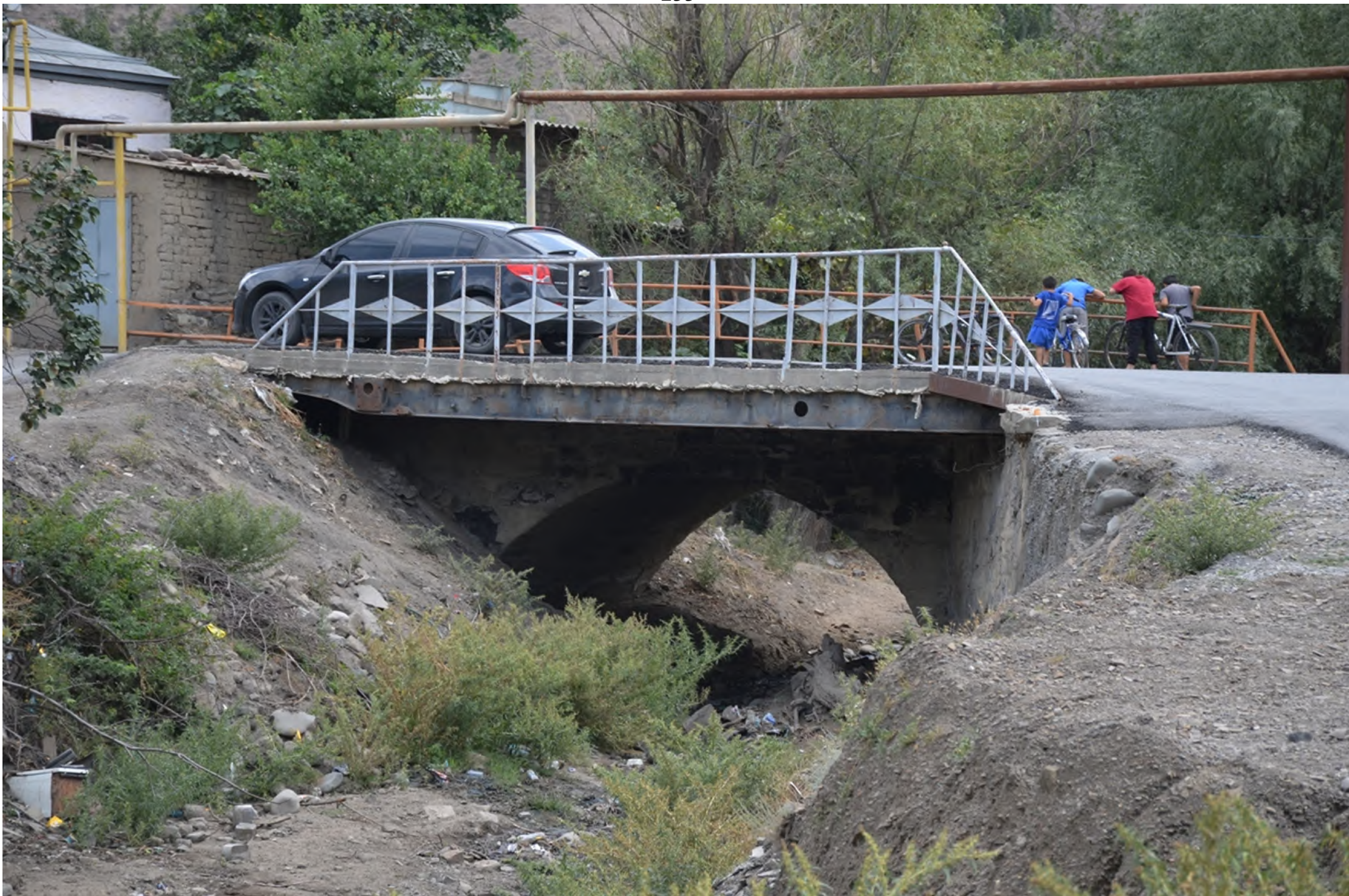
Мост, расположенный в с. Ахты Ахтынского района Республики Дагестан. Фото Агафоновой И.С. 04.09.2022 года.
