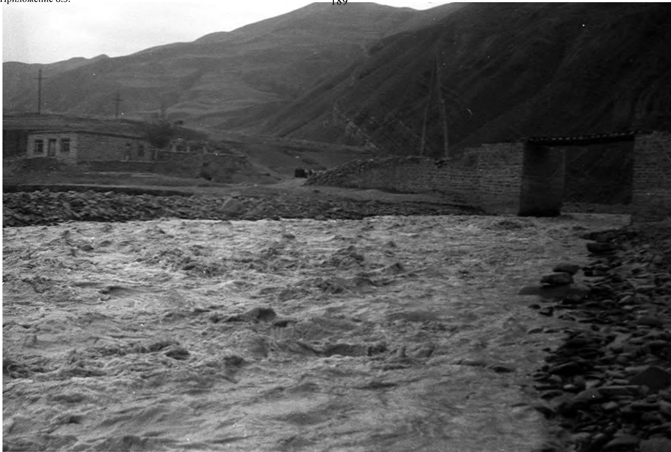
Негатив. Дагестан. Строящийся мост. 1962 год // РЭМ 9177/29
