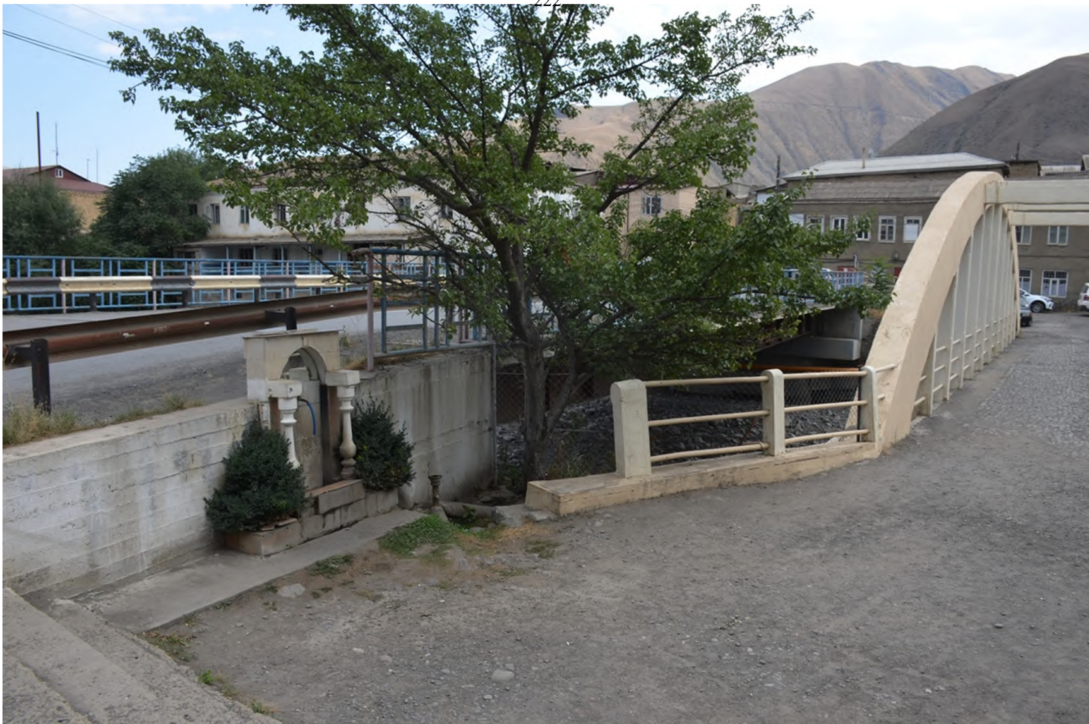
Мост инженеров Джиорса и Дебернади, расположенный в с. Ахты Ахтынского района Республики Дагестан. Фото Агафоновой И.С. 04.09.2022 года.
