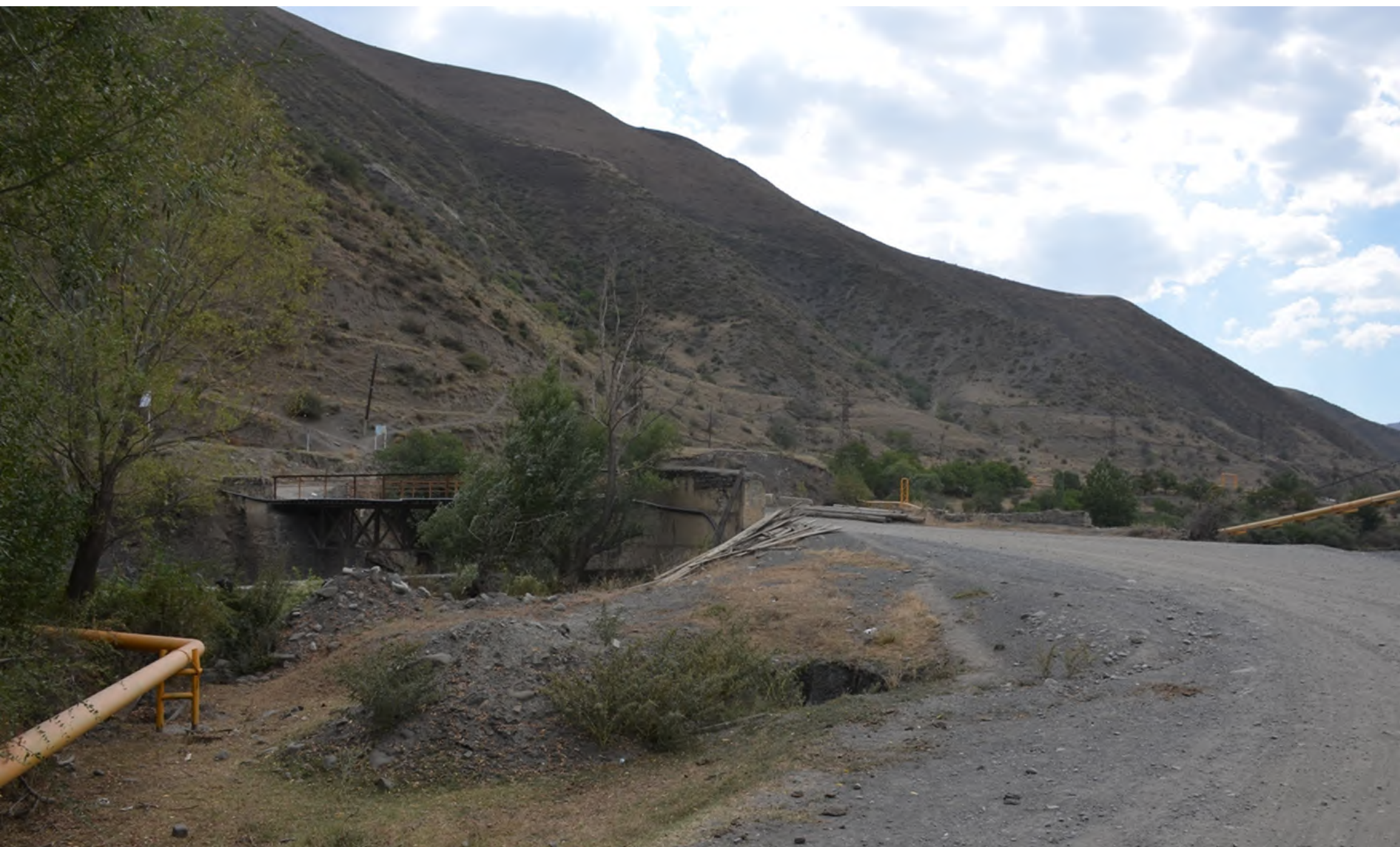
Мост, расположенный по адресу: Республика Дагестан, Ахтынский район, с. Ахты, 2,5 км к западу от села. Фото Агафоновой И.С. 04.09.2022 года.
