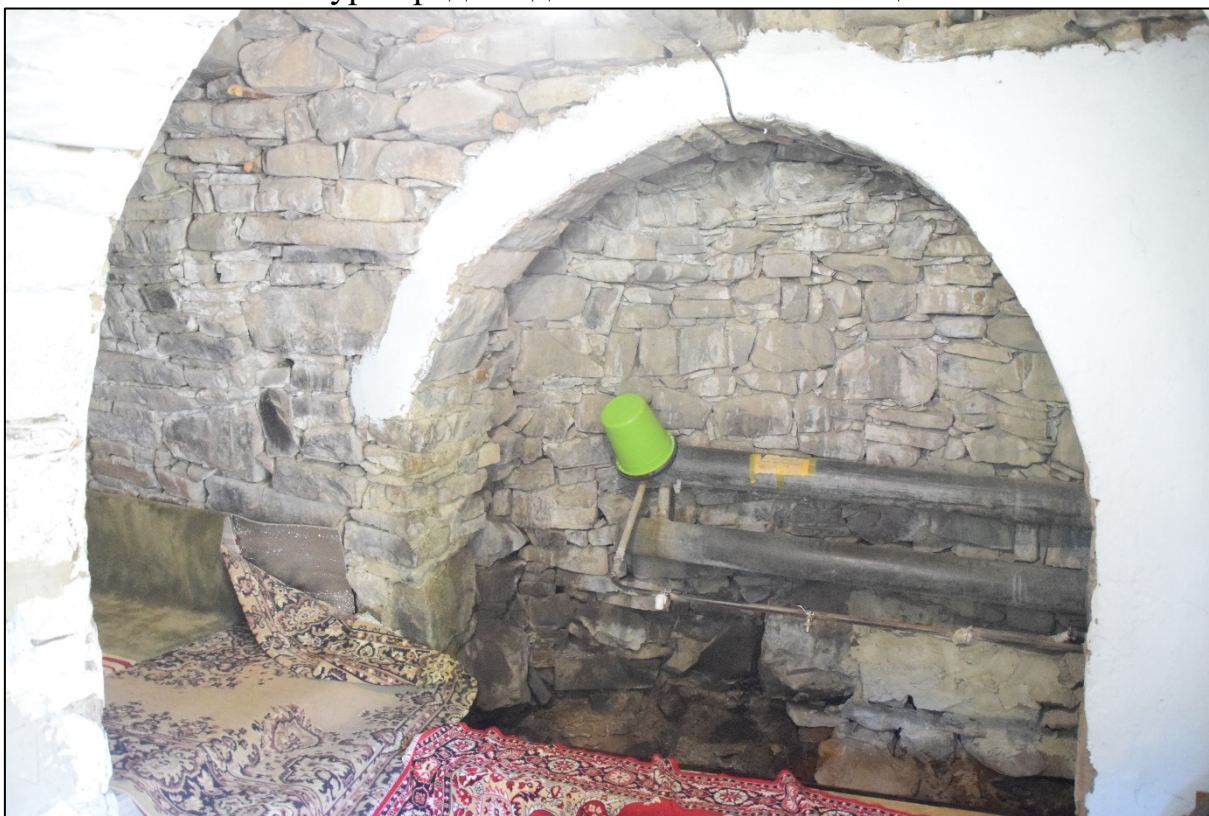
Фото 8. Вид на помещение для омовения с арочным проемом.
