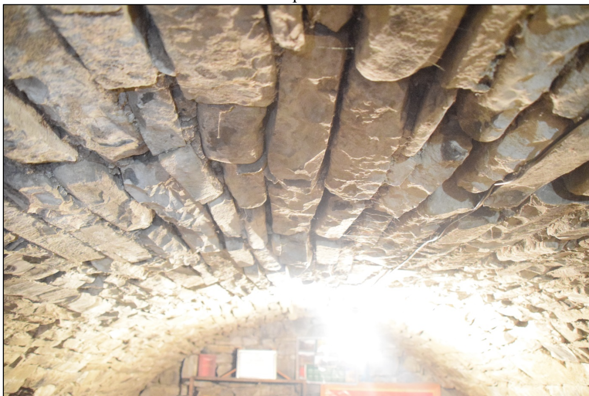
Фото 19. Вид на кладку цилиндрического свода мечети, камень скальный, фактически необтесанный, подогнанный друг к другу.
