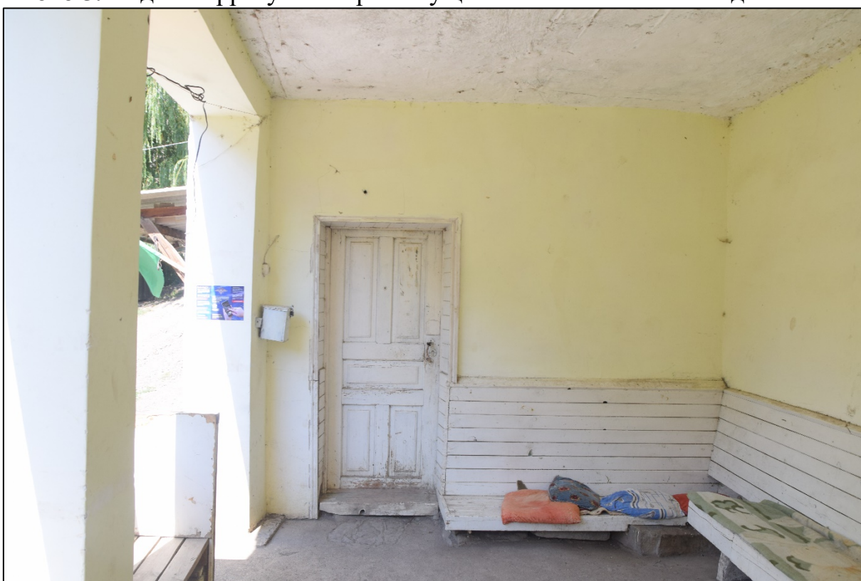
Фото 6. Вид на главный вход в мечеть со стороны террасы.
