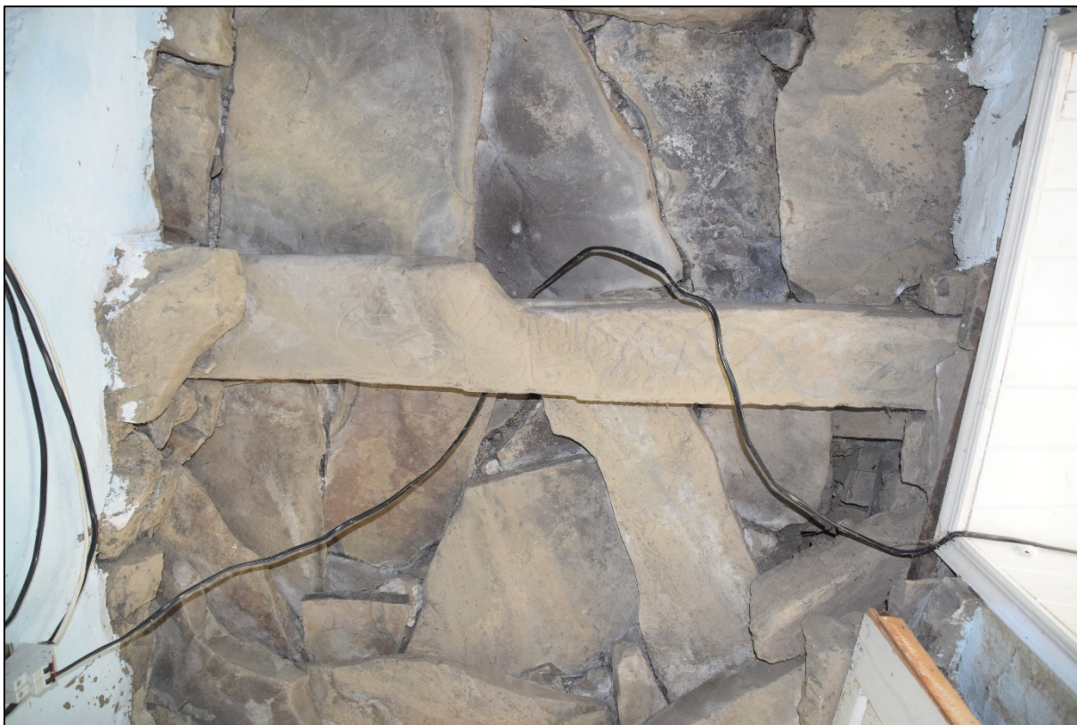
Фото 16. Каменная резная балка перекрытия над помещением для омовения. На балке выполнена резьба плетеного орнамента.
