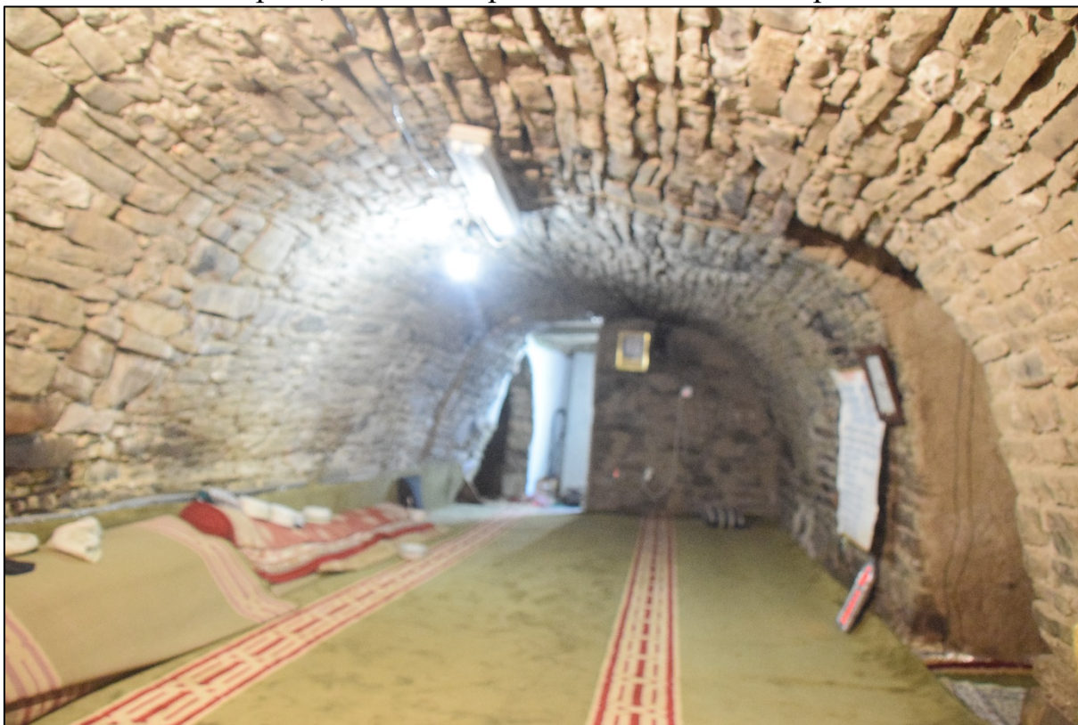
Фото 13. Общий вид на молельный зал в сторону выхода.
