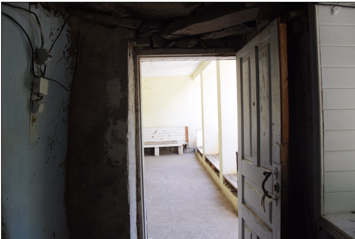
Фото 7. Тамбур перед входом в основные помещения мечети.
