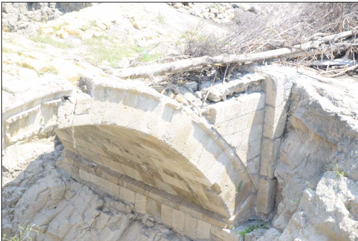
Фото 7. Вид на кладку моста, арка и часть сохранившегося более позднего ограждения.
