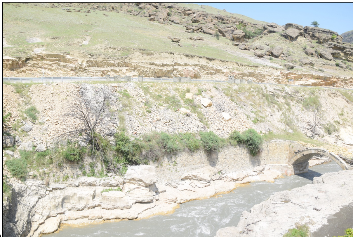
Фото 8. Вид на подпорную стену берегоукрепления на левом берегу реки Аварское Койсу.
