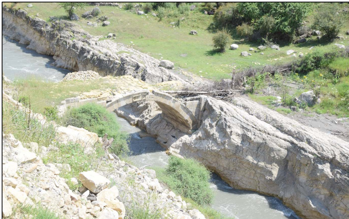
Фото 1. Общий вид моста с левого берега реки Аварское Койсу.
