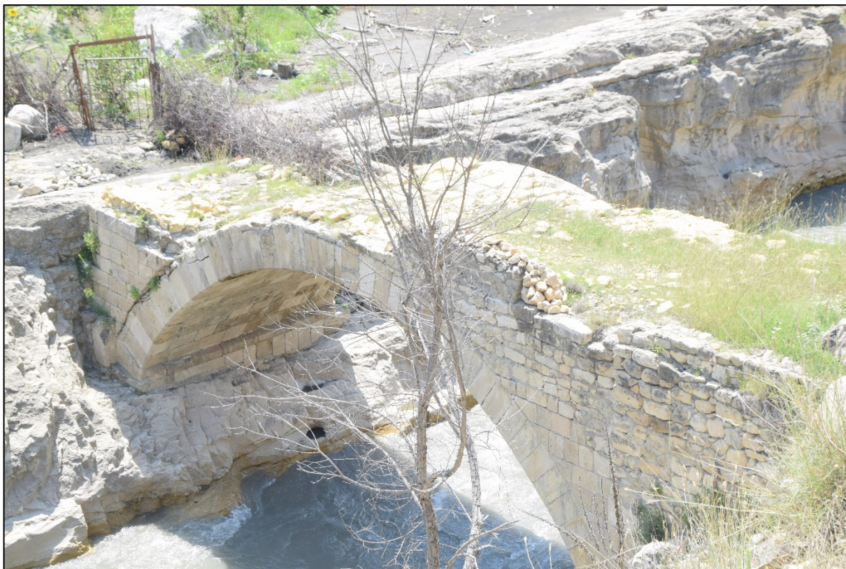
Фото 5. Вид на арку моста, ограждение не сохранилось, пята арки упирается в скалистый берег.
