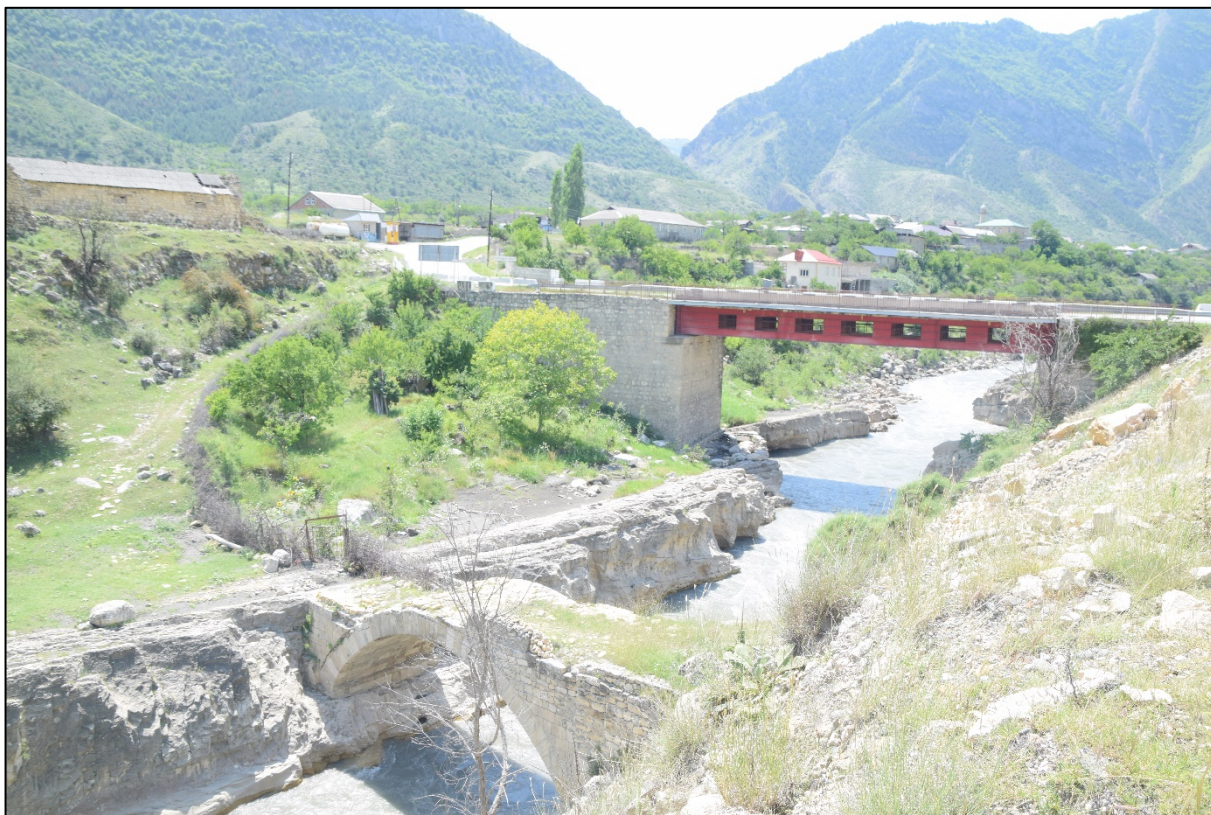
Фото 4. Общий вид на исследуемый объект с левого берега реки Аварско-Койсу, на заднем плане виден новый действующий мост через реку.
