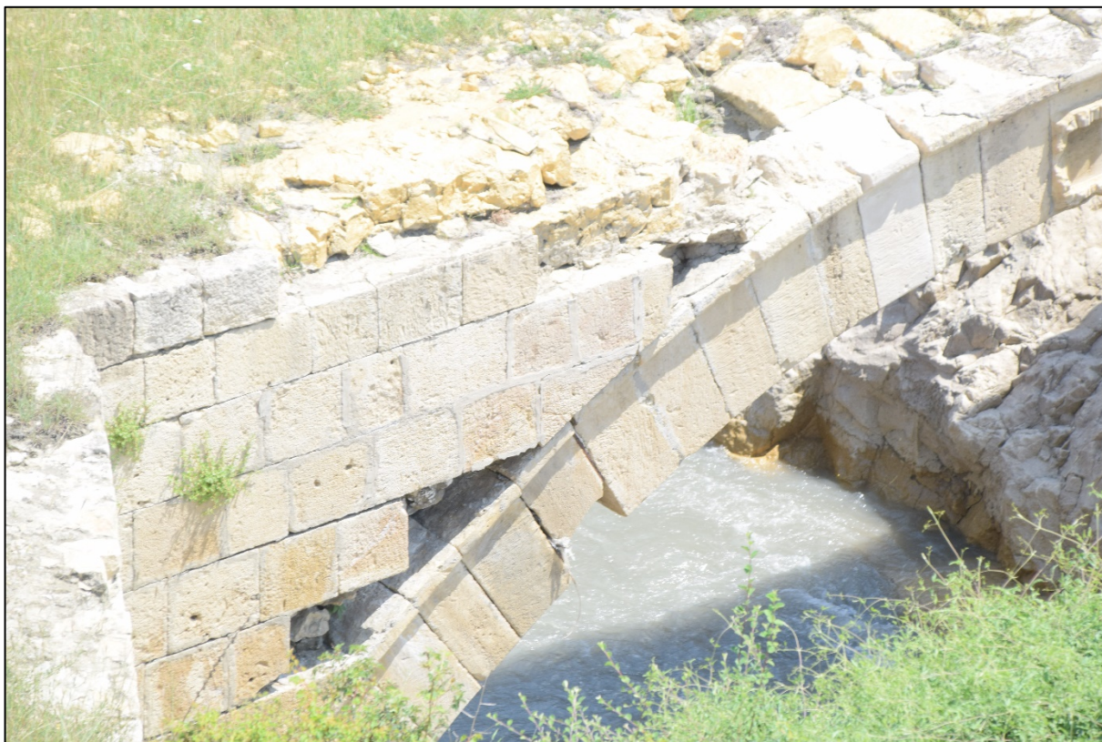
Фото 6. Вид на кладку моста, арка и часть сохранившегося тесаного каменного ограждения моста.
