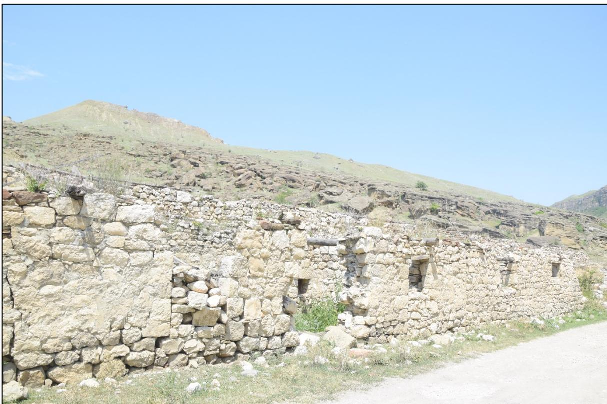
**Фото 20.** Вид на вход в хозяйственный блок с южной стороны, обрушение части несущей стены, проемов и конструкций.
