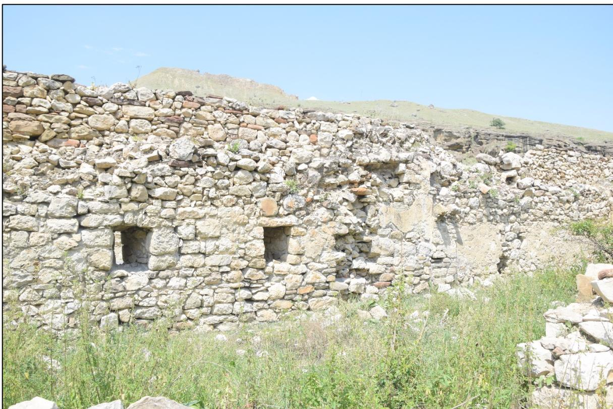
**Фото 23.** Вид на хозяйственный блок внутри помещений, следы значительной деформации несущих конструкций здания.
