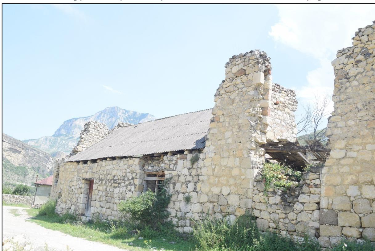
**Фото 16.** Часть несущих стен в высотности двух этажей, административный блок с поздней крышей и проемами.
