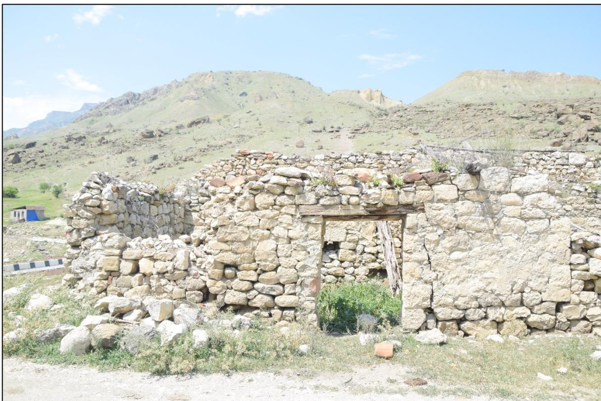
**Фото 19.** Вид на вход в хозяйственный блок с южной стороны, обрушение части несущей стены.
