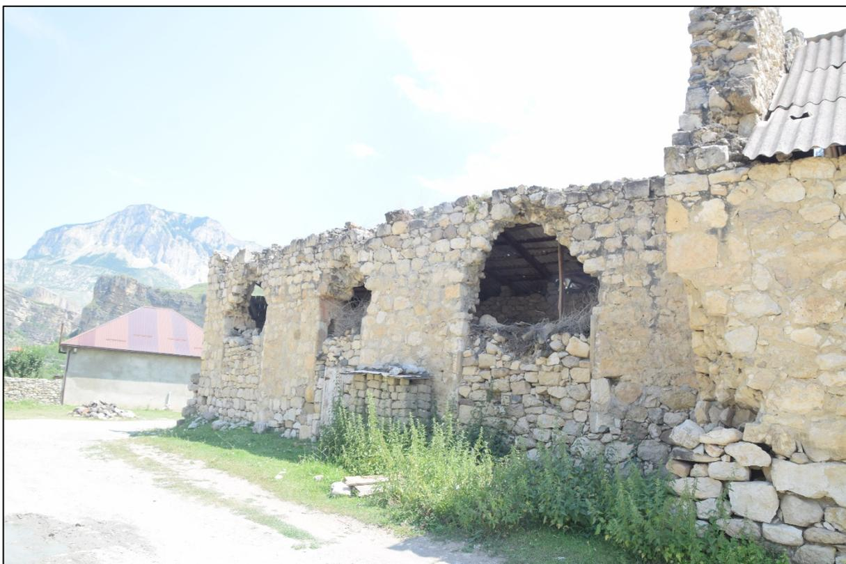
**Фото 24.** Административный и казарменный блок, полное обрушение второго этажа и крыши, частичное заложение оконных проемов.
