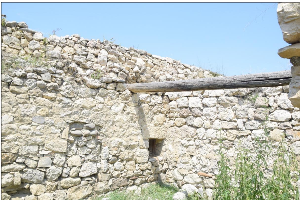
**Фото 22.** Вид на хозяйственный блок внутри помещений, часть заложённых бойниц, единственная сохранившаяся балка перекрытия.
