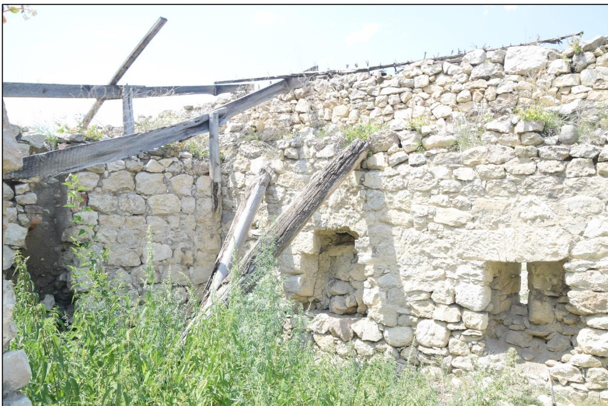
**Фото 21.** Вид на хозяйственный блок внутри помещений, бойницы сохранили свой вид и расположение, деревянные балки перекрытия полностью потеряли свои несущие характеристики.
