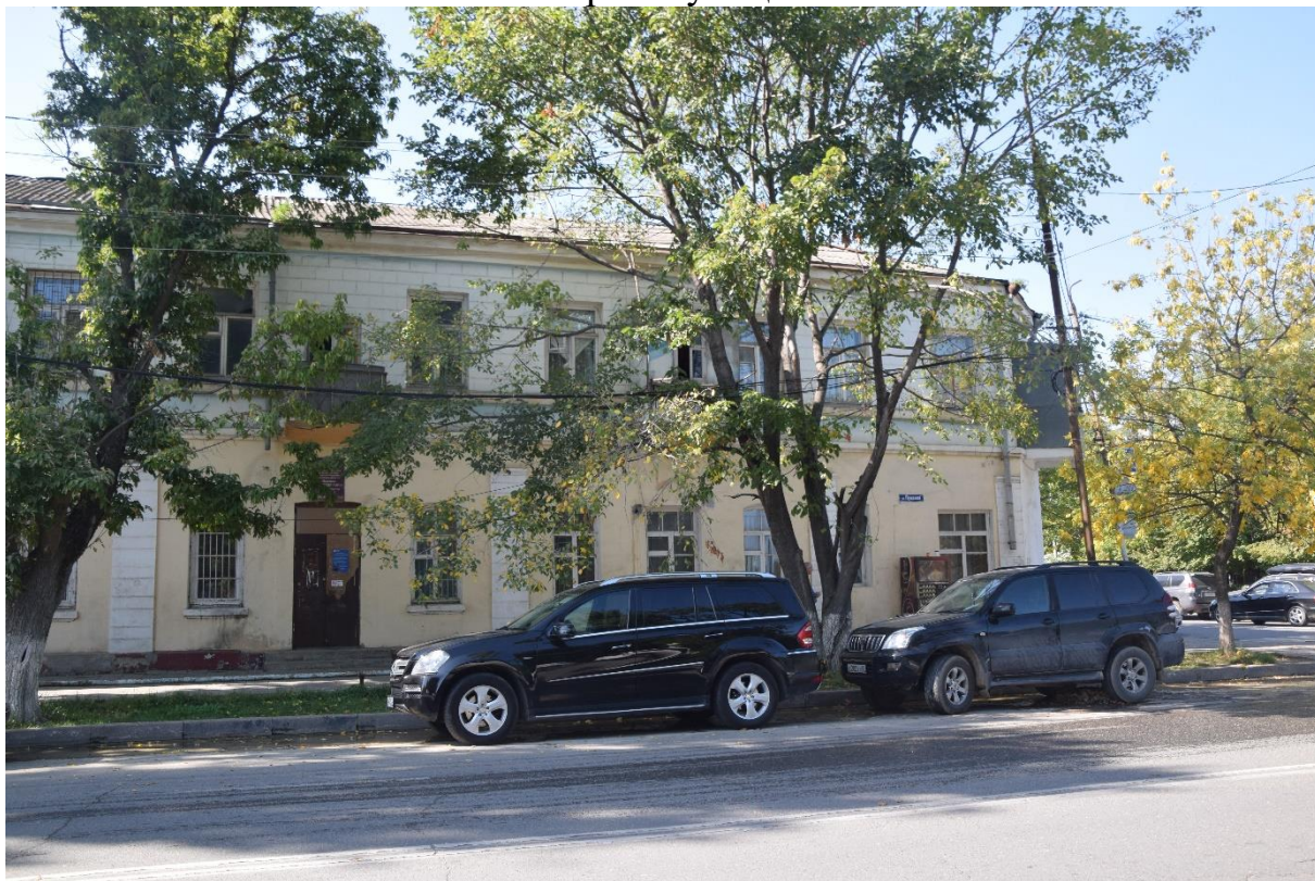
Фото 6. Общий вид на фасад объекта с ул. Пушкина, № 2, с северной стороны улицы
