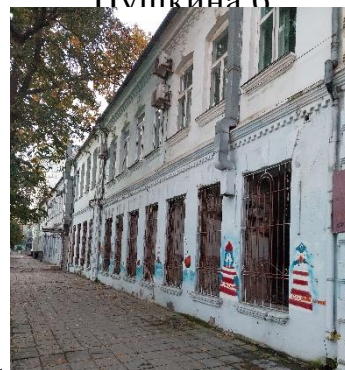
Общий вид на объект по ул. Пушкина 6
