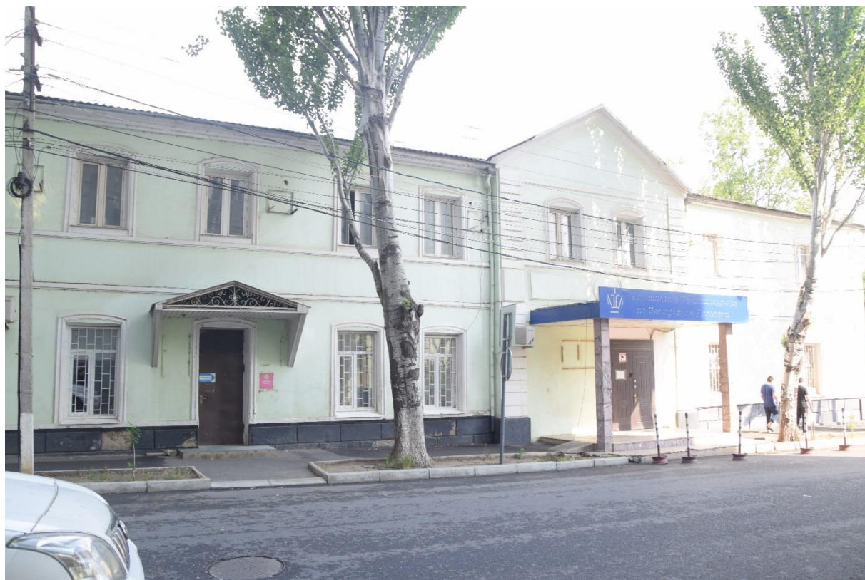
Фото 28. Фасад по С. Стальского, № 2 с южной стороны
