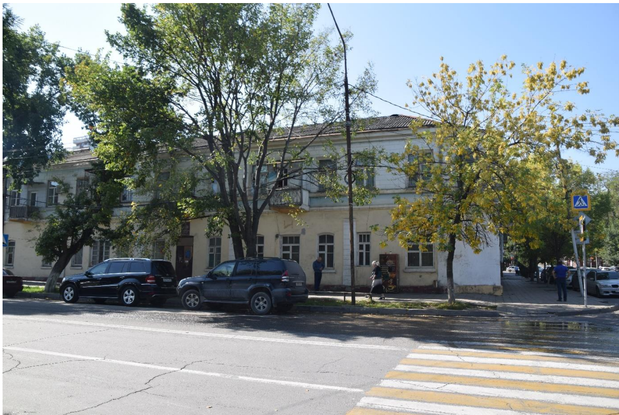
Фото 5. Общий вид на фасад объекта с ул. Пушкина, № 2, с северной стороны улицы
