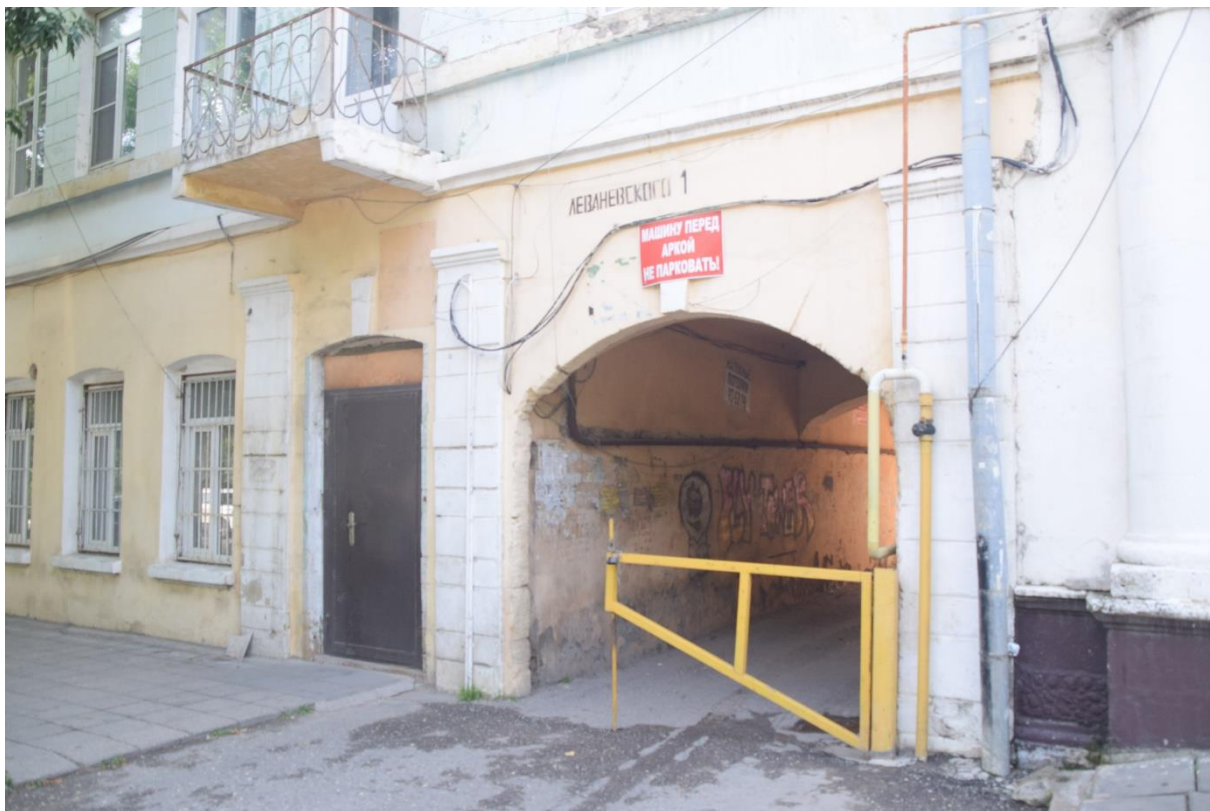
Фото 4. Вид на въездную арку здания по адресу ул. Леваневского, 1
