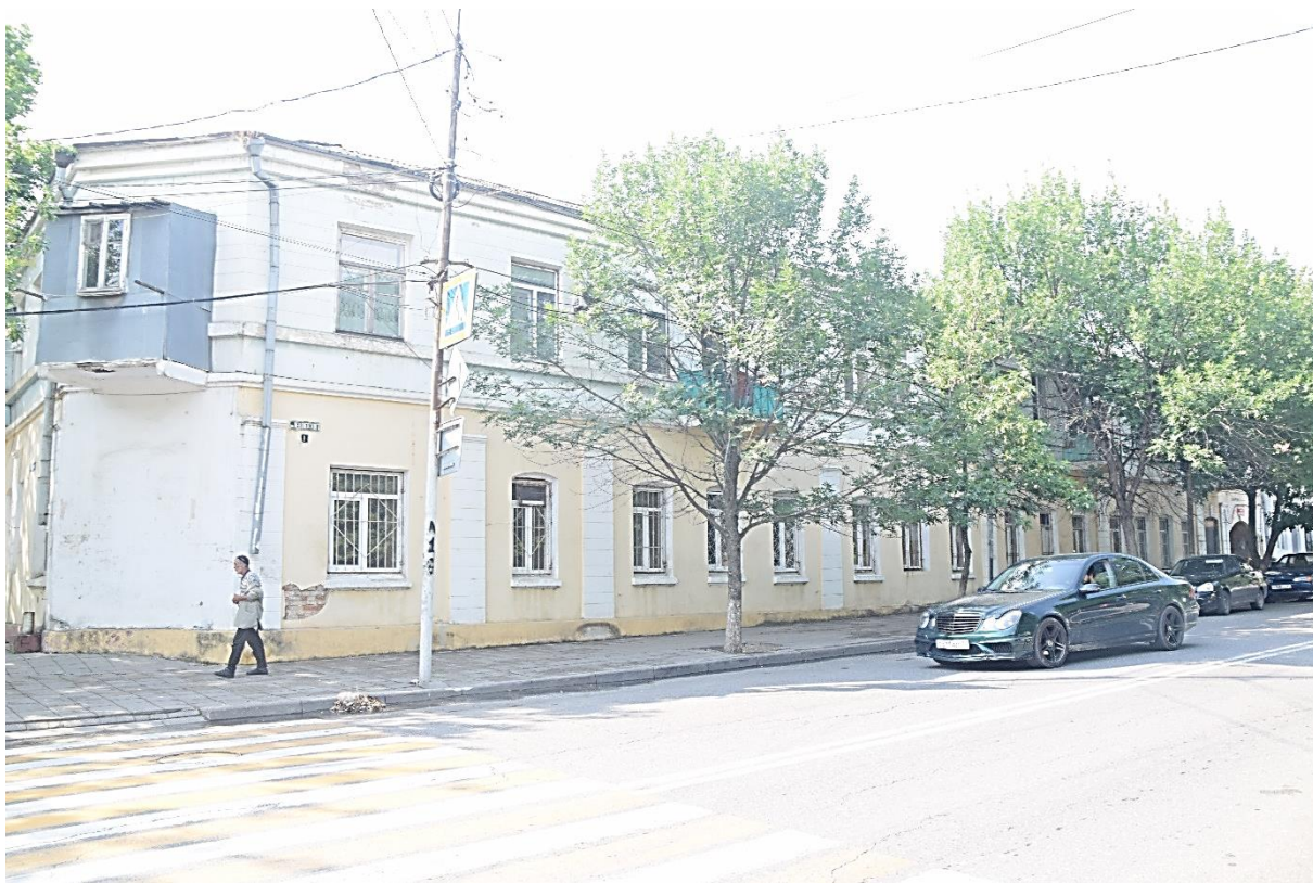
Фото 3. Общий вид на фасад объекта с пересечения ул. Пушкина и ул. Леваневского, с северной стороны
