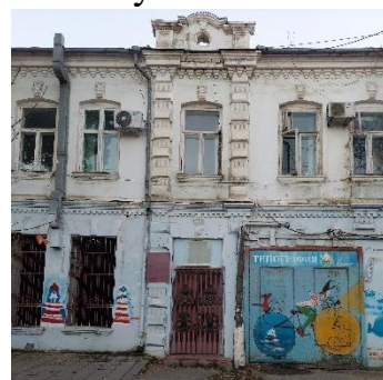
Общий вид на объект по ул. Пушкина 6
