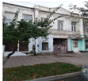
Общий вид на объект по ул. Пушкина 4
