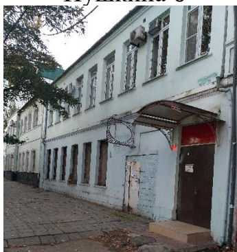
Общий вид на объект по ул. Пушкина 6
