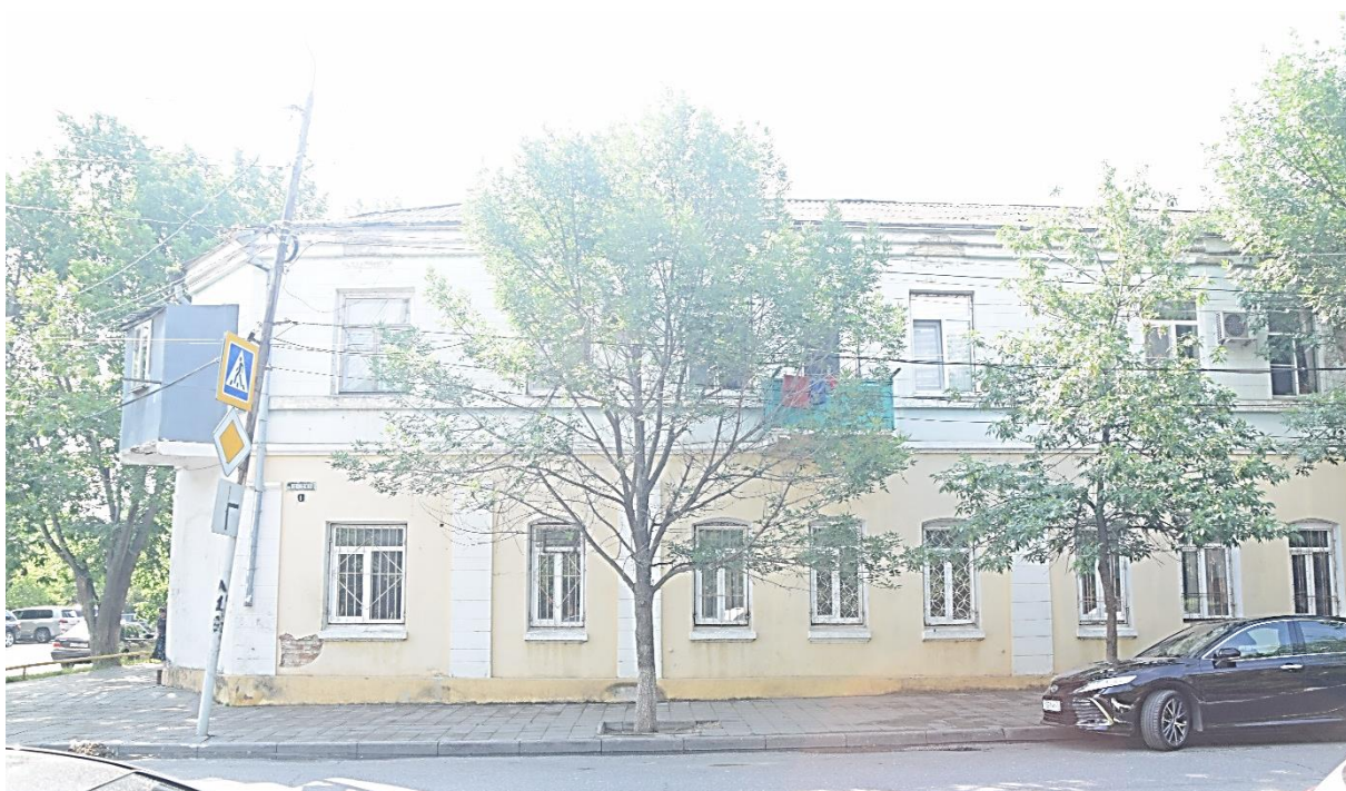
Фото 2. Общий вид на фасад объекта с ул. Леваневского, с северо-западной стороны улицы
