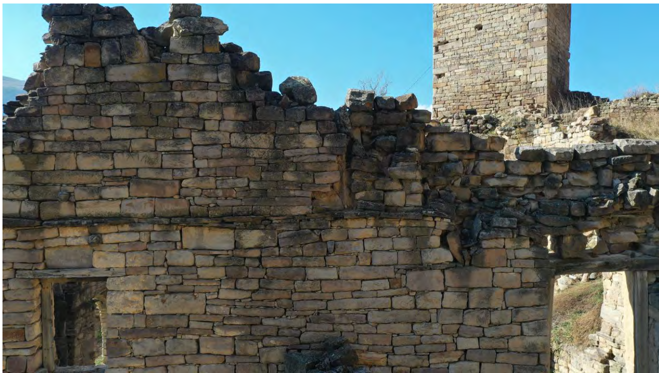
Рис. 32. Вид фасада южной стены ОКН ФЗ «Мечеть и баиня (Баграб-Росотль), XVI-XVII вв.»
