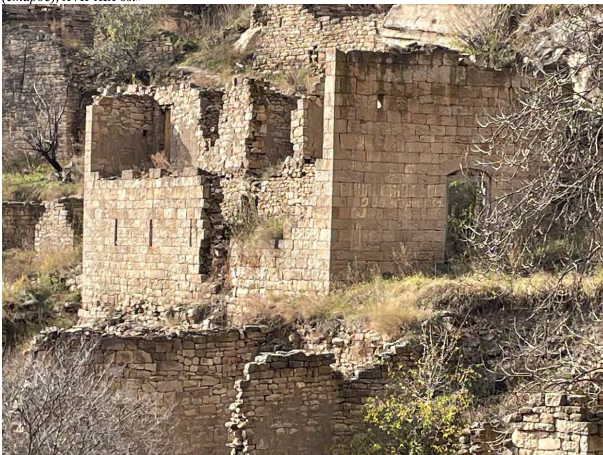
Рис. 43. Вид на ВОКН «Жилой дом, XIX в.»
