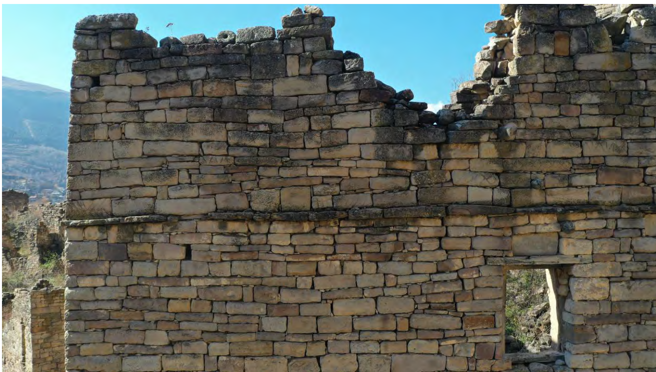
Рис. 31. Вид фасада южной стены ОКН ФЗ «Мечеть и баиня (Баграб-Росотль), XVI-XVII вв.»
