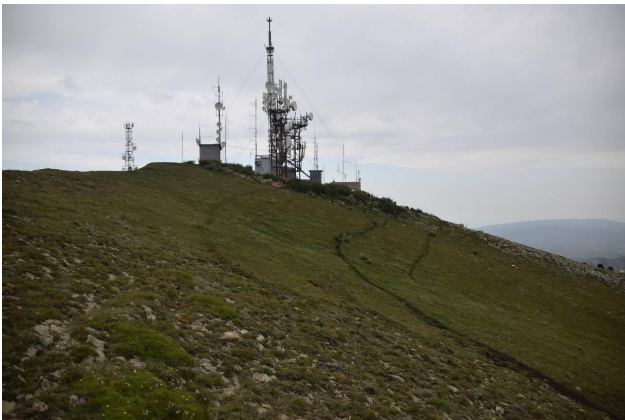
Фото 7. Общий вид на исследуемый объект, вышка связи в окрестностях объекта
