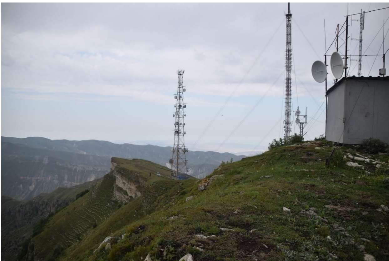
Фото 3. Общий вид на исследуемый объект, вышка связи в окрестностях. (Фото выполнены 15.04.2022 г.)
