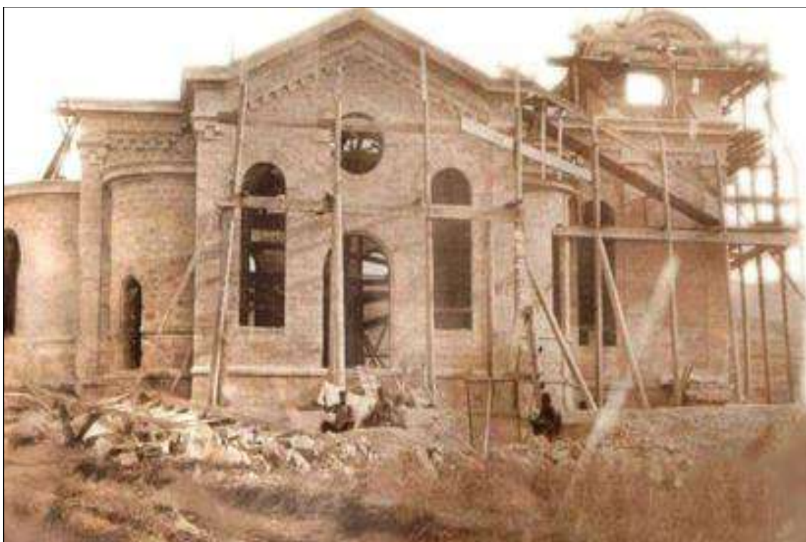
Фото.8. Церковь Успения Пресвятой Богородицы в период строительства.
