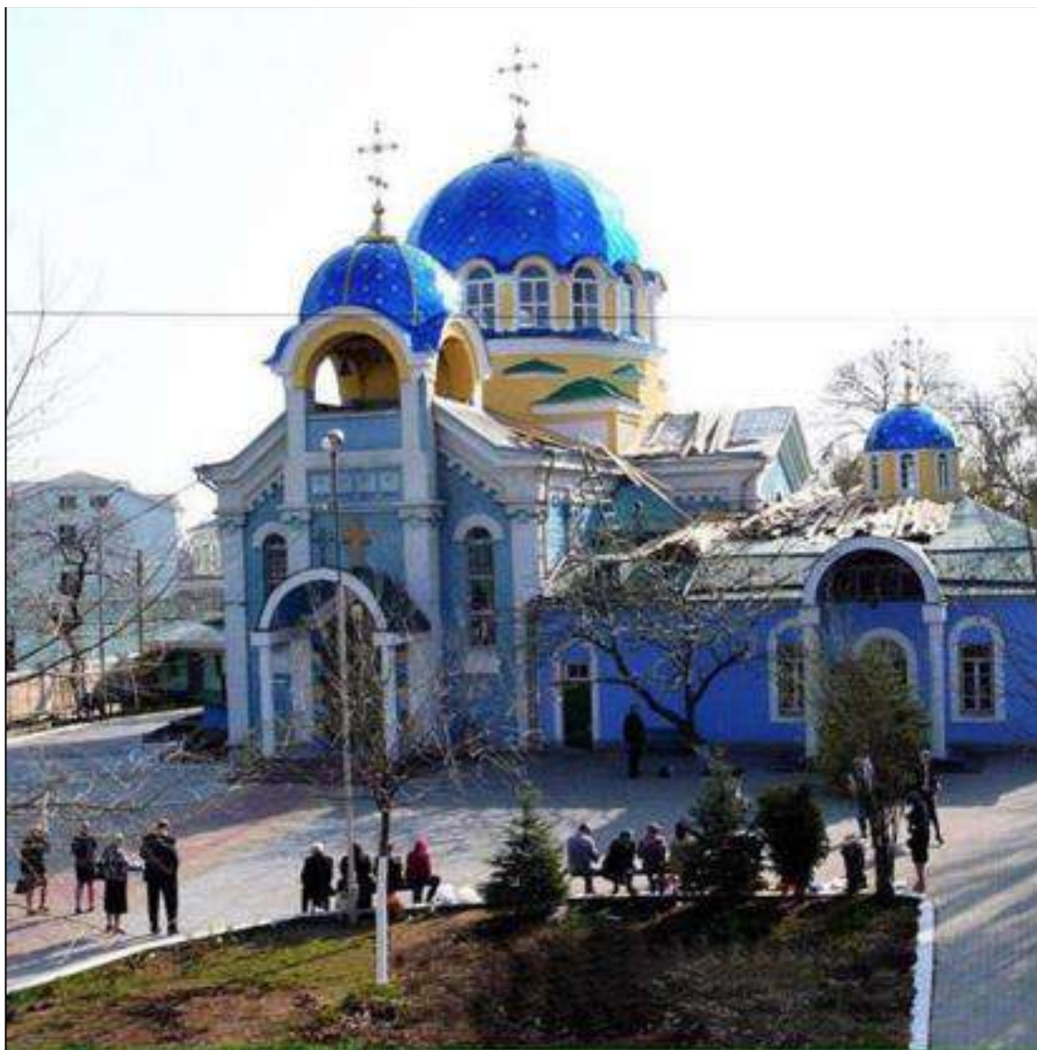
Фото.9.Церковь Успения Пресвятой Богородицы в период строительства.
