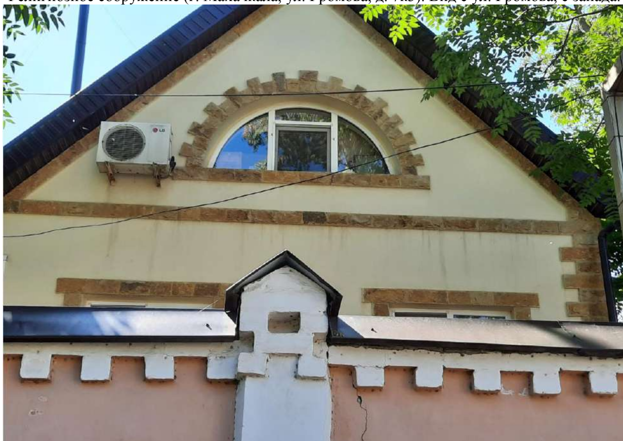
Т.ф. 2.6 Объект, входящий в состав комплекса Кафедрального Успенского собора Религиозное сооружение (г. Махачкала, ул. Громова, д. 7к3). Вид с ул. Камалова, с севера.
