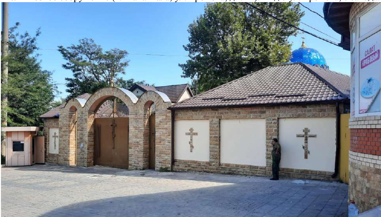
Т.ф. 2.4 Объект, входящий в состав комплекса Кафедрального Успенского собора Религиозное сооружение (г. Махачкала, ул. Громова, д. 7к2). Вид с ул. Громова, с запада.
