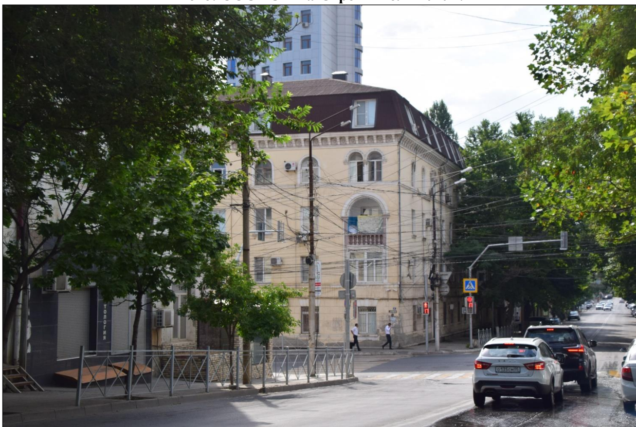
Т.ф. 12. Застройка на пересечении улиц Дахадаева и Даниялова. Вид с северо-запада. Фото: ООО «Сигма-Строй» июль 2020 г.
