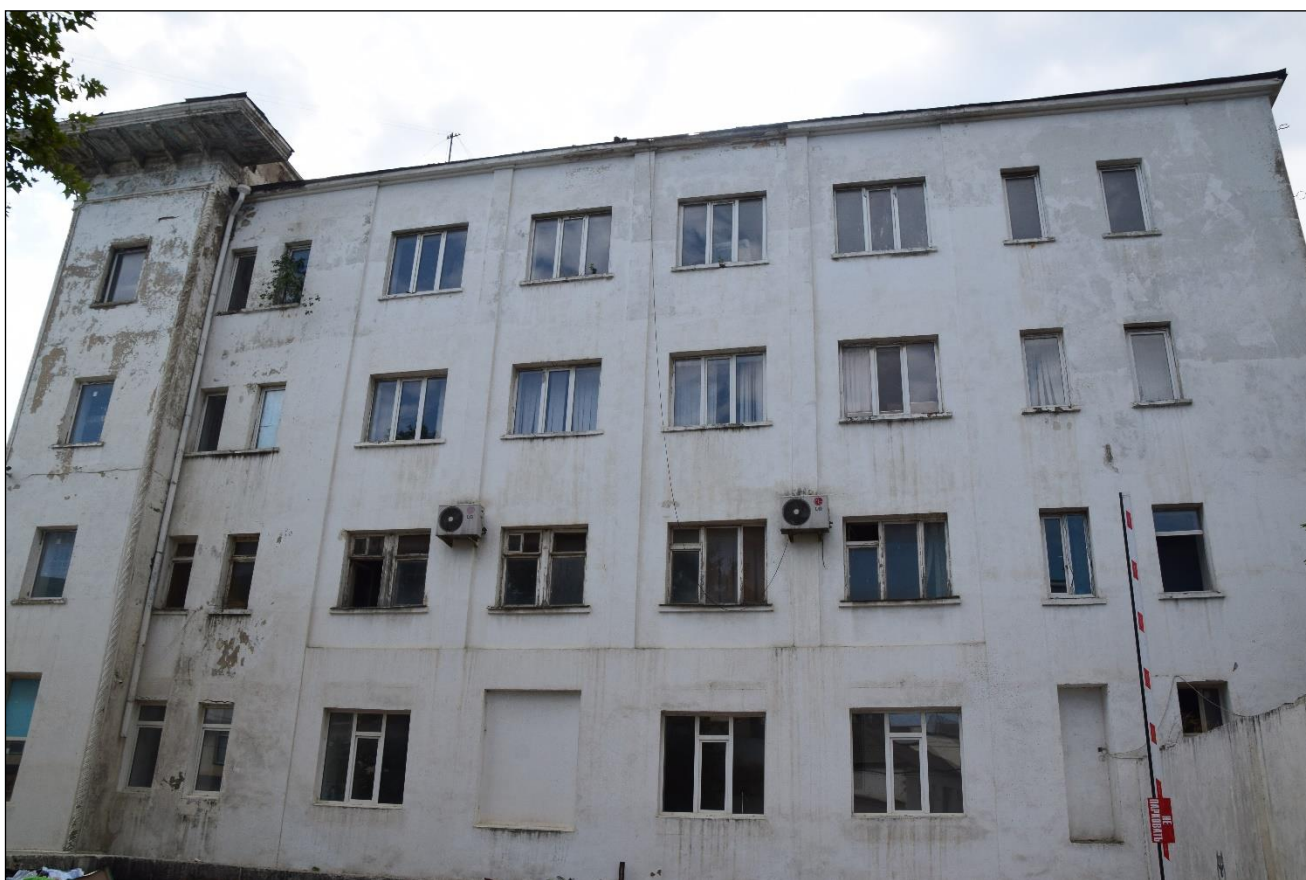
Т.ф. 2.Республика Дагестан, г.Махачкала, ул.Буйнакского, д. 2. «Гостиница "Дагестан". Арх.Гримм». Боковой (северо-западный) фасад Объекта. Фото: ООО «Сигма-Строй» июль 2020 г.
