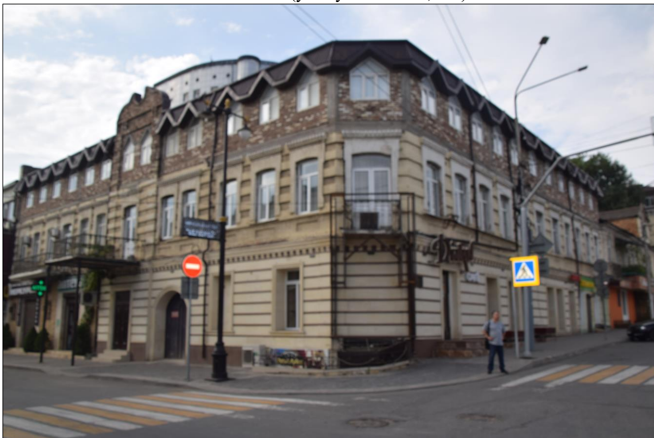
Вид с севера, с улицы Буйнакского. Фото 2020 г.
