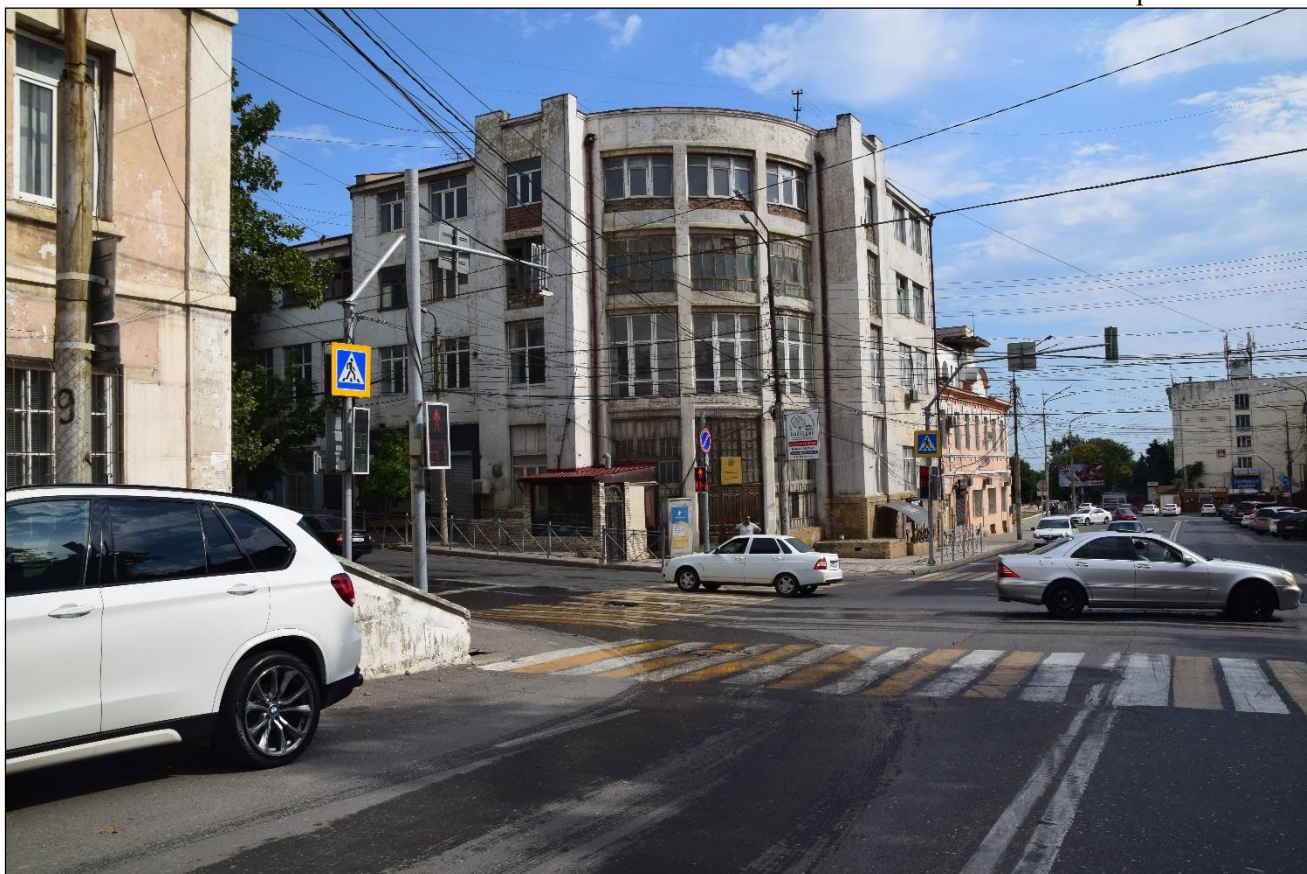
Т.ф. 11. Застройка по четной стороне улицы Дахадаева. Вид с юго-запада. Фото: ООО «Сигма-Строй» июль 2020 г.
