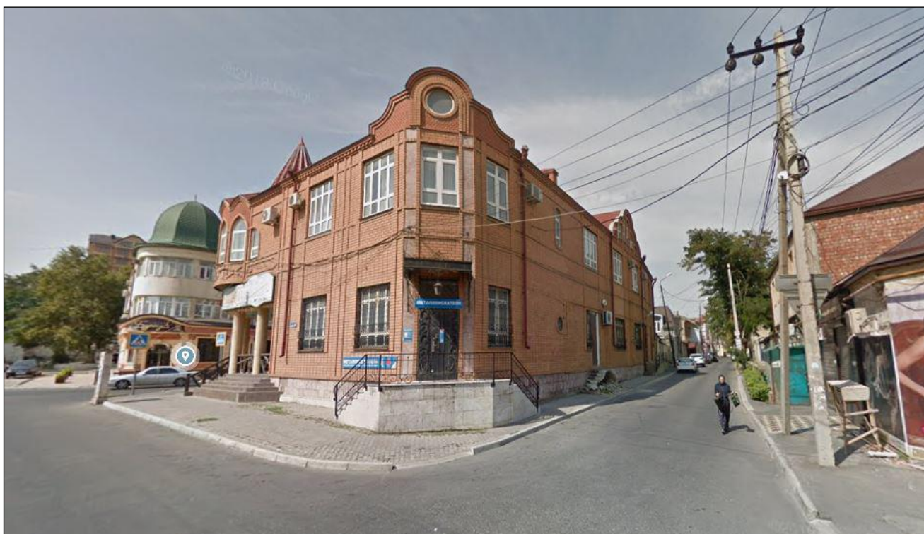
Т.ф. 30. Застройка на пересечении улиц Герцена и Готфрида Гасанова. Вид с северо-востока. Фото: ООО «Сигма-Строй» июль 2020 г.
