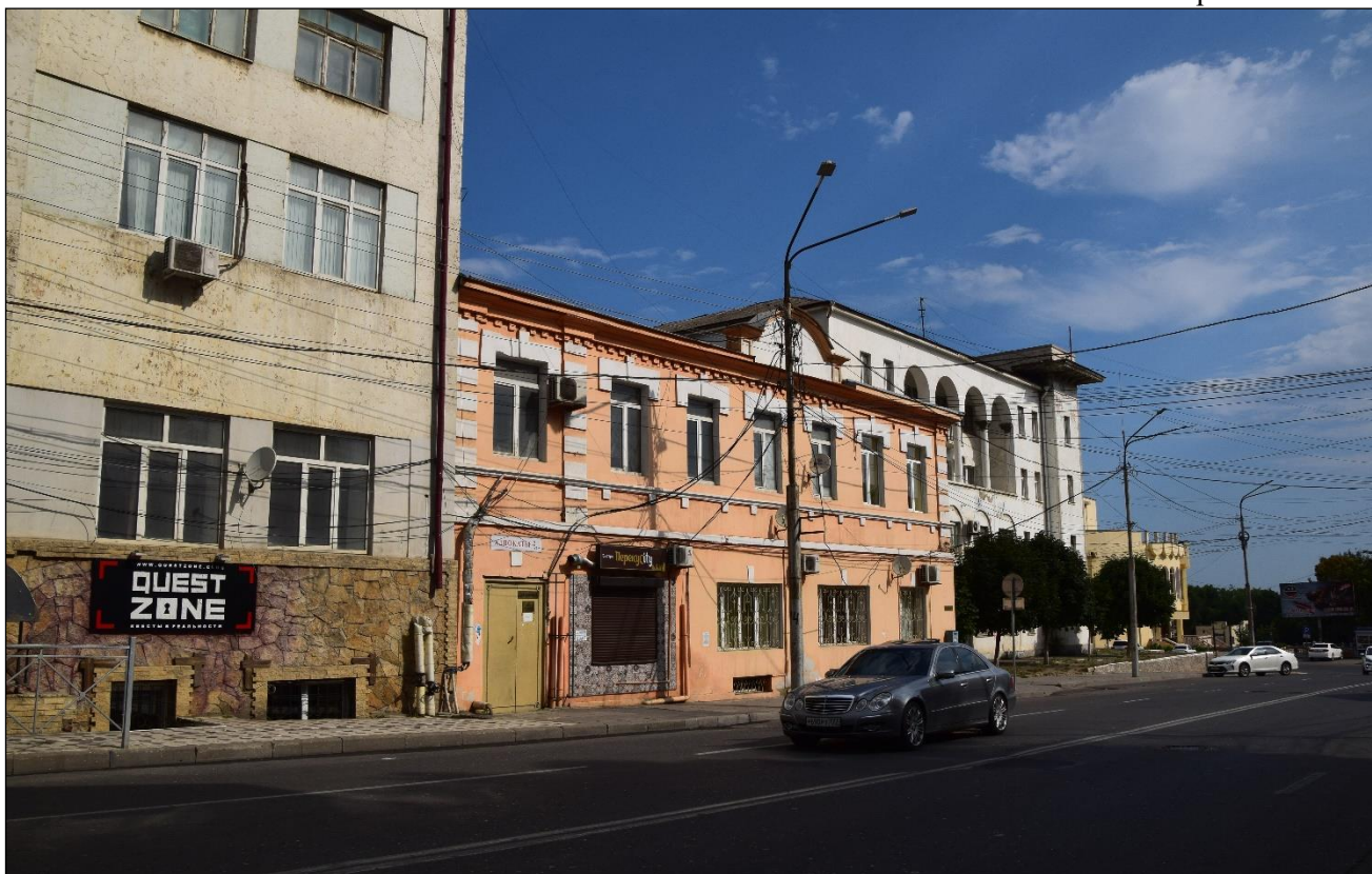
Т.ф. 7. Застройка по четной стороне улицы Дахадаева. Вид с юго-запада. Фото: ООО «Сигма-Строй» июль 2020 г.
