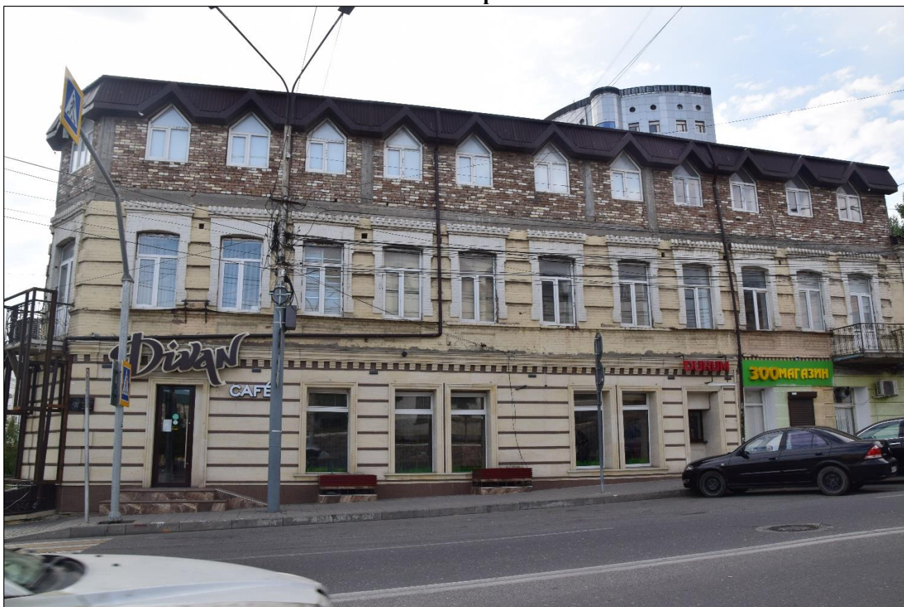
Т.ф. 8. Северо-западный фасад здания №9/3 по улице Буйнакского. Вид с улицы Дахадаева. Фото: ООО «Сигма-Строй» июль 2020 г.
