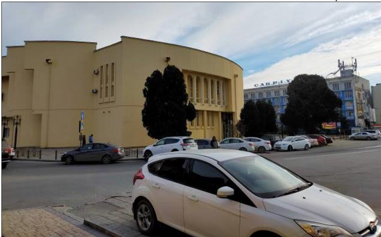
Т.ф. 31. Застройка на пересечении ул. Буйнакского и ул. Готфрида Гасанова. Вид с юга. Фото: ООО «Сигма-Строй» июль 2020 г.
