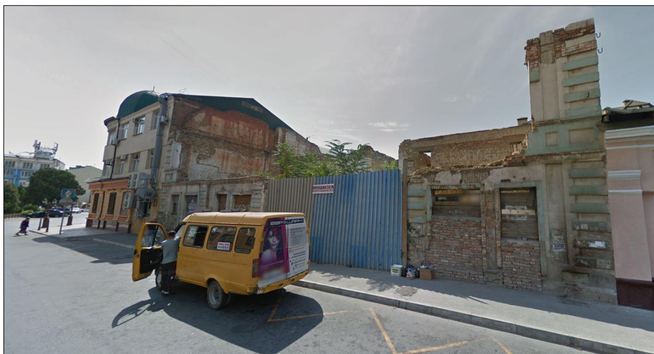
Т.ф. 24. Застройка по нечетной стороне улицы Буйнакского. Вид севера. Фото: ООО «Сигма-Строй» июль 2020 г.
