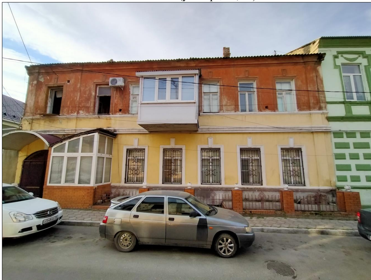
Вид с северо-востока, с улицы Герцена. Фото 2020 г.
