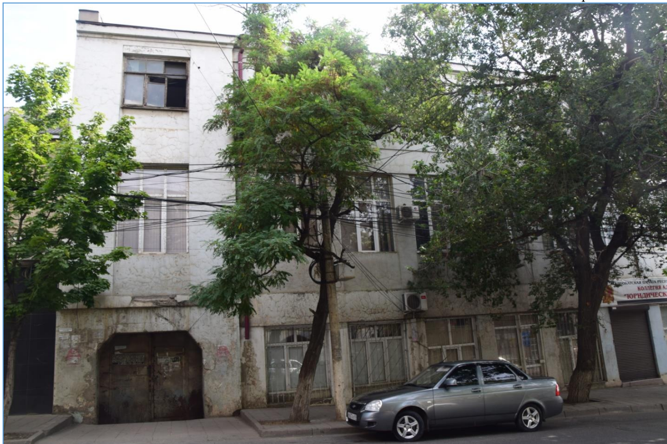
Т.ф. 13. Юго-западный фасад здания №23 по улице Даниялова. Фото: ООО «Сигма-Строй» июль 2020 г.
