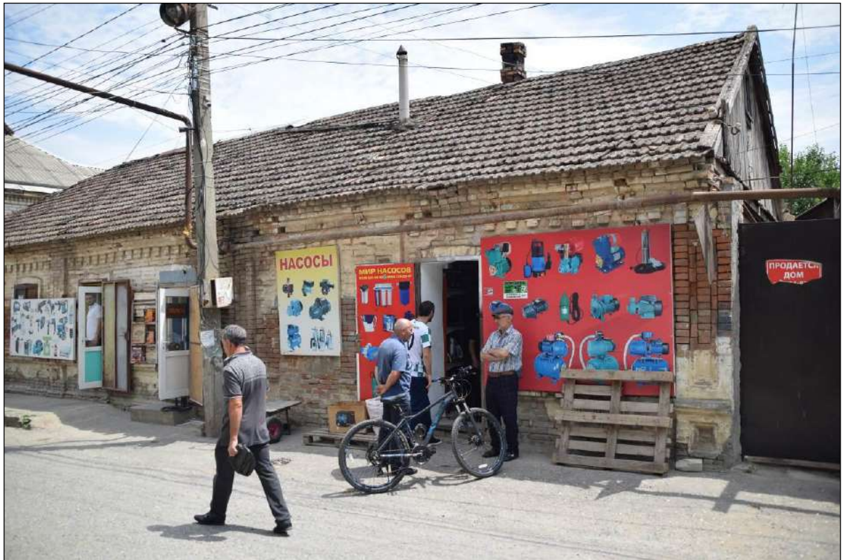
Т.ф. 3.3.2 Исторически ценный градоформирующий объект. Жилой дом (г. Хасавюрт, ул. Тотурбиева, 134 (на ул. Мусаясул)). Вид с ул. Мусаясул, с юго-запада.
