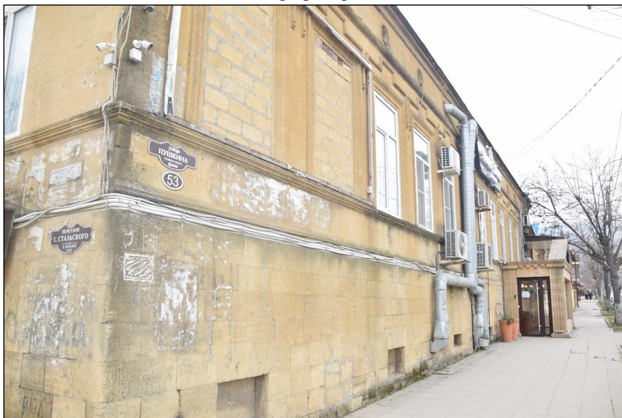
Фото 6. Фасад здания по ул. Пушкина, поздние пристройки и коммуникации, нарушающие общий вид здания.
