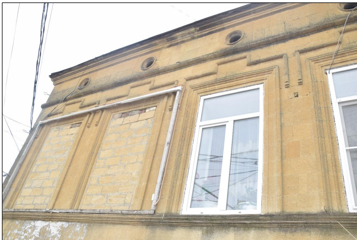
Фото 7. Архитектурно-художественное оформление главного фасада здания по ул. Пушкина, антаблемент с слуховыми окнами, наличники оконных проемов.
