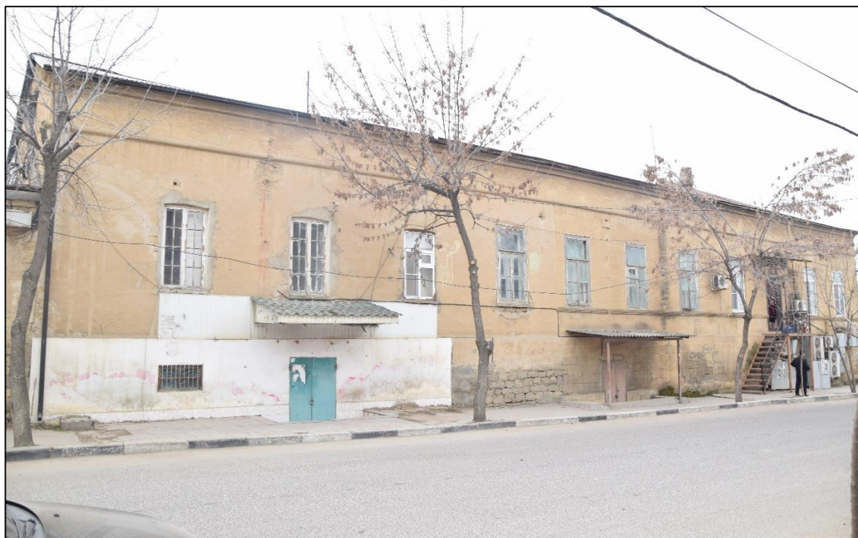
Фото 3. Вид западного фасада здания по ул. С. Стальского, два спуска организованных в цоколь.
