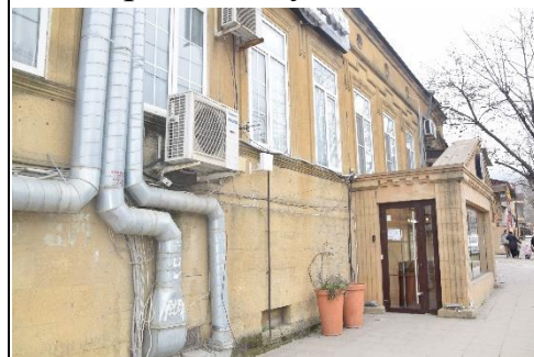
Поздние пристройки по главному фасаду
