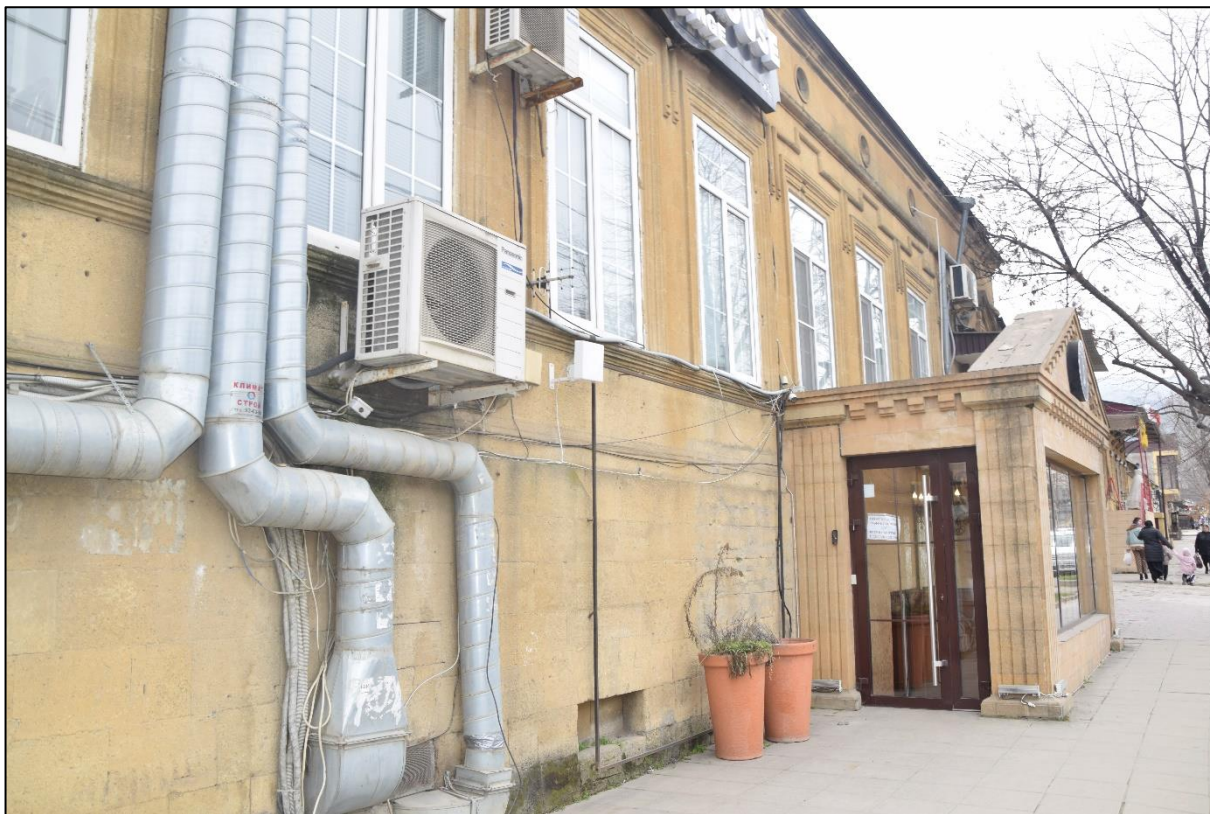
Фото 9. Поздние пристройки к главному фасаду здания, вход в кафе.
