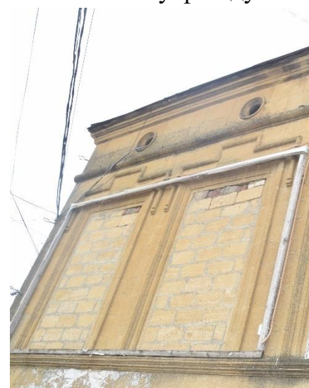
Заложенные оконные проемы
