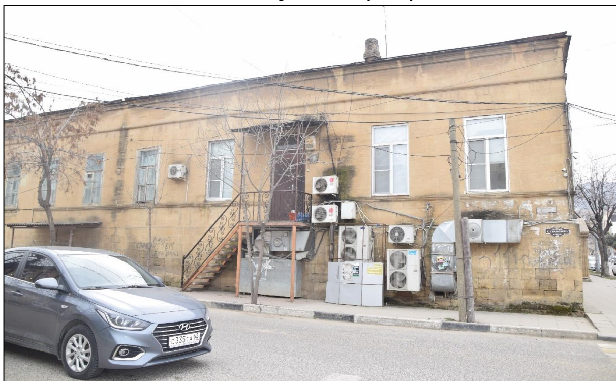
Фото 2. Фасад здания по ул. С. Стальского, поздний дверной проем, элементы коммуникаций нарушающий внешний вид.
