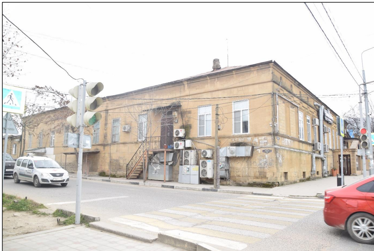
Фото 1. Общий вид здания на пересечении ул. Пушкина и С. Стальского.
