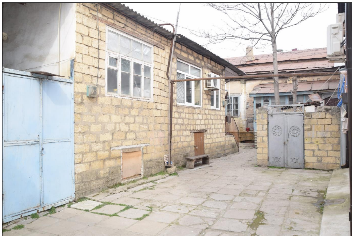
Фото 13. Поздние пристройки к дворовому фасаду здания.
