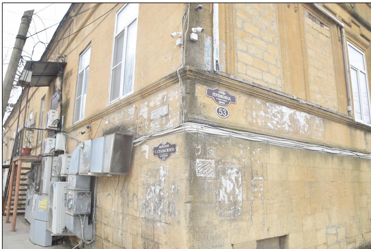
Фото 5. Угол здания на пересечении улиц Пушкина и С. Стальского, межэтажный профилированный пояс.
