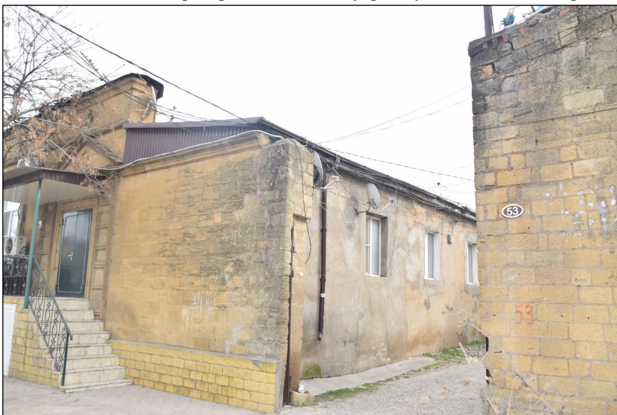
Фото 10. Дворовой фасад здания, проход между двумя зданиями.
