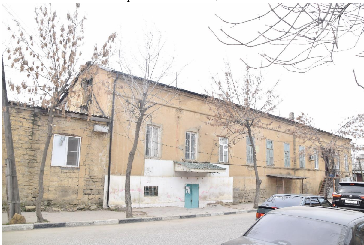
Фото 4. Общий вид на здание с ул. С. Стальского, торец здания.
