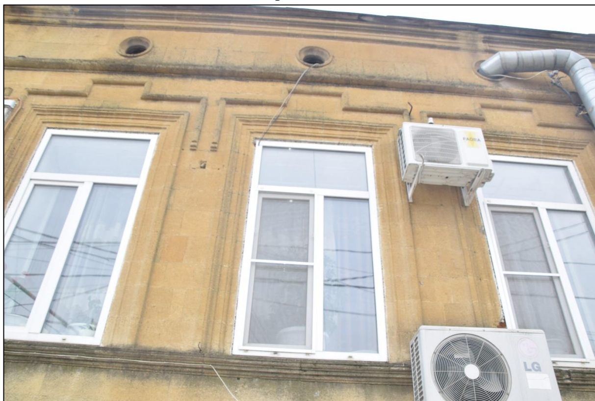
Фото 8. Архитектурно-художественное оформление главного фасада здания по ул. Пушкина, наличники оконных проемов, сандрики и слуховое окно.
