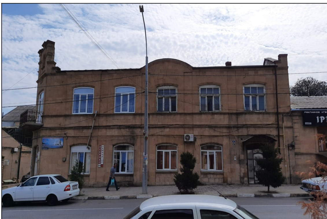
Фото. 8. «Жилой дом купца Саруханова».
