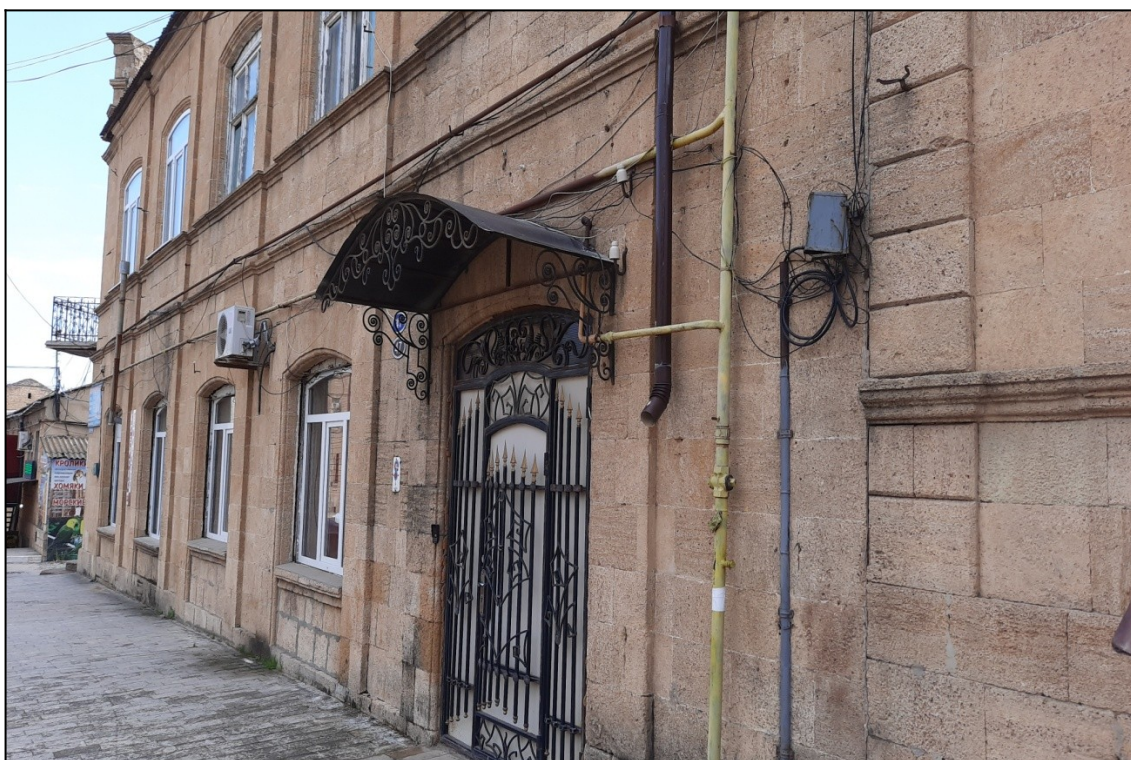
Фото. 12. «Жилой дом купца Саруханова».
