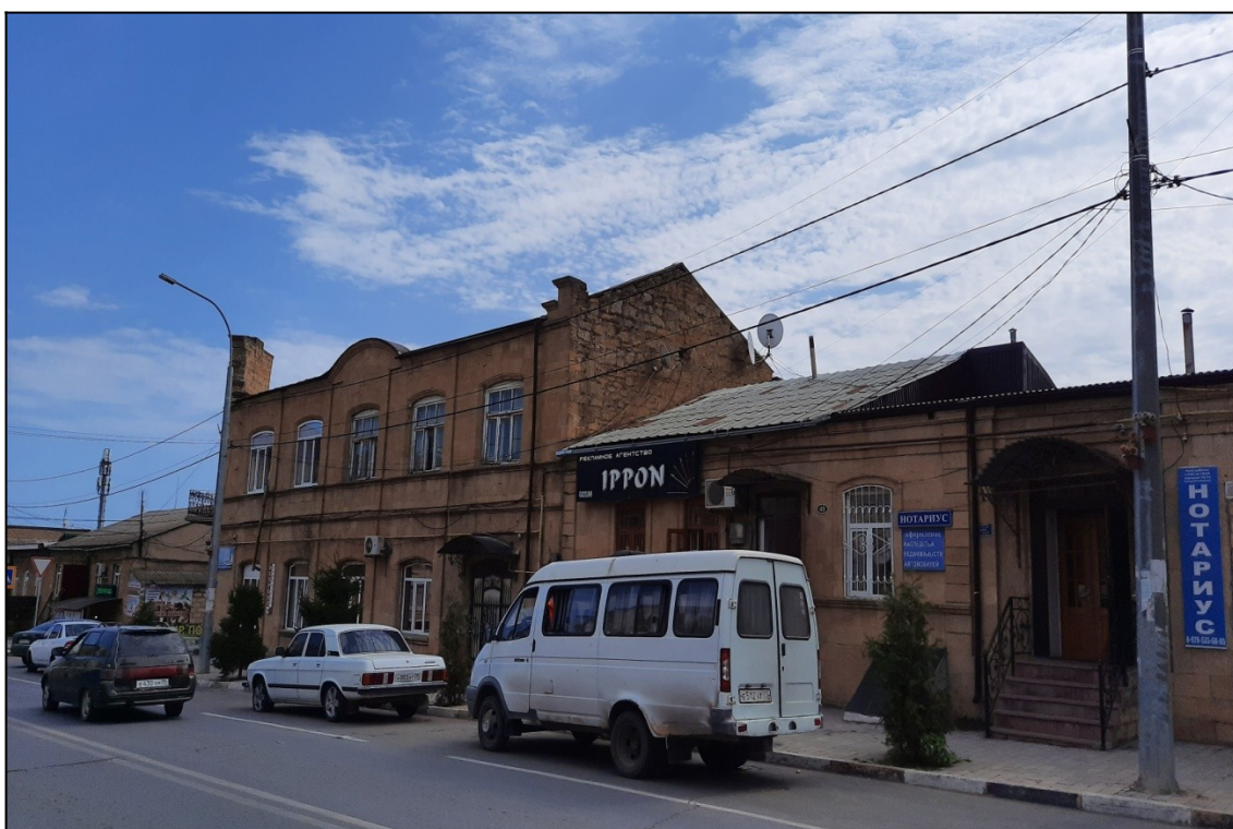
Фото. 10. «Жилой дом купца Саруханова».
