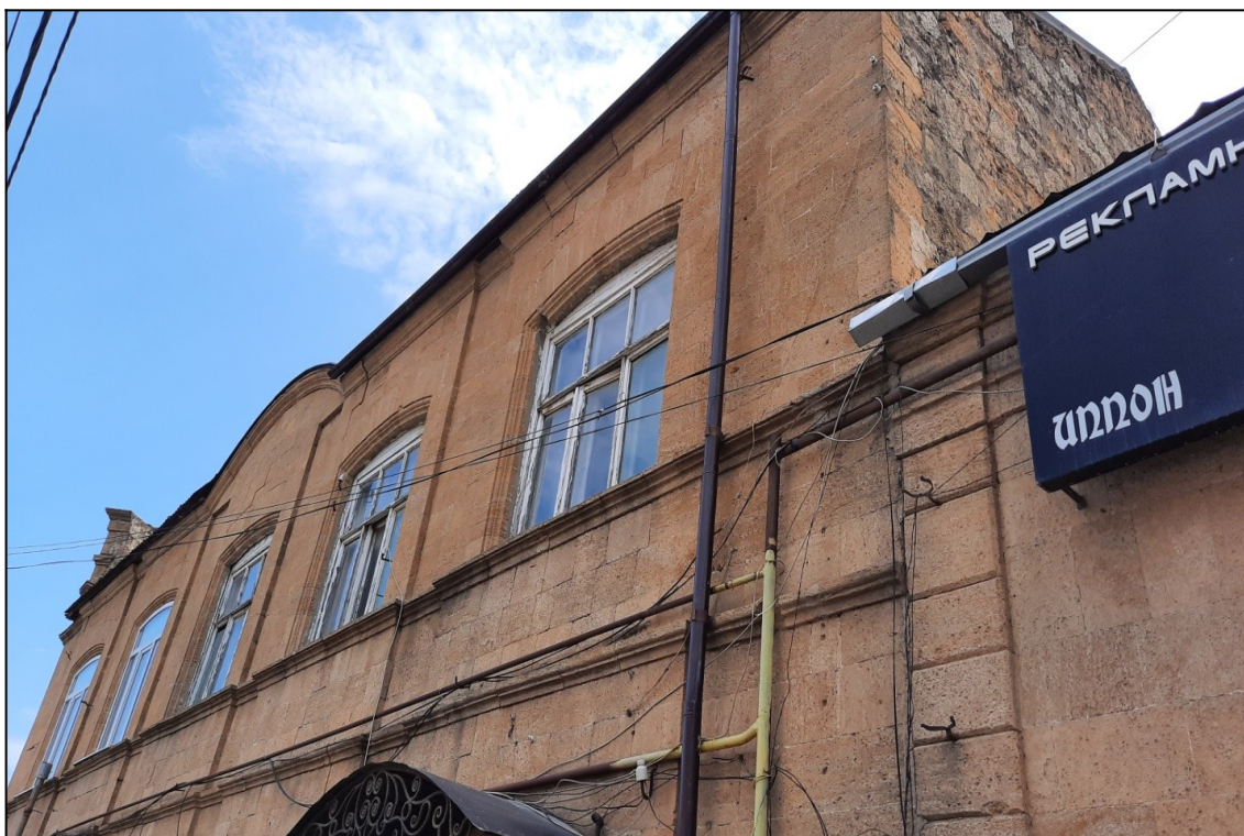
Фото. 13. «Жилой дом купца Саруханова».
