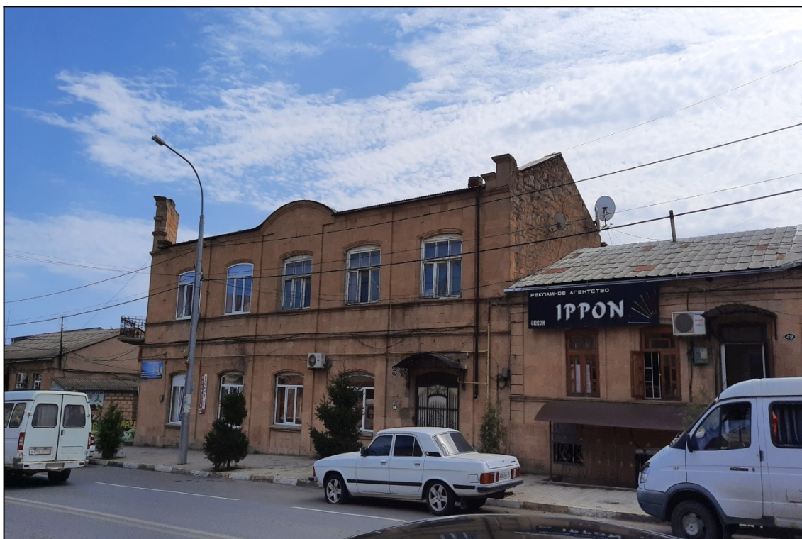
Фото. 9. «Жилой дом купца Саруханова».
