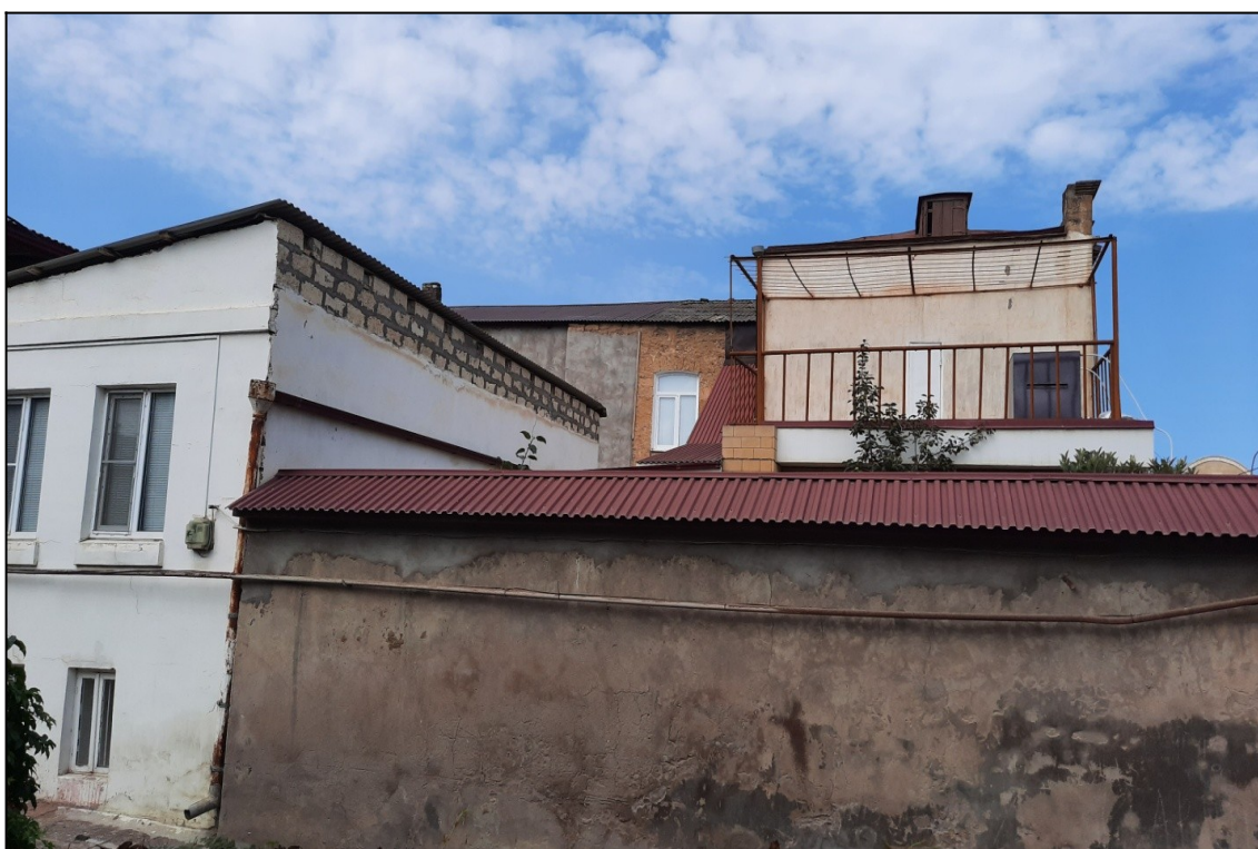
Фото. 22. «Жилой дом купца Саруханова».
