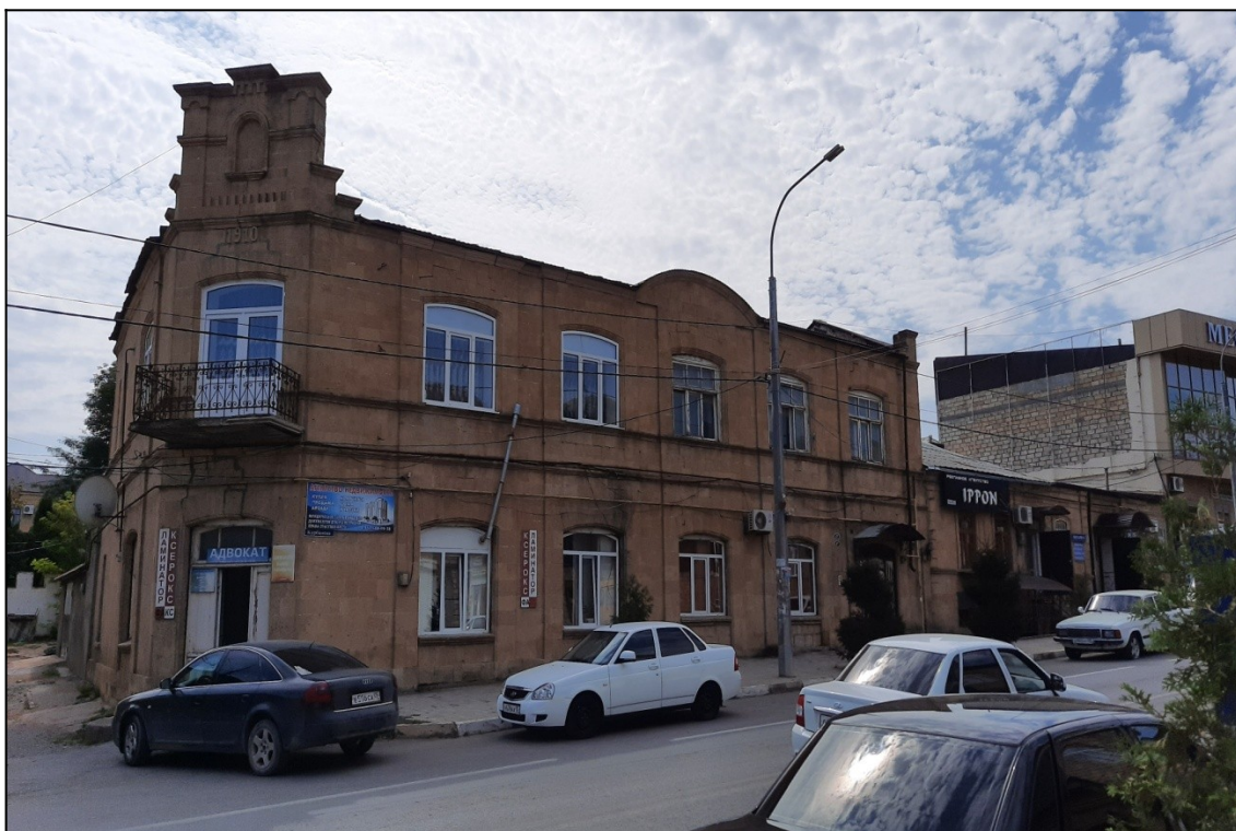
Фото. 7. «Жилой дом купца Саруханова».
