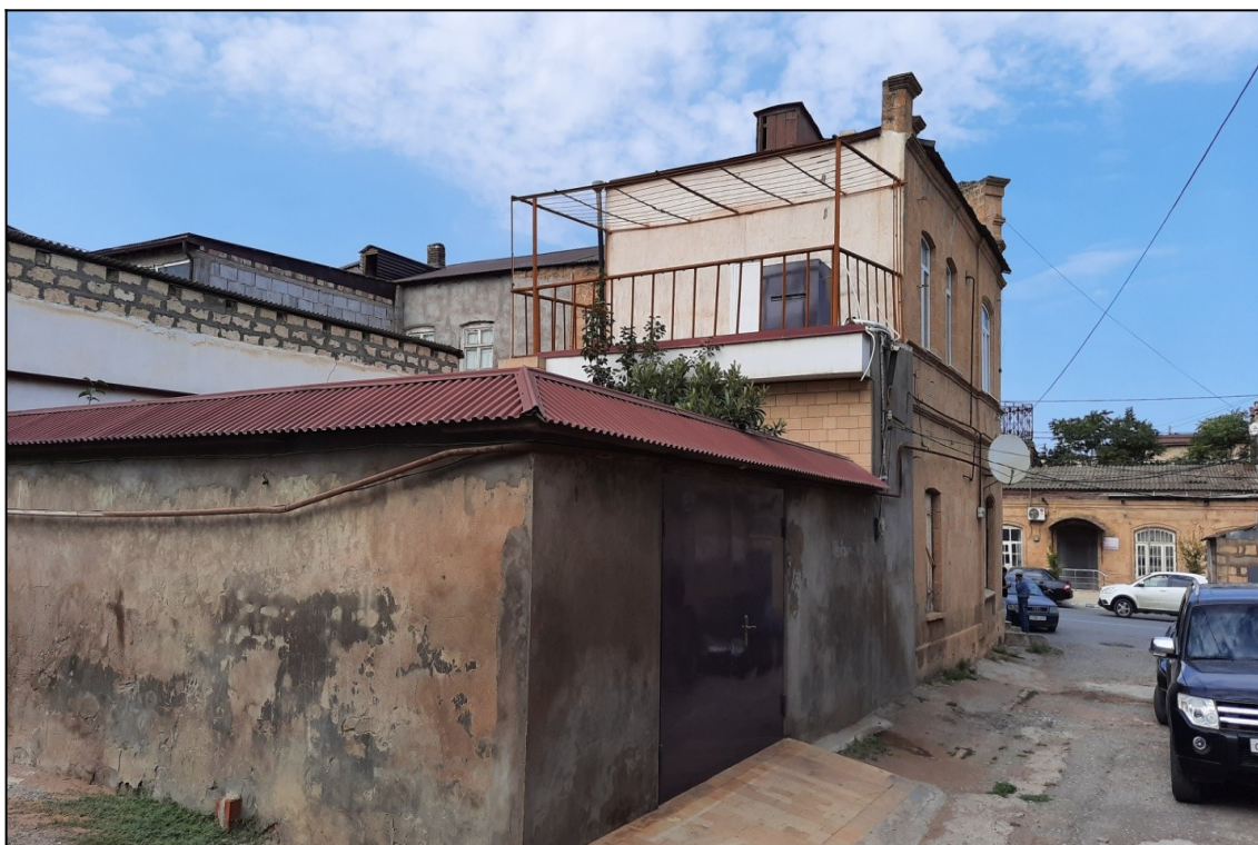
Фото. 21. «Жилой дом купца Саруханова».
