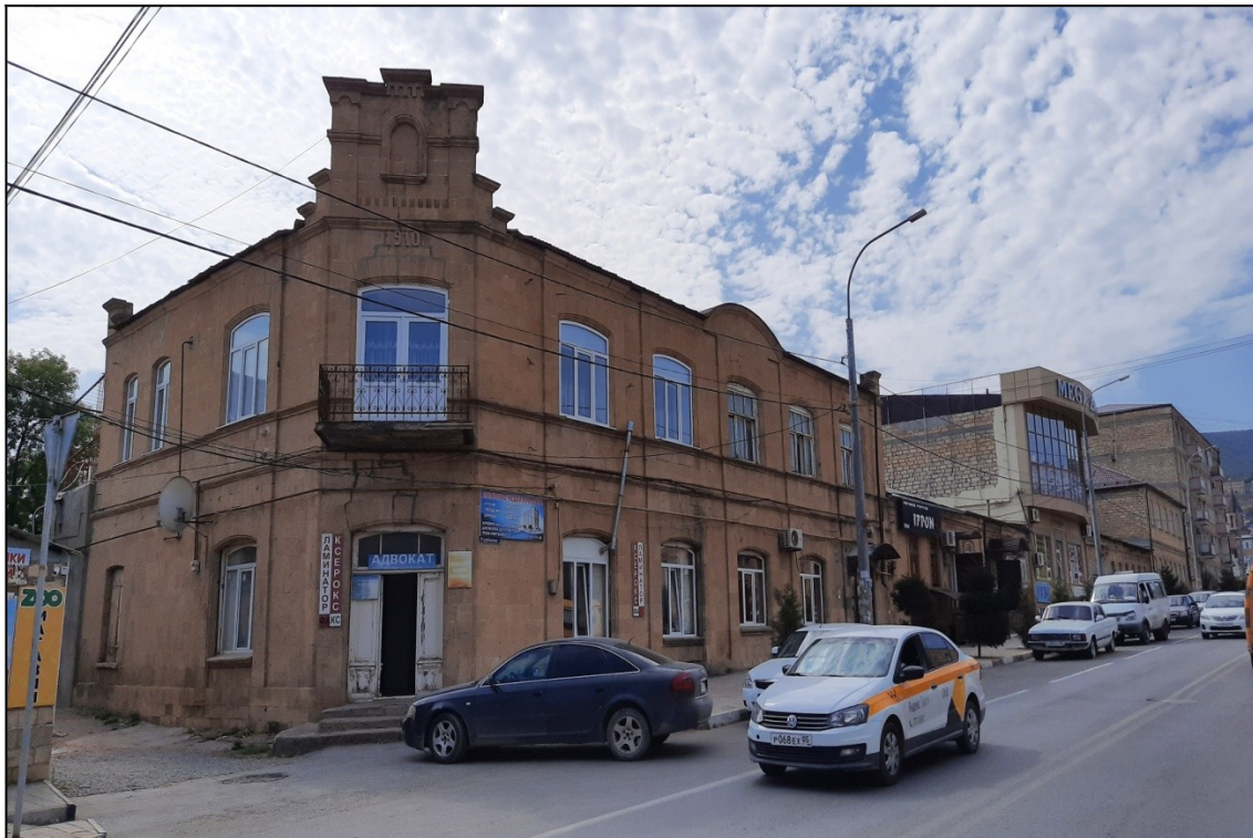
Фото. 6. «Жилой дом купца Саруханова».
