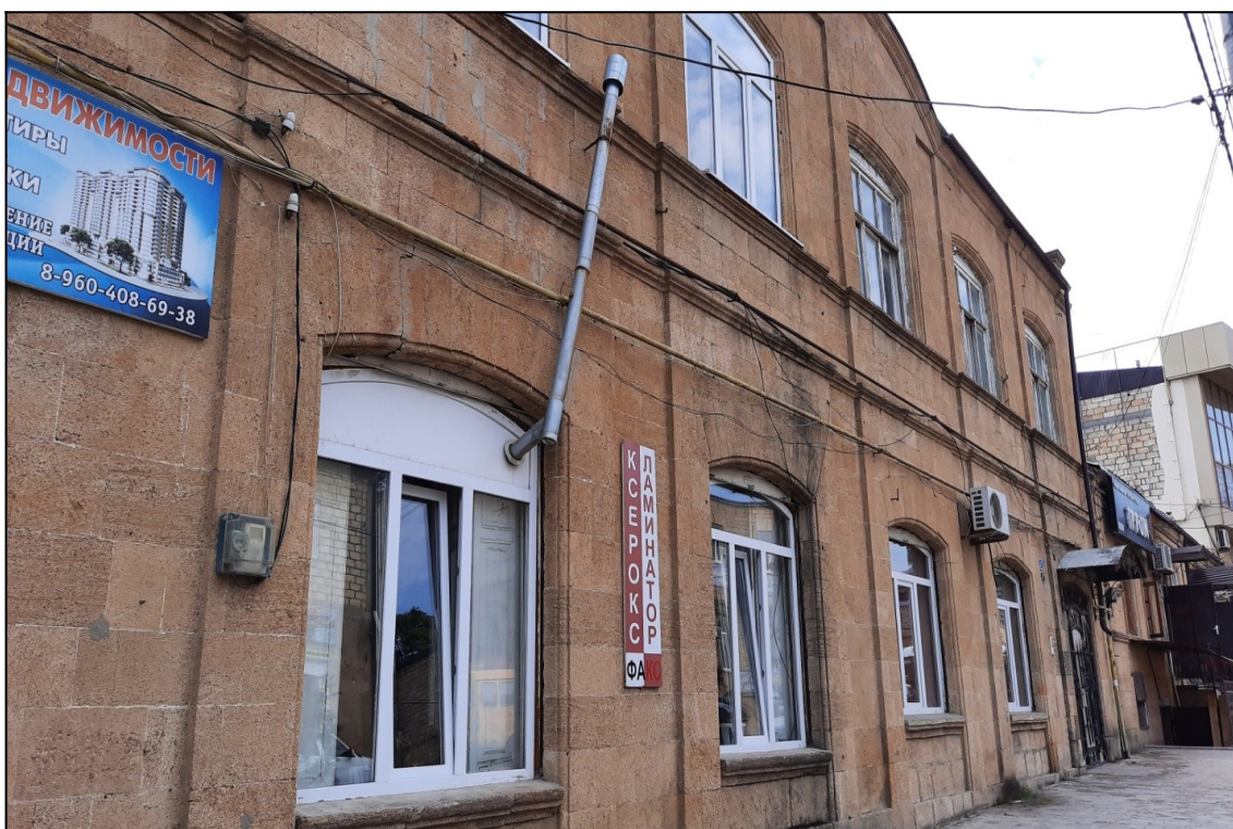
Фото. 16. «Жилой дом купца Саруханова».
