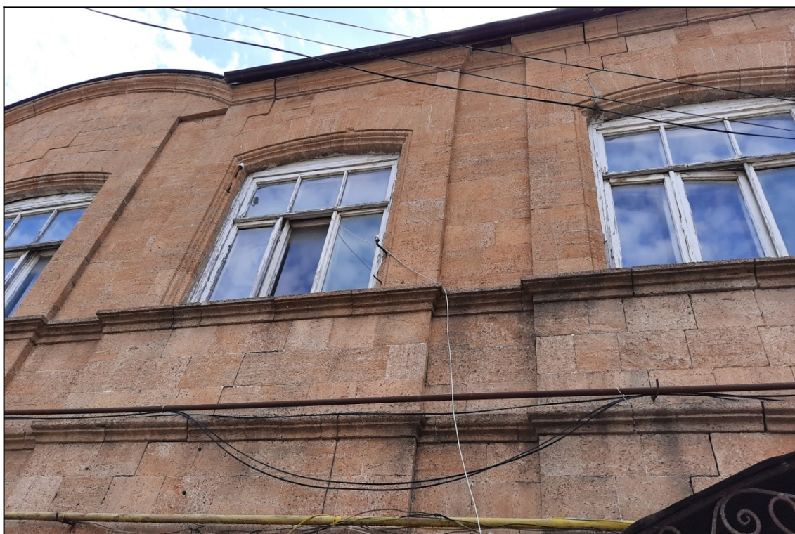
Фото. 14. «Жилой дом купца Саруханова».
