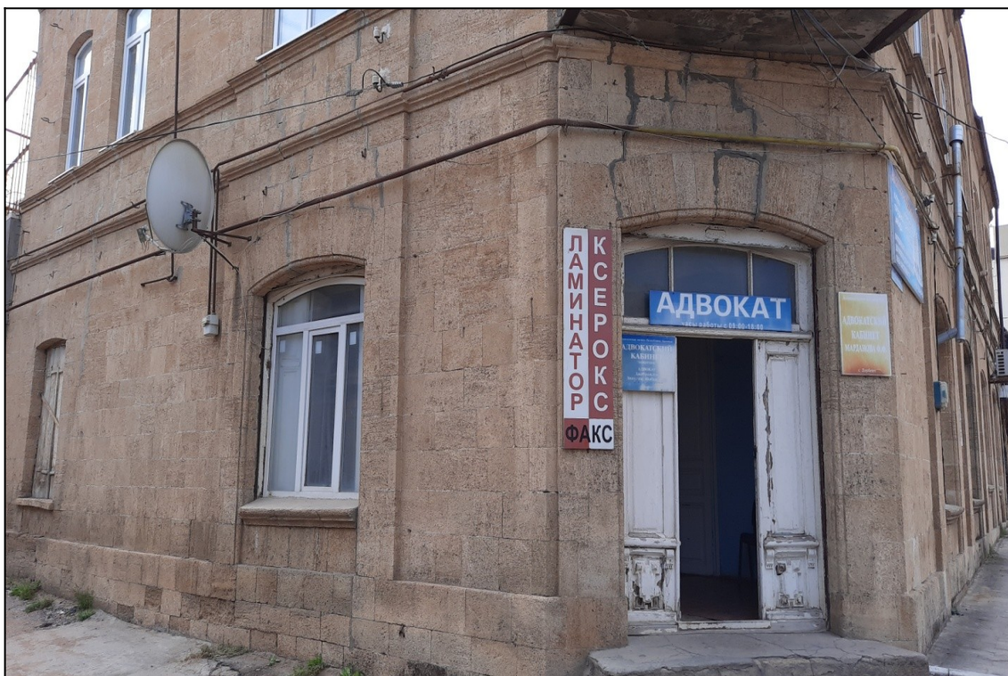
Фото. 17. «Жилой дом купца Саруханова».
