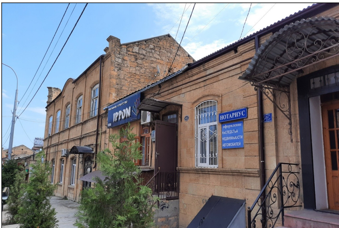
Фото. 11. «Жилой дом купца Саруханова».
