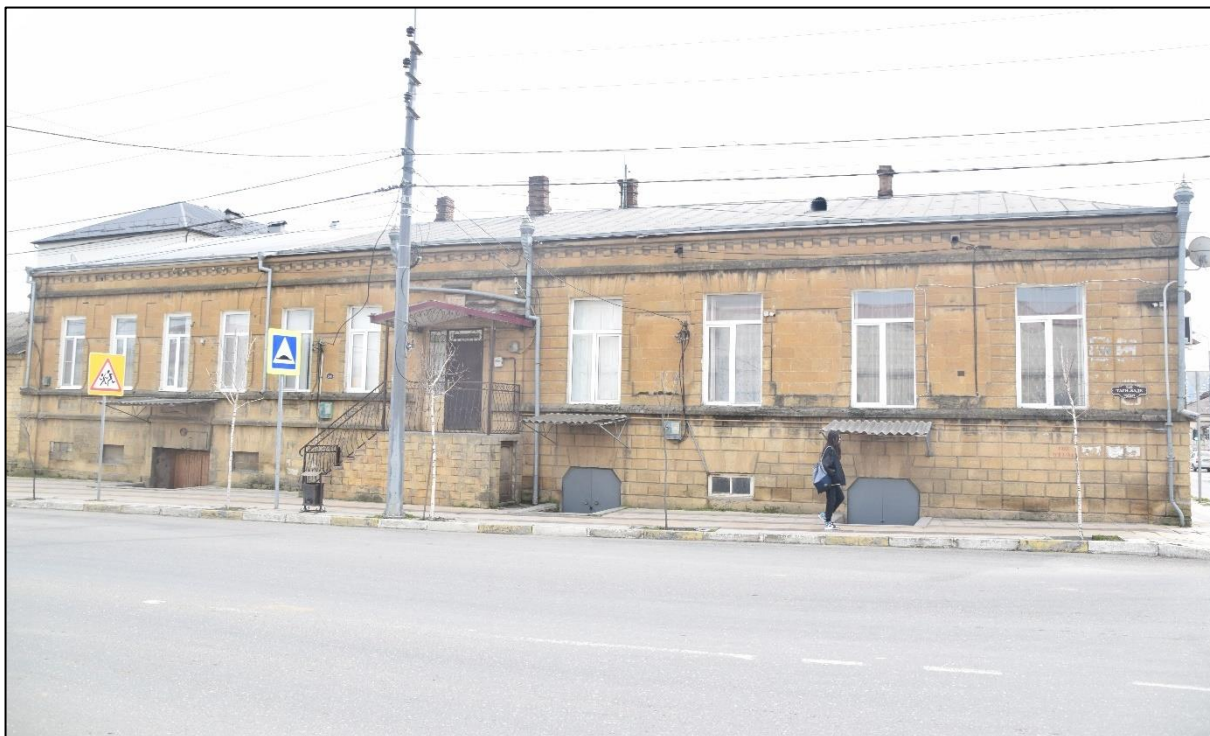
Фото 2. Полный вид фасада по ул. Таги-Заде в одиннадцать световых осей, высокий цоколь и жилой этаж.
