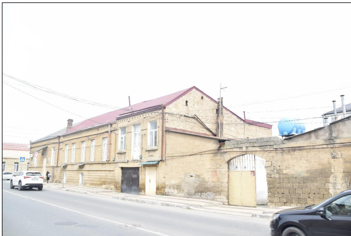
Фото 11. Угол здания с западного фасада.
