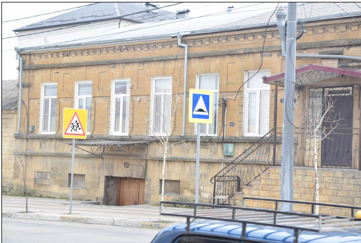
Фото 3. Архитектурно-художественные элементы здания, карниз с сухариками, молдинг, пояса, филенки.
