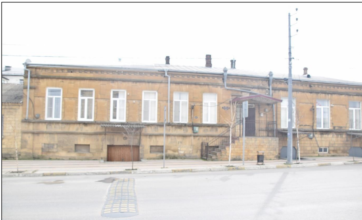
Фото 1. Фасад здания по ул. Таги-Заде, главный вход в здание.
