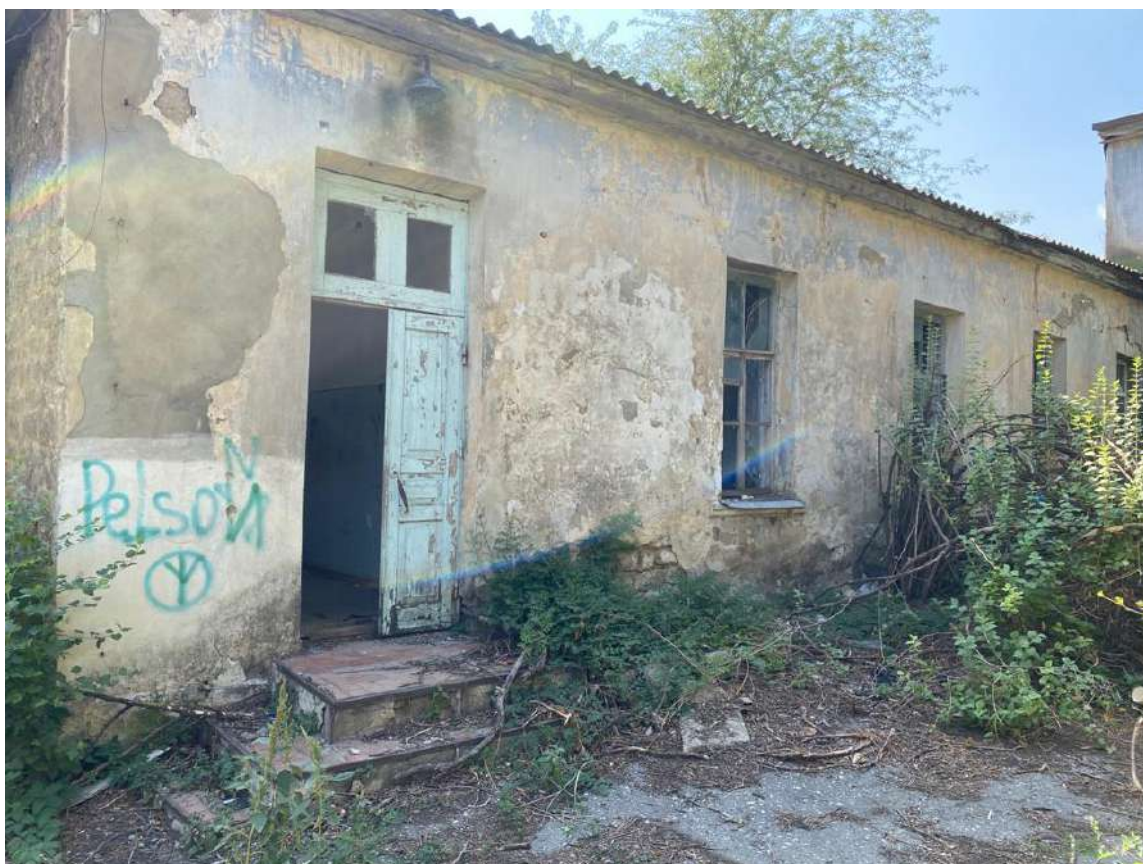
Вид с северо-запада на Объект. Литер В. Фрагмент дворового фасада
