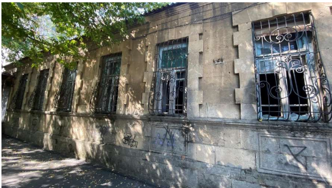
Вид с северо-востока на Объект. Литер В. Главный фасад
