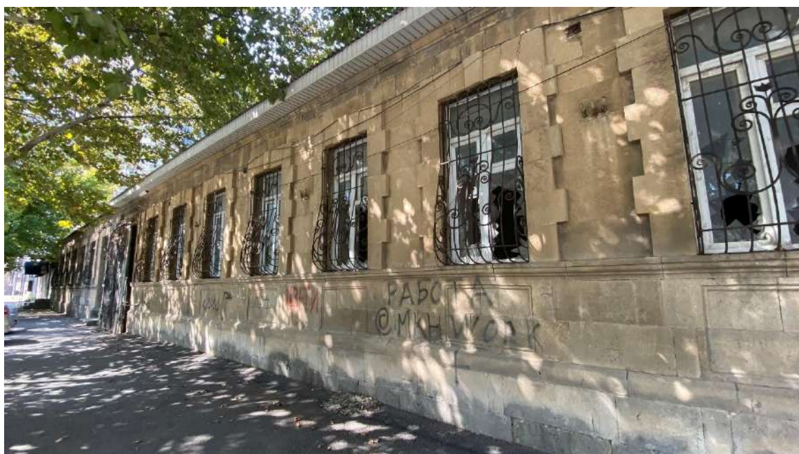
Вид с северо-востока на Объект. Литер А. Главный фасад
