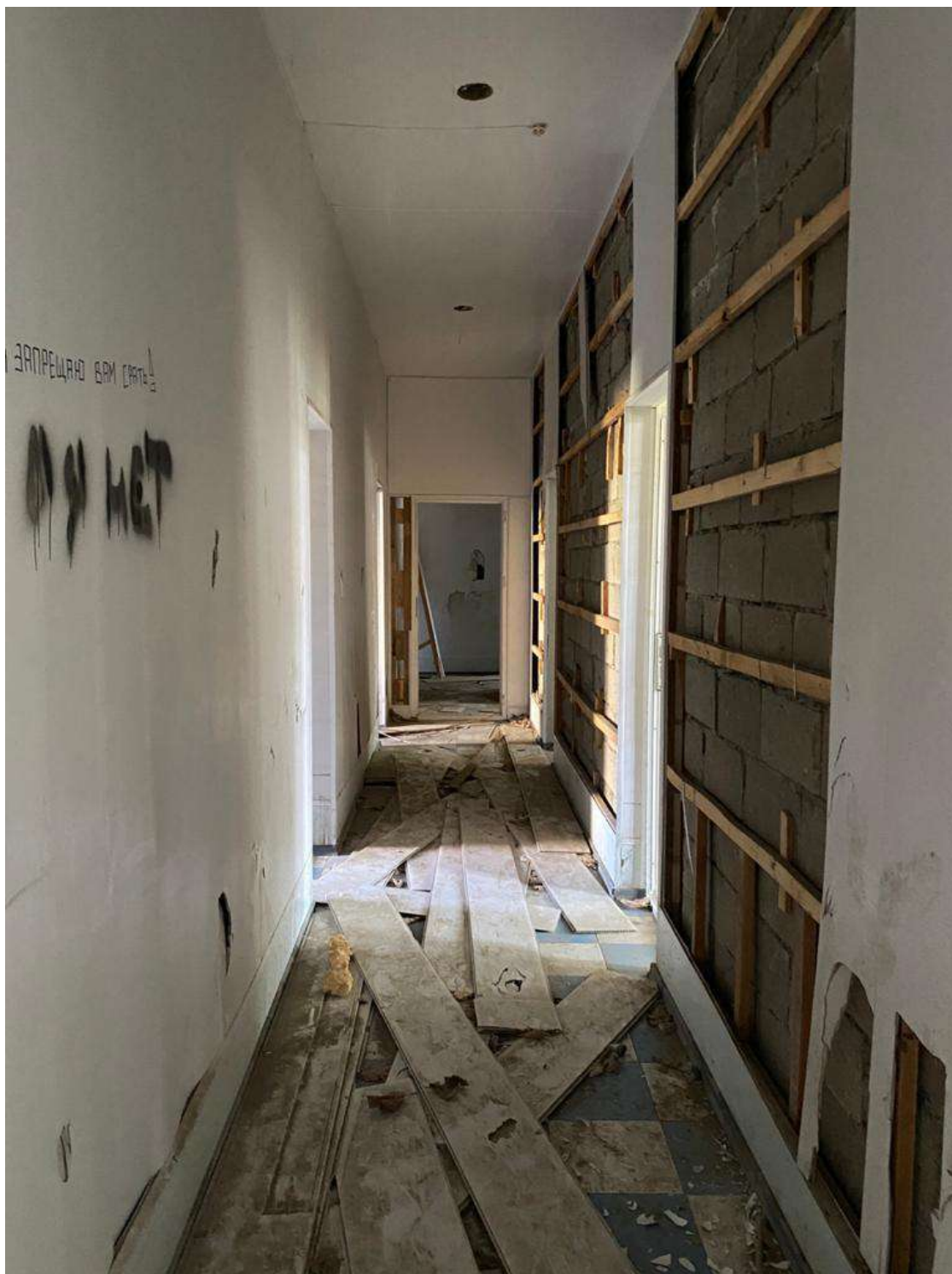
Интерьер Объекта. Литер А. Коридор
