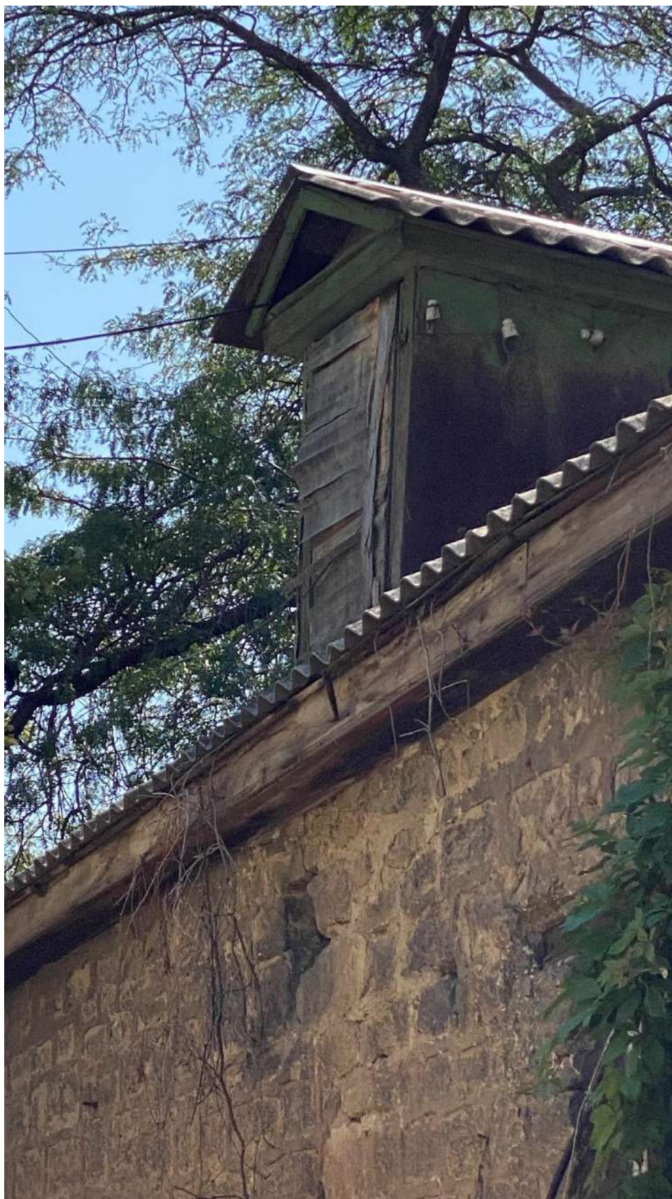
Вид с северо-запада на Объект. Слуховое окно на кровле Литер В. Северо-восточный дворовый фасад.
