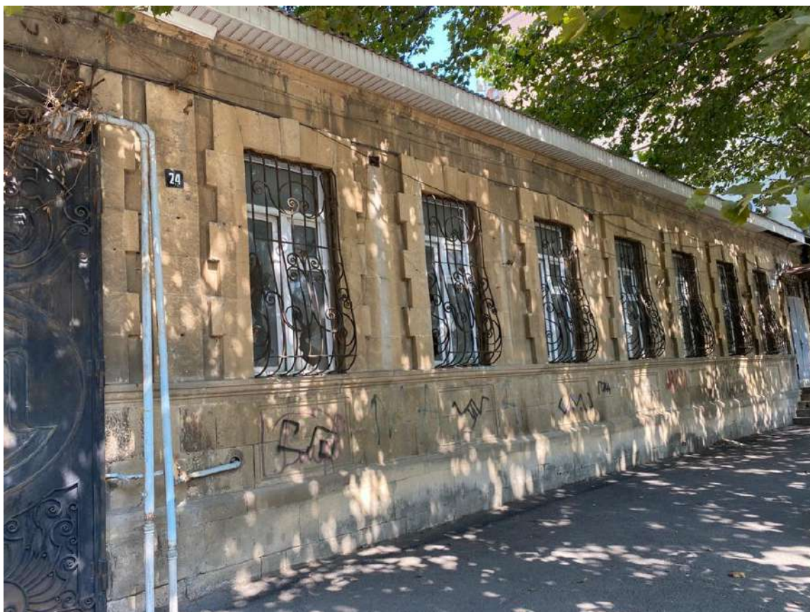
Вид с юга на Объект. Литер А. Главный фасад
