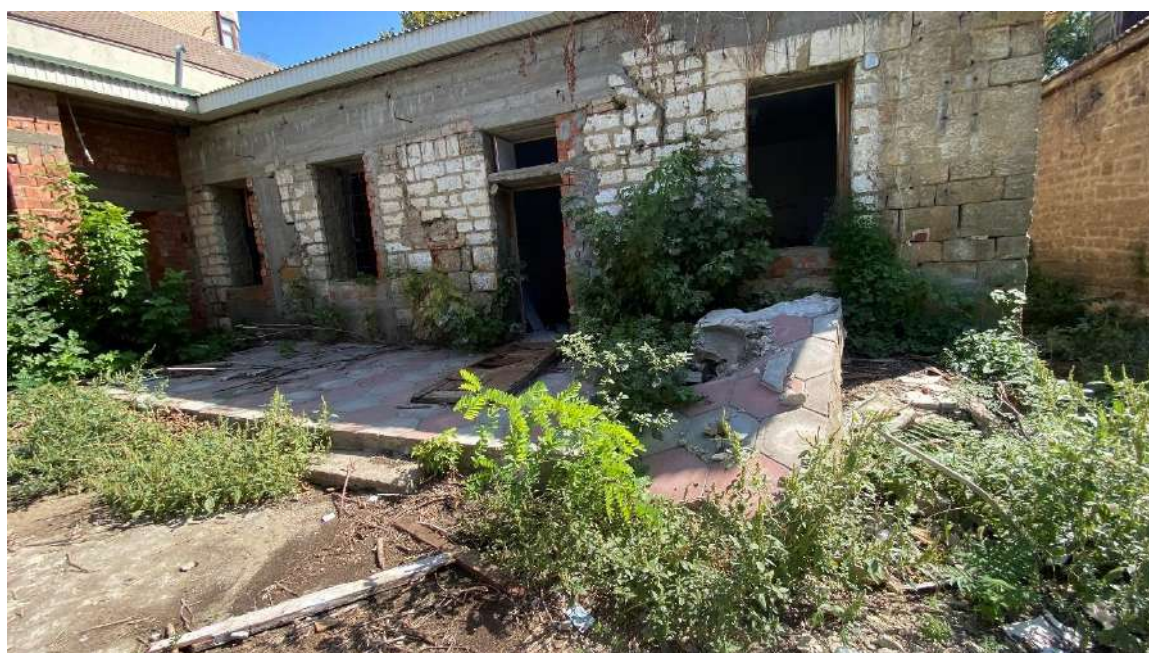
Вид с запада на Объект. Литер А. Дворовый фасад.
