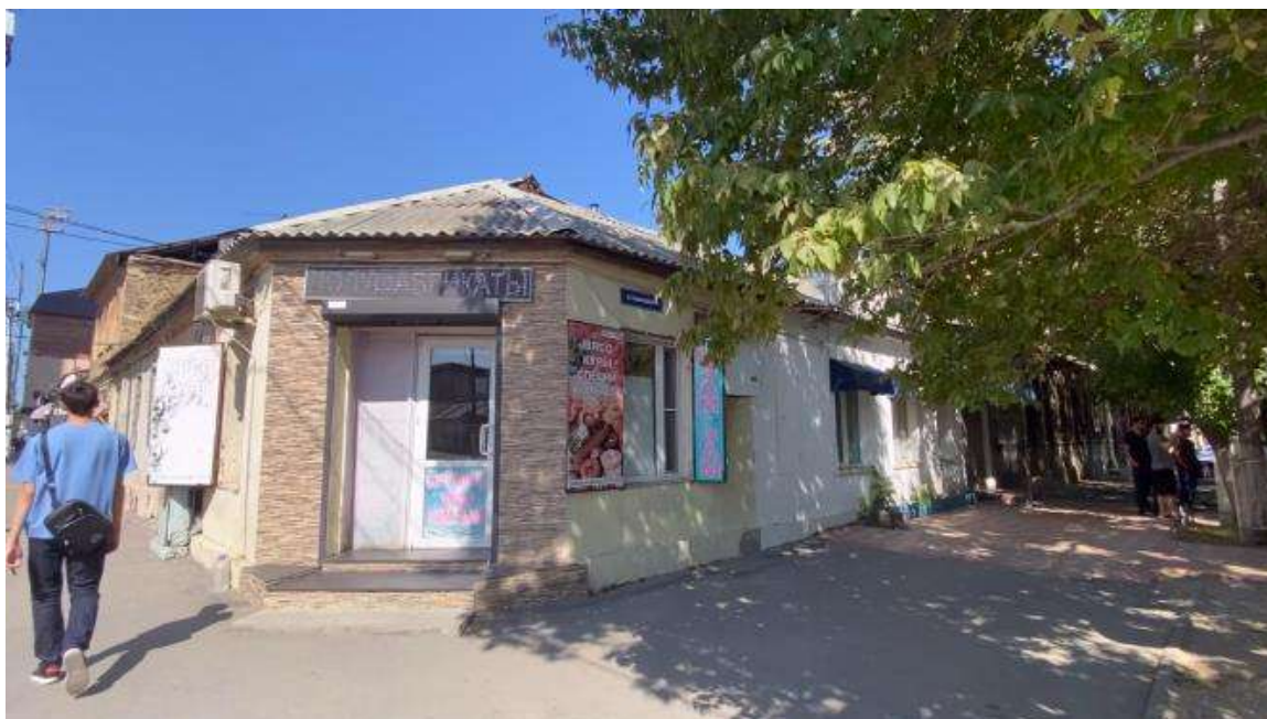
Вид с юга на Объект. Литер В. Главный фасад.
