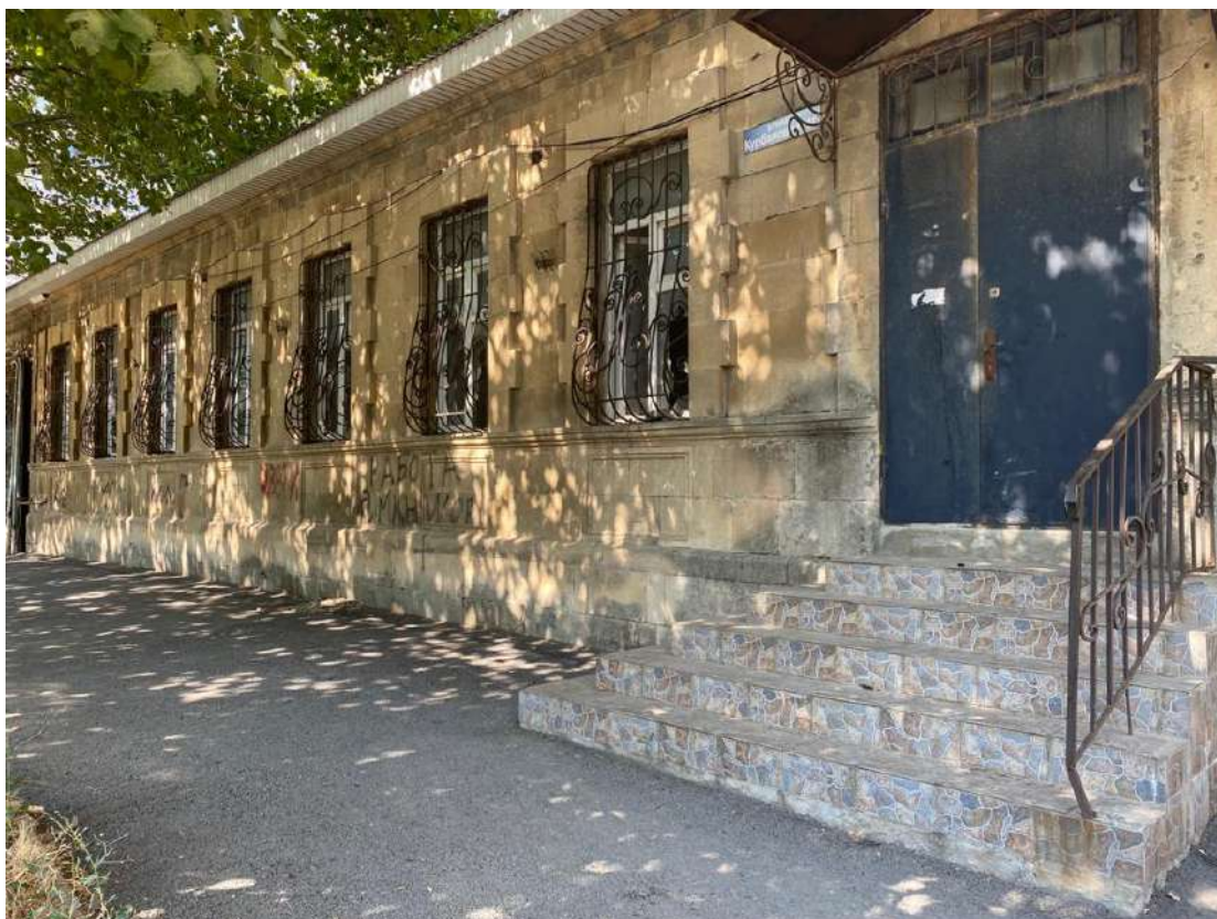
Вид с северо-востока на Объект. Литер А. Главный фасад.
