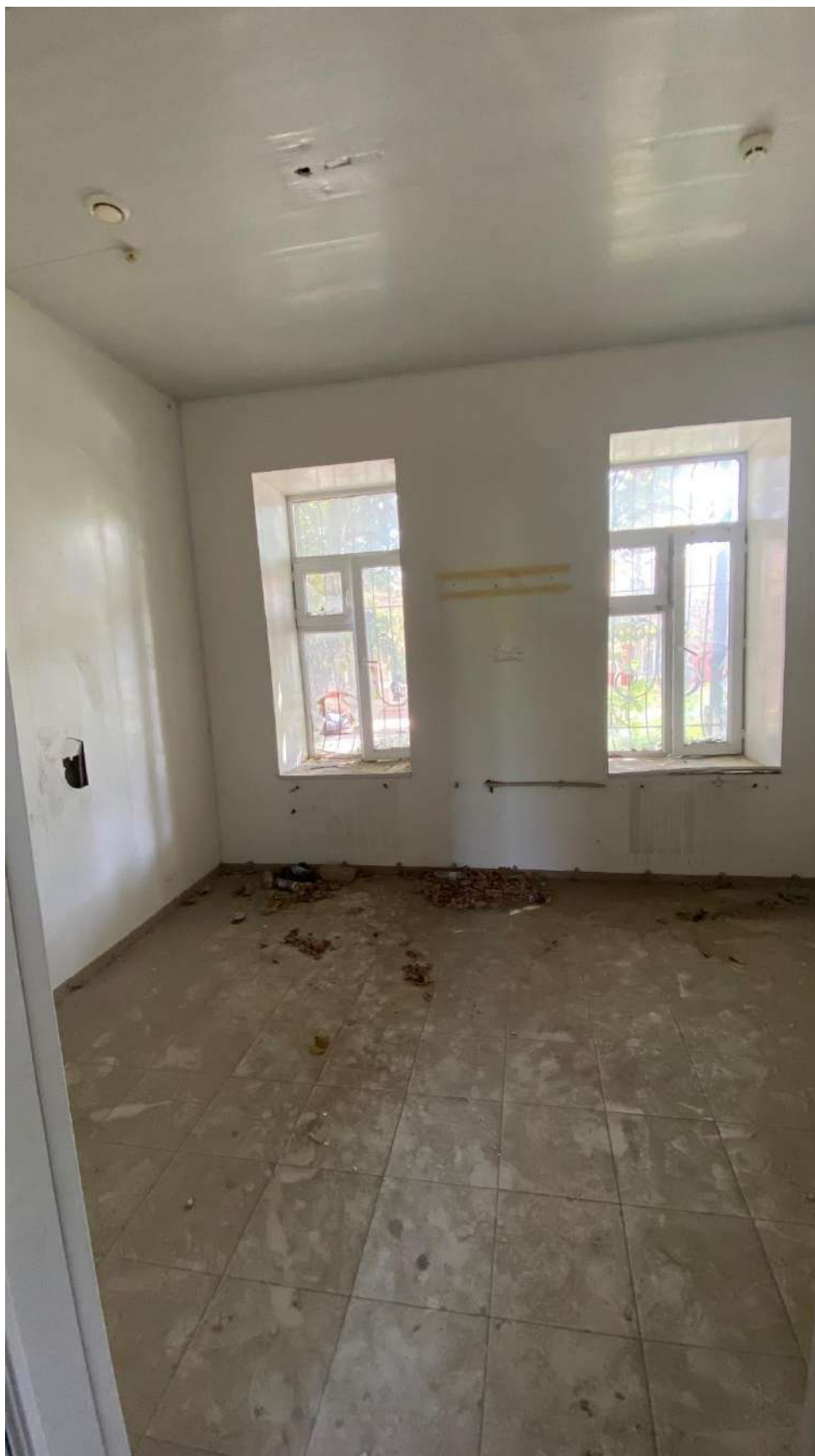
Интерьер Объекта. Литер А. Внутреннее помещение.
