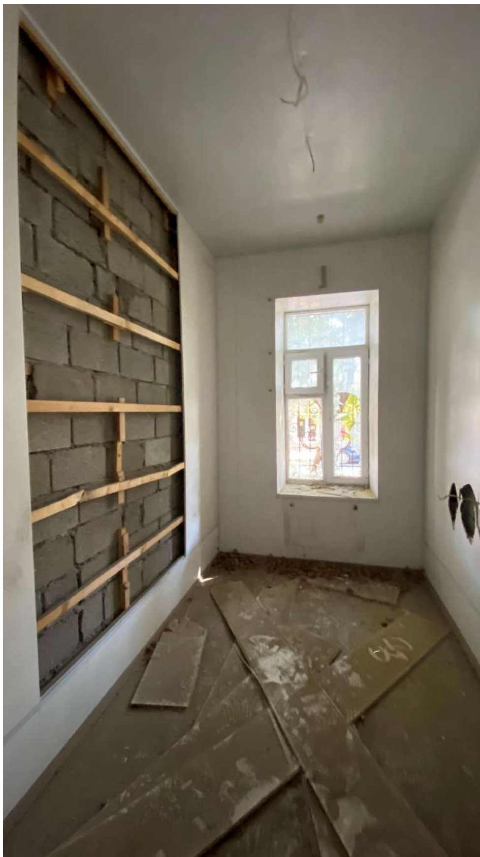
Интерьер Объекта. Литер А. Внутреннее помещение.
