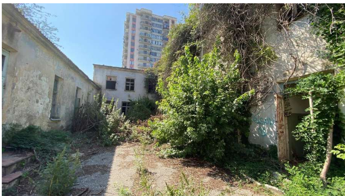
Вид с северо-востока на Объект. Литер В. Дворовая территория и фасад.
