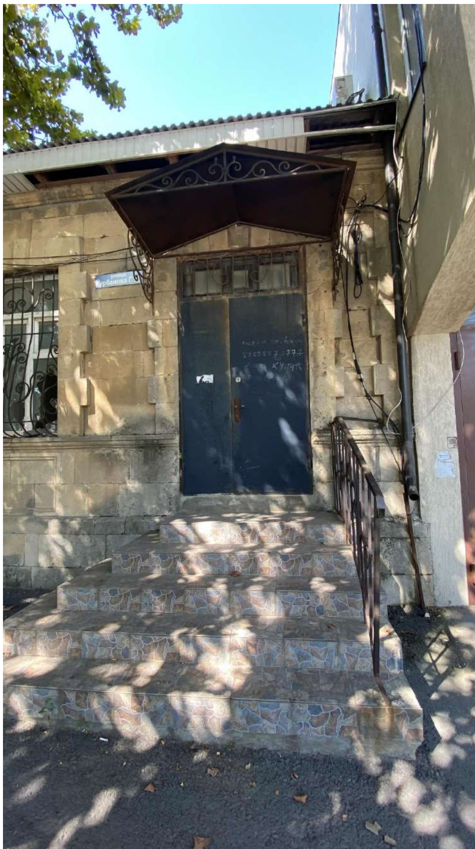
Вид с востока на Объект. Литер А. Главный фасад. Входная группа.
