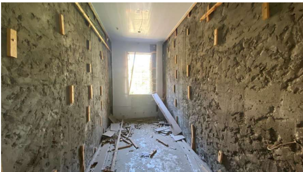
Интерьер Объекта. Литер А. Внутреннее помещение.
