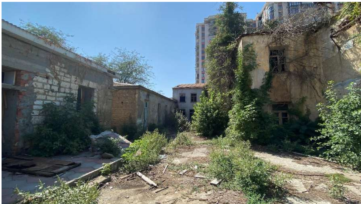
Вид с севера на Объект. Литер А и В. Дворовая территория и фасады.
