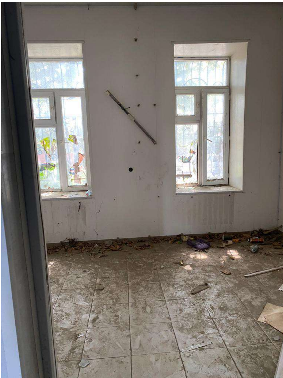
Интерьер Объекта. Литер А. Внутреннее помещение
