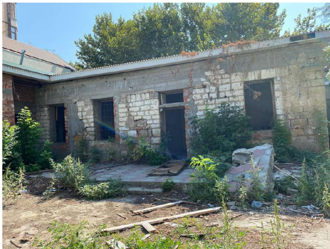
Вид с запада на Объект. Литер А. Дворовый фасад
