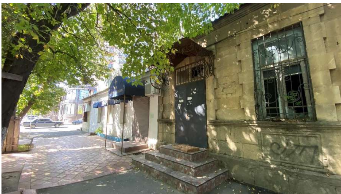
Вид с северо-востока на Объект. Литер В. Главный фасад. Входная группа.
