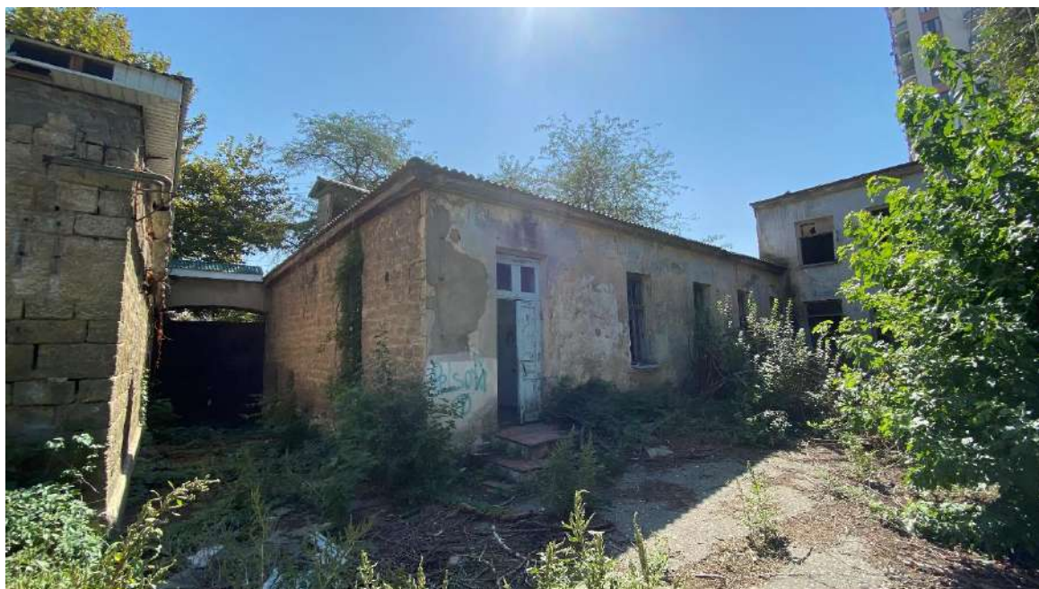
Вид с северо-запада на Объект. Литер В. Дворовый фасад.
