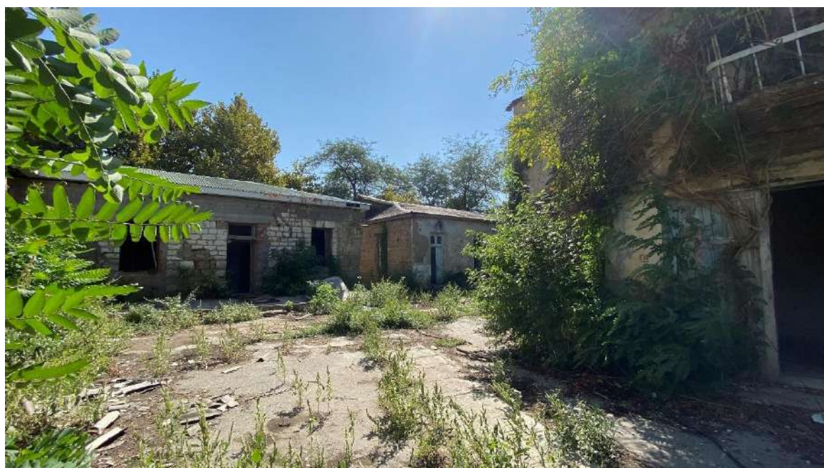
Вид с северо-запада на Объект. Литер А и В. Дворовая территория и фасады.
