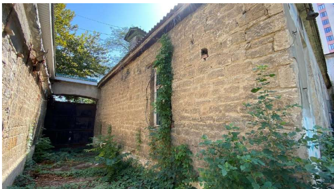
Вид с северо-запада на Объект. Сквозной проезд между Литер А и В.
