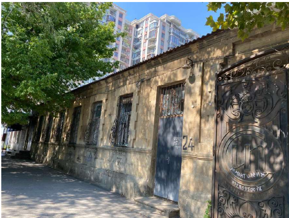
Вид с северо-востока на Объект. Литер В. Главный фасад
