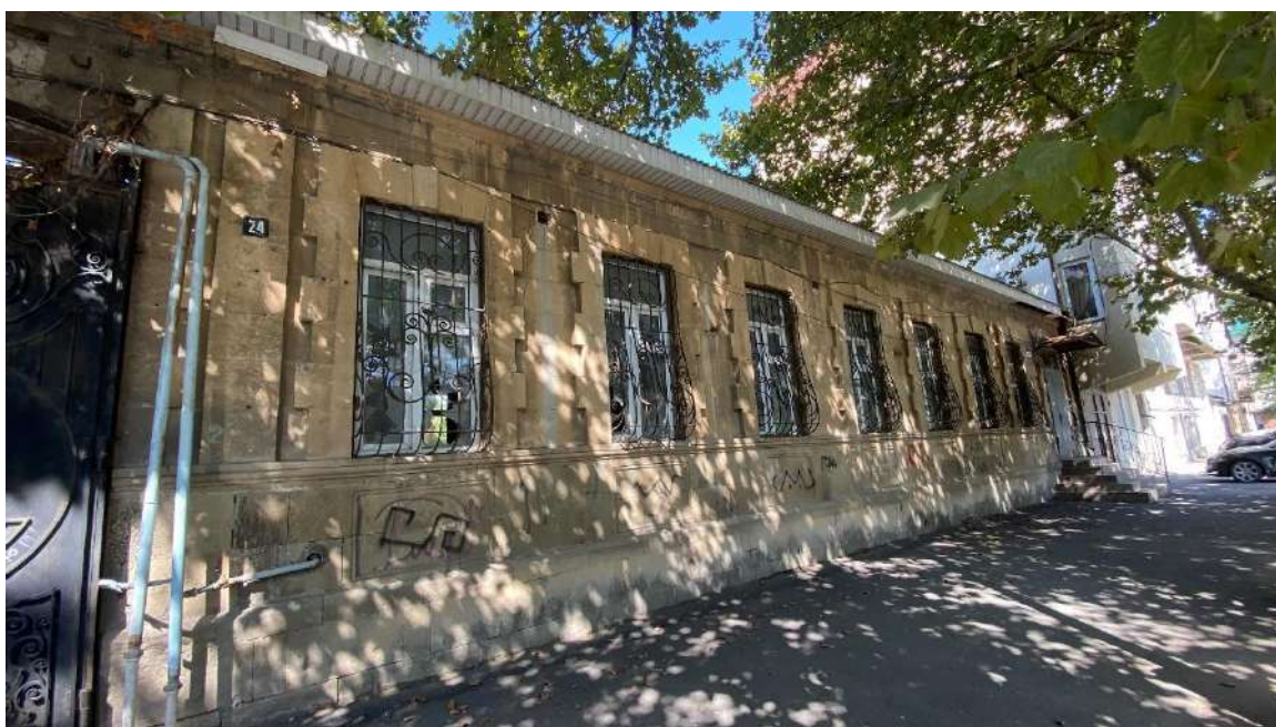
Вид с юго-востока на Объект. Литер А. Главный фасад.
