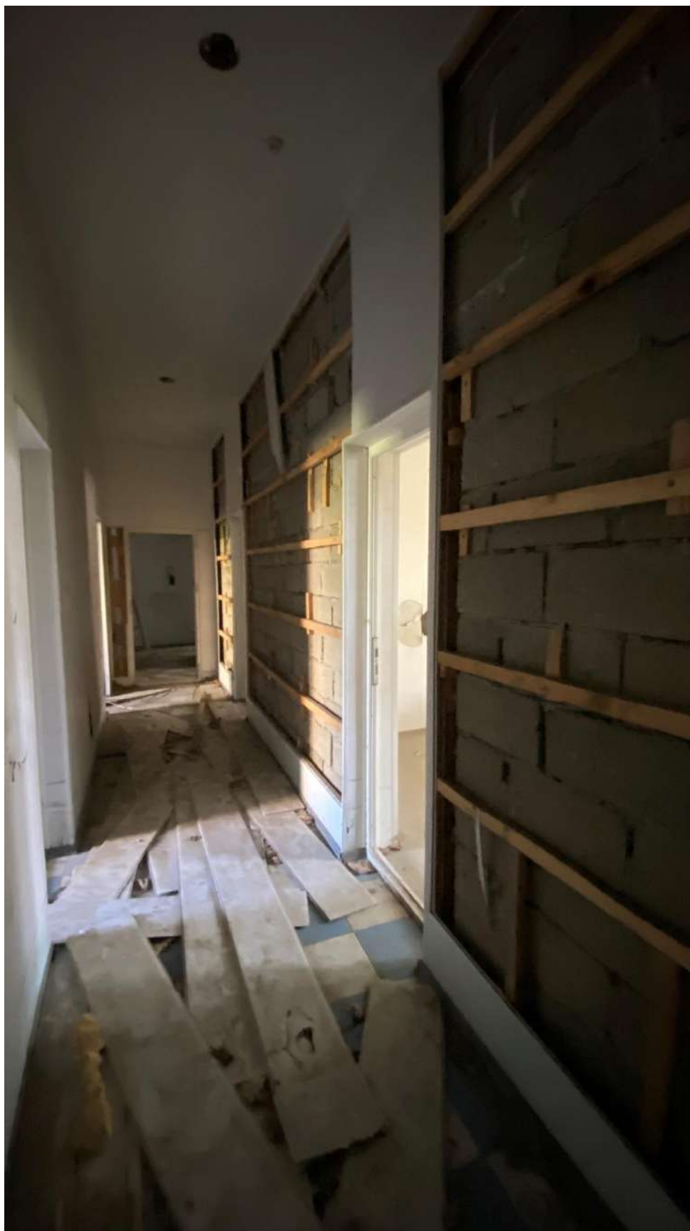
Интерьер Объекта. Литер А. Коридор.
