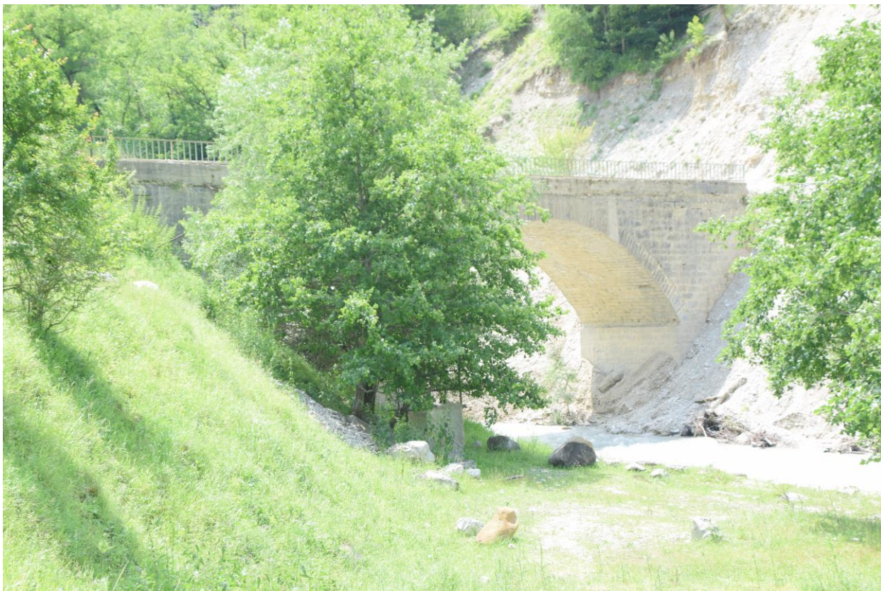
Фото 3. Вид на исследуемый объект с северной стороны, береговая опора
