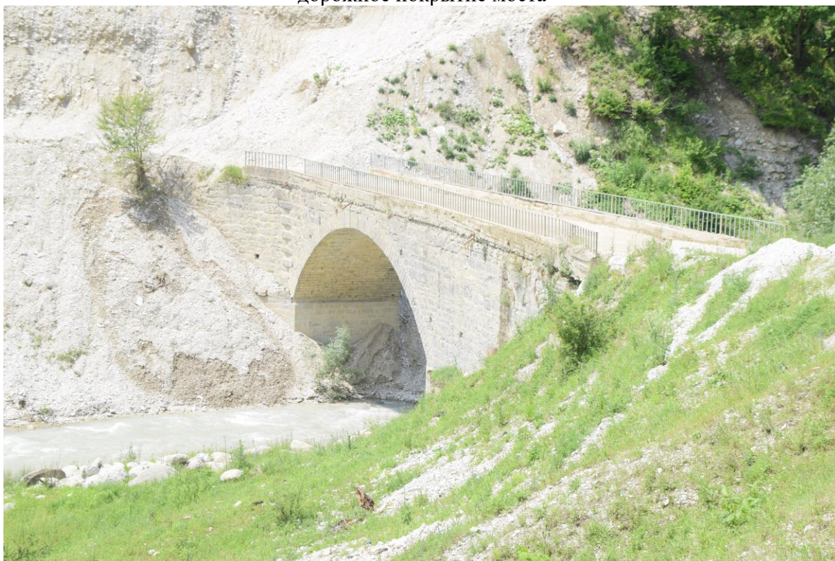
Фото 2. Вид на исследуемый объект с восточной стороны, арка моста, пролет
