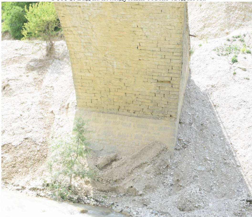
Фото 6. Опора моста со стороны берега противоположного селу Алмак
