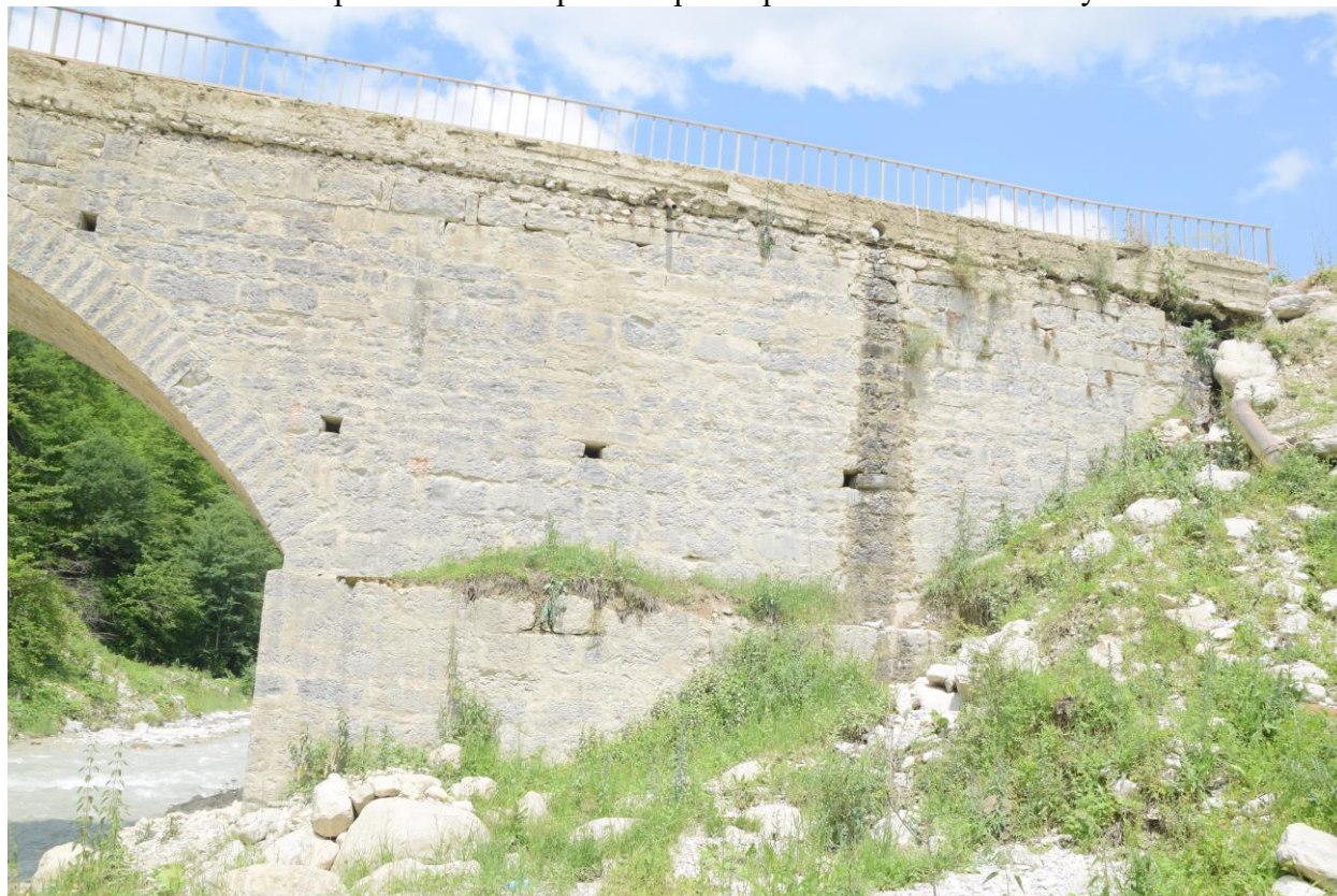
Фото 10. Опора моста с берега, со стороны села Алмак
