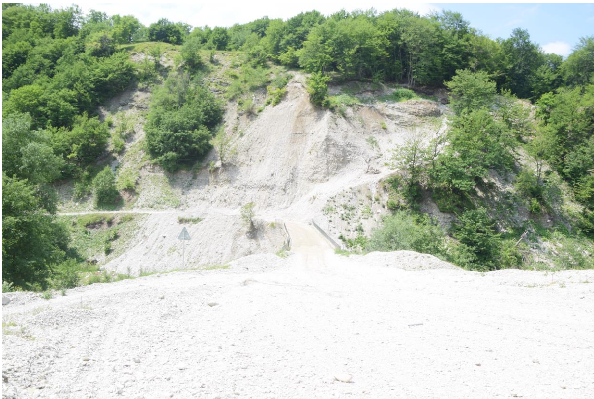
Фото 1. Вид на исследуемый объект с северо-восточной стороны, от села Алмак, дорожное покрытие моста
