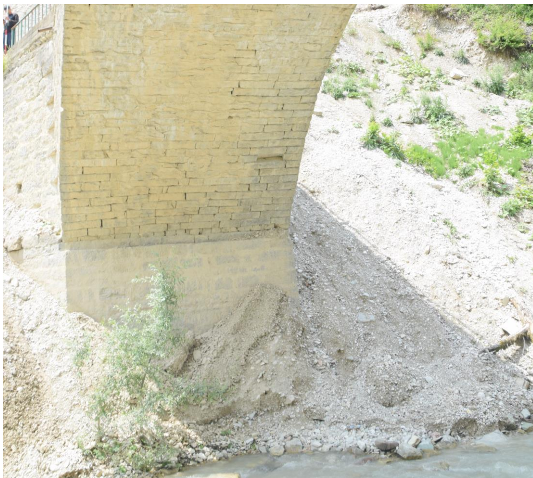
Фото 9. Опора моста со стороны берега противоположного селу Алмак
