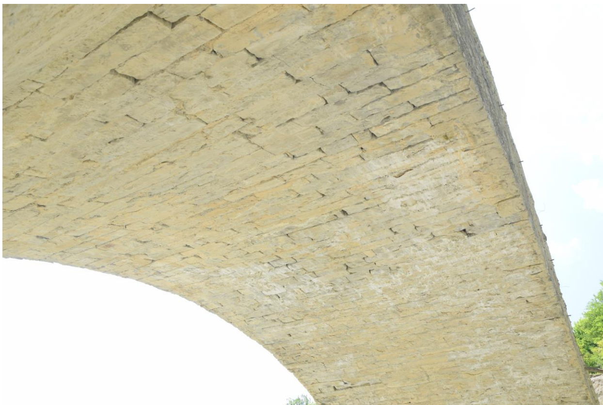
Фото 7. Свод моста исследуемого объекта
