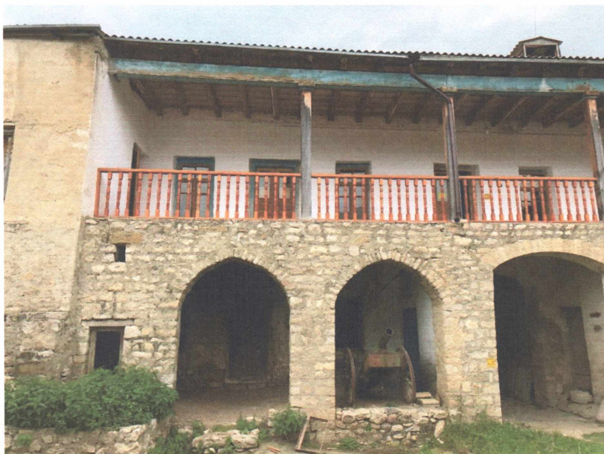
Фото №15. Фасад по оси В.
