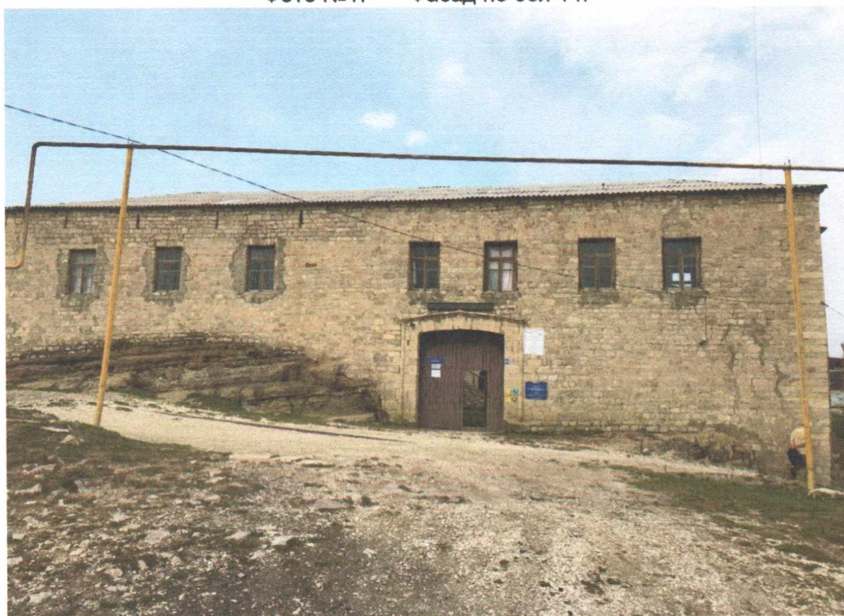
Фото №2. Фасад по оси А.
