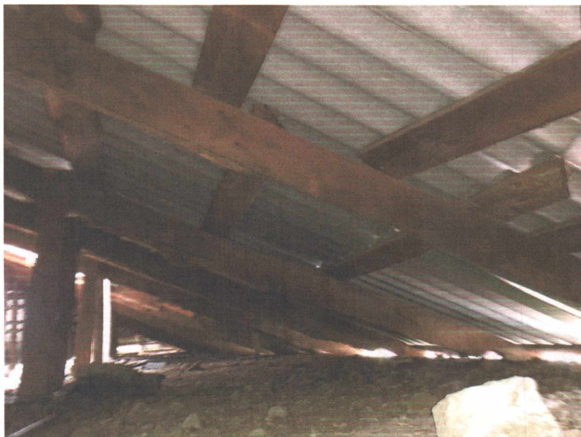
Фото №28. Кровельное покрытие из асбоцементных волнистых листов
