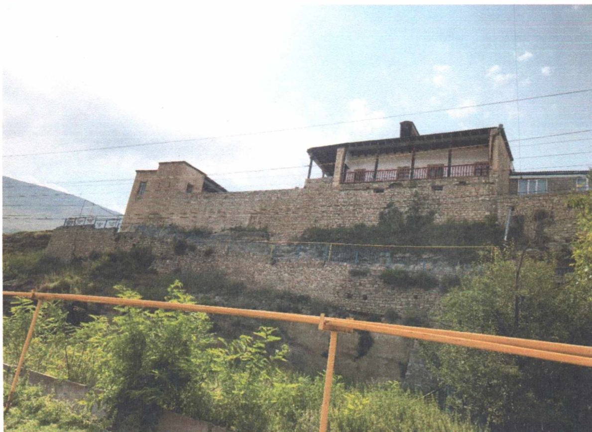
Фото №1. Фасад по оси 14.
