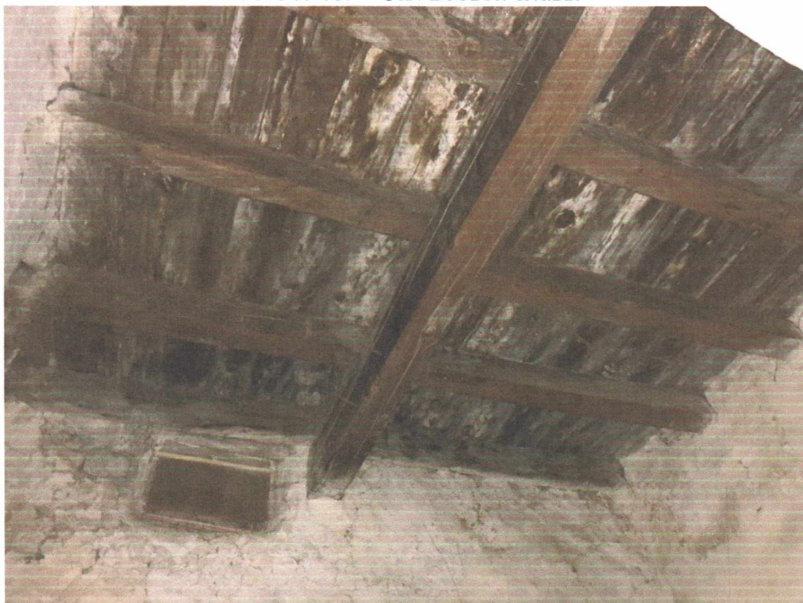
Фото №20. Чердачное перекрытие в осях 6-8/Н/С.
