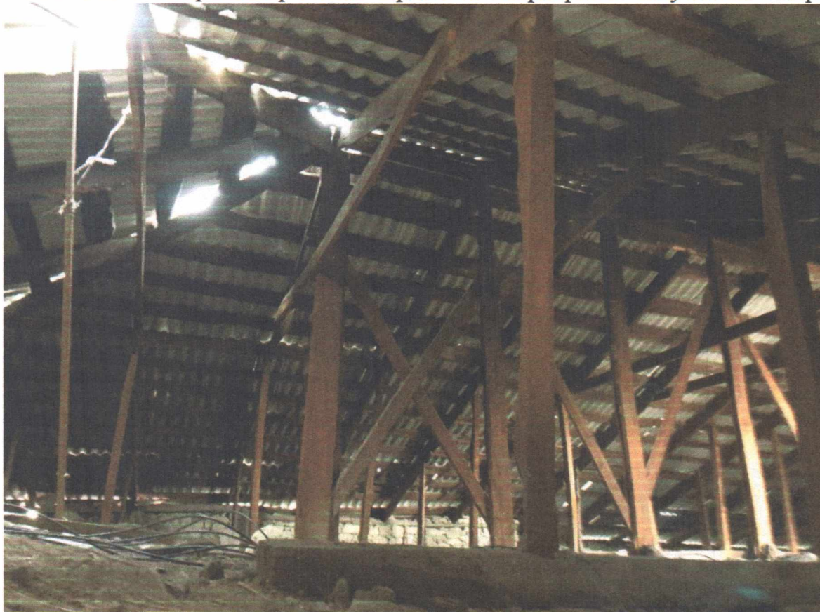
Фото №27. Опираение прогонов чердачного перекрытия на участке галереи
