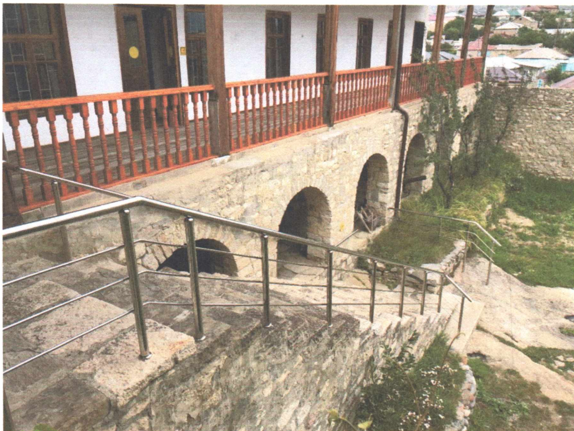
Фото №14. Вид на лестничный марш сверху
