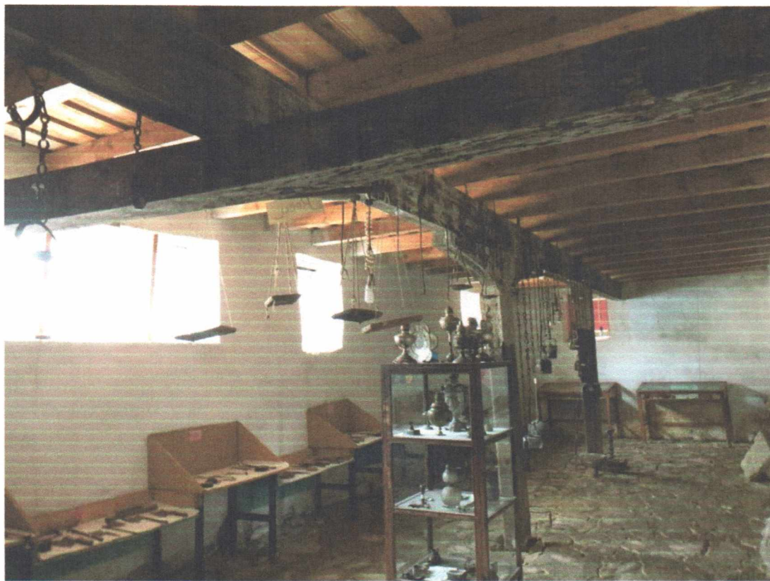
Фото №21. Поражение огнем деревянных элементов перекрытия первого этажа в осях.9-11/А-Б (зал «Средневековья»)
