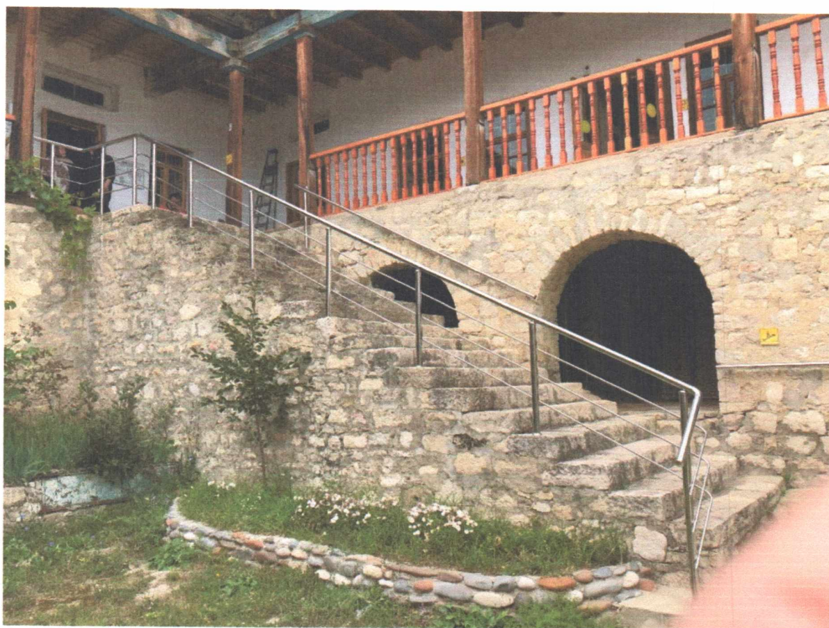
Фото №16. Лестница подъема на этаж
