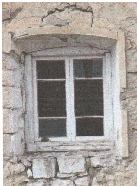
Историческая колода в оконном проеме южного фасада
