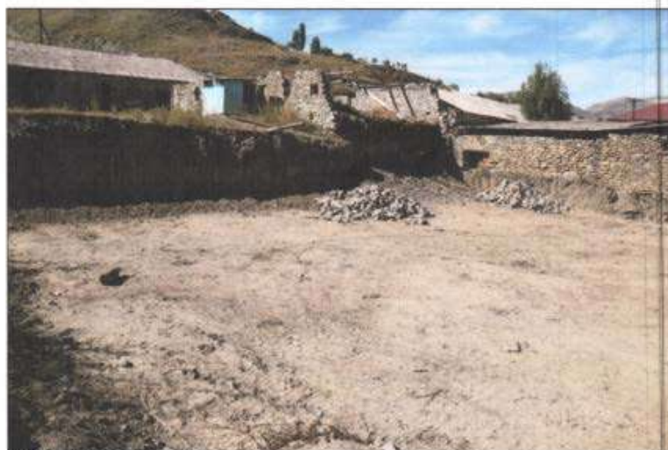
Фото.4.Вид на участок строительства.
