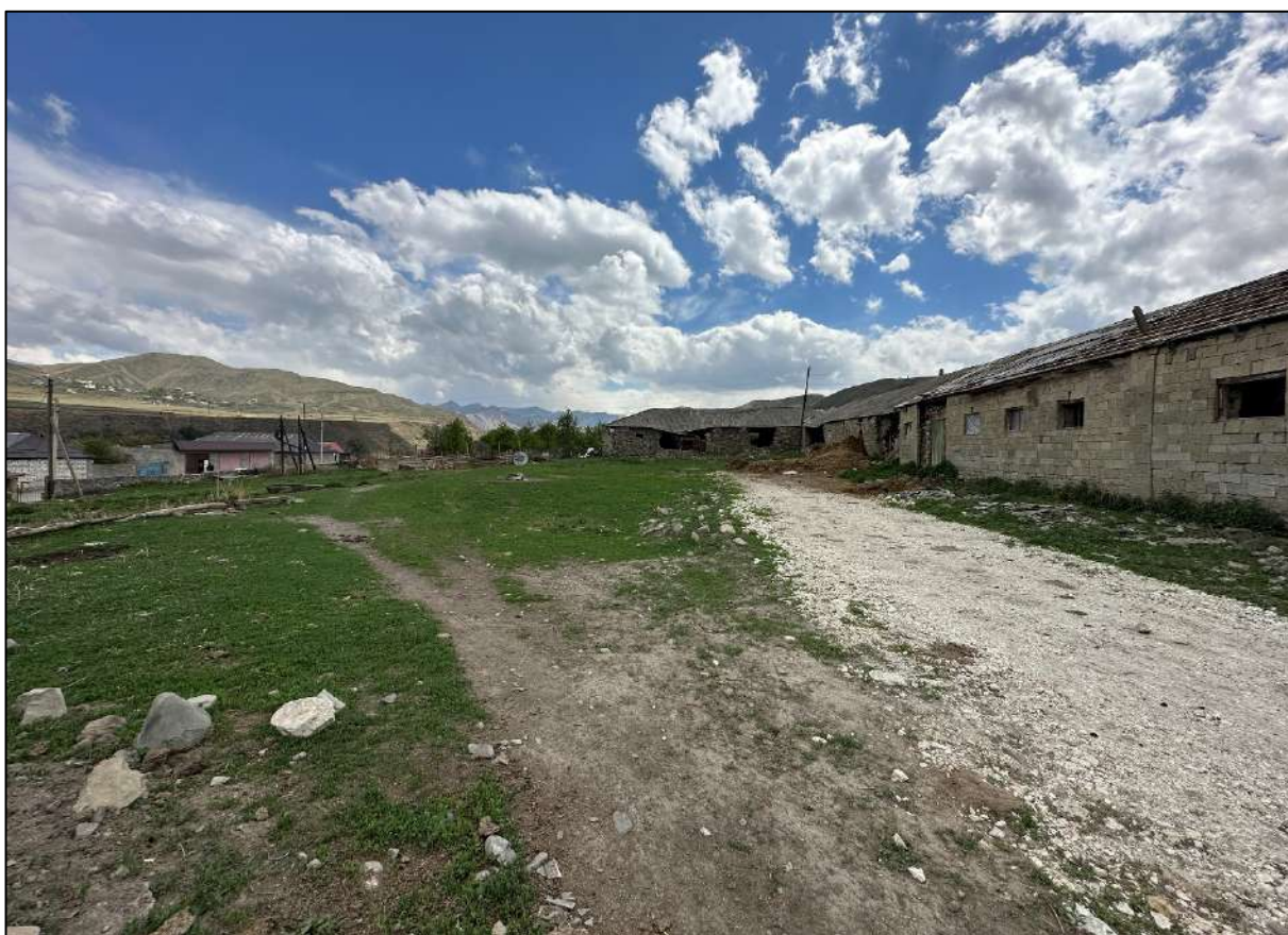
Фото 18. Общий вид территории выявленного объекта культурного наследия «Шамхальское кладбище, участок № 2».
