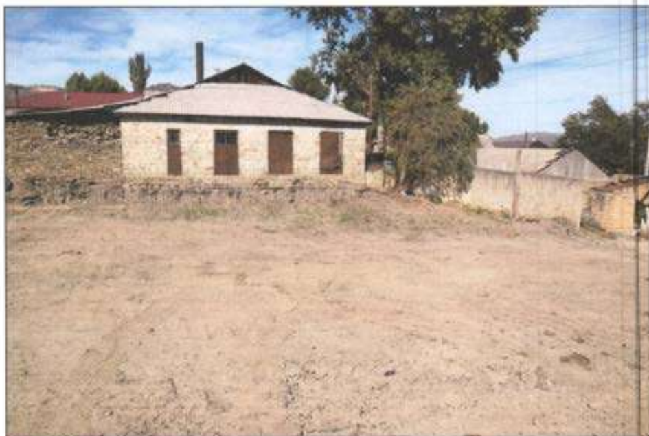
Фото.3.Вид на участок строительства.
