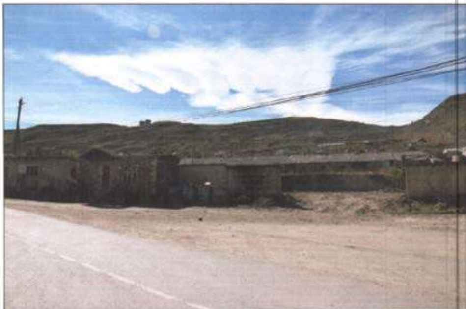
Фото.1.Вид на участок строительства со стороны дороги с.Кумух - с.Шовкра.
