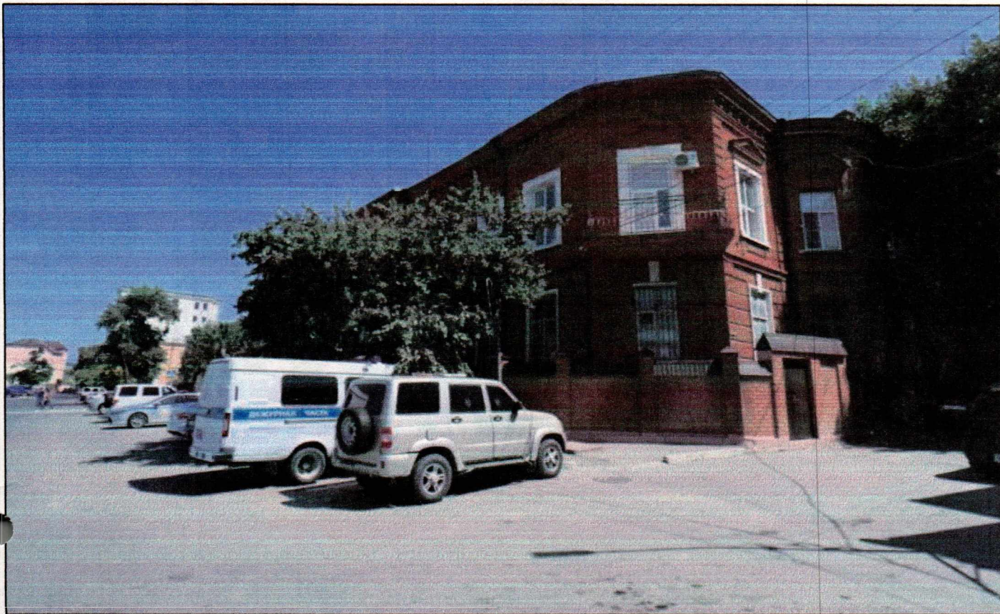
Т.ф.2. Вид на главный фасад северо-запада
