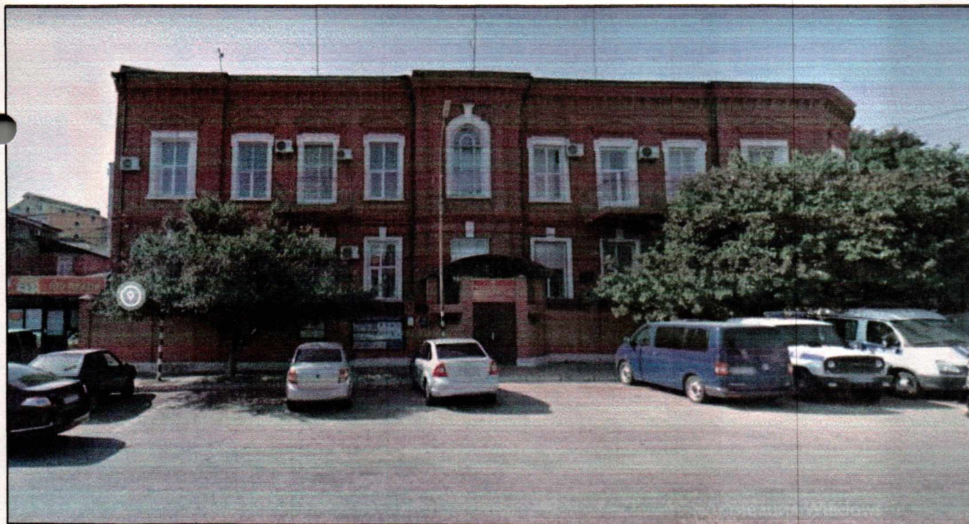
Т.ф.1. Вид на главный фасад выходящий на привокзальную площадь с севера
