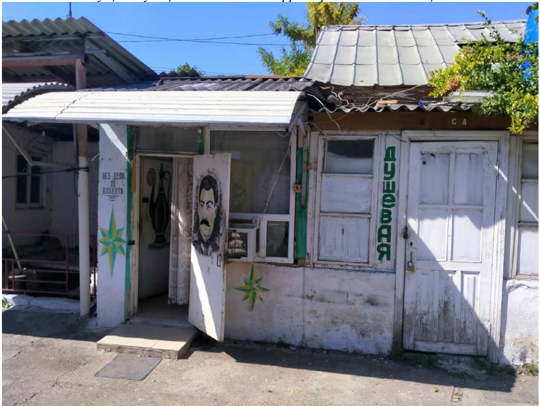
Илл. 44. Фото существующего положения территории объекта. Общий вид неэксплуатируемое вспомогательное здание
