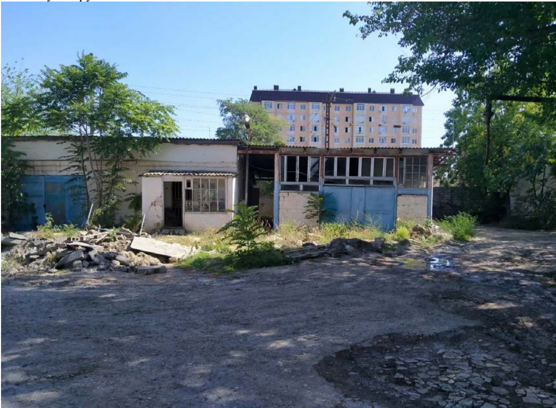
Илл. 42. Фото существующего положения территории объекта. Общий вид неэксплуатируемое вспомогательное здание
