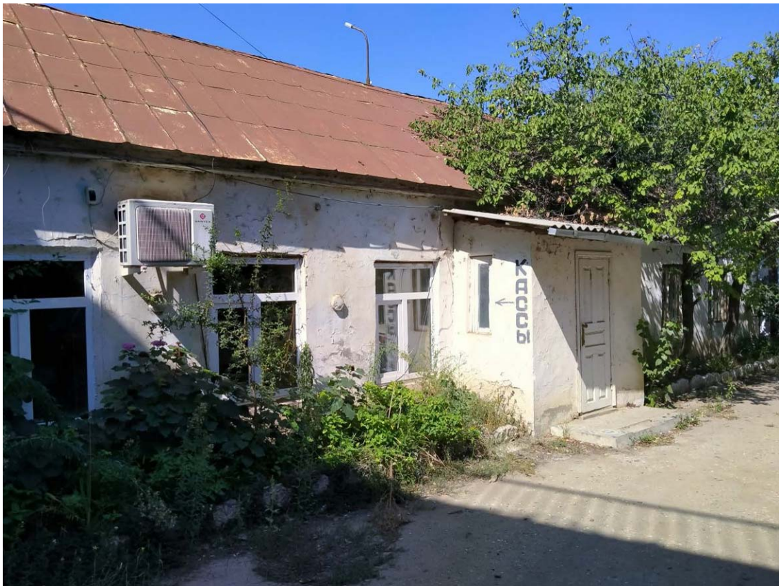
Илл. 45. Фото существующего положения территории объекта. Общий вид здания КТП
