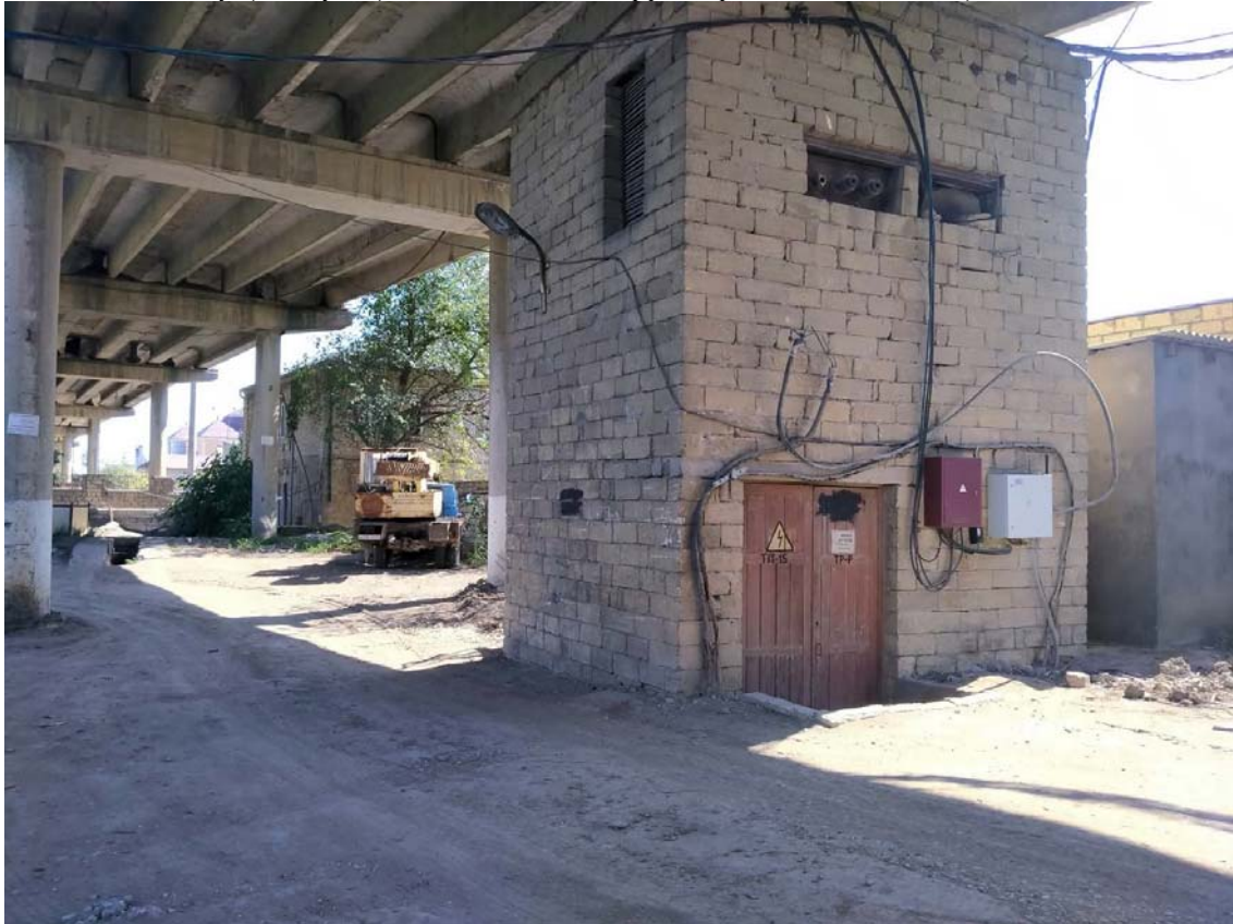
Илл. 46. Фото существующего положения территории объекта. Общий вид территории
