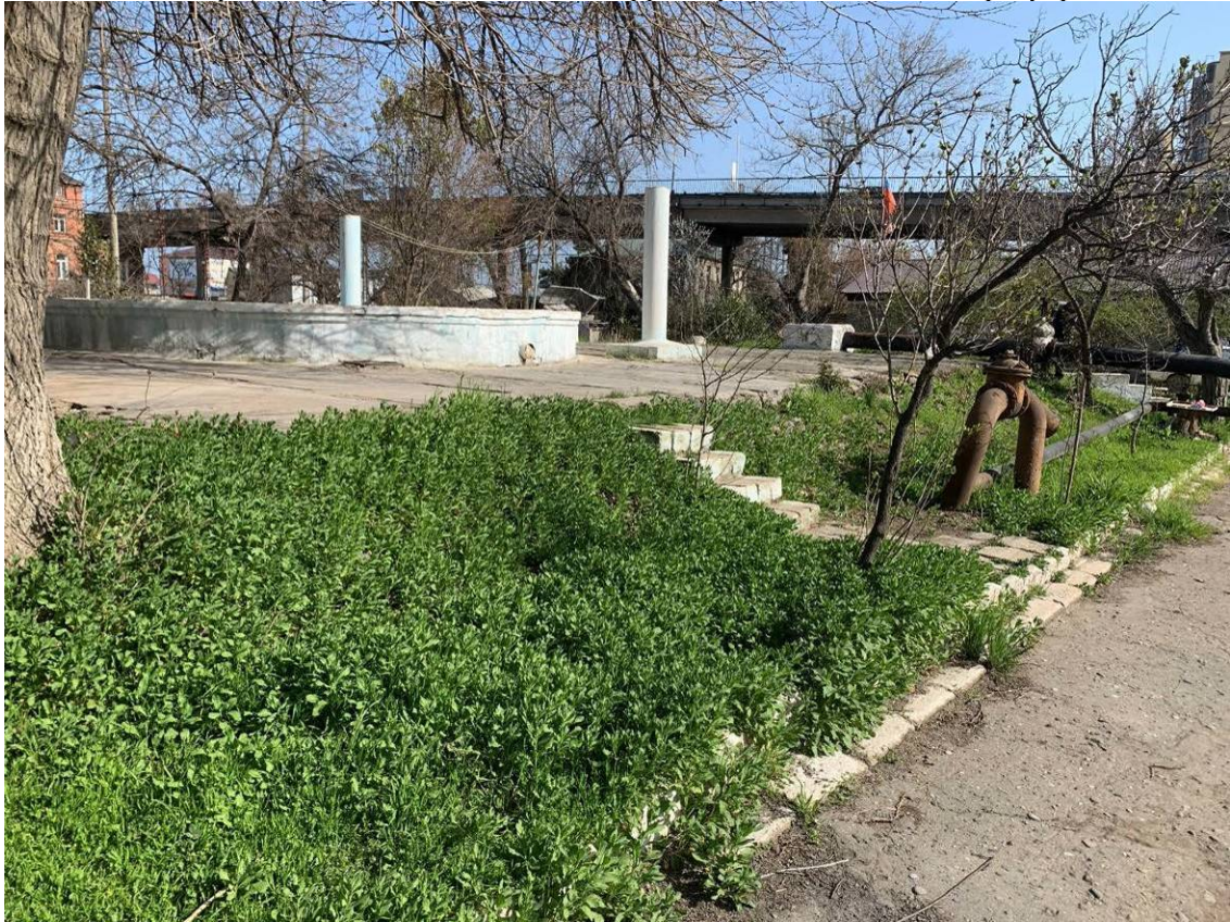
Илл. 38. Фото существующего положения территории объекта. Состояние трубопроводов на
