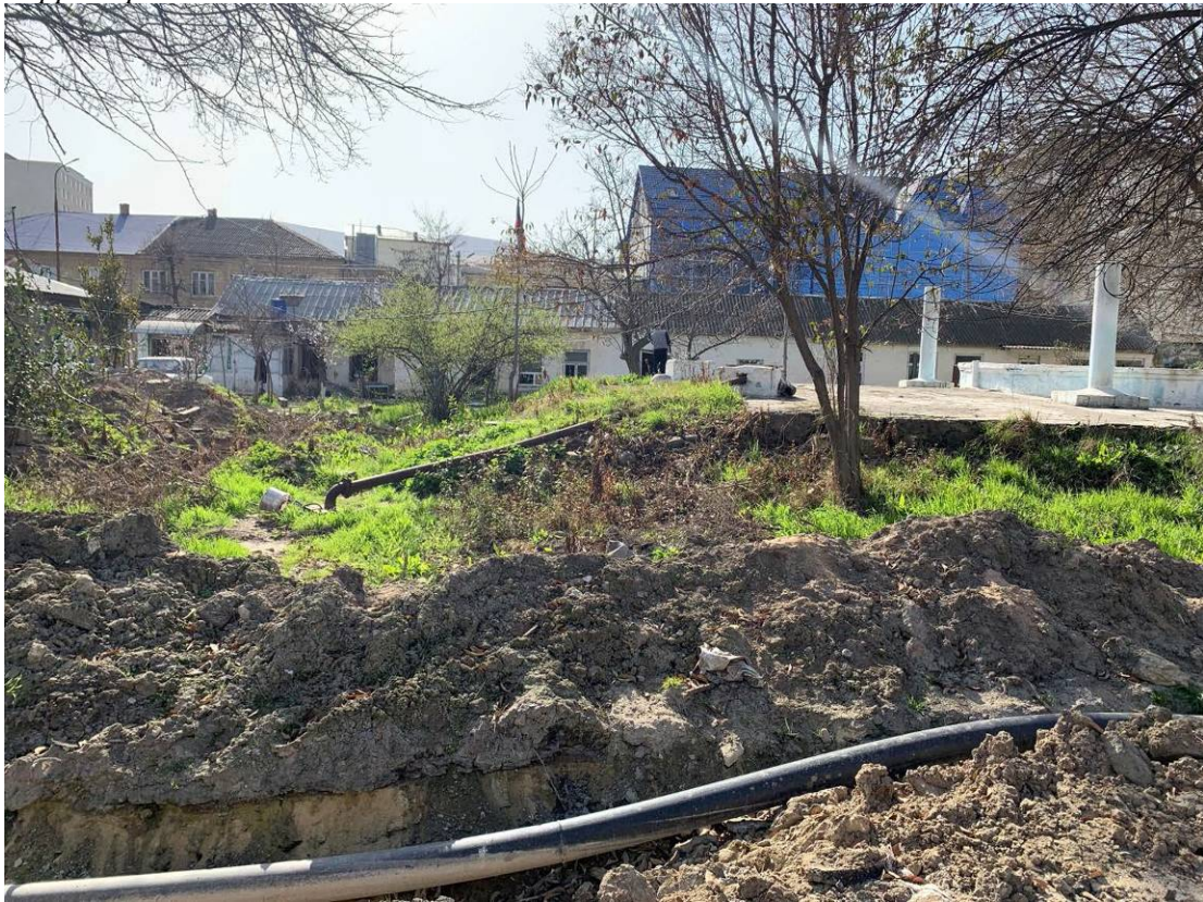
Илл. 39. Фото существующего положения территории объекта. Общий вид территории, вспомогательное здание и КТП
