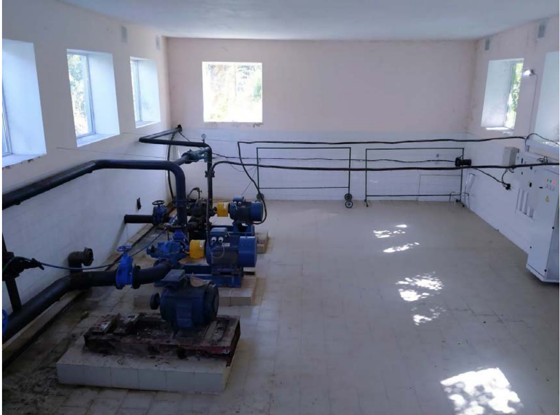
Илл. 36. Фото существующего положения территории объекта. Общий вид машинного зала насосной
