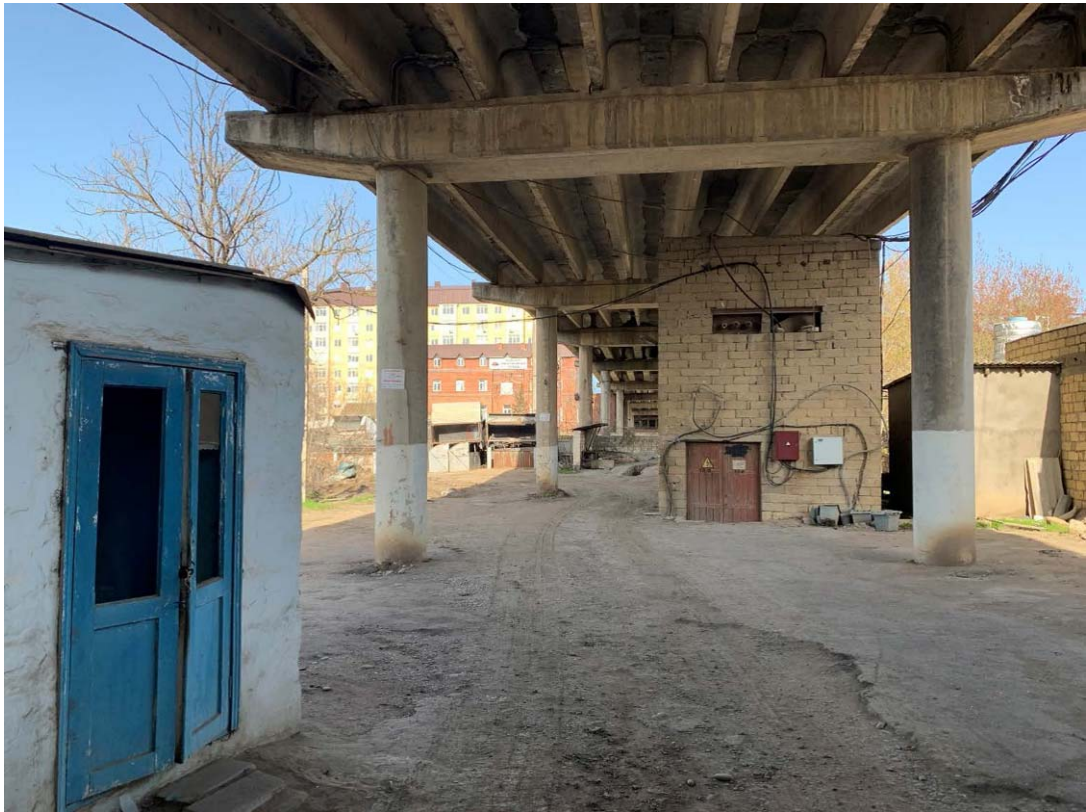
Илл. 40. Фото существующего положения территории объекта. Общий вид территории,
