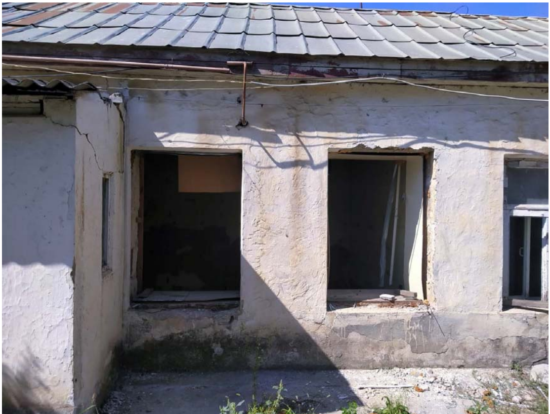
Илл. 43. Фото существующего положения территории объекта. Общий вид подсобных зданий
